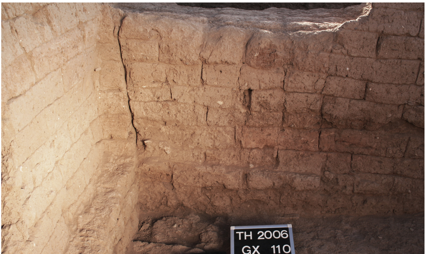
Abb. 74: Baufuge zwischen Mauer MC29 und der rechtwinklig daran anschließenden Mauer MC13 von Westen.
