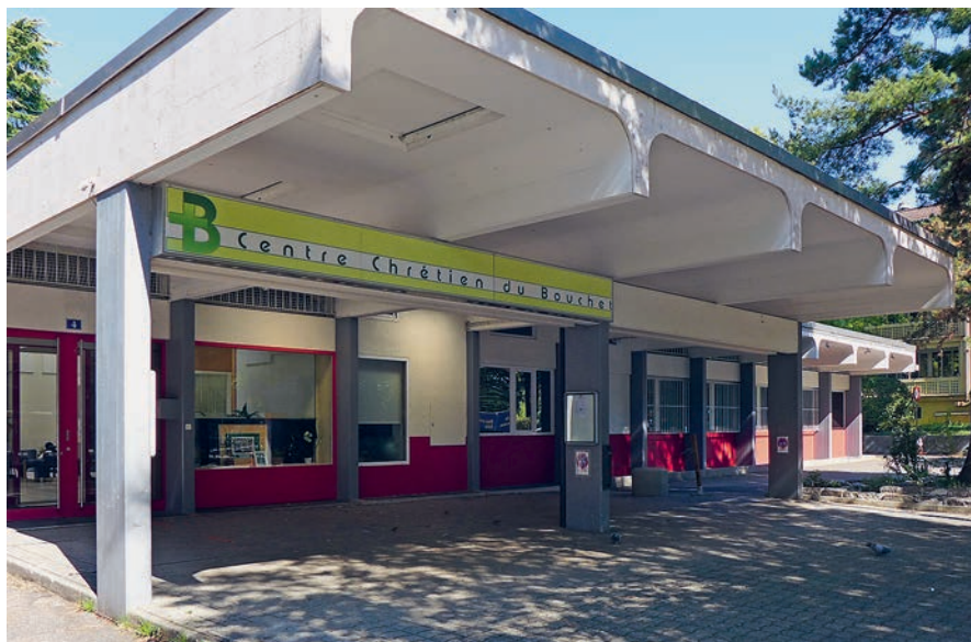
Fig. 46 : Genève, Eglise Apostolique Evangélique, Centre chrétien du Bouchet, ancien bureau de poste, Carrefour du Bouchet 4.
