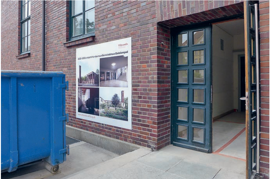
Abb. 22: Basel, Gemeindeforum Ökolampad, 1929–1931, Eugen Tamm und Emil Berger, wurde 2020 an die Wibrandis-Stiftung verkauft. Neunutzung nach Umbau u. a. als Theater und Quartiertreffpunkt (Foto August 2022).
