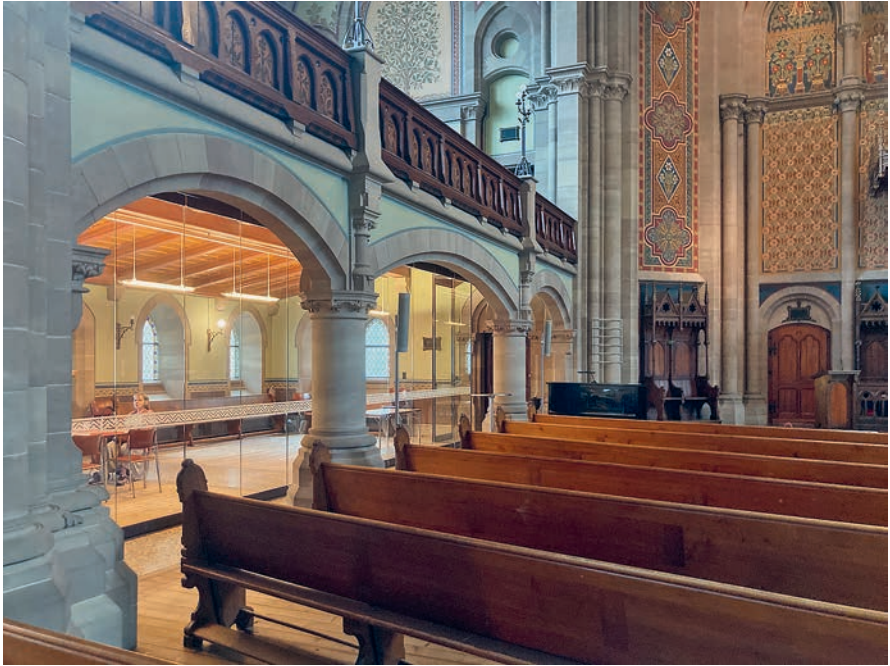
Abb. 28: Basel, Mattheuskirche, 1893–1895, Felix Henry, dank eines Umbaus 2002–2003 (Einbau von Glaswänden unter den Seitenemporen und Ausbau des Untergeschosses) kann die Kirche wie ein Gemeindezentrum genutzt werden.
