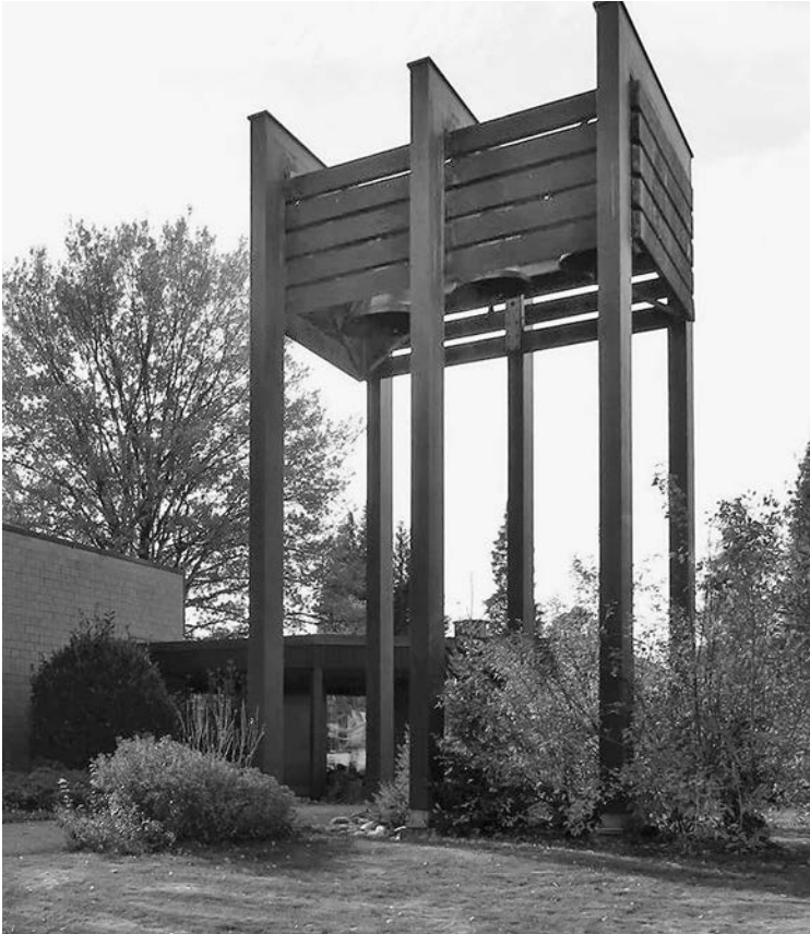
Abb. 43: Lüterkofen, Reformierte Kirche, 1977, Antonio Schlup. Die Kirchgänger mussten sich unter dem nur fünf Meter über dem Boden hängenden schrillen Geläut hindurchquälen. 2021 erfolgte eine Umrüstung analog zur Lösung in Kehrsatz (Abb. 46).
