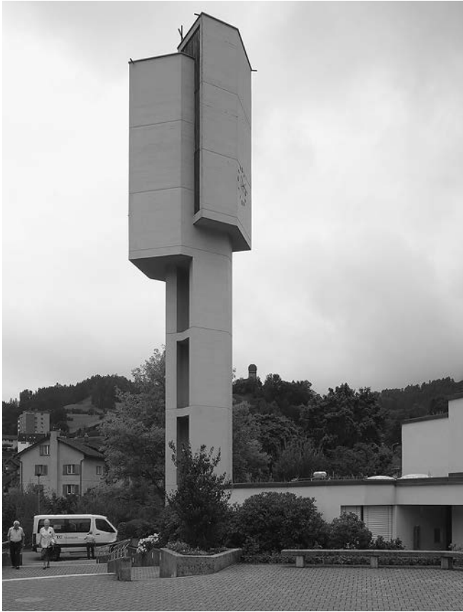
Abb. 41: Wattwil, St. Felix und Regula, 1966, Hermann Baur. Geschlossener Betonturm mit enormem Resonanzraum
