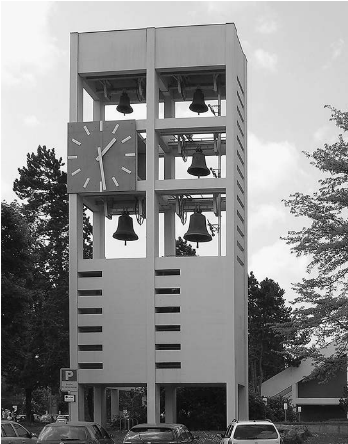
Abb. 48: Bern, Reformierte Kirche Bethlehem, 1958–1960, Werner Küenzi. Offener Turm mit Platzverhältnissen, die keinen Jochumbau erlauben. Mit sinnvoll konstruierten Flugklöppeln ist gleichwohl eine erhebliche Lautstärkensenkung zu erwarten.
