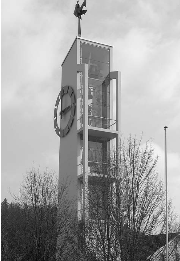
Abb. 45: Hunzenschwil, Reformierte Kirche, 1959–1960, Zschokke & Riklin. Zur Abdämpfung des Glockenklangs verkleidete man 2015 sämtliche offenen Stellen der Turmarchitektur mit grünlich schimmerndem Glas.
