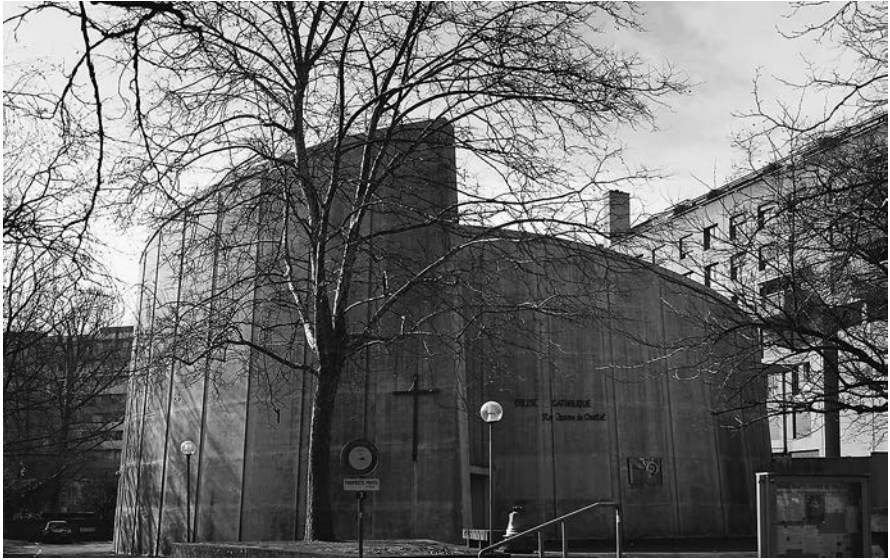
Abb. 70: Genève, Église Sainte-Jeanne-de-Chantal, 1967–1969, Jean-Marie Ellenberger. Zum Abbruch vorgesehen
