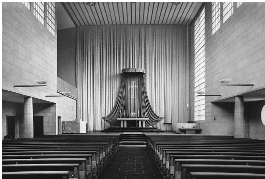
Abb. 72: Luzern, St. Josef (Maihofkirche), 1940–1941, Otto Dreyer. Innenraum nach der Erbauung
