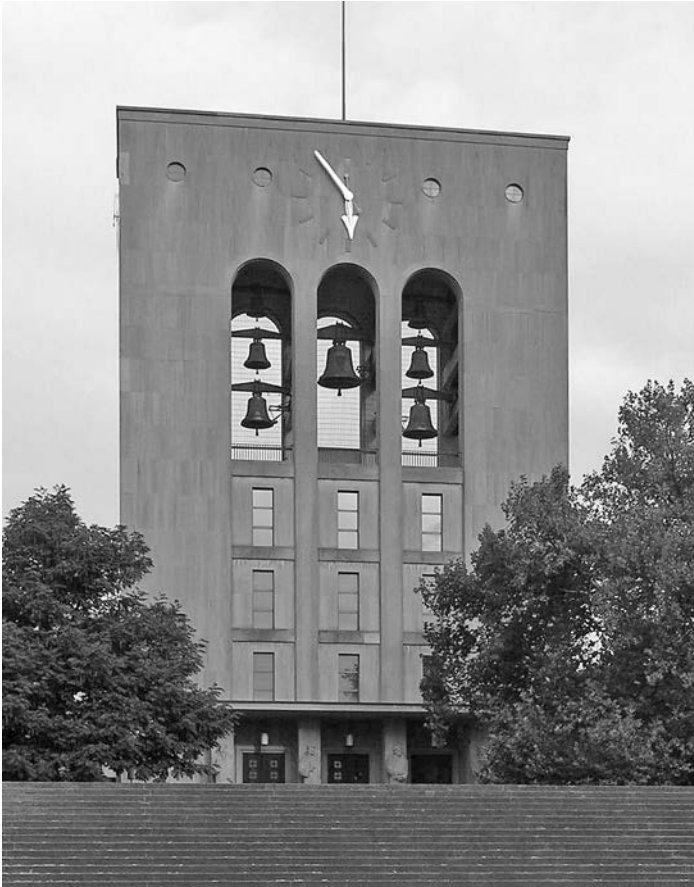
Abb. 40: Zürich, Pauluskirche, 1933, Arter & Risch. Eines der ersten modernen Beispiele der Schweiz mit offen inszenierter Aufhängung der Glocken
