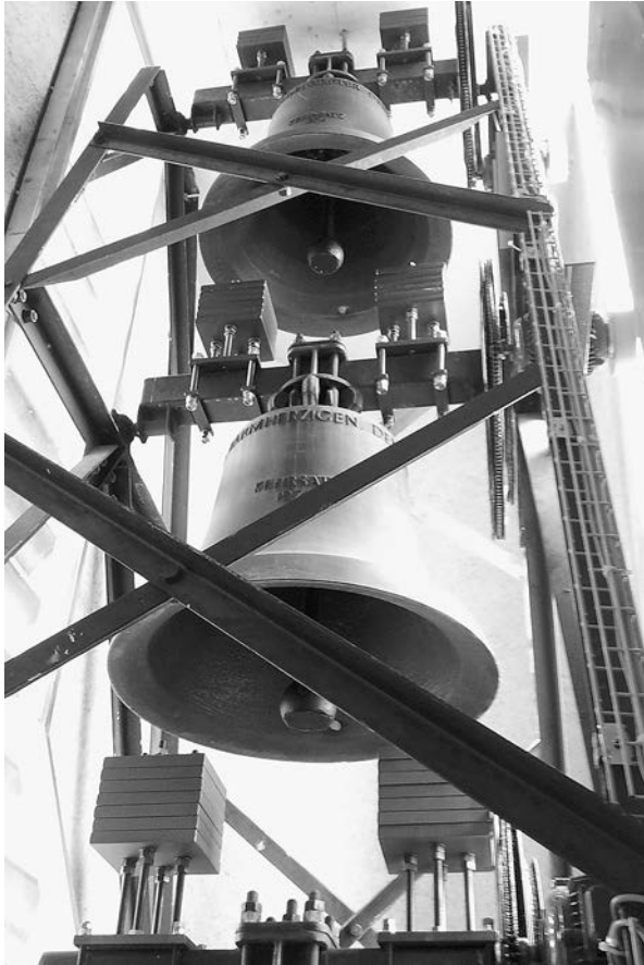
Abb. 46: Kehrsatz, Ökumenisches Zentrum, 1975–1976, Benedikt Huber. Betonglockenstube fünf Meter über dem Boden neben dem Eingang. Die Glockenjoche wurden durch Metallplatten beschwert und die Klöppelvorschwünge eingekürzt, sodass Fallklöppel mit vergleichsweise langer Aufpralldauer die Glocken anregen.
