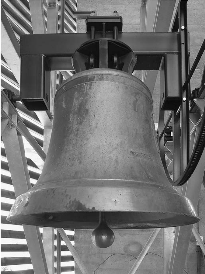
Abb. 47: Pfäffikon ZH, St. Benignus, 1963, Richard Krieg. Die Glocken hingen ursprünglich an geraden Stahljochen, welche zwecks Schalldruckpegelsenkung durch gekröpfte (gestelzte) Tragbalken ersetzt wurden. Im Vergleich zum leicht verlangsamenden System in Kehrsatz ähnelt der Schwungrhythmus dem herkömmlichen Läuten.
