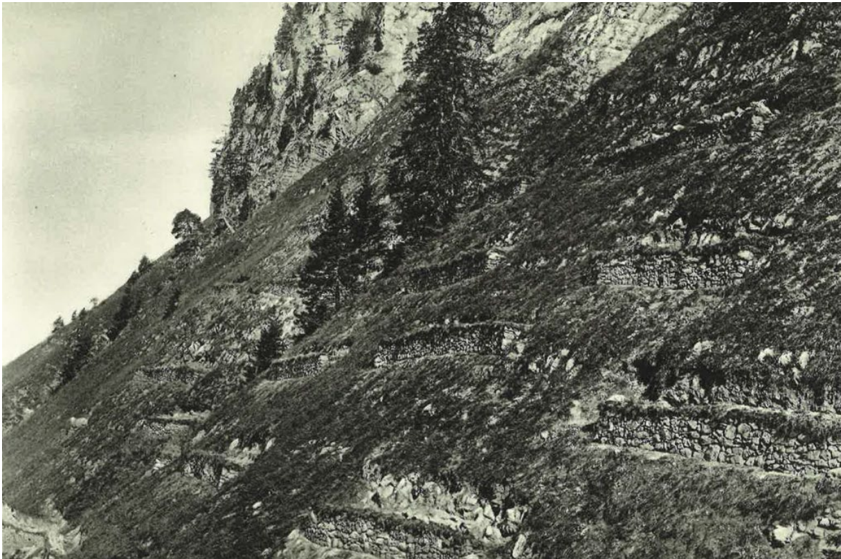
Abb. 27: Untermauerte Terrassen ( banquettes ) in Malnant (Hoch-Savoyen), ca. 1909. Quelle: Coaz 1910: Abb. XXVII.
