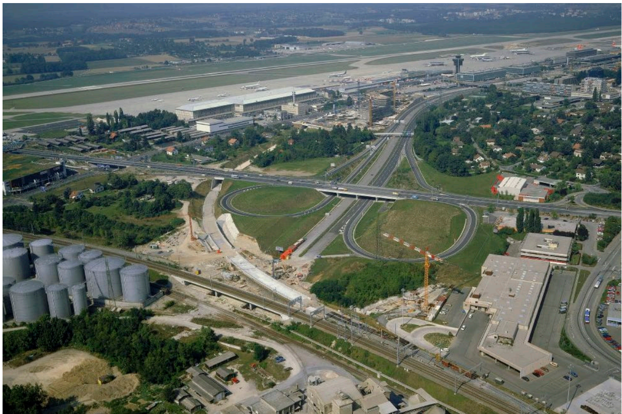
Abb. 26: Die Bauarbeiten an der Flughafenlinie Genf. Aufnahme vom September 1985. Fotografie von Comet Photo AG. Quelle: COM FC25-0002-010.
