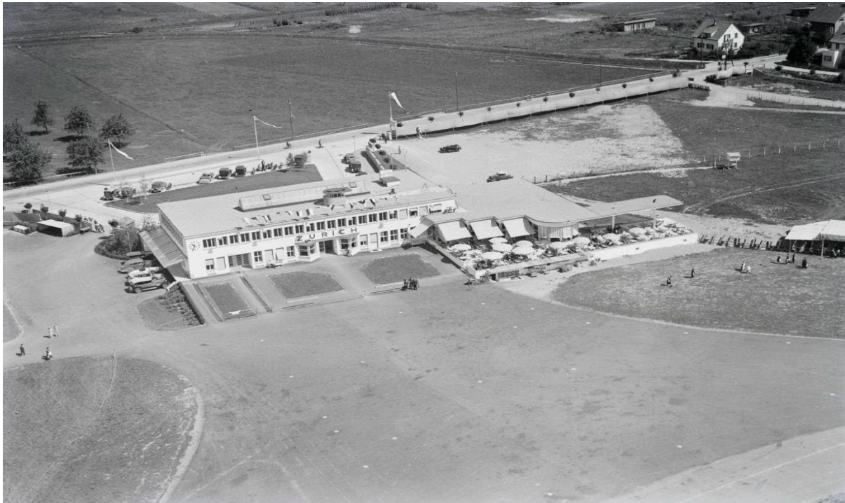
Abb. 2: Dübendorf, Flugplatzgebäude. Aufnahme vom 29.07.1934. Fotografie von Swissair. Quelle: LBS SR02-10670.
