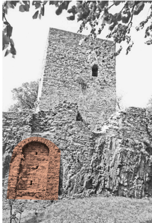
5 Frutigen, Tellenburg. Die Umfassungsmauer wird seit der ersten Sanierung 1929/30 durch einen vorgesetzten Pfeiler (orange Fläche) gestützt. Es handelt sich um eine präventive oder zumindest nur minimal invasive Massnahme. Der Pfeiler ist aus dem gleichen Steinmaterial wie das Mauerwerk der Burg und passt sich somit optimal in das Ruinenbild ein. Blick nach Westen. Aufnahme von 1974.
