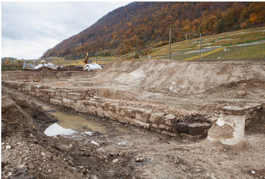
4 La Neuveville, Chavannes. Partie occidentale du mur du port réalisé en blocs calcaires dressés à joints vifs. À droite, derrière la chambre de ciment, amorce du débarcadère. Vue vers l'ouest.
