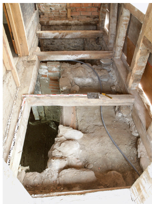
29 Thun, Schorenstrasse 40. Die Sondage V legte die Situation unter dem Fussboden des Raumes 4 frei. Die Backsteinmauer (117) steht auf der alten Kellertreppe (122) aus der Phase 3. Der dazugehörige Keller (Raum 2) reicht bis zum dritten Bodenbalken. Links zeigt sich das Flickmauerwerk (46) aus Phase 5. Von der Bildmitte bis zum Vordergrund zieht sich die versetzte Südostmauer (45) des Kellers (Raum 1). Zustand 2020.
