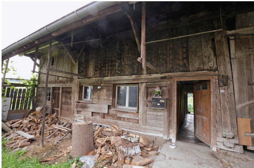
5 Schwarzenburg, Albligen Mischleren 96. Blick an die Nordfassade. Zentral im Bild die zweigeschossig abgegebundene Fassade der ältesten Hauskonstruktion, unten stark durch Fenster und vorge nagelte Bretter überprägt, oben die stehenden, mit Beilhieben verzierten Bohlen.
