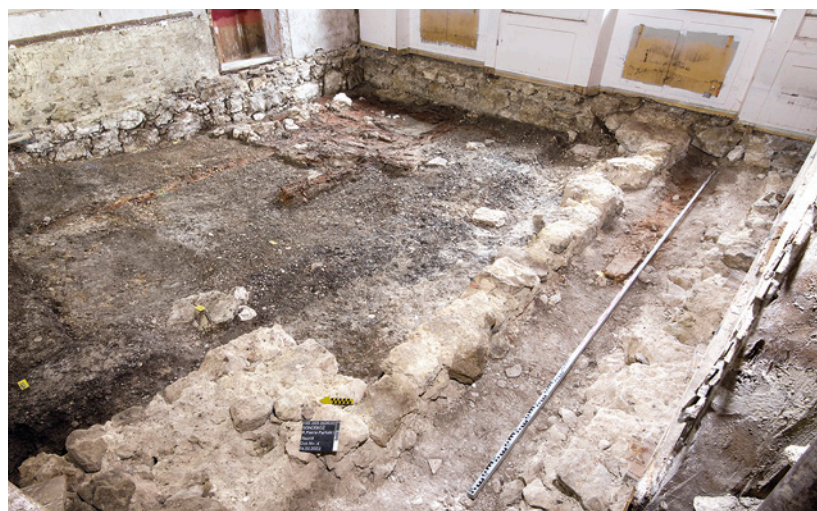
9 Sonceboz-Sombeval, Rue Pierre-Pertuis 1. Anciens murs et restes de plancher (phases 1 à 4) apparus sous le parquet de la salle à manger. Vue vers l'est.
