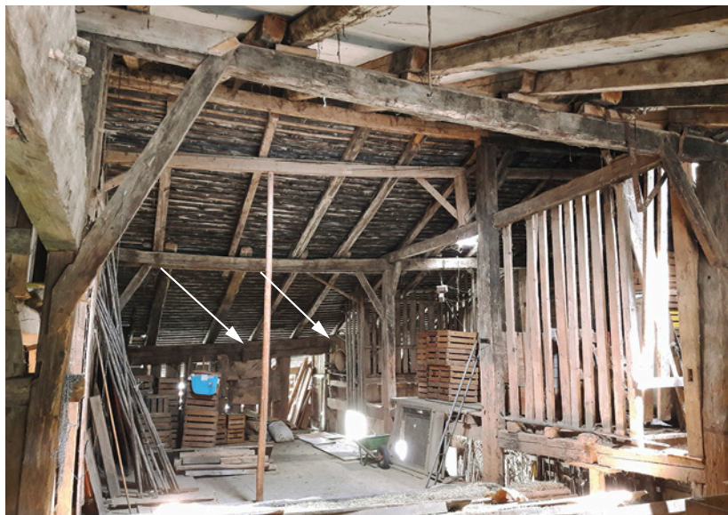
13 Thun, Schorenstrasse 40. Blick auf die ehemaligen Bühnen (Raum 27) und den QB III mit der Reite (Räume 26 und 31) über dem Tenn. Im Hintergrund die Wandpfette (1, Abb. 11) vom LB I. Dort gewährt ein zweites, mit Quersätteln (weisse Pfeile) verkämmtes Langholz das verwindungssteife Überspannen grösserer Distanzen. Zustand 2018. Blick nach Osten.
