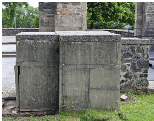
7 Rüeggisberg, Kloster. Südwestlicher Vierungspfeiler der Klosterkirche mit der Plattenverkleidung der 1980er-Jahre. Blick nach Osten. Aufnahme von 2016.
