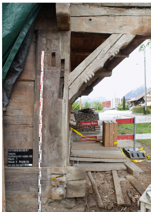
24 Thun, Schorenstrasse 40. Der Eckständer der nordwestlichen Stubenecke trägt dort, wo ein Übergang zum gemauerten Stall zu erwarten wäre, ein kurzes Zapfloch für einen Bundbalken des Stallgerüsts und ein längeres für seine Versteifung mittels Kopfband. Beide deuten darauf hin, dass sich dort ein ursprünglicher Zugang zum Tenn befand. Blick nach Südosten.
