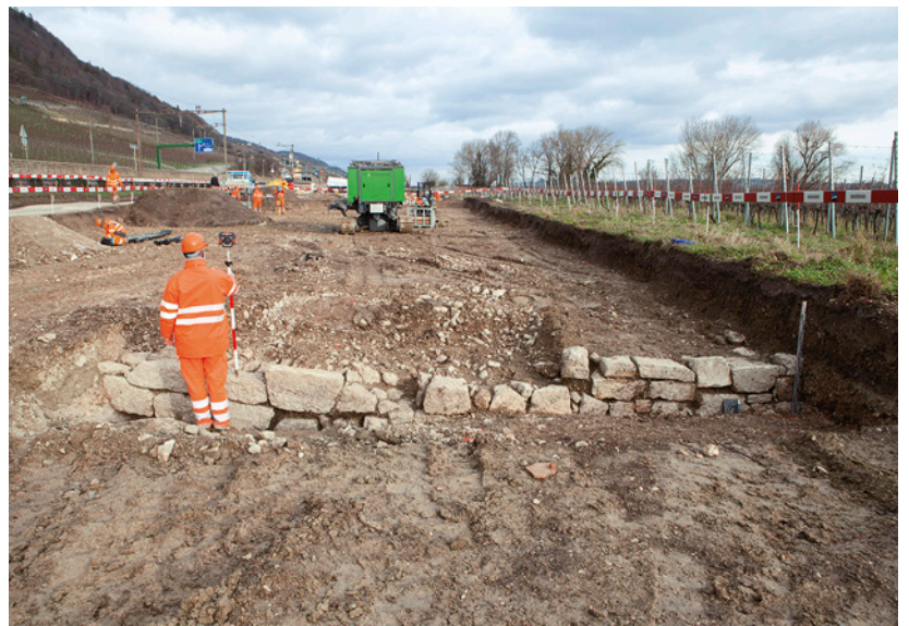
7 La Neuveville, Chavannes. Muret à parement simple, perpendiculaire à la rive, délimitant une des « levées » gagnées sur le littoral. Vue vers l'est.
