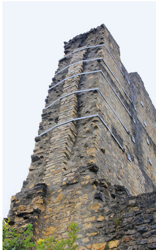
17 Ormalingen BL, Farnsburg. Das Mauerwerk wird mit einer Vormauerung und Stahlbänder gesichert. Blick nach Nordwesten. Aufnahme von 2020.
