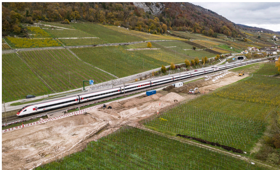
1 La Neuveville, Chavannes. Vue partielle du chantier de doublement de la voie CFF. Vue vers le nord.
