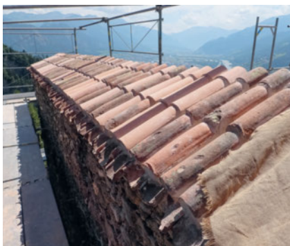
4: Neu-Aspermont, Jenins GR. Die mit neu hergestellten Hohlziegeln ergänzte Kronenabdeckung des Wohnturms. Blick nach Süden, © M. Vasella.
