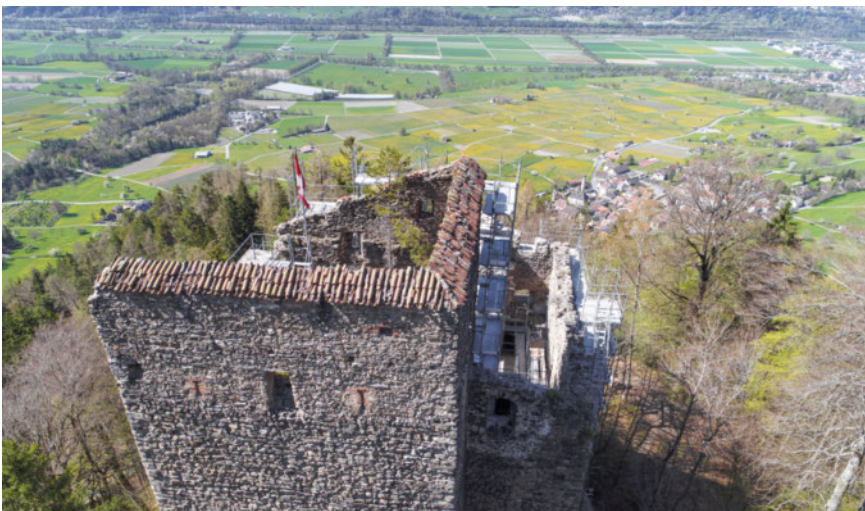
1: Neu-Aspermont, Jenins GR. Blick nach Südwesten auf die Kronenabdeckung von 1466 aus Hohlziegeln, © ADG.
