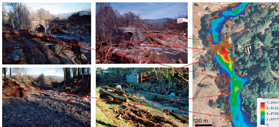
Figura 9: Tramo analizado del arroyo Cabrera, las fotografías muestran los depósitos de material leñoso y el puente principal unos días después de la inundación de 1997. La imagen de la derecha muestra los resultados de la simulación, con el patrón espacial de los depósitos y el nivel del agua (calado).
