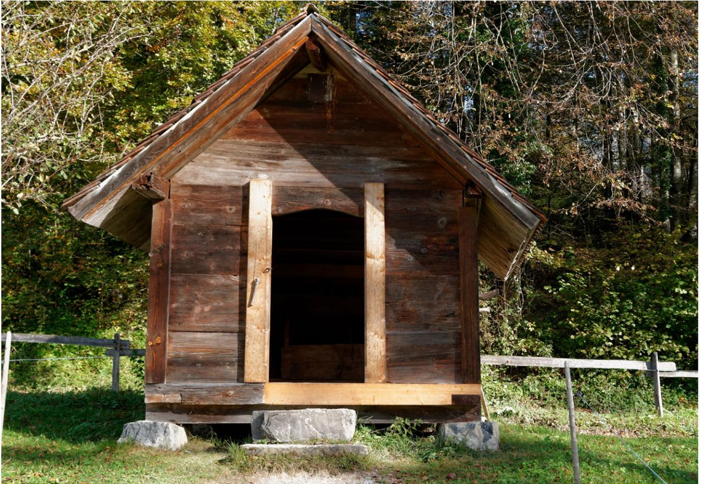
**15** Freilichtmuseum der Schweiz, Kornspeicher aus Montsevelier: Im Jahr 2011 wurden die Türpfosten sowie Teile des Schwellenkranzes ersetzt. Diese Massnahmen sind auf dieser Aufnahme noch gut zu erkennen, das Holz ist seitdem nachgedunkelt. Blick nach Nordosten. Aufnahme 2014.
