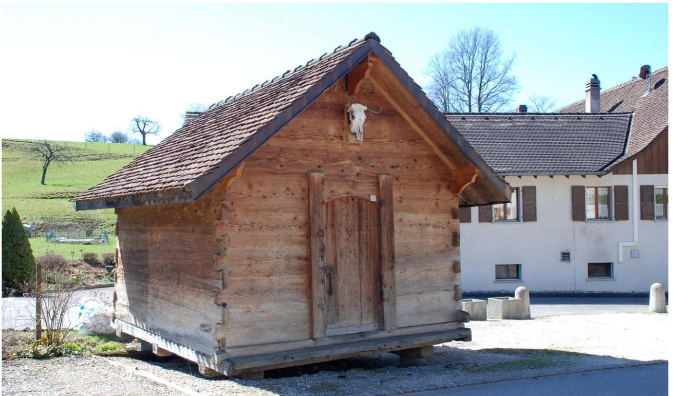
**13** Montsevelier: Ein Kornspeicher in Blockbauweise mit Schwalbenschwanzverzinkung: Auch von diesem kann angenommen werden, dass er versetzt wurde. Aufnahme 2010.
