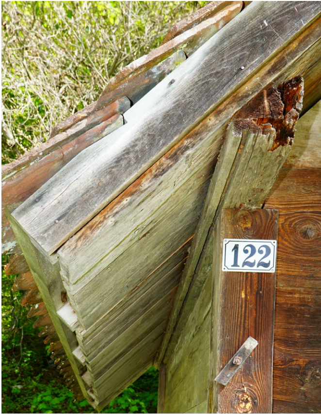
10 Freilichtmuseum der Schweiz, Kornspeicher aus Montsevelier: In die Nut des Rähmbalkens wurde möglicherweise früher eine vertikale Bretterschalung eingefügt, um das Gebäude besser vor der Witterung zu schützen. Aufnahme 2022.
