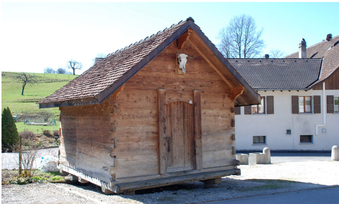
13 Montsevelier: Ein Kornspeicher in Blockbauweise mit Schwalbenschwanzverzinkung: Auch von diesem kann angenommen werden, dass er versetzt wurde. Aufnahme 2010.
