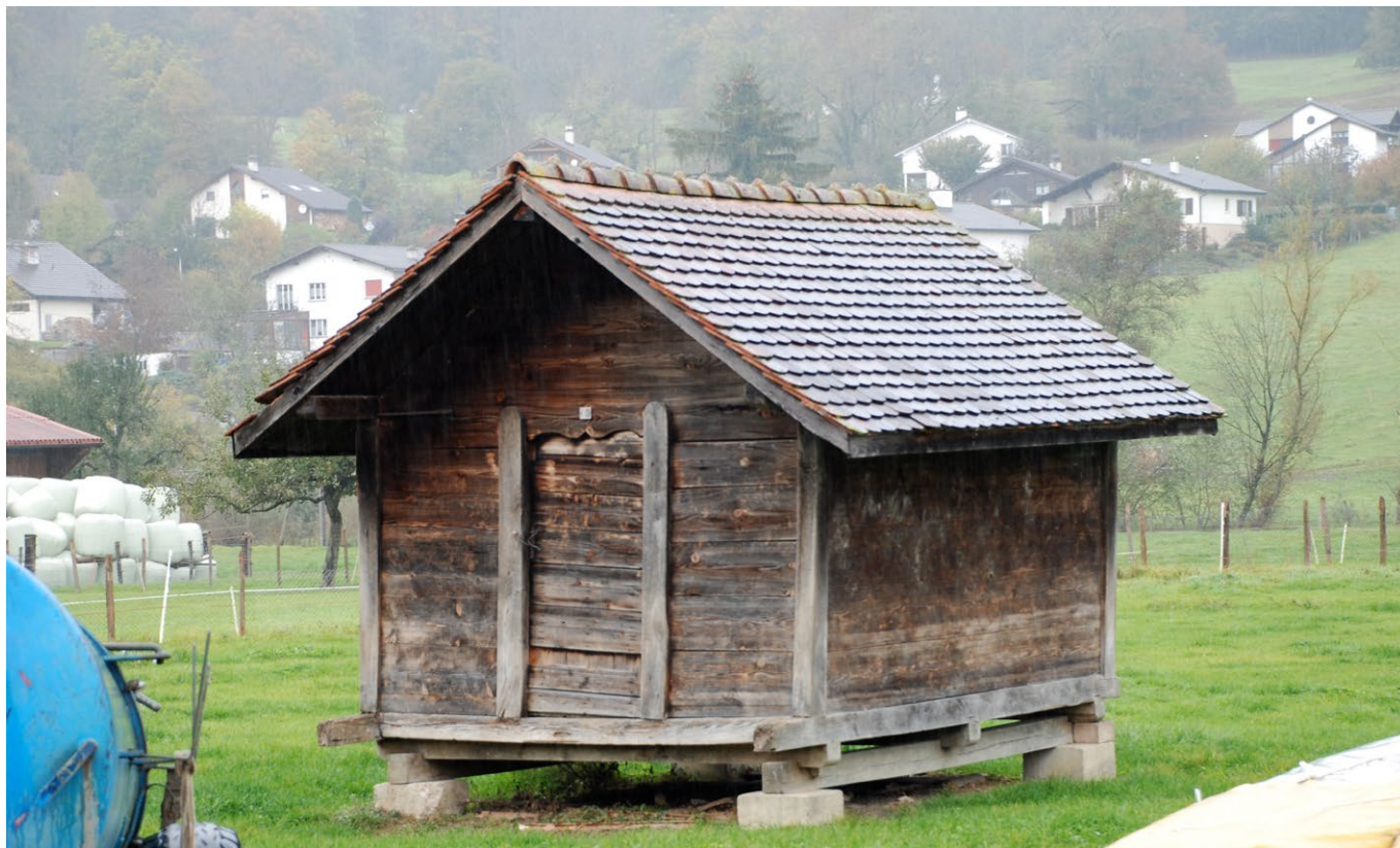
12 Courchapoix JU: Ein Kornspeicher in Ständerbohlenkonstruktion. Die winkelrechten Steinfundamente suggerieren, dass der Speicher an diesen Ort versetzt wurde. Aufnahme 2009.
