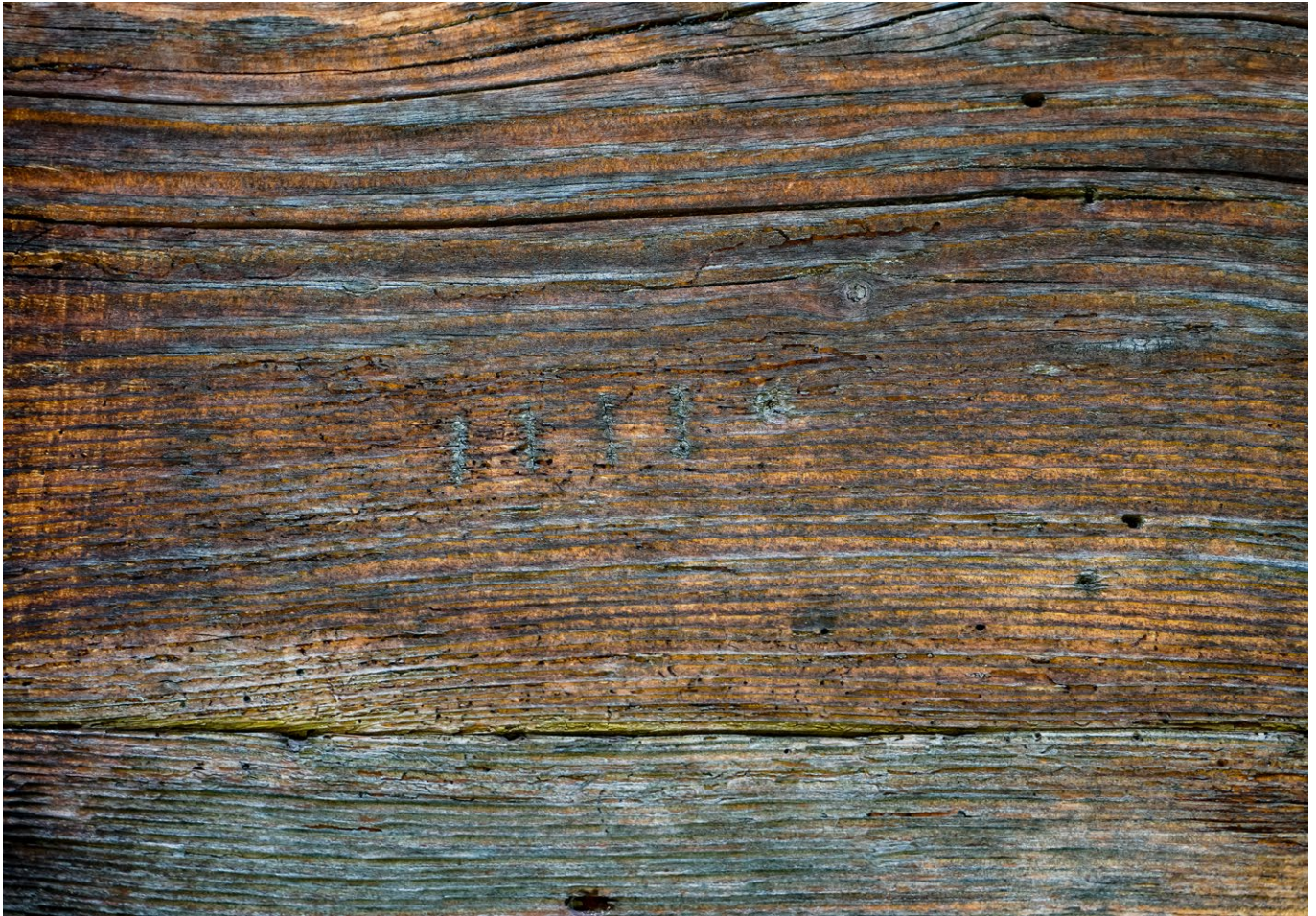
6 Freilichtmuseum der Schweiz, Kornspeicher aus Montsevelier: Einige Bohlen im oberen Wandbereich der Gebäudefront weisen Abbundzeichen auf. Aufnahme 2022.
