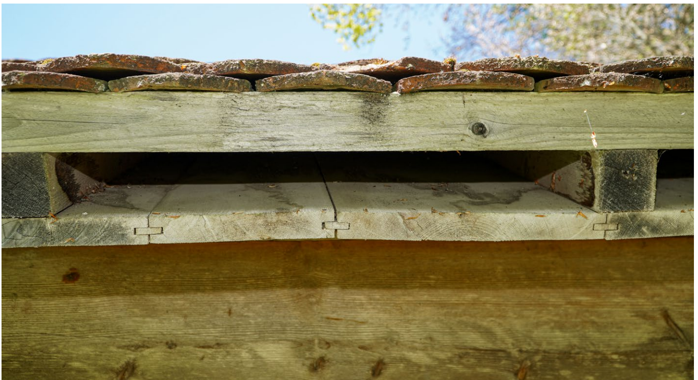
11 Freilichtmuseum der Schweiz, Kornspeicher aus Montsevelier: Die Deckenbretter sind sehr sorgfältig über kleine Leisten miteinander verbunden und der Schutz vor Ungeziefer ist gewährleistet. Aufnahme 2022.
