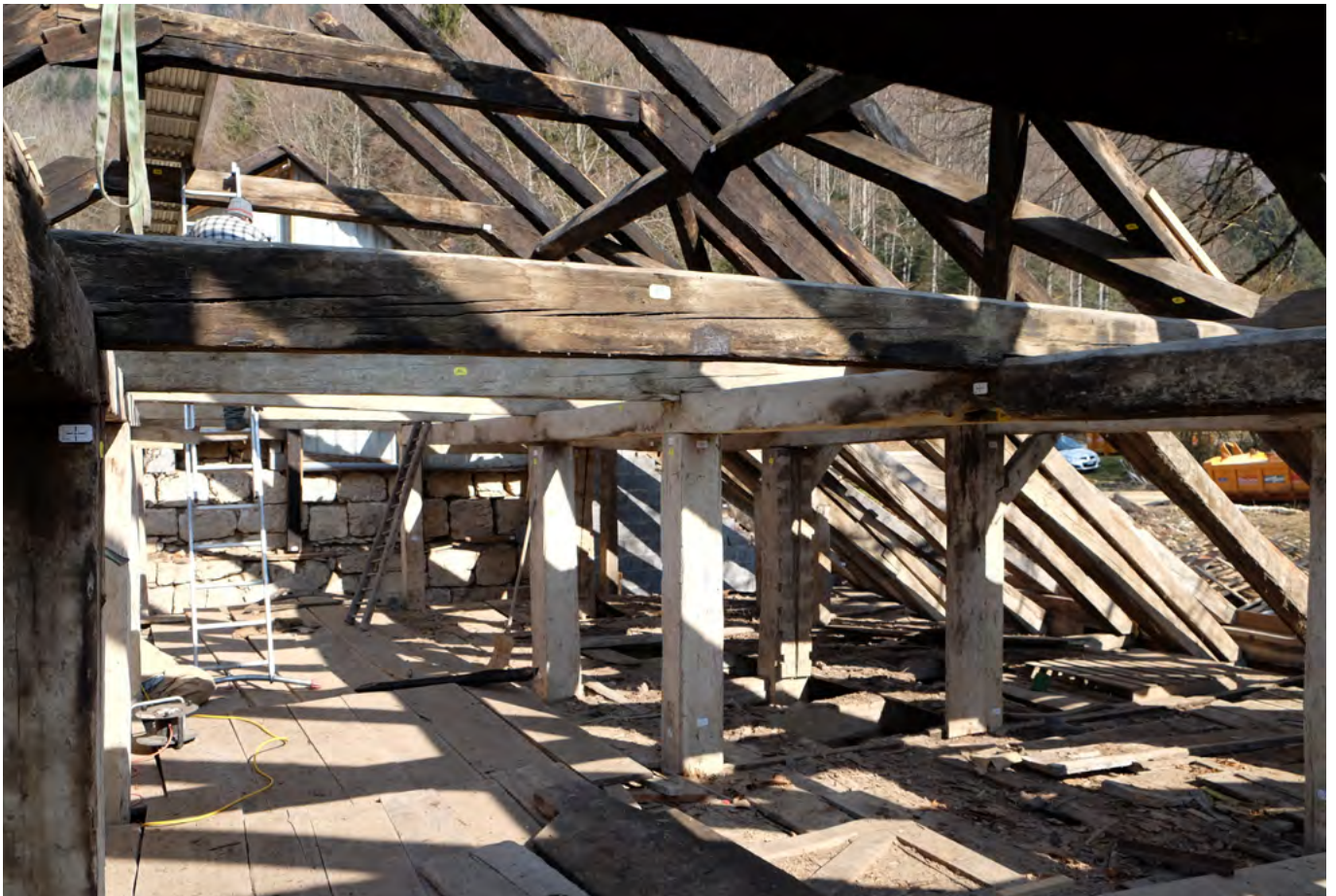
19 Péry, Planche Nanry: Der Dachraum der Ziegelhütte während des Abbaus für die Translozierung ins Freilichtmuseum. Blick nach Norden. Aufnahme 2016.
