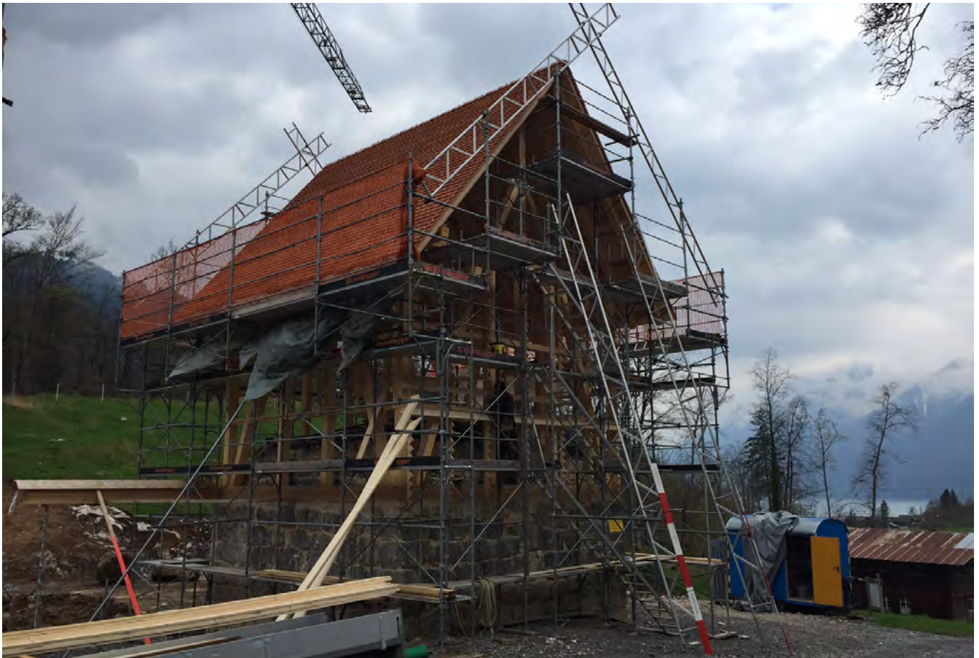
20 Freilichtmuseum der Schweiz, Ziegelei aus Péry: Aufbau des neuen turmförmigen Holzbaus über dem wiedererrichteten Brennofen. Aufnahme 2017.
