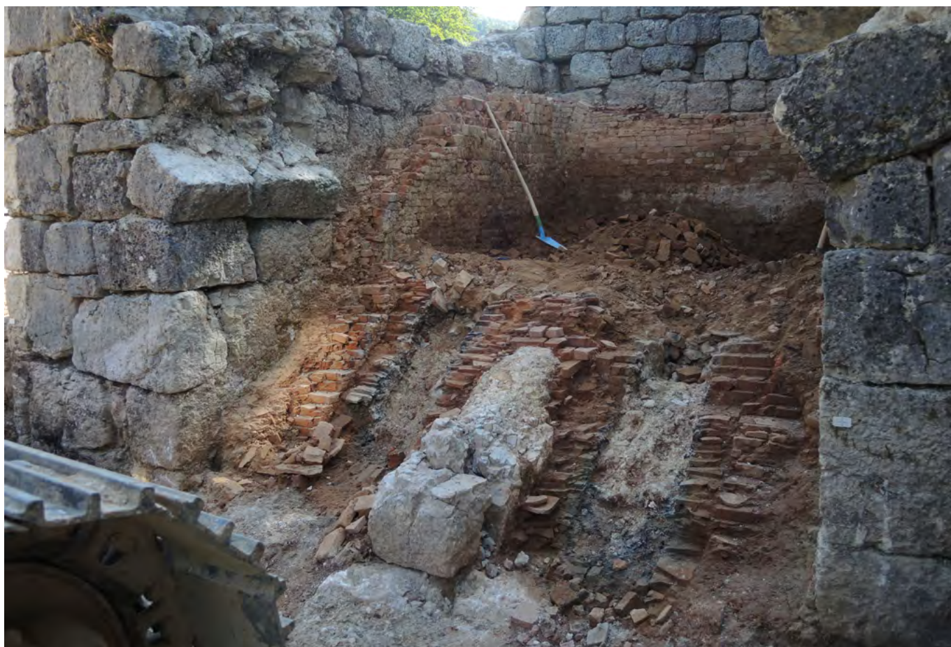
8 Péry, Planche Nanry: Freilegung des Ziegelbrennofens durch den ADB. Unter dem Schutt der aus Backsteinen gemauerten Innenisolierung liegt die durch eine Scheidewand aus Kalksteinen in zwei Kammern geteilte Feuerung des Ofens. Die beiden Schürkanäle waren ebenfalls mit Backsteinen isoliert. Dazwischen liegt gebrannter Kalk vom letzten Brand, wohl vor 1905. Blick nach Osten. Aufnahme 2016.
