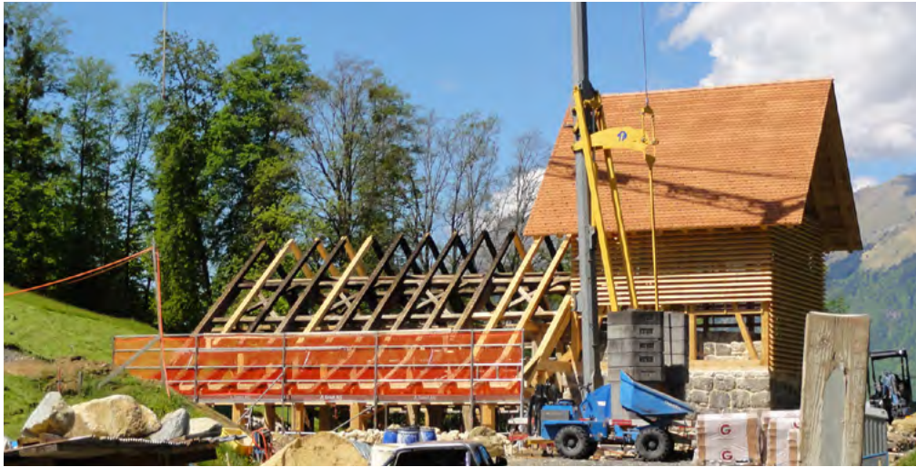
21 Freilichtmuseum der Schweiz, Ziegelei aus Péry: Wiederaufbau der historischen Ziegelscheune. Soweit möglich, wurden die historischen Baumaterialien wiedereingesetzt. Der Brennofen mit dem hölzernen Schutzbau ist bereits fertiggestellt. Blick nach Südwesten. Aufnahme 2017.
