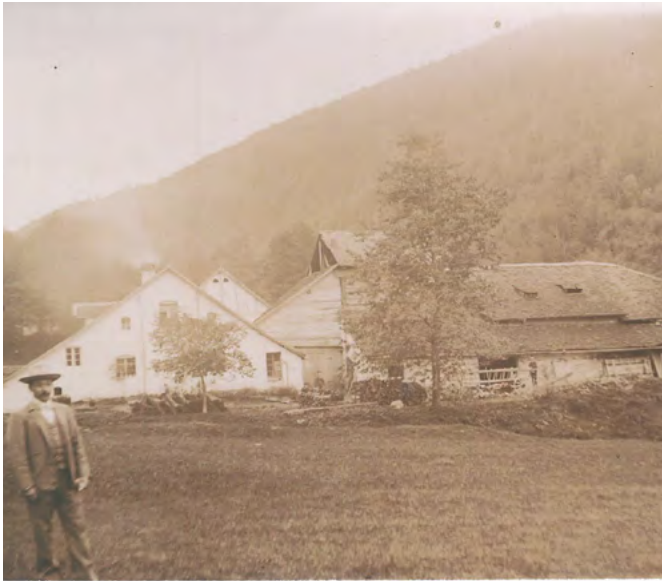
6 Péry, Planche Nanry: Die Ziegelei vermutlich kurz vor der Stilllegung des Betriebs. Gut zu erkennen ist rechts im Vordergrund die verbretterte Ziegelhütte mit dem noch stehenden Holzturm über dem Brennofen. Links davon sind die beiden an der Strasse angeordneten jüngeren Steingebäude mit ihren breitgelagerten Satteldächern zu sehen. Blick nach Osten. Aufnahme um 1905.
