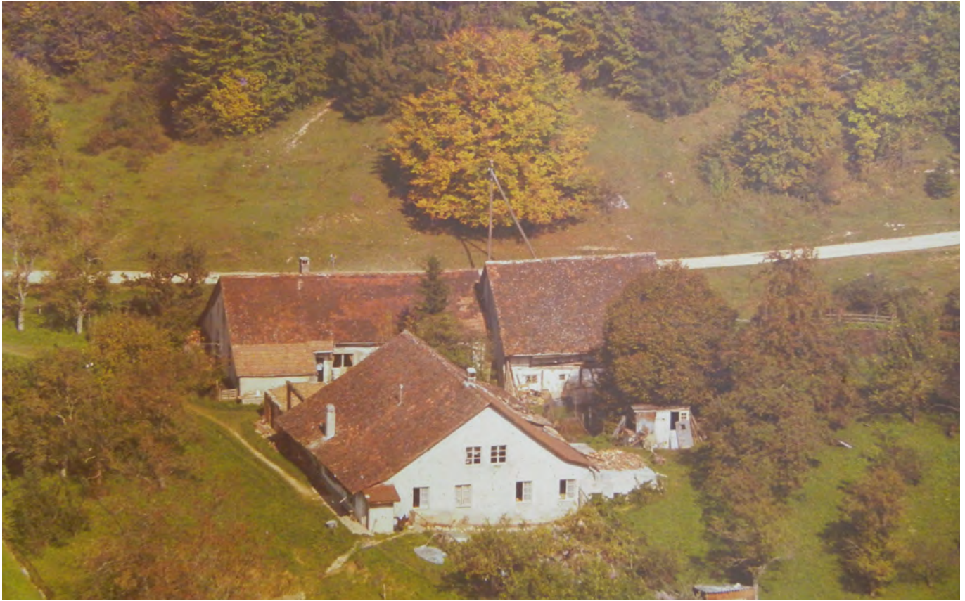
4 Péry, Planche Nanry: Luftbild zur Baugruppe der ehemaligen Ziegelei. Im Vordergrund steht die damals bereits zum Wohngebäude umgenutzte Ziegelhütte aus dem 18. Jahrhundert, der hölzerne Turm über dem Brennofen fehlt bereits. Dahinter sind parallel zur Strasse die beiden jüngeren Steingebäude der Ziegelei aus dem 19. Jahrhundert angeordnet. Blick nach Norden. Aufnahme um 1980.
