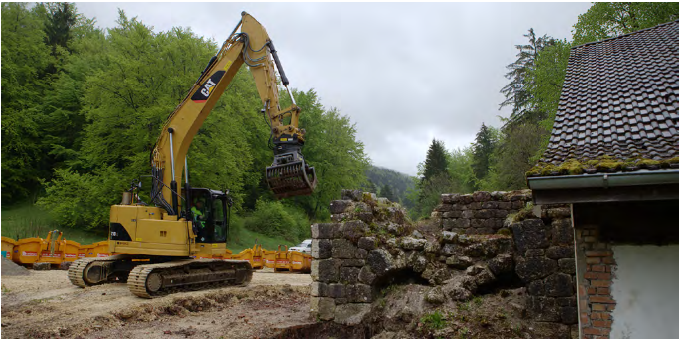
18 Péry, Planche Nanry: Die Ofenruine zu Beginn der Freilegung und des Abbaus der Mantelmauern für den Transport zum Freilichtmuseum. Blick nach Osten. Aufnahme 2016.
