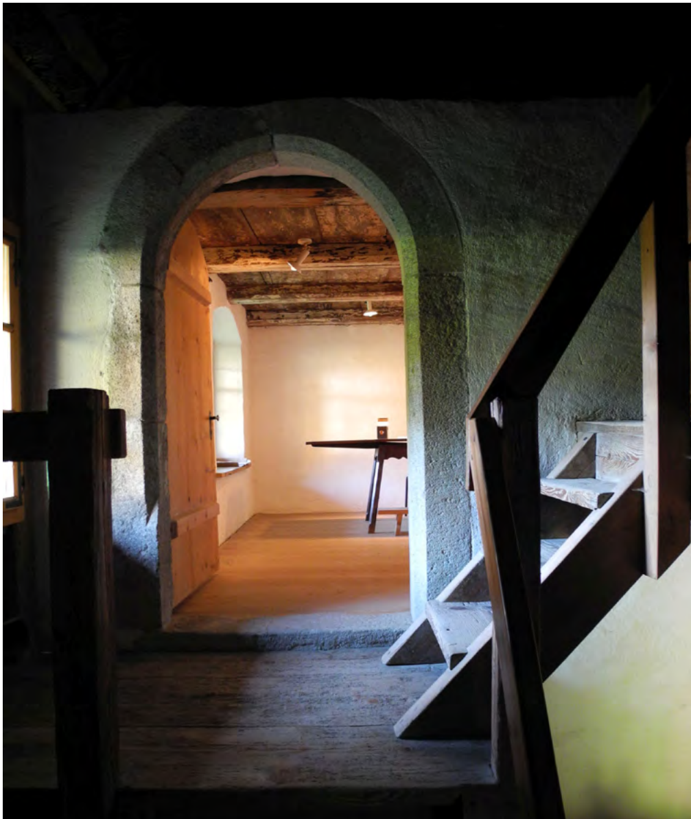
40 Freilichtmuseum der Schweiz, Bauernhaus aus Oberentfelden: Rekonstruierter Erschliessungsbe- reich im Wohnteil vor dem gemauerten Stock mit Blick in dessen erhöhtes Erdgeschoss. Die kleine Stiege führt zum Gaden des Wohnteils. Blick nach Süden. Aufnahme 2013.
