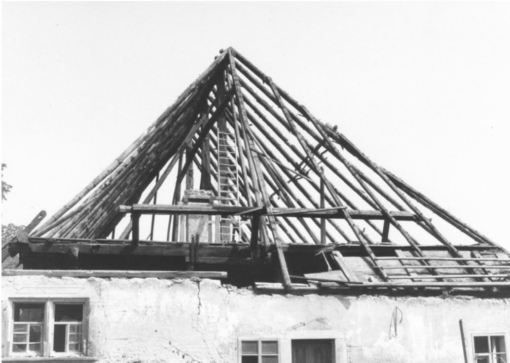
24 Oberentfelden, Schustergässli 1/3: Blick in den Dachraum der Hochstudkonstruktion nach dem Abtragen der Dachdeckung und Lattung. Blick nach Norden. Aufnahme 1933.
