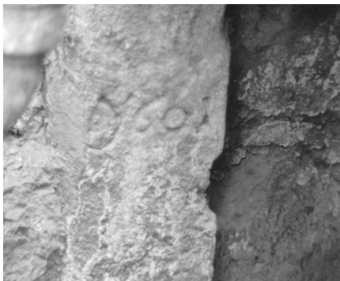
11 Oberentfelden, Schustergässli 1/3: Seitliches Türgewände des Kellerzugangs im gemauerten Stock. Der Stein trägt eine verwaschene und schwer lesbare Inschrift, die wohl als Jahreszahl «1601» zu entziffern ist. Ob dies den Zeitpunkt des Baus des gemauerten Stocks angibt, ist zwar wahrscheinlich, aber letztlich nicht mehr zu verifizieren. Blick nach Westen. Aufnahme 1983.
