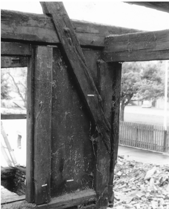
25 Oberentfelden, Schustergässli 1/3: Unterer Bereich der Dachkonstruktion während des Abbaus. Zu sehen ist das untere Ende des Sperrrafens , der hier im Gaden auf den Ständer der Aussenwand abgesprengt und mit diesem verblattet ist. Darüber ist das Langband mit dem Spannbalken der Dachbasis verblattet. Aufnahme 1983.
