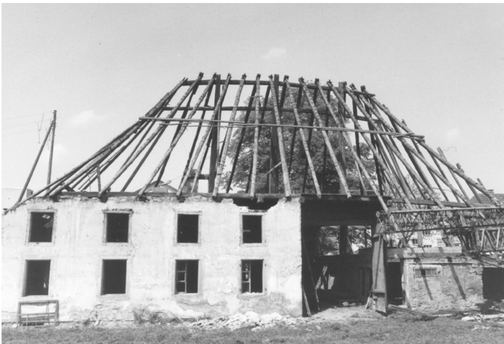
16 Oberentfelden, Schustergässli 1/3: Östliche Längsseite des Vielzweckbauernhauses während des Abbaus. Nach dem Abtragen der Dachdeckung sind im gemauerten Wohnteil auch die gleichförmig angeordneten Fenster des Gadens zu sehen. Nördlich davon liegt das mittige Tenn. Zu sehen ist ein Flügel des zweiteiligen Tores. Darüber steht das von der Hochstudkonstruktion des Ursprungsbaus getragene Dachwerk. Blick nach Westen. Aufnahme 1983.
