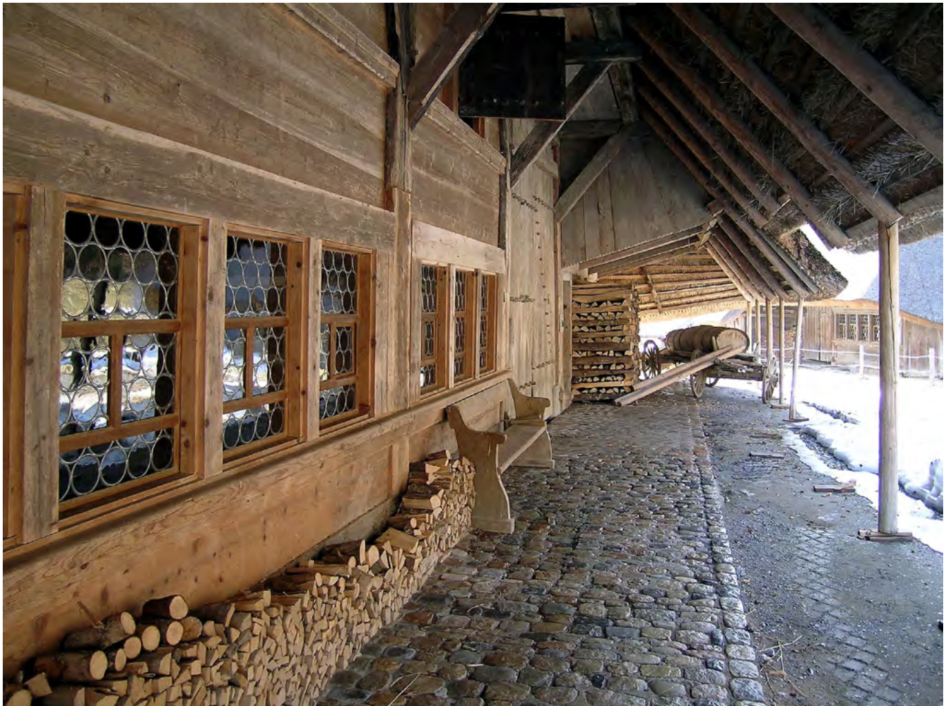
39 Freilichtmuseum der Schweiz, Bauernhaus aus Oberentfelden: Die wiederhergestellte Stubenfassade mit den neuen Bohlenwänden und den rekonstruierten Reihenfenstern im Erdgeschoss. Blick nach Westen. Aufnahme 2005.
