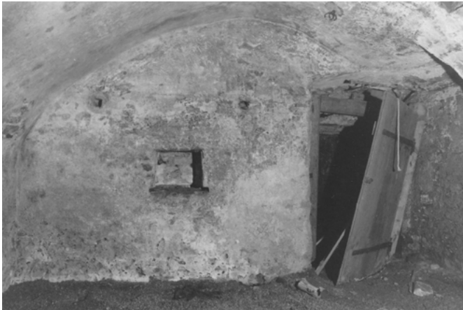
27 Oberentfelden, Schustergässli 1/3: Gewölbter Keller des gemauerten Stocks. Neben der Zugangstür ist eine quadratische Lichtnische zu sehen. Blick nach Osten. Aufnahme 1983.
