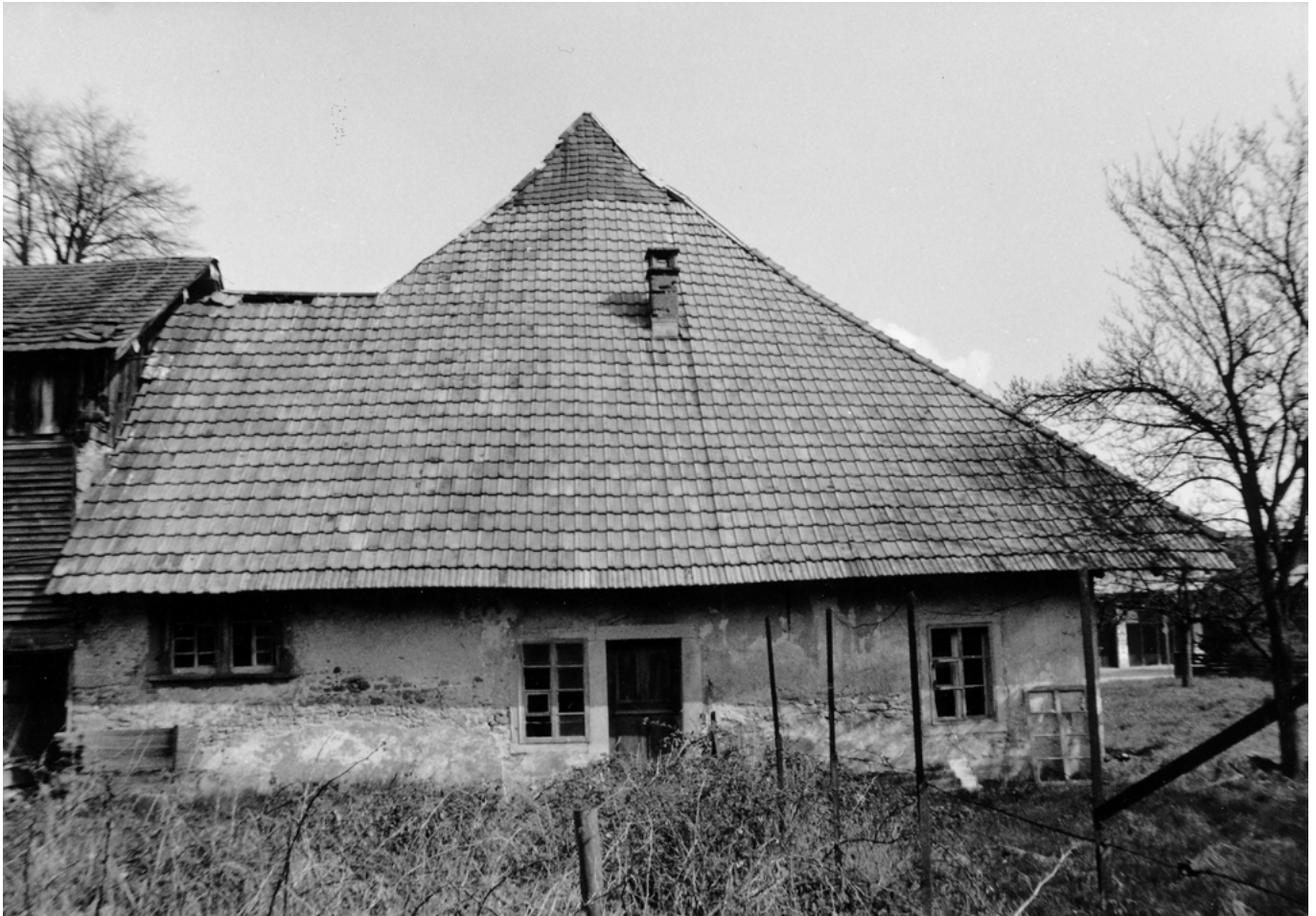
13 Oberentfelden, Schustergässli 1/3: Gemauerte und verputzte Südfassade des Wohnteils. Das Doppelfenster des gemauerten Stocks auf der linken Seite ist halb verdeckt von der weit herabgezogenen Dachfläche. Mittig liegen die Tür und das Fenster der jüngeren Küche des östlichen Wohnteils. Rechts ist das Fenster des nach der Hausteilung im 19. Jahrhundert eingebauten Eckzimmers zu sehen. Links schliesst auf der Strassenseite der jüngere Giebeldachanbau an, der zuletzt den Stock verdeckt hat. Blick nach Norden. Aufnahme 1982.
