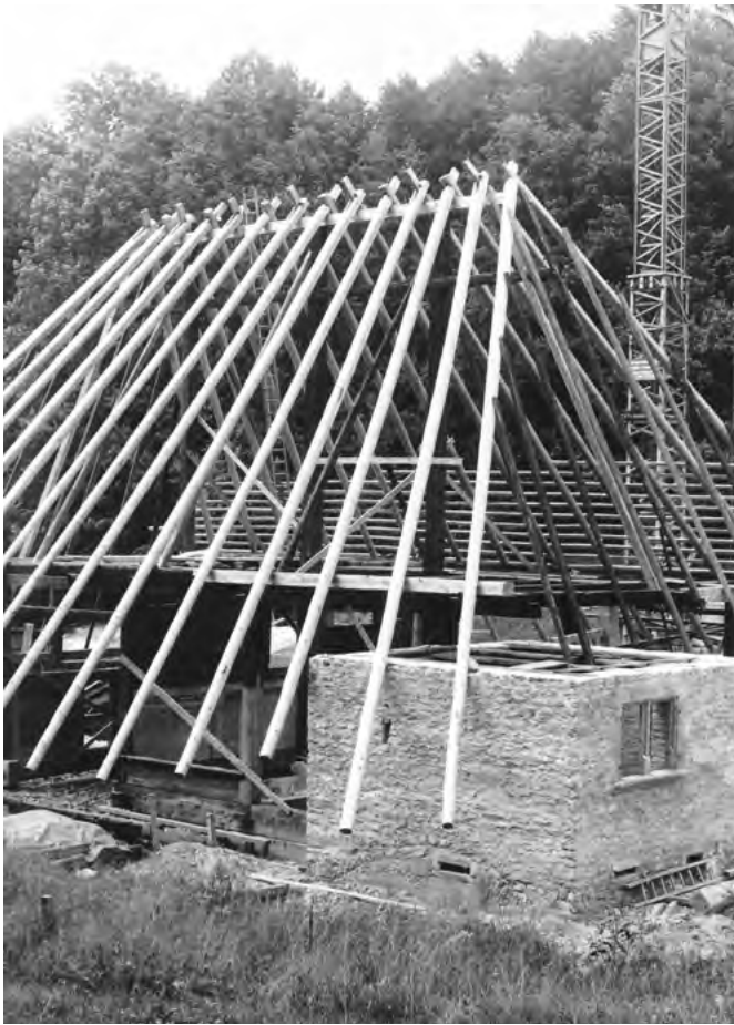
34 Freilichtmuseum der Schweiz, Bauernhaus aus Oberentfelden: Wiederaufbau des Hochstudgerüsts über dem bereits wiederhergestellten gemauerten Stock im Museum. Blick nach Nordwesten. Aufnahme 1984.
