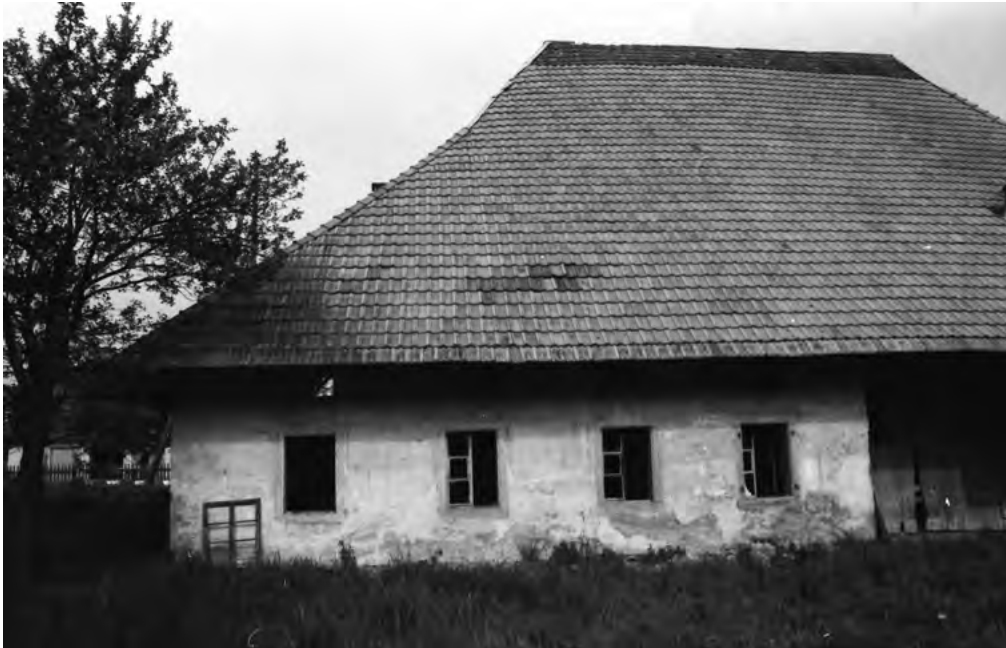
15 Oberentfelden, Schustergässli 1/3: Der gemauerte Wohnteil auf der östlichen Gartenseite. Unter dem weit herabgezogenen Walmdach ist nur die Fensterreihe der Erdgeschossräume zu sehen. Der Gaden versteckt sich vollständig unter dem Dachvorstand. Blick nach Westen. Aufnahme 1982.
