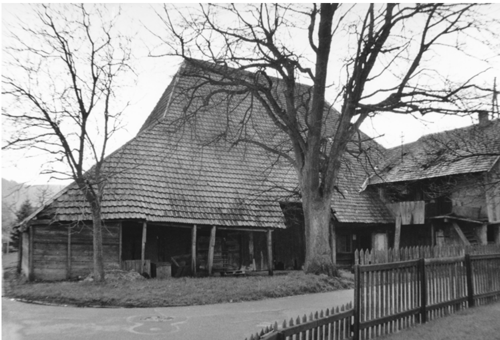
8 Oberentfelden, Schustergässli 1/3: Das Bauernhaus steht an der Einmündung des Schustergässli auf die Bergstrasse. Dort im Eckbereich ist ein jüngerer Anbau mit Schleppehdach an das Kerngebäude mit dem hohen Walmdach angefügt. Weiter südlich am Schustergässli, auf dem Bild rechts, hebt sich ein weiterer jüngerer Holzanbau mit zwei Geschossen und Satteldach vom Kernbau ab. Ein mächtiger Baum steht mittig vor der Tenneinfahrt. Blick nach Südosten. Aufnahme 1983.
