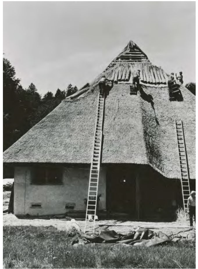
35 Freilichtmuseum der Schweiz, Bauernhaus aus Oberentfelden: Deckung der Dachflächen des fertiggestellten Bauernhauses. Blick nach Westen. Aufnahme 1985.
