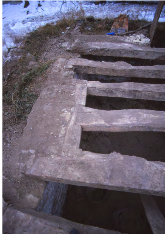
12 Leutwil, Zopfhüsi: Aufsicht auf den nordwestlichen Eckbereich des Kellers nach dem Abtrag des Holzgebäudes. Zu sehen sind die verbläteten Balkenenden der Deckenkonstruktion nach dem Entfernen der Bodendielen und der Steinausmauerung in den Zwischenräumen. Aufnahme 1998.
