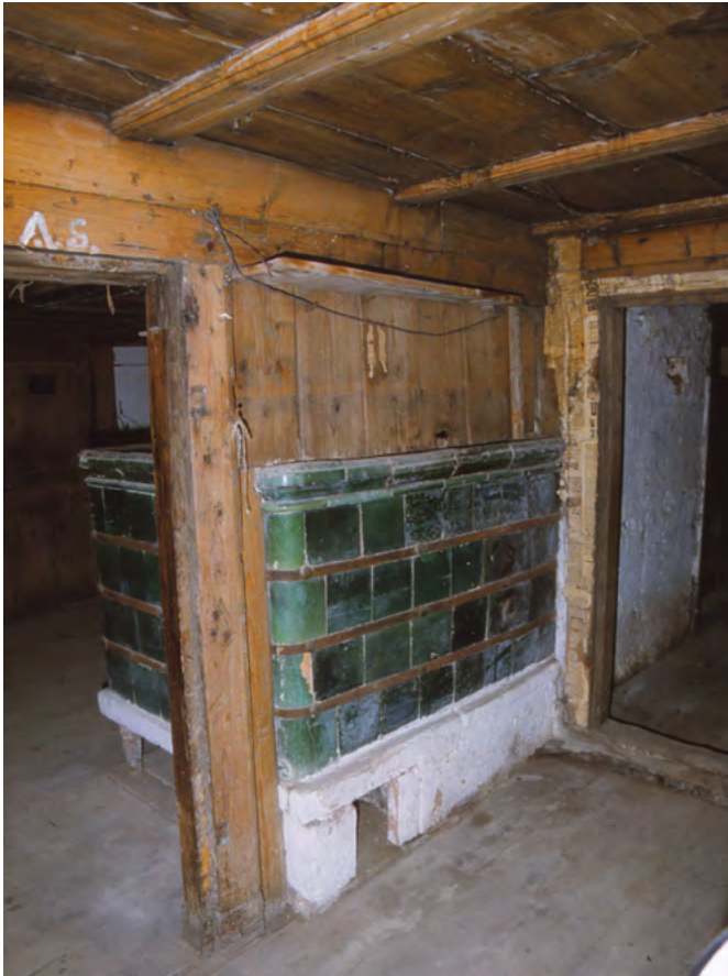
25 Leutwil, Zopf Hüsi: Blick auf die getäfelte Zwischenwand von Nebenstube und Stube. Der Stubenofen reicht in die Nebenstube hinein und heizt diese mit. Direkt links daneben grenzt der Türdurchgang zur Stube an. Rechter Hand ist der Zugang von der Stockkammer aus zu sehen. Blick nach Norden. Aufnahme 1998.
