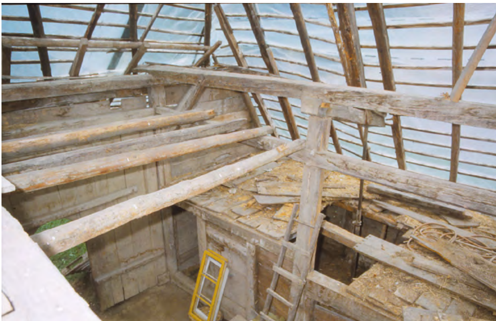
18 Leutwil, Zopf Hüsi: Blick vom Wohnteil in den südlichen Abschnitt des Ökonomieteils mit dem gartenseitigen Tenntor. Gut zu erkennen ist die Grundkonstruktion der Innenwand als Hochständerbau mit verblattetem Kopfband und aufgeblattetem Bindebalken. Blick nach Südwesten. Aufnahme 1998.
