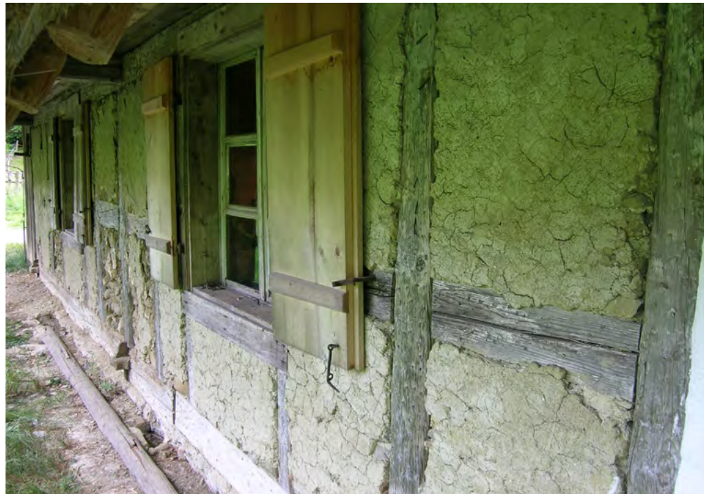
15 Leutwil, Zopfhüsi: Mit Steinen und Lehmputz ausgefachte Wandflächen auf der Ostseite. Sie wurden im Ganzen auf den Ballenberg transloziert und sind deshalb noch heute im Original erhalten. Blick nach Nordwesten. Aufnahme 2007.
