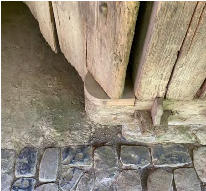
19 Freilichtmuseum der Schweiz, Kleinbauernhaus aus Leutwil: Schwellenkranz des Ökonomieteils mit Zapfenschloss und dem darin eingehängten Drehzapfen des Tennors auf der ehemaligen Zugangsseite an der Strasse. Blick nach Süden. Aufnahme 2020.
