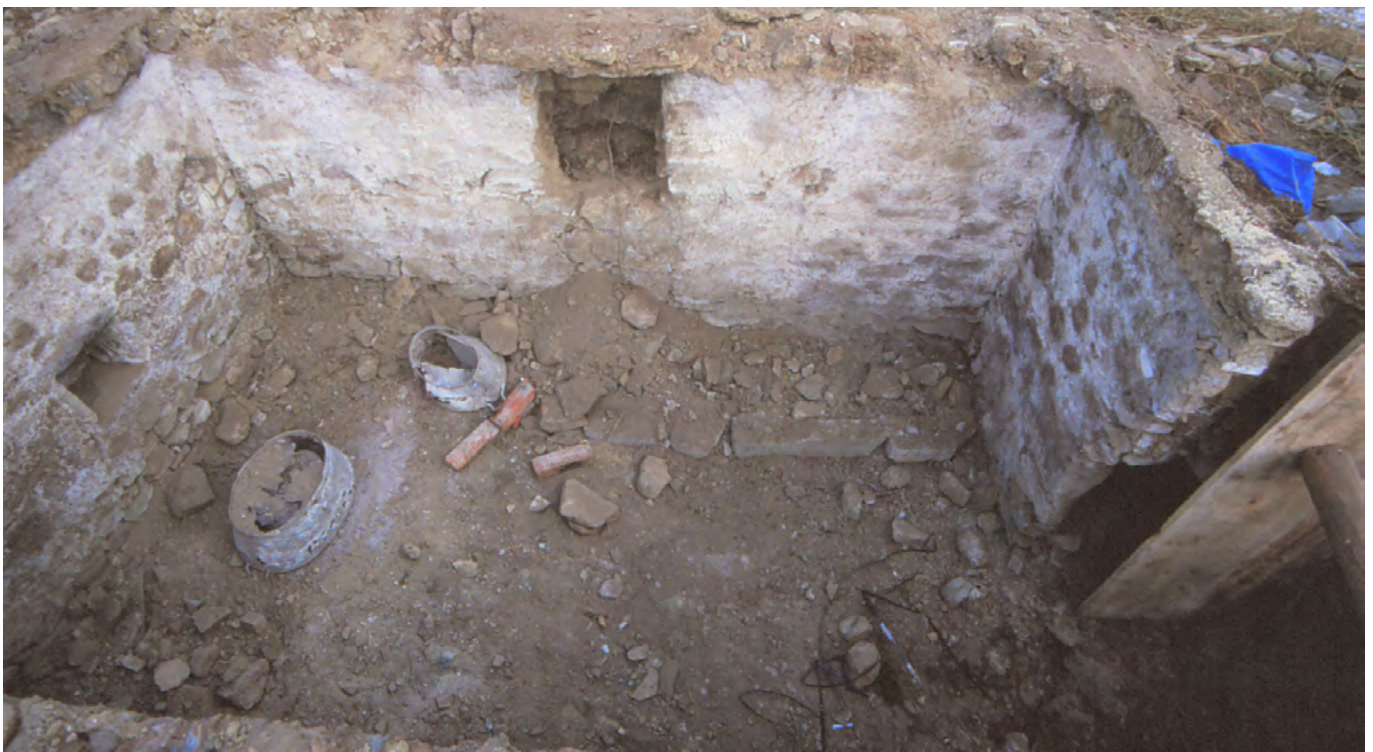
11 Leutwil, Zopfhüsi: Blick in den gemauerten Keller unter dem Kleinbauernhaus. Das Holzgebäude darüber ist zu diesem Zeitpunkt bereits abgetragen. Rechter Hand liegt der Kellerzugang von der Südseite. Links befindet sich eine Lichtnische. An der Ostseite ist die sich nach aussen verengende Lichtöffnung zu sehen. Blick nach Osten. Aufnahme 1998.
