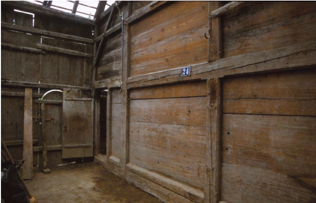
17 Leutwil, Zopf Hüsi: Blick auf die Hochständerwand mit Bohlenausfachung zwischen Tenn und Wohnteil. Die offenstehende Tür stellt die innere Erschließung zwischen dem Tenn und dem Gang des Wohnteils dar. Links daneben ist das doppelflügelige Tenntor zu sehen. Blick nach Norden. Aufnahme 1998.
