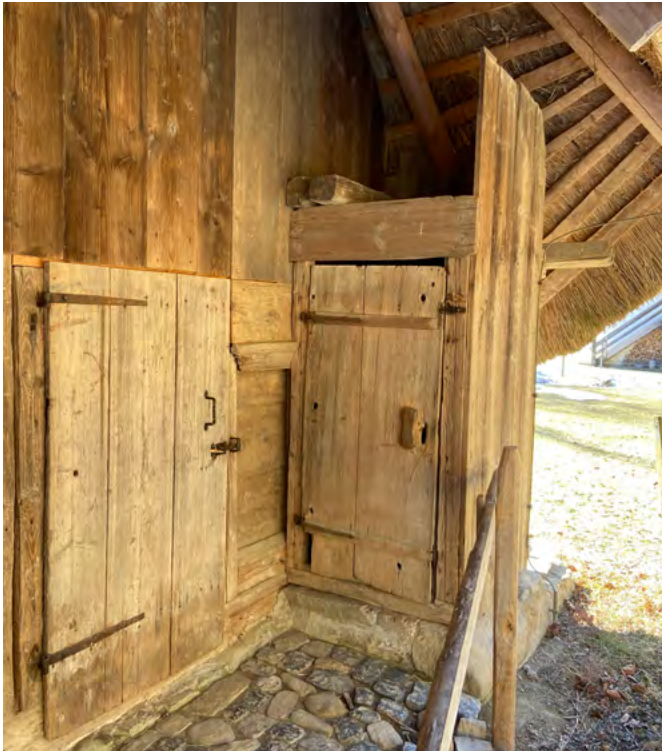
10 Freilichtmuseum der Schweiz, Kleinbauernhaus aus Leutwil: Das 1948/49 neu angebaute Toilettenhäuschen lag einst strassenseitig gegenüber vom Haus- eingang. Über den gepflasterten und überdachten Vorplatz konnte es trockenen Fusses aufgesucht werden. Linker Hand befindet sich die äussere Stalltür. Blick nach Westen. Aufnahme 2022.
