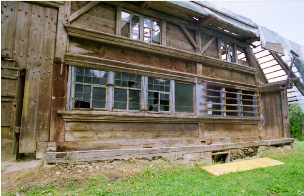
14 Leutwil, Zopfhusi: Südfassade des Ständerbaus mit der liegenden Bohlenaufschichtung und den verblätternen Kopfbändern. Unter der Nebenstube in der Südostecke liegt der gemauerte Keller. Die Fensterzonen sind zwischen den durchlaufenden, profilierten Brüstungs- und Sturzriegeln eingespannt. Blick nach Norden. Aufnahme 1998.
