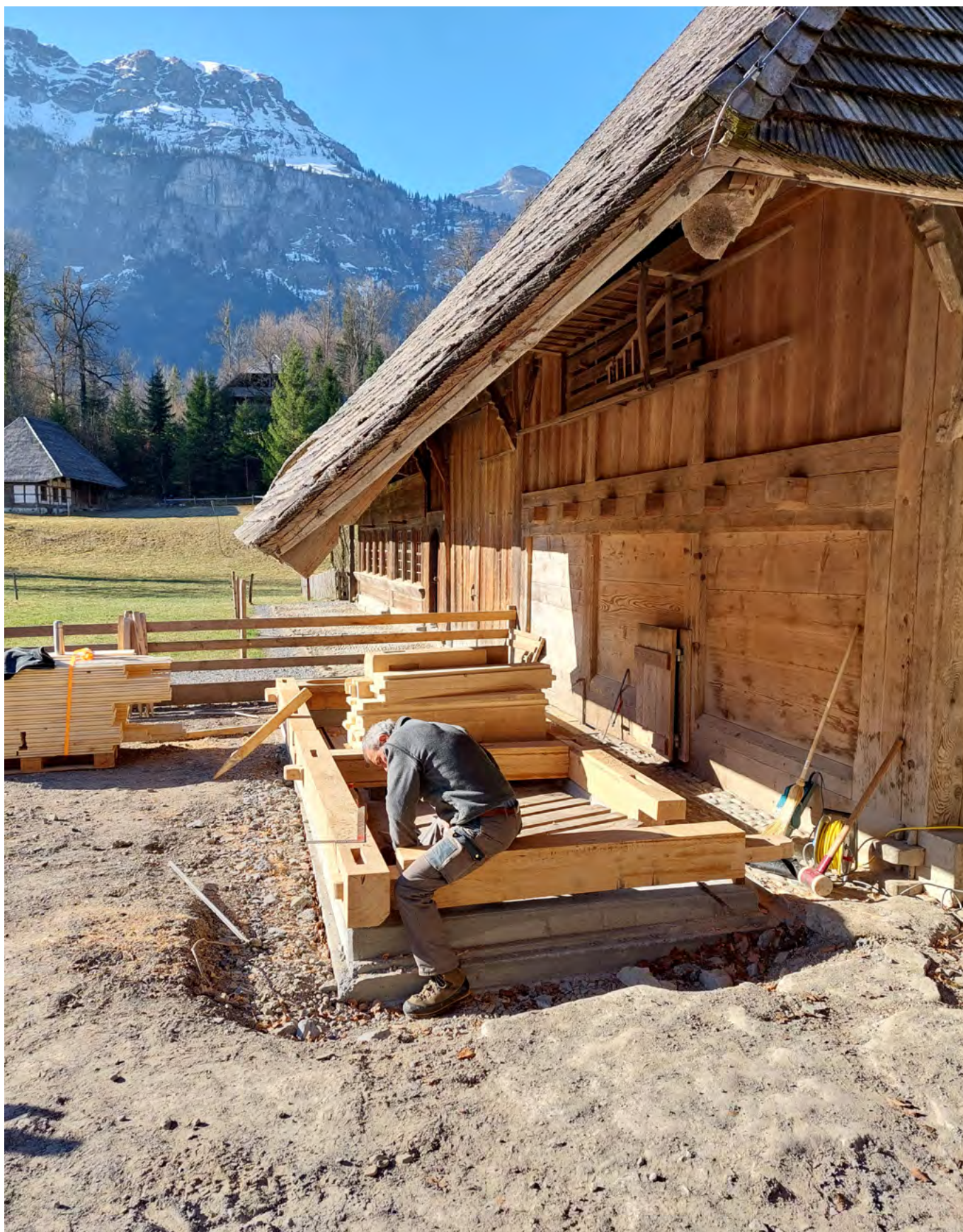
21 Freilichtmuseum der Schweiz, Bauernhaus aus Madiswil: Aufgrund des schlechten Erhaltungszustands wurde ein Grossteil des Stallteils aus neuem Holz aufgebaut. Der Schweinestall, auf der Aufnahme gerade im Bau, wurde bereits ein zweites Mal ersetzt. Aufnahme 2022.
