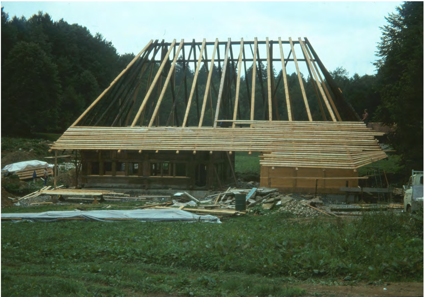
18 Freilichtmuseum der Schweiz, Bauernhaus aus Madiswil: Wiederaufbau des Bauernhauses im Freilichtmuseum. Blick nach Westen. Aufnahme 1975.
