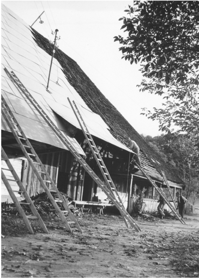
5 Madiswil, Bennacker: Westliche Längsseite des Hauses beim Umdecken der Dachhaut. Aufnahme vor 1975.
