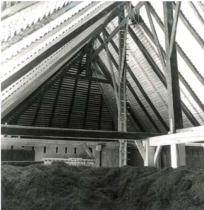
12 Freilichtmuseum der Schweiz, Bauernhaus aus Madiswil: Innenraum des Ökonomieteils mit gut erkennbarer die Hochstudkonstruktion. Aufnahme nach 1975.
