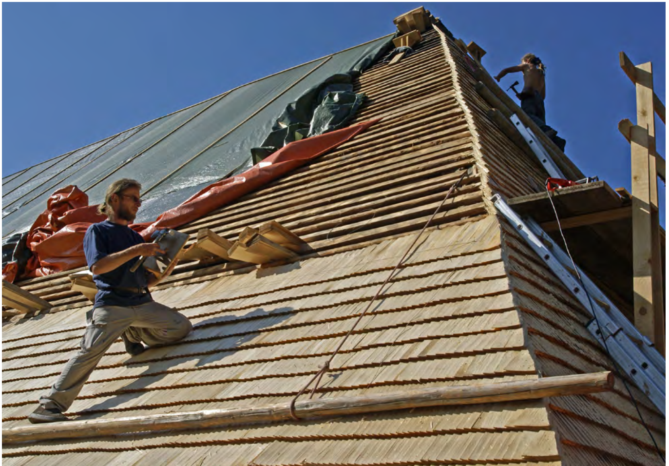
16 Freilichtmuseum der Schweiz, Bauernhaus aus Madiswil: Reparatur des Nagelschindeldachs. Aufnahme 2009.
