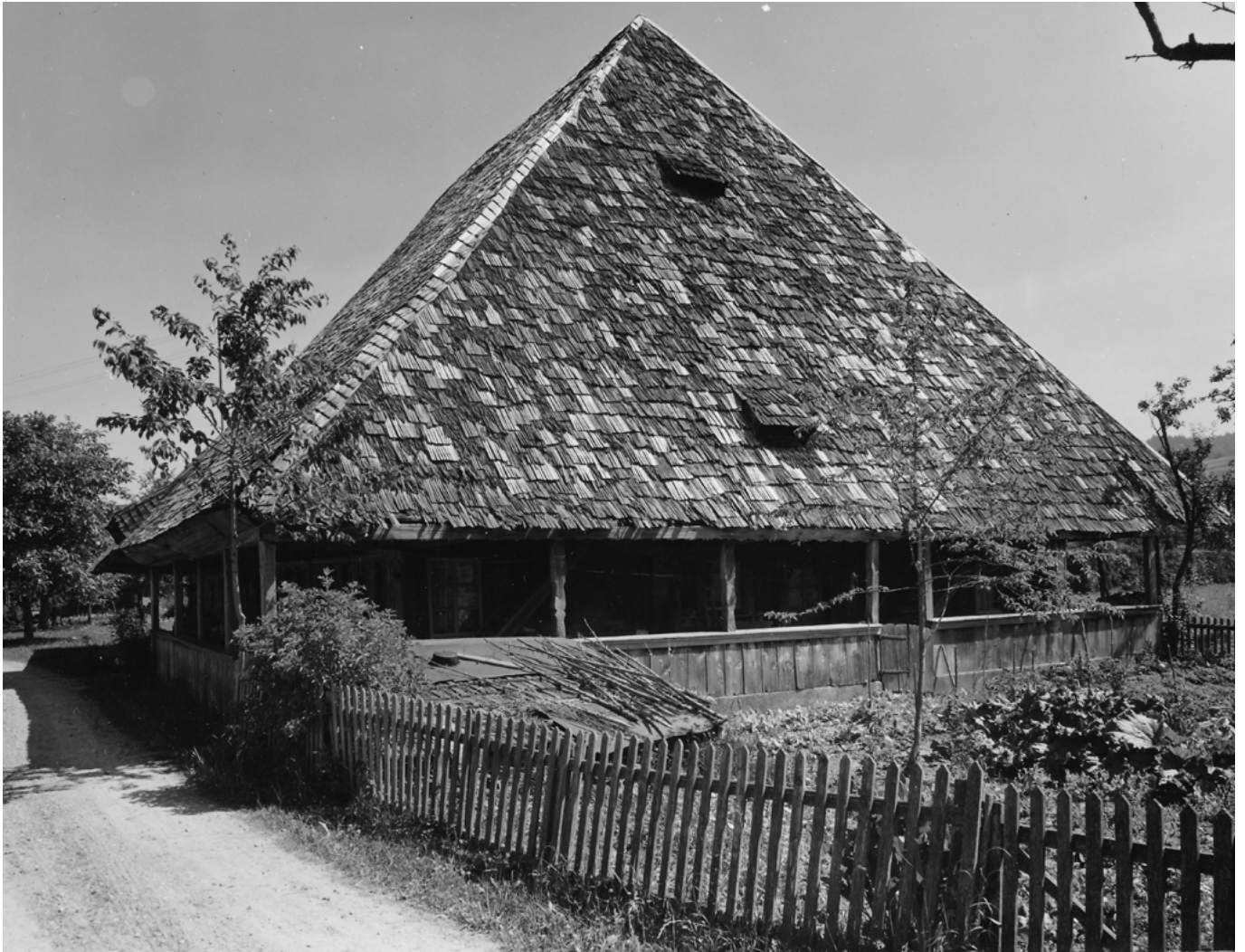
7 Madiswil, Bennacker: Das Bauernhaus mit Garten und überdecktem Gemüse Keller. Blick nach Norden. Aufnahme vor 1975.
