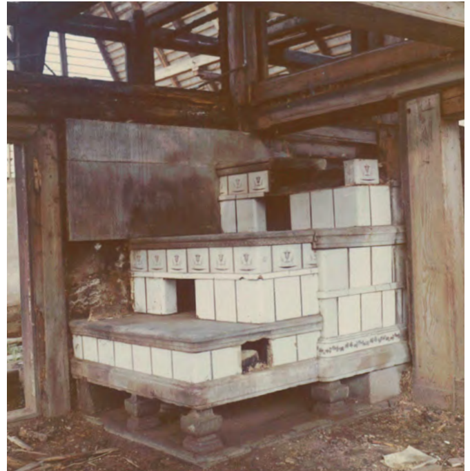
15 Madiswil, Bennacker: Der Kachelofen in der westlichen, etwas grösseren Stube, dessen Kacheln ins frühe 19. Jh. datiert werden können, während des Rückbaus der Liegenschaft. Aufnahme nach 1975.
