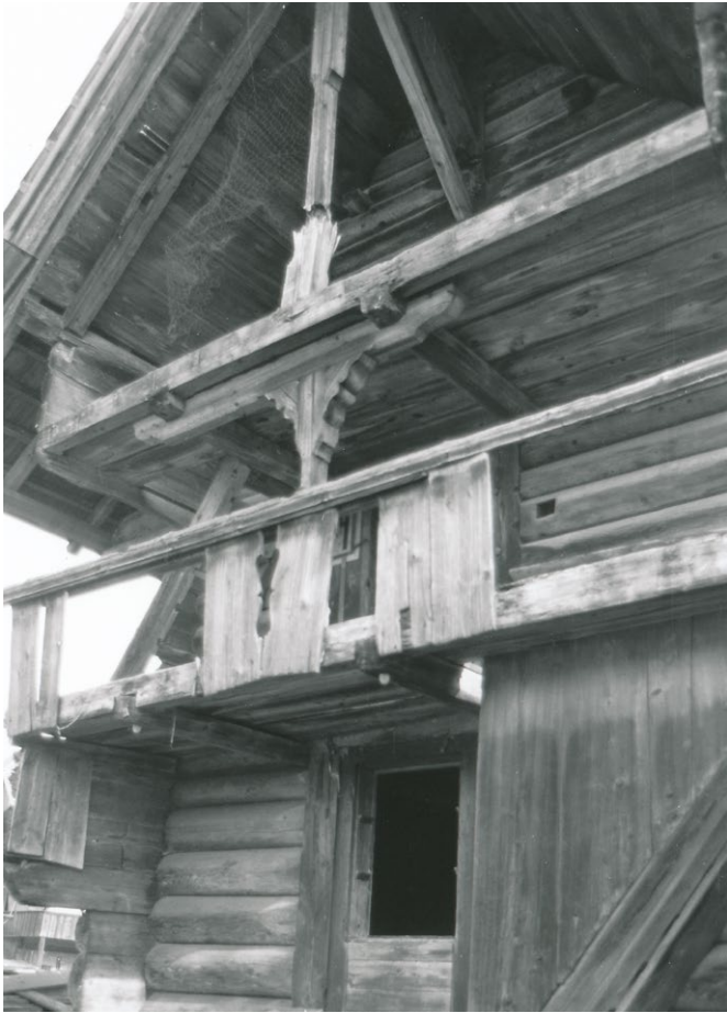
12 Kiesen, Dorf 25 B /Ringstrasse 10: Die zwei Speichergeschosse wurden von Bohllendecken überspannt, die in die Wände eingenuet waren und auf je zwei längslaufenden Kantholzbalken auflagern. Die Balken kragten giebelseitig auf Laubentiefe vor und dienten als zusätzliche Laubenträger. Blick nach Nordosten. Aufnahme 1975.
