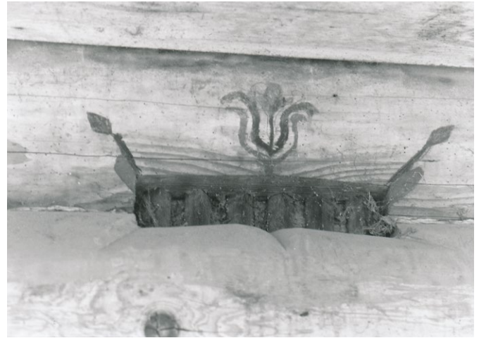
15 Kiesen, Dorf 25 B /Ringstrasse 10: Lüftungsschlitze an der Südfassade mit einem aufgemalten Tulpenornament. Aufnahme 1975.
