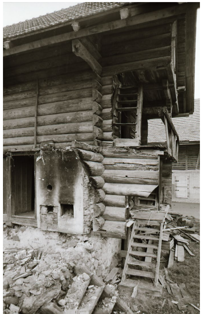
16 Kiesen, Dorf 25 B /Ringstrasse 10: Treppenerschliessung, Zugangsplattform und zweites Lagergeschoss. Gemauerte Brandwand mit Feueröffnungen des Trittofens. Blick nach Süden. Aufnahme 1975.
