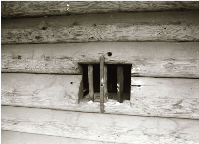
14 Kiesen, Dorf 25 B /Ringstrasse 10: Vergitterte Lüftungsöffnung im zweiten Lagergeschoss an der Südfassade. Aufnahme 1975.
