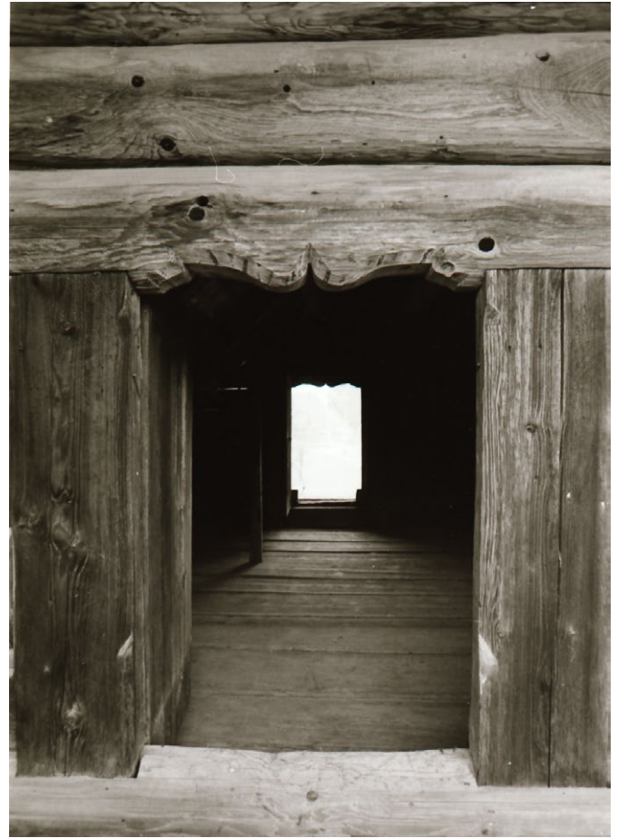
13 Kiesen, Dorf 25 B /Ringstrasse 10: Tür im Dachgeschoss. Die Türstürze wiesen tief eingeschnittene, innen und aussen gefaste Kielbogenmotive, sogenannten Eselsrücken auf. Blick nach Osten. Aufnahme 1975.
