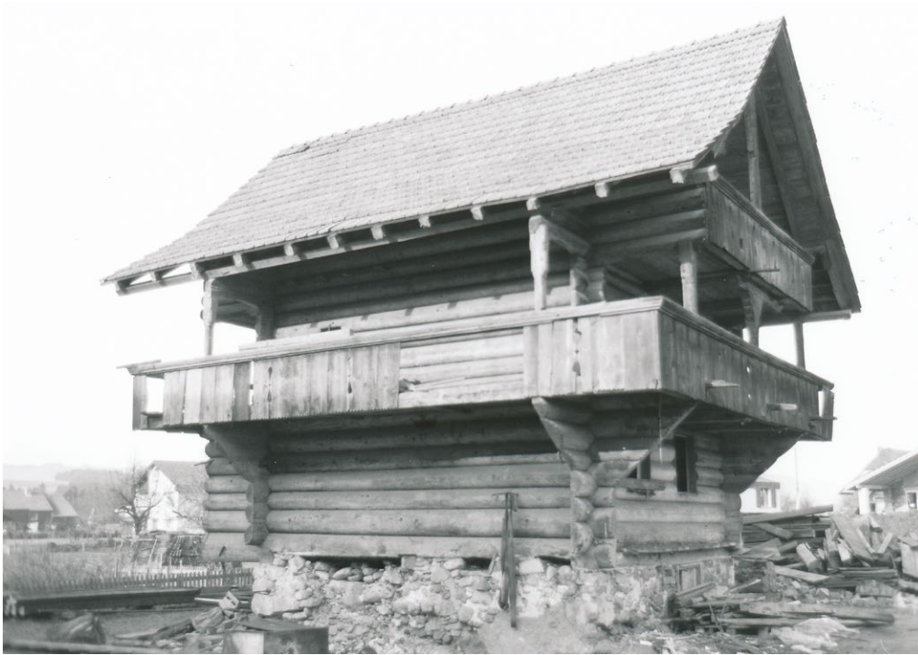
17 Kiesen, Dorf 25 B /Ringstrasse 10: Das Speichergebäude zeigt eine umlaufende Laube im zweiten Speichergeschoss und eine separate Laube im dritten Speichergeschoss. Blick nach Nordwesten. Aufnahme 1975.
