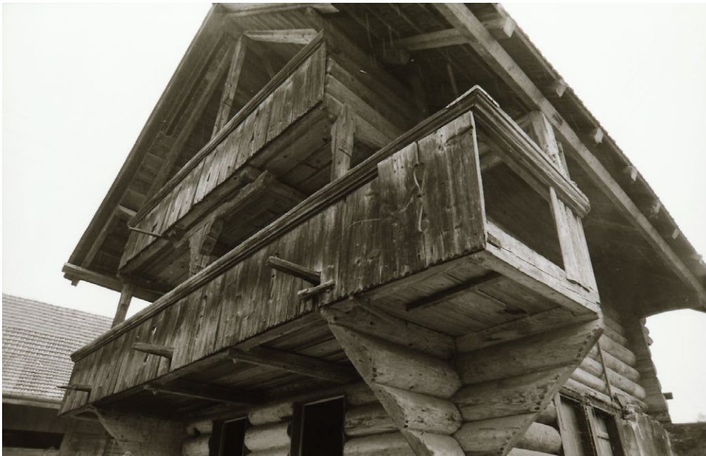
18 Kiesen, Dorf 25 B /Ringstrasse 10: Lauben- und Dachkonstruktion. Blick nach Nordwesten. Aufnahme 1975.
