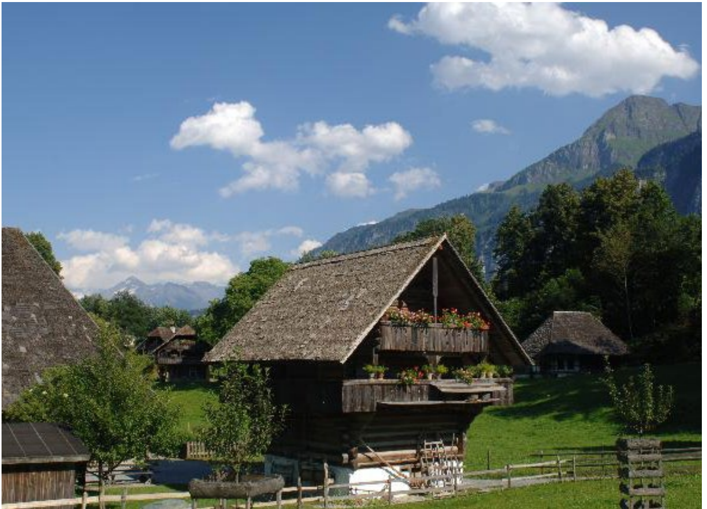
28 Freilichtmuseum der Schweiz, Kornspeicher aus Kiesen: Rückfassade West. Blick nach Osten. Aufnahme 2005.
