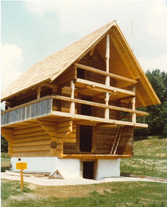
22 Freilichtmuseum der Schweiz, Kornspeicher aus Kiesen: Gerade wieder aufgerichteter und mit Schindeln eingedeckter Speicher. Die Laubenbretter der Ostfassade fehlen noch. Der Neuholzanteil ist zu diesem Zeitpunkt noch gut sichtbar. Heute ist das Holz hingegen verwittert und nur schwer von der Originalsubstanz zu unterscheiden. Blick nach Nordwesten. Aufnahme 1976.
