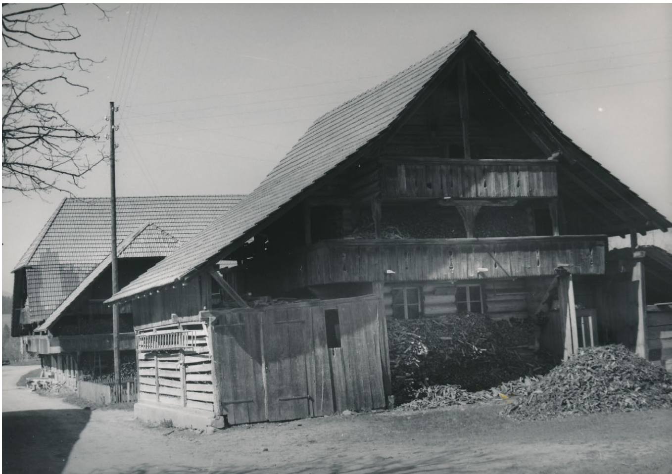
6 Kiesen, Dorf 25 B /Ringstrasse 10: Blick auf die Ostfassade des Kornspeichers in seiner ursprünglichen Situation an der Ringstrasse. Im Hintergrund ist das Alte Haus Albert Waber zu sehen. Blick nach Nordwesten.
