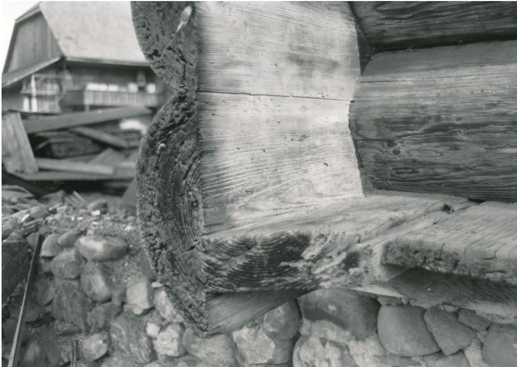
10 Kiesen, Dorf 25 B /Ringstrasse 10: Westlich kragte die Bohllendecke als Eingangspodest in Laubentiefe vor. Der Übergang von der Bohllendecke auf die Hälblingswand wurde mittels des auf den Traufseiten winkelförmig ausgenommen Hälblings gebildet, wodurch eine fugenlose Verbindung von Boden und Wand entstand. Blick nach Nordosten. Aufnahme 1975.
