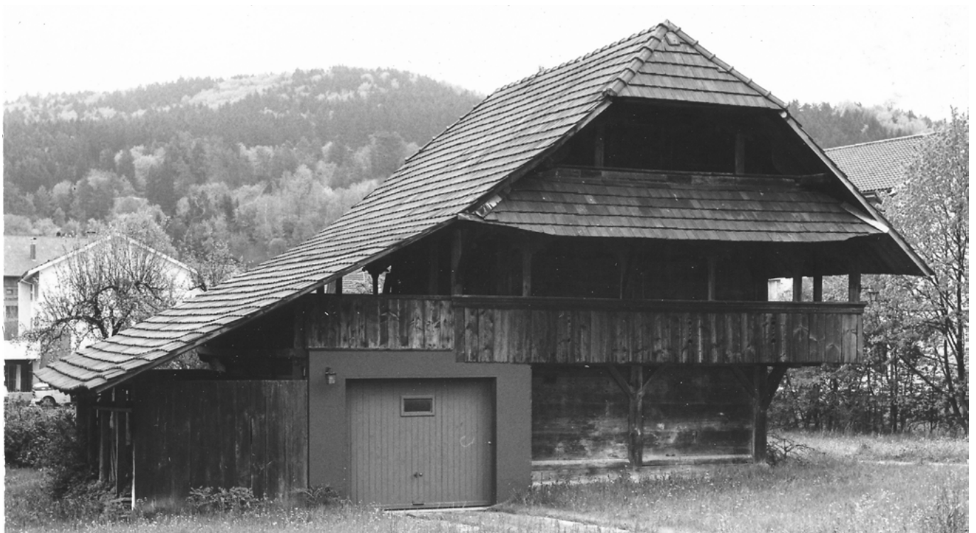
14 Ostermundigen, Mitteldorfstrasse 20: Westliche Feldseite des Kornspeichers mit den rückseitigen Frontlauben und dem nachträglich angefügten Klebdach kurz vor der Translozierung. Linker Hand ist unter dem angeschleppten Dach der Garageneinbau des 20. Jahrhunderts zu sehen. Blick nach Osten. Aufnahme 1977.
