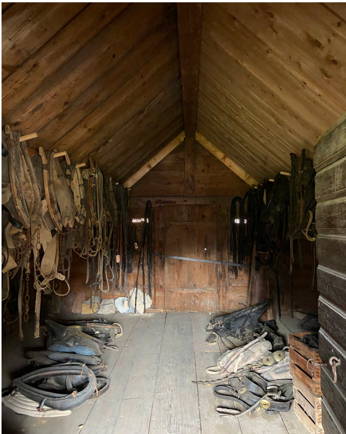
29 Freilichtmuseum der Schweiz, Speicher aus Ostermündigen: Lager im Dachgeschoss, das heute zur Aufbewahrung von Pferde- und Ochseneschirren dient. Gut zu sehen ist das neu beim Wiederaufbau aus stossweise aneinandergesetzten Brettern gefügte Unterdach. An der hinteren Giebelwand ist der rückwärtige Ausgang auf die westliche Frontlaube zu sehen. Blick nach Westen. Aufnahme 2022.
