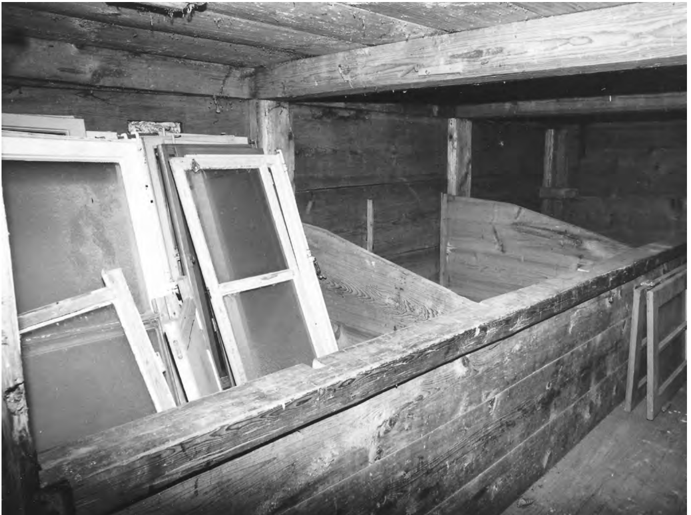
21 Ostermündigen, Mitteldorfstrasse 20: Erdgeschoss mit den eingebauten Fruchtkästen für die Lagerung des Kornes. Blick nach Westen. Aufnahme 1977.
