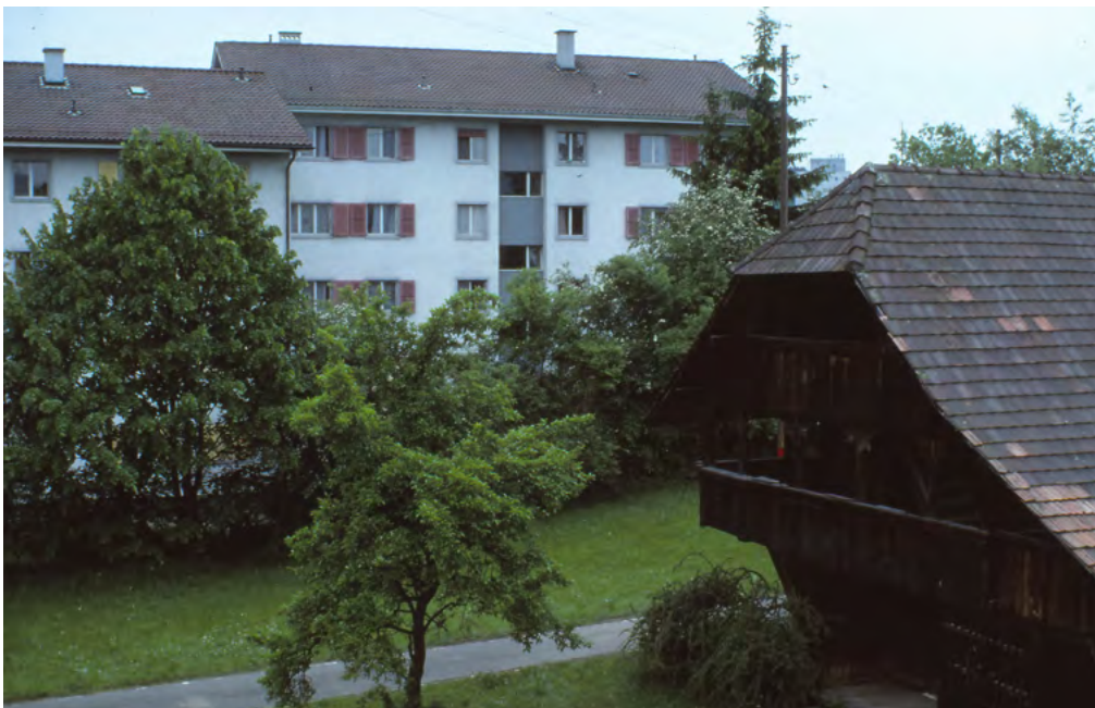
8 Ostermundigen, Mitteldorfstrasse 20: Im Vordergrund ist der Speicher am alten Standort kurz vor der Translozierung zu sehen. Im Hintergrund liegen die bereits nahe an die Hofparzelle herangerückten Wohnblöcke an der Mitteldorfstrasse. Blick nach Südwesten. Aufnahme 1977.
