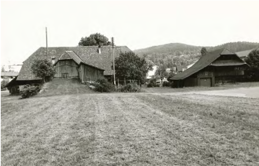
7 Ostermundigen, Mitteldorfstrasse 20: Der ehemalige Gastelihof kurz vor der Translozierung von der Feldseite gesehen. Linker Hand das Bauernhaus und rechts der Kornspeicher. Blick nach Osten. Aufnahme 1977.
