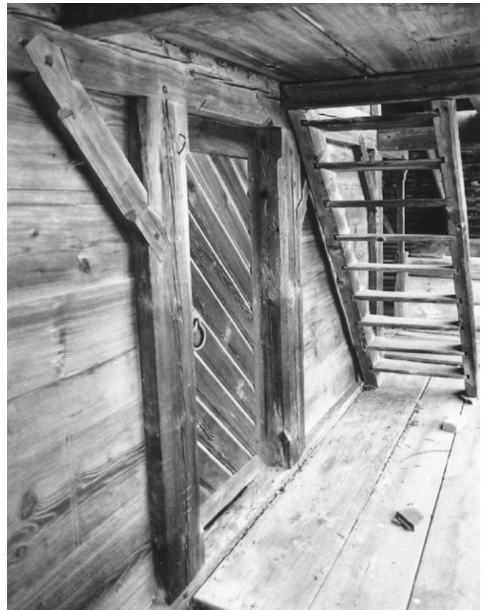
18 Ostermundigen, Mitteldorfstrasse 20: Laube im ersten Obergeschoss auf der östlichen Hofseite mit der dortigen Zugangstür in den oberen Speicher mit den dortigen Fruchtkästen. Die darüber angeordnete Stiege führt zur Laube im zweiten Obergeschoss. Gut zu beobachten ist hier die Bohlen-Ständerkonstruktion der Wände mit den Kopfbändern. Blick nach Nordosten. Aufnahme 1977.
