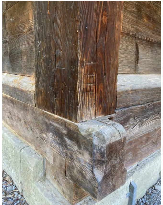
9 Freilichtmuseum der Schweiz, Kornspeicher aus Ostermundigen: Südöstlicher Eckständer des Speichers über dem aus örtlichen Sandsteinblöcken gemauerten Steinsockel und ehemaligen Keller. Gut zu erkennen sind die strichförmigen Abbundzeichen der Zimmerleute aus dem 18. Jahrhundert. Blick nach Nordwesten. Aufnahme 2022.
