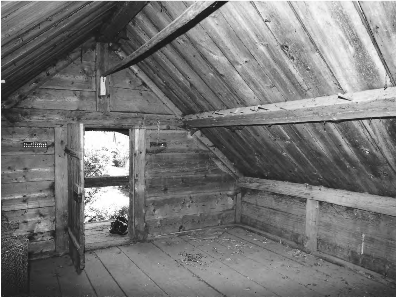
22 Ostermundigen, Mitteldorfstrasse 20: Zweites Obergeschoss, das nicht mit Fruchtkästen ausgestattet war und für anderweitige Lagerzwecke genutzt worden sein dürfte. Charakteristisch für Kornspeicher ist die sorgfältige Verkleidung der Unterseiten der Dachflächen mit einer Spundholzverschalung. Blick nach Osten. Aufnahme 1977.
