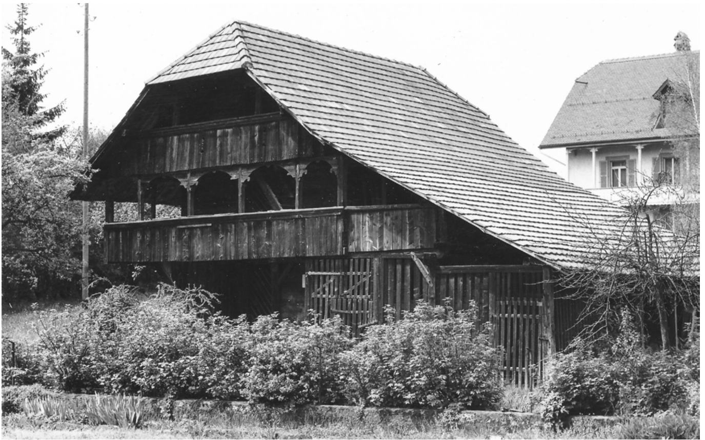
13 Ostermundigen, Mitteldorfstrasse 20: Östliche Hofseite des Kornspeichers mit den beiden Frontlauben und der Blendfassade kurz vor der Translozierung. Rechts ist die mit einer Lattung verschlossene Remise zu sehen. Im Hintergrund steht noch das zum Hof gehörige Stöckli des 19./frühen 20. Jahrhunderts. Blick nach Westen. Aufnahme 1977.
