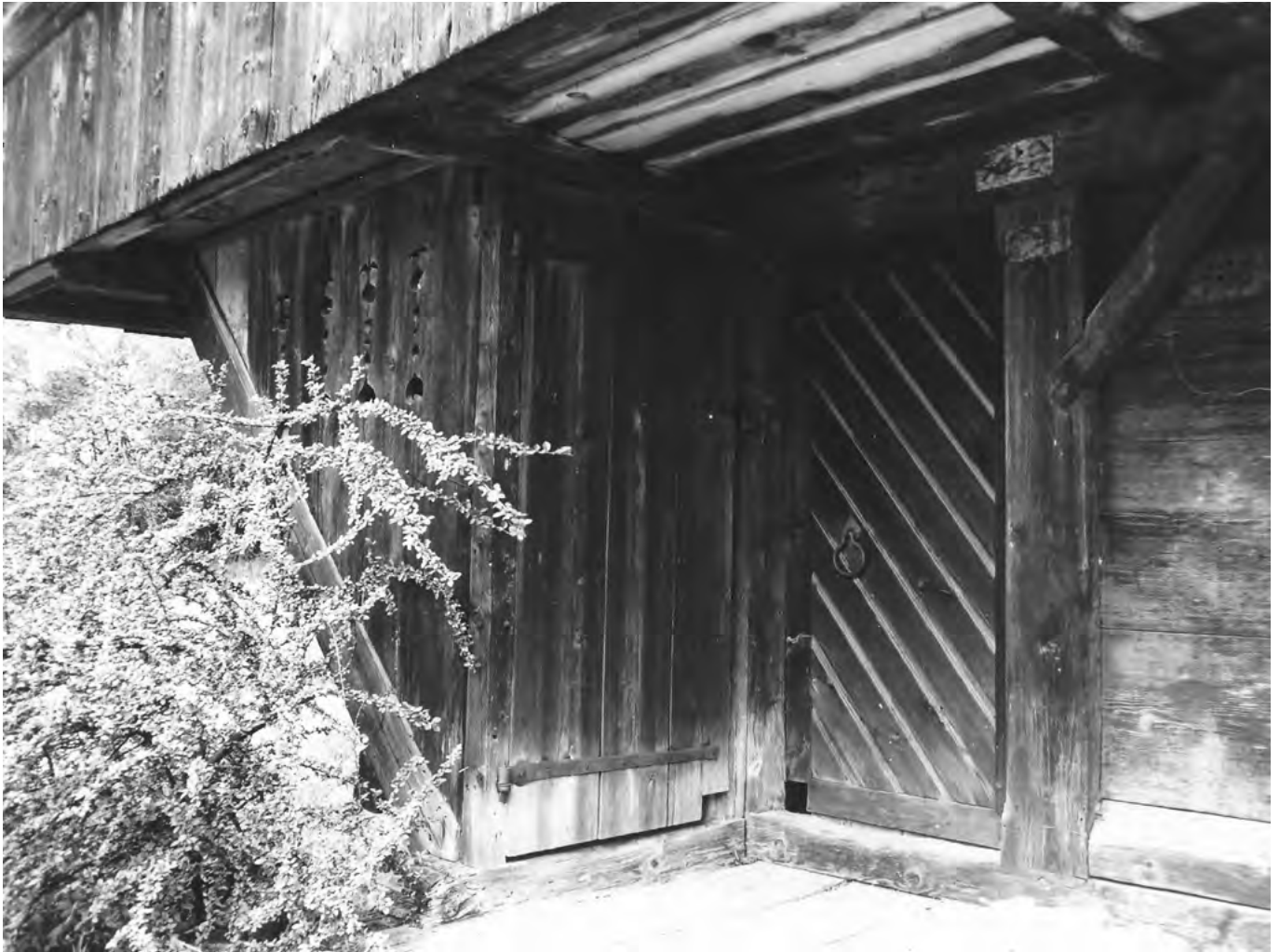
17 Ostermundigen, Mitteldorfstrasse 20: Zugangsbereich auf der östlichen Hofseite. Vom vorgelegten Holzpodest aus gelangte man zur Tür im Erdgeschoss mit den dortigen Fruchtkästen. Links davon ist der verbretterte Treppenaufgang zur Laube im Obergeschoss zu sehen. Blick nach Südwesten. Aufnahme 1977.
