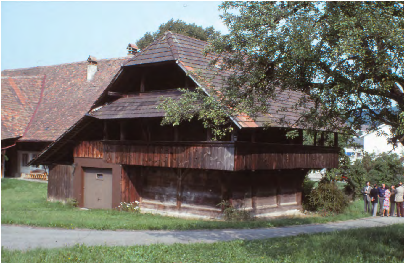
12 Ostermundigen, Mitteldorfstrasse 20: Der Kornspeicher vor der Translozierung am alten Standort. Auf der Nordseite sind unter dem verlängerten Schleppepdach die jüngere Remise und die Garage eingebaut. Im Hintergrund ist das Bauernhaus des Gostelihofs zu sehen. Im Vordergrund verläuft der ehemalige Zugangsweg von der Mitteldorfstrasse in zugehörige westliche Ackerflur. Blick nach Nordosten. Aufnahme 1977.
