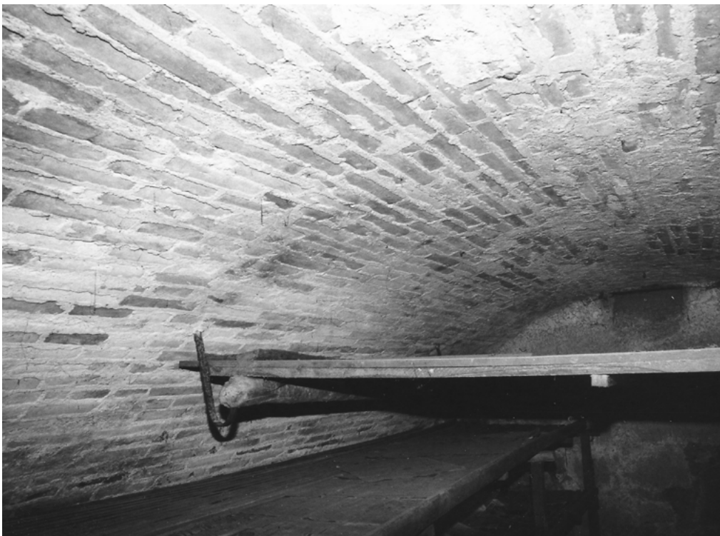
20 Ostermundigen, Mitteldorfstrasse 20: Blick in das Kellergeschoss mit dem aus Backsteinen gemauerten, unverputzten Tonnengewölbe. Es bleibt offen, ob dieses aus der Bauzeit stammt oder erst nachträglich anstelle einer flachen Holzdecke eingefügt worden ist. An Eisenhaken und eingelegten Holzstangen waren auch unter dem Gewölbe Holzbretter zu Lagerzwecken eingelegt. Im Hintergrund ist die Lüftungsöffnung auf der westlichen Giebelseite zu erkennen. Blick nach Westen. Aufnahme 1977.
