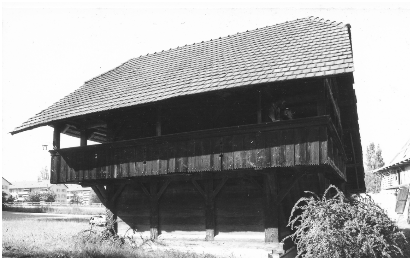
15 Ostermündigen, Mitteldorfstrasse 20: Südliche Trauffassade mit der dort umlaufenden Laube. Zu erkennen ist die Ständerbautechnik mit den verblatteten Kopfbändern und den horizontal eingeschobenen Wandbohlen. Am rechten Bildrand ist das Bauernhaus angeschnitten. Blick nach Norden. Aufnahme 1977.
