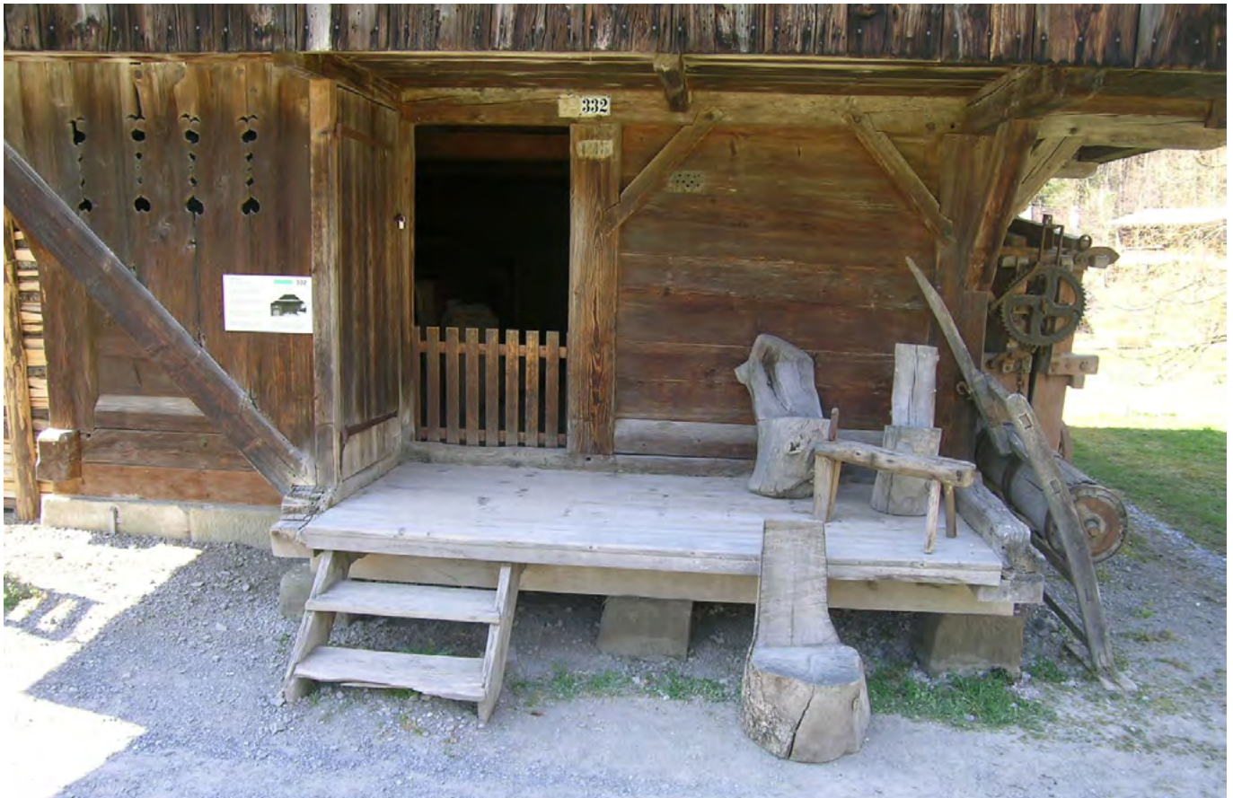
26 Freilichtmuseum der Schweiz, Speicher aus Ostermundigen: Erhöht angelegter Eingangsbereich des Speichers mit dem vorgelegten Bretterboden. Der überdachte Vorplatz unter der Laube ist heute über drei Holztritte erschlossen. Blick nach Westen. Aufnahme 2009.
