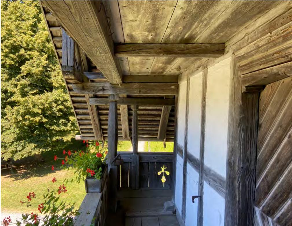
**14** Freilichtmuseum der Schweiz, Stöckli aus Dettligen: Untere Frontlaube auf der heutigen Nordwestseite des Gebäudes. Gut zu erkennen ist die Konstruktion der Lauben mit den säulenförmigen Stützen. Am rechten Bildrand ist die Zugangstür zum Wohnraum im Obergeschoss mit verziertem Sturz angeschnitten. Blick nach Nordosten. Aufnahme 2022.
