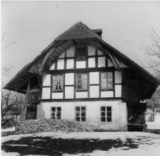
**7** Dettligen, Untere Schmiede: Die repräsentative Südfassade des Stöckli mit dem weit vorgezogenen Krüppelwalm mit Ründe. Das Erdgeschoss ist als feuerechter Ofenraum gemauert und mit Ecklisenen ausgestattet, während die Obergeschosse mit Wohn- und Speicherfunktionen in Holz als einfaches Gitterfachwerk konstruiert sind. Blick nach Norden. Aufnahme 1971.
