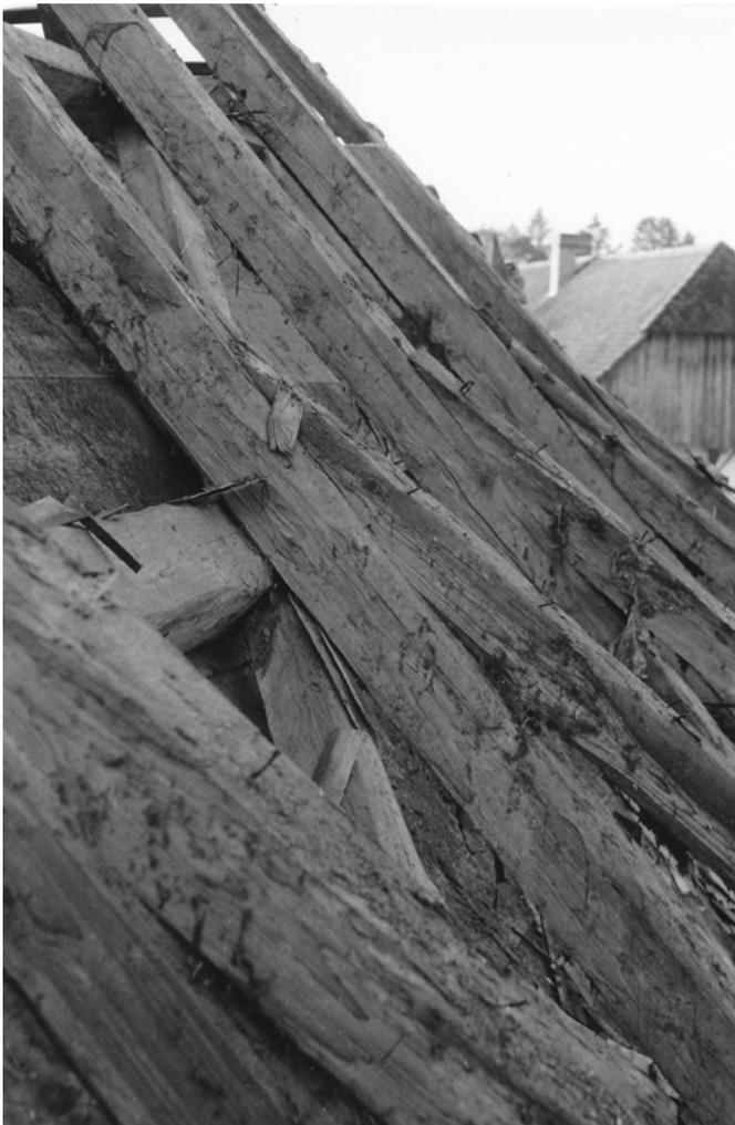
**19** Dettligen, Untere Schmiede: Sparrendach des Stöckli mit den aufgezapften Aufschieblingen der östlichen Traufseite. Aufnahme 1974.
