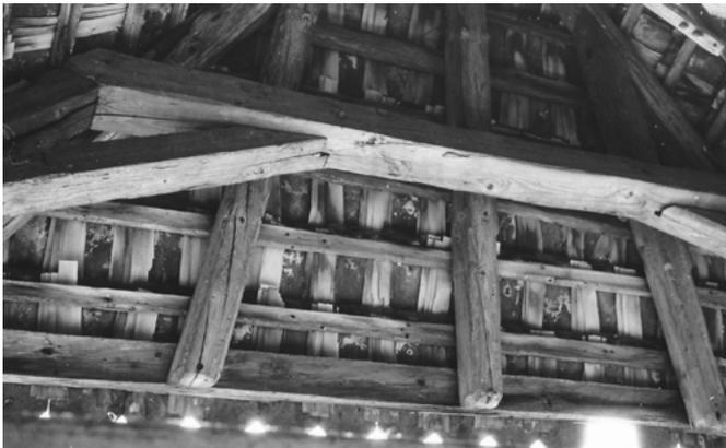
**21** Detligen, Untere Schmiede: Blick unter die Flugsparrenkonstruktion des nördlichen Krüppelwalms auf der nördlichen Giebelseite des Stöckli. Blick nach Norden. Aufnahme 1974.
