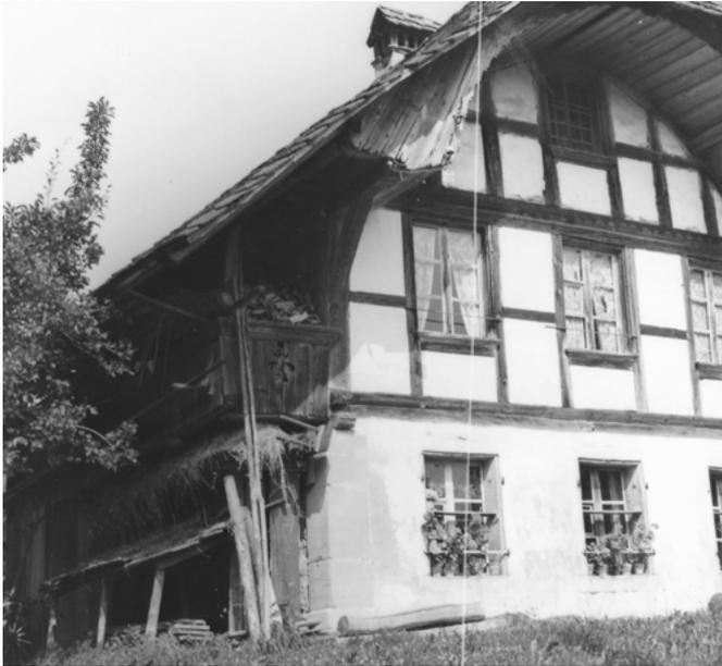
**11** Dettligen, Untere Schmiede: Südliche Giebel- und westliche Traufseite des Stöckli, die zu den beiden Strassenverläufen ausgerichtet waren. Auf der Traufseite ist ein kleiner, mit Pultdach geschützter Lagerplatz unter der Seitenlaube zu erkennen. Blick nach Nordosten. Aufnahme 1971.
