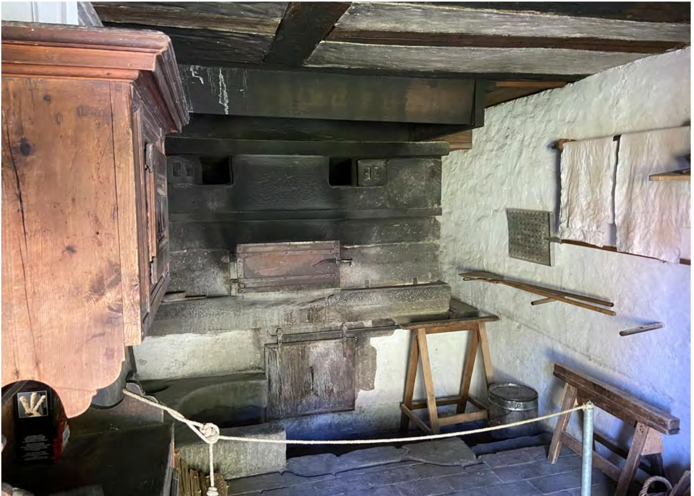
**28** Freilichtmuseum der Schweiz, Stöckli aus Dettligen: Der wiederhergestellte Backraum mit dem aus einem Ofenhaus von Lützelflüh BE übernommenen Backofen. Neben der tief angelegten Arbeits- und Schürgrube ist der hufeisenförmige Unterbau der Buechgrube aus Sandstein zu sehen. Dort wurde das Wasser zum Wäschewaschen erhitzt, zugleich konnte die Buchenasche des Backofens als «Waschmittel» verwendet werden. Blick nach Südwesten. Aufnahme 2022.
