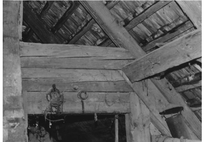
**18** Dettligen, Untere Schmiede: Sparrendachkonstruktion des Stöckli mit Kehlbalken und darunter angeordnetem liegendem Dachstuhl. Aufnahme 1974.
