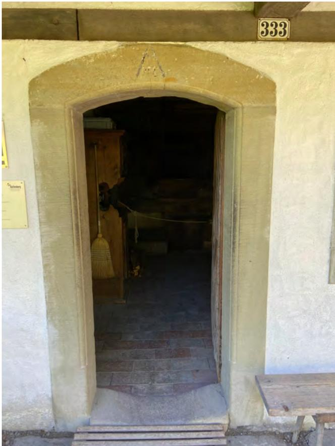
9 Freilichtmuseum der Schweiz, Stöckli aus Detligen: Zugang zum Ofenraum im Erdgeschoss auf der heutigen West- und ehemaligen Ostseite. Das mit dem breiten Schlägeisen scharrierte Sandsteingewände trägt im Sturz die nicht sicher zu deutende Inschrift «AMC». Blick nach Osten. Aufnahme 2022.
