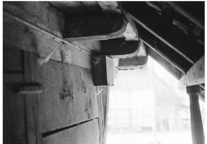
**20** Dettligen, Untere Schmiede: Blick von der östlichen Seitenlaube aus unter die Dachtraufe. Gut zu erkennen ist die Flugfettenkonstruktion, auf der die Aufschieblinge des Dachvorstands liegen. Blick nach Norden. Aufnahme 1974.
