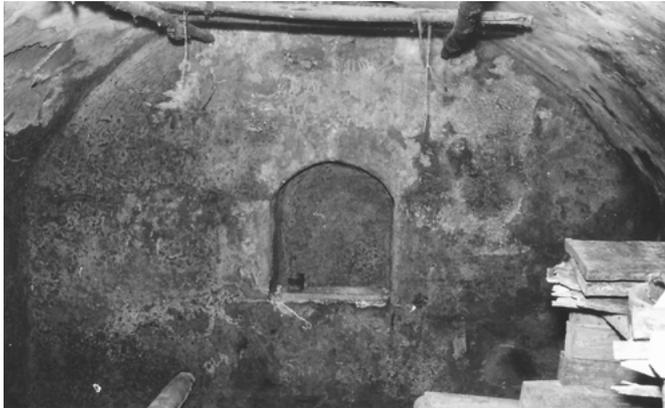
**23** Detligen, Untere Schmiede: Westliche Stirnseite des Gewölbekellers des Stöckli mit der sich deutlich abzeichnenden Lichtnische. Die Lüftungsöffnung im Scheitelbereich der Tonne wird durch das Holzgerüst unterhalb der Wölbung verdeckt. Am Gerüst wurden Vorräte zum Trocknen aufgehängt, um sie vor Tierfrass zu schützen. Blick nach Westen. Aufnahme 1974.
