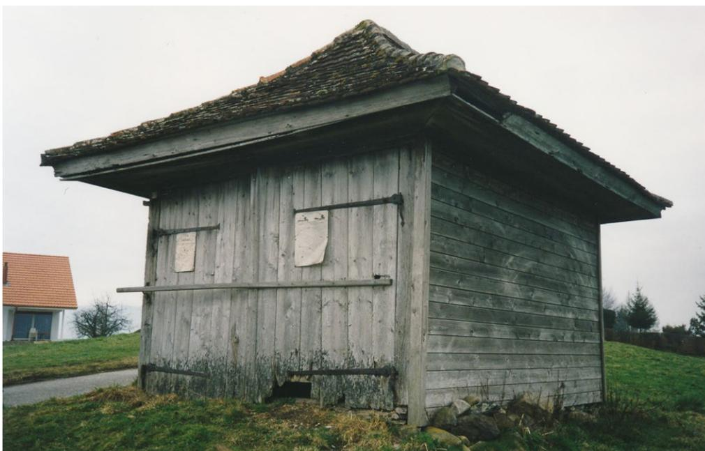
6 Mühledorf, Spritzenhaus: Blick von Nordwesten auf das zur Strasse orientierte doppelflügelige Brettentor, das nur mit einer Holzstange verschlossen war, um im Bedarfsfall rasch Zugriff auf die Löscheräte zu haben. Die dem Wetter ausgesetzte Westseite ist zusätzlich an der Aussen-seite mit Brettern verschalt. Aufnahme 1998.
