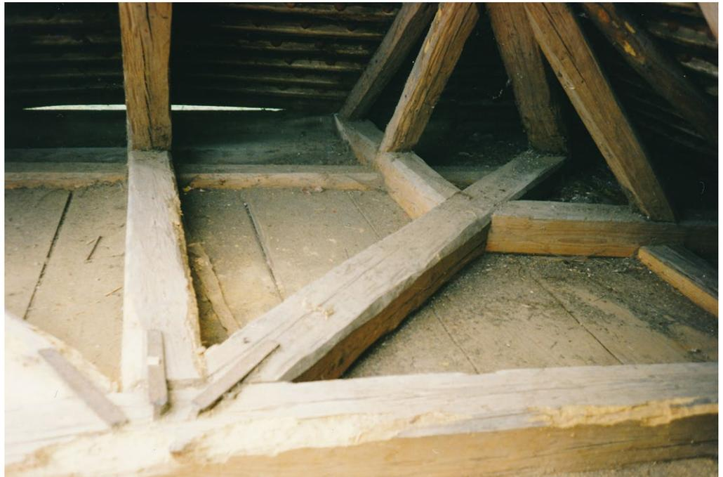
**11** Mühledorf, Spritzenhaus: Das Dachwerk während dem Entfernen der Dachdeckung. Unter der bereits abgenommenen Dachlattung zeigt sich hier das gesamte Konstruktionsprinzip des Sparrendachs mit den auf die Sparren und die Enden der Stichbalken gezapften Aufschieblingen. Aufnahme 1998.
