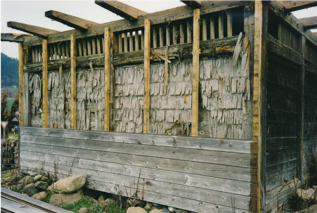
**8** Mühledorf, Spritzenhaus: Blick auf die Westseite während des Abbaus. Unter der jüngeren Bretterverschalung sind die Reste einer älteren Verschindelung zu sehen. Die vorkragende Stichbalkenlage ist nach dem Abnehmen des Dachwerks besonders gut zu erkennen. Die vor die Fassaden springenden Hölzer trugen das auf allen Seiten weit vorgezogene Vollwalmdach. Aufnahme 1998.
