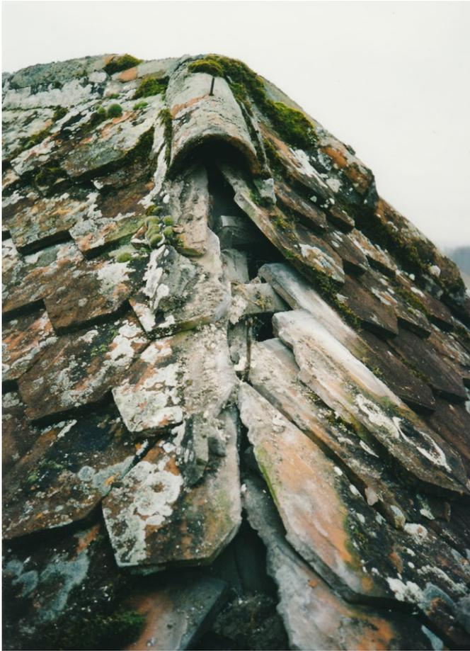
**12** Mühledorf, Spritzenhaus: Deckung mit Spitzziegeln und den vermörtelten Hohlziegeln auf den Dachgraten. Aufnahme 1998.
