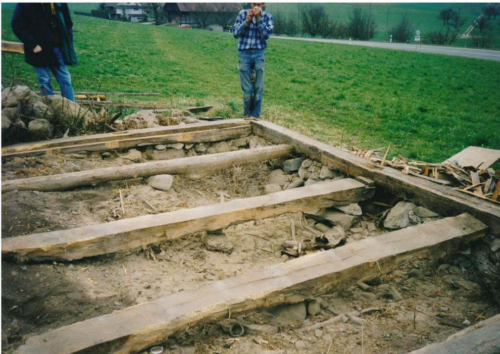
**9** Mühledorf, Spritzenhaus: Blick auf die Schwellbalkenkonstruktion nach Entfernen der quer dazu verlegten Bodenbretter. Der Rahmen sitzt zum Abhalten von Bodenfeuchtigkeit auf Trockensteinsockeln, die aus Flussgeröllen und Moränegeschiebe gesetzt waren. Aufnahme 1998.
