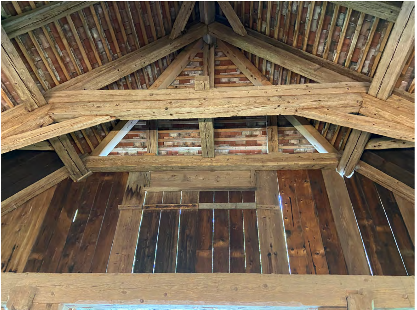
16 Freilichtmuseum der Schweiz, Pferde- und Ausfütterungsstall aus Faulensee: Blick in den oberen Dachraum des Sparrendachs mit der darunter eingebauten liegenden Stuhlkonstruktion. Blick nach Norden. Aufnahme 2021.
