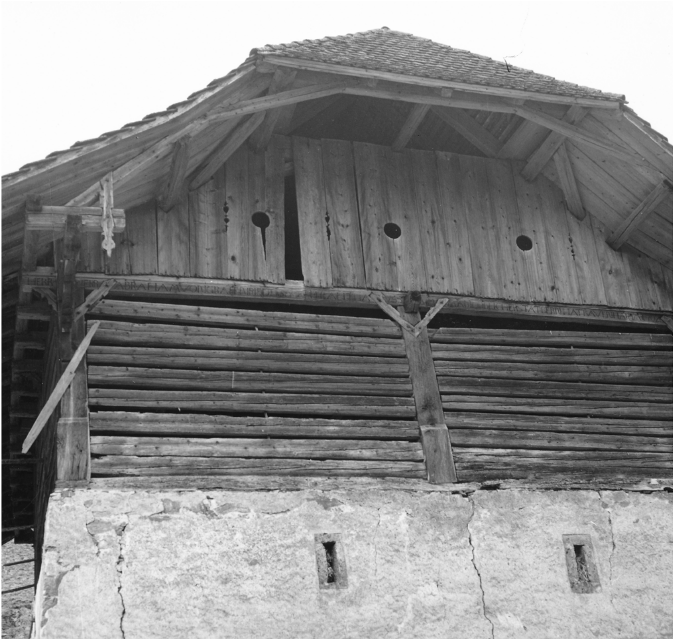
9 Faulensee, Schüpfgut, Pferde- und Ausfütterungsstall: Blick von der Seeseite auf den Nordgiebel des Stalls. Gut zu erkennen ist der charakteristische Aufbau. Das als Stall genutzte Erdgeschoss ist gemauert. Der Heuboden im ersten Obergeschoss, das von der Rückseite ebenerdig befahren werden konnte, ist als lockerer Block-Ständerbau gefügt. Das als weiterer Heuboden genutzte Dachgeschoss ist mit Brettern verschalt. Das weit vorspringende Krüppelwalmdach ruht auf einer im Berner Mittelland während der frühen Neuzeit weitverbreiteten Schwebgiebelkonstruktion mit Flugsparren. Blick nach Süden. Aufnahme 1969/70.
