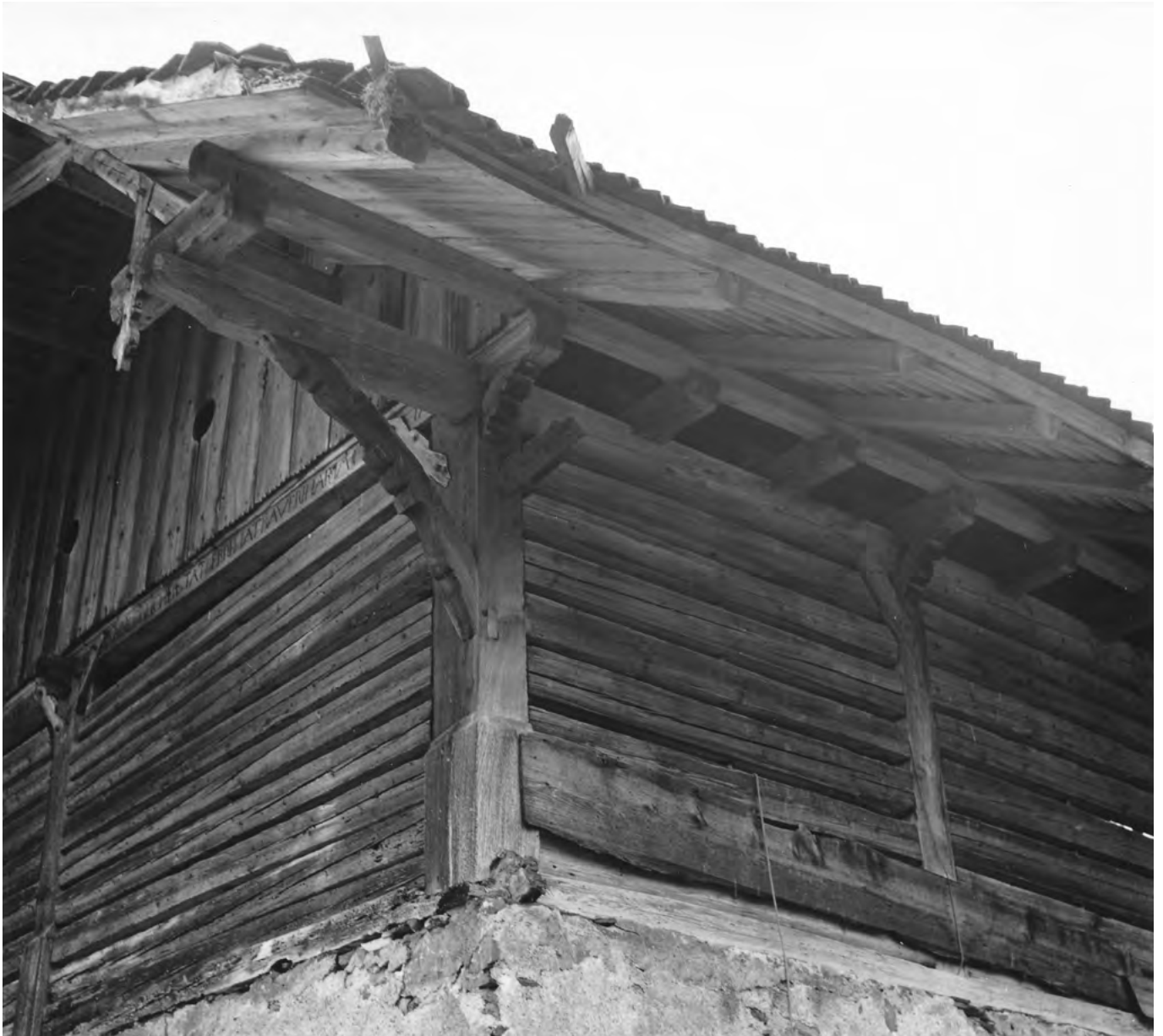
8 Faulensee, Schüpfgut, Pferde- und Ausfütterungsstall: Blick unter die zur Talseite gerichtete nordwestliche Ecke des Walmdachs. Zu sehen ist eine reich verzierte Eckständerkonstruktion mit schnitzverzierten Bügen und weit vorkragender Schwebgiebelkonstruktion, die das Dach trägt. Der Rähmbalken der lockeren Blockwand trägt eine eingeschnittene Inschrift, die auf den Bauherrn und das Jahr der Errichtung verweist. Die seeseitige Inschrift unterstreicht die ehemals deutlich dorthin ausgerichtete Orientierung des anfangs als Pferdestall genutzten Gebäudes. Blick nach Südosten. Aufnahme 1969/70.
