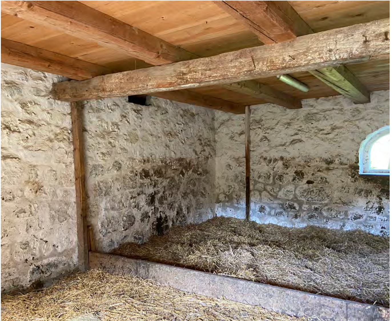
21 Freilichtmuseum der Schweiz, Pferde- und Ausfütterungsstall aus Faulensee: Blick in den Stall. Auf der rechten Seite ist die segmentbogenförmige Fensteröffnung in der heutigen Ostmauer zu sehen. Blick nach Nordosten. Aufnahme 2021.
