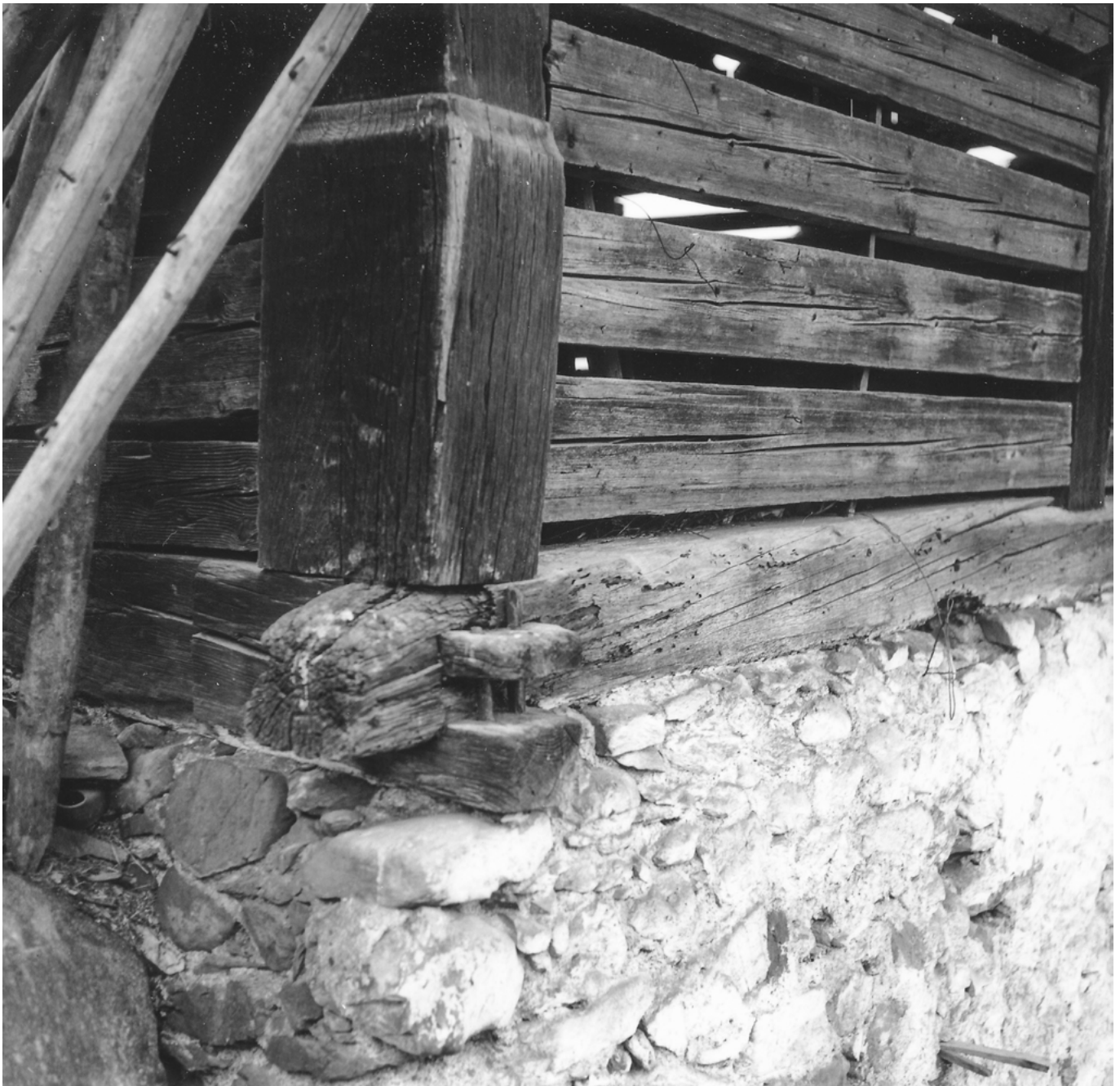
13 Faulensee, Schüpfgut, Pferde- und Ausfütterungsstall: Eckkonstruktion des als lockerer Block-Ständerbau konstruierten Heuraums. In den mit Zapfenschloss gesicherten Schwellenkranz ist der mit einer profilierten Basis ausgestattete Eckständer eingelassen. In diesen sind wiederum in den Längsseiten die Blockhölzer des Wandaufbaus mit ihren Zapfen verankert. Aufnahme 1969/70.
