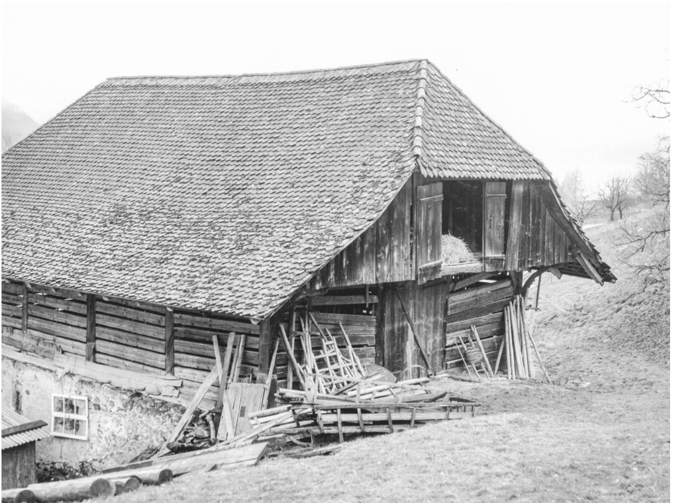
14 Faulensee, Schüpfgut, Pferde- und Ausfütterungsstall: Blick vom Pächterhaus auf die Rückseite des Stalls. Die zum Hang gerichtete Rückseite weist über dem mit locker gefügten Blockwänden ausgestatteten unteren Heuraum einen weiteren Heuboden unter dem Dach auf, der mit Brettern verschalt ist. Sowohl zum Heuraum als auch zum oberen Heuboden ist jeweils ein zweiflügeliges Tor zu sehen. Interessant ist auch die Dachdeckung mit Spitzziegeln, die wohl von Beginn an bestanden hat. Blick nach Nordosten. Aufnahme 1969/70.
