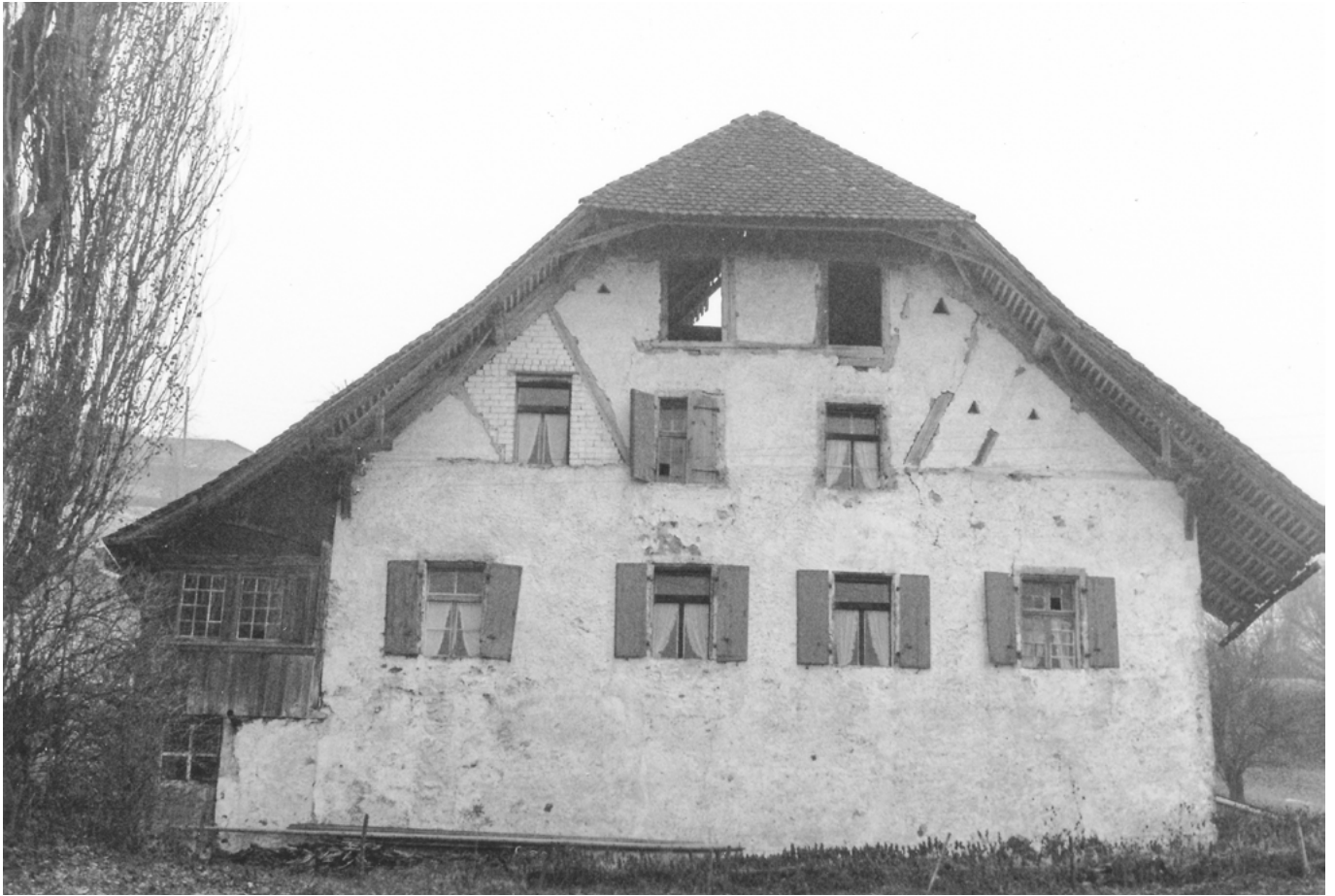
5 Faulensee, Schüpftgut: Seeseitige Fassade des Gutshauses in der Hinteren Schüpft aus der Zeit um 1600 vor der Renovierung von 1991. Es handelt sich um einen sogenannten Stock mit einem massiv gebauten, zweigeschossigen unteren Bauteil und einem Fachwerkaufsatz in den Dachgeschossen. Blick nach Süden. Aufnahme vermutlich um 1986.
