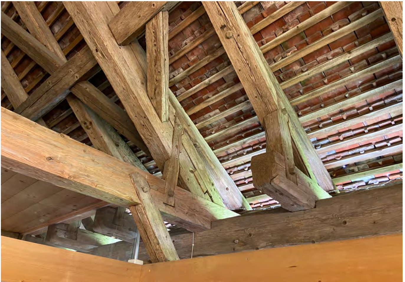
15 Freilichtmuseum der Schweiz, Pferde- und Ausfütterungsstall aus Faulensee: Blick in den traufseitigen Dachaufbau des Sparrendachs und der liegenden Stuhlkonstruktion. Aufnahme 2021.
