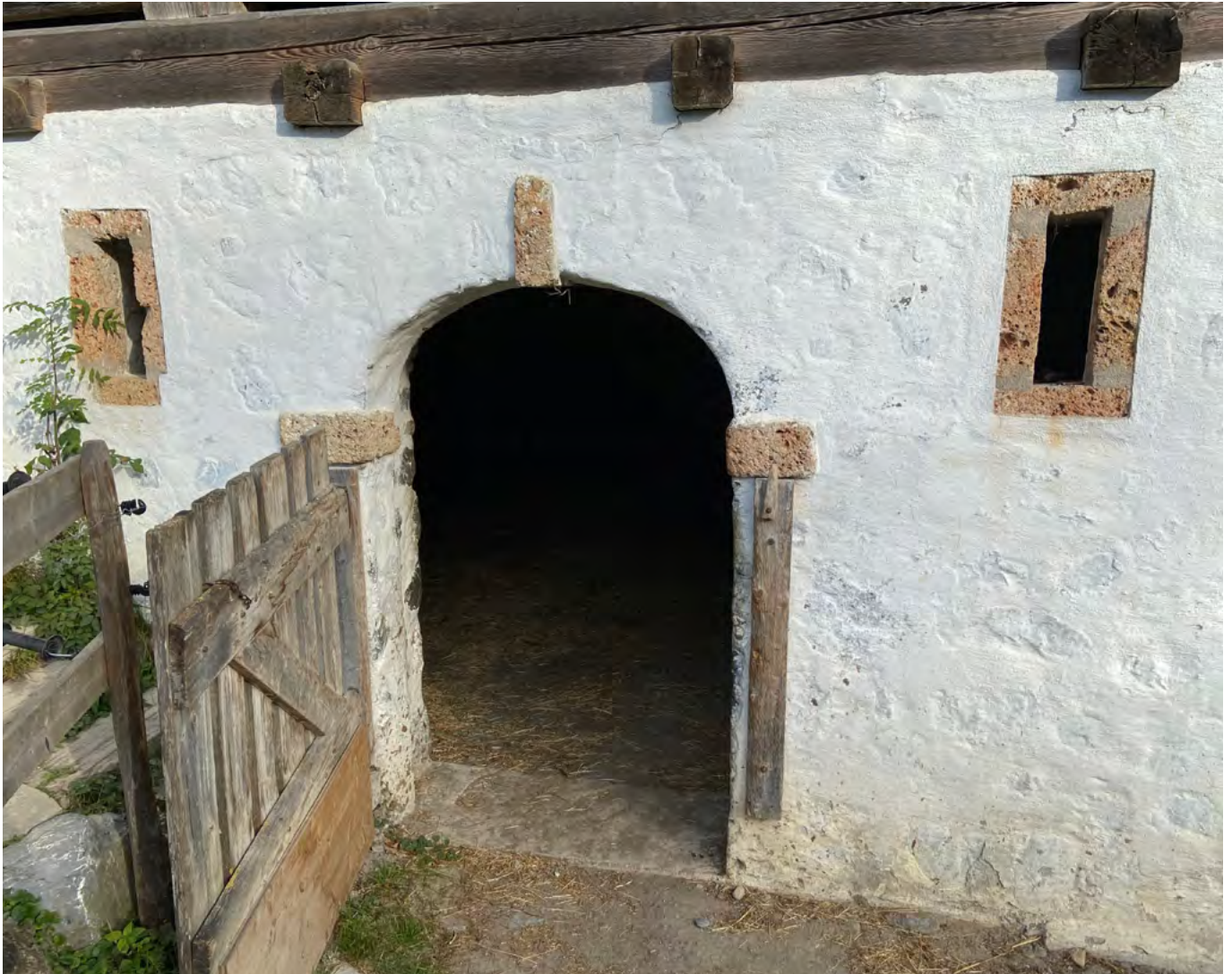
12 Freilichtmuseum der Schweiz, Pferde- und Ausfütterungsstall Faulensee: Die ursprüngliche östliche Zugangsseite liegt heute im Westen. Sie zeigt noch wie am alten Standort in Faulensee die Gliederung des Rundbogenportals mit Tuffquadern. Daneben sind zwei mit Tuffgewänden ausgestattete Schartenfenster angeordnet. Blick nach Osten. Aufnahme 2021.
