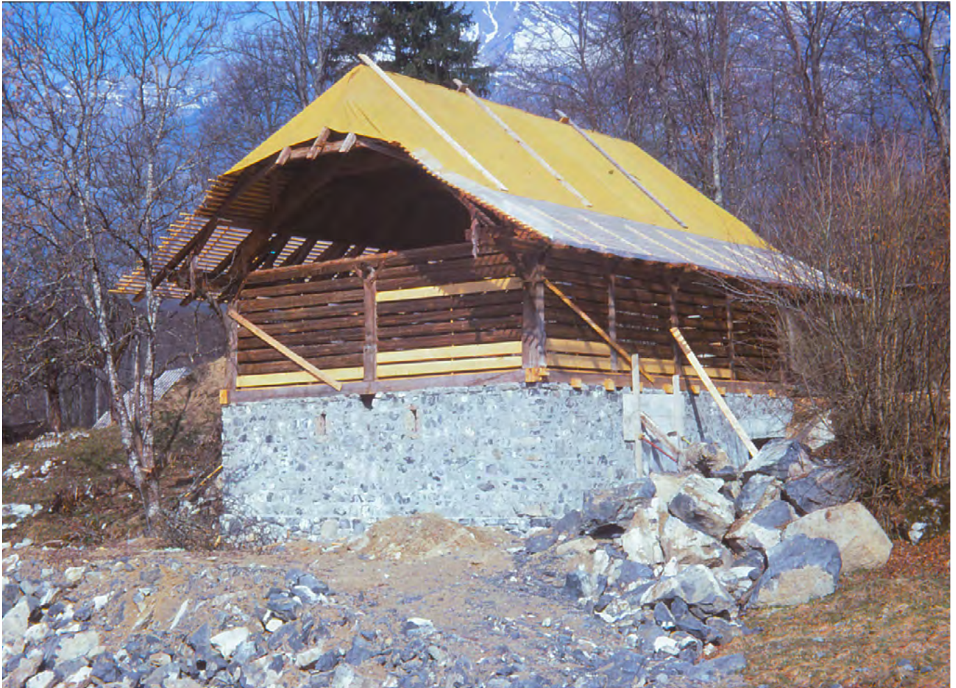
18 Freilichtmuseum der Schweiz, Pferde- und Ausfütterungsstall aus Faulensee: Wiederaufbau des bereits sechs Jahre zuvor in Faulensee abgebauten Stallscheunengebäudes in der neu entstehenden Baugruppe zum Berner Mittelland. Auf der Abbildung erkennt man deutlich die ersetzten Hölzer der Konstruktion. Blick nach Nordwesten. Aufnahme 1976.
