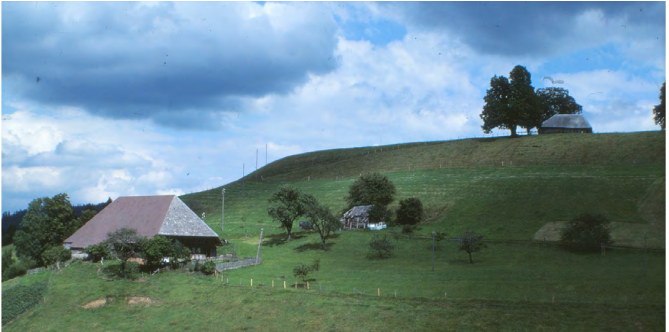
4 Wasen im Emmental, Obere Schützenalp: Der Käsespeicher ist in der Bildmitte zu sehen. Die Alpbetriebe des Emmentals entstanden hauptsächlich ab dem 16. Jahrhundert. Da sie unterhalb der Baumgrenze lagen, musste der bestehende Hochwald aufwendig gerodet werden, um Weideflächen für die Kühe zu schaffen. Blick nach Nordosten. Aufnahme 1977.
