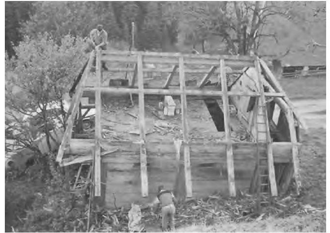
11 Wasen im Emmental, Obere Schützenalp: Der Käsespeicher ohne Dachdeckung. Das einfache Konstruktionsprinzip des Walmdaches wurde beim Abbau ersichtlich. Blick nach Westen. Aufnahme etwa 1978.
