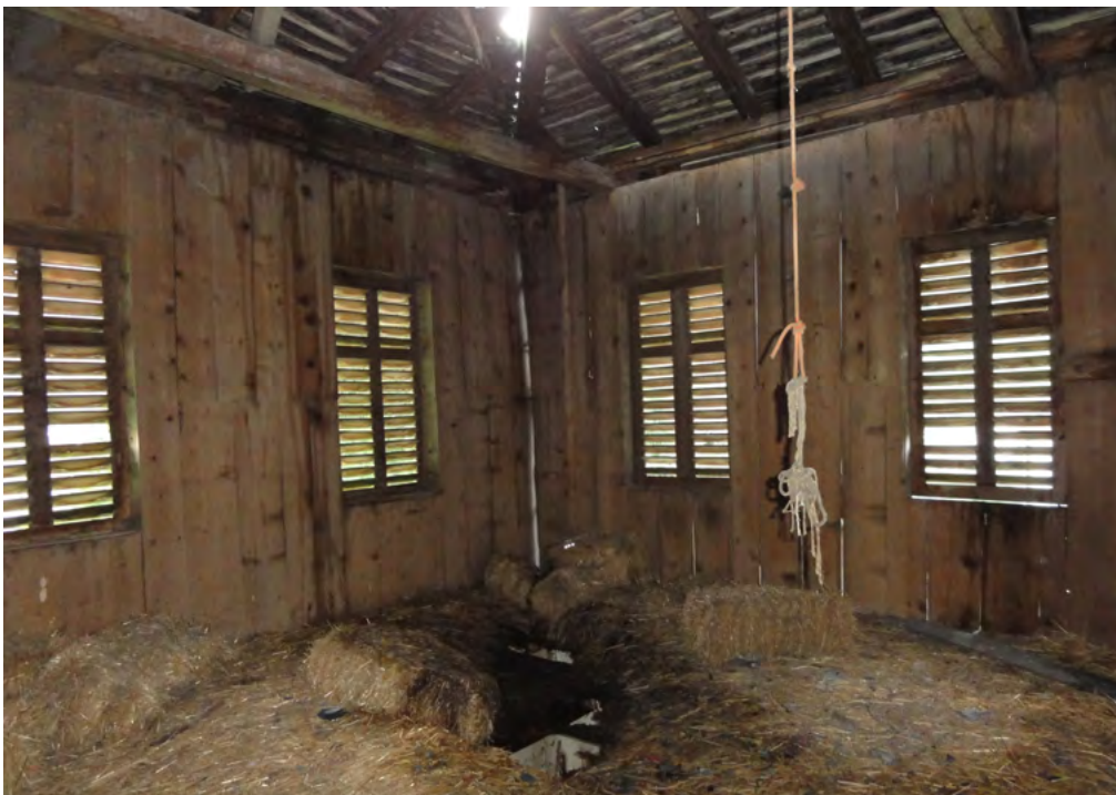
17 Luchsingen, Hauptstrasse: Der Heuraum im Obergeschoss. Die mit Jalousieläden versehenen Öffnungen dienen der für die Heulagerung notwendigen Durchlüftung. Blick nach Südosten. Aufnahme 2012.
