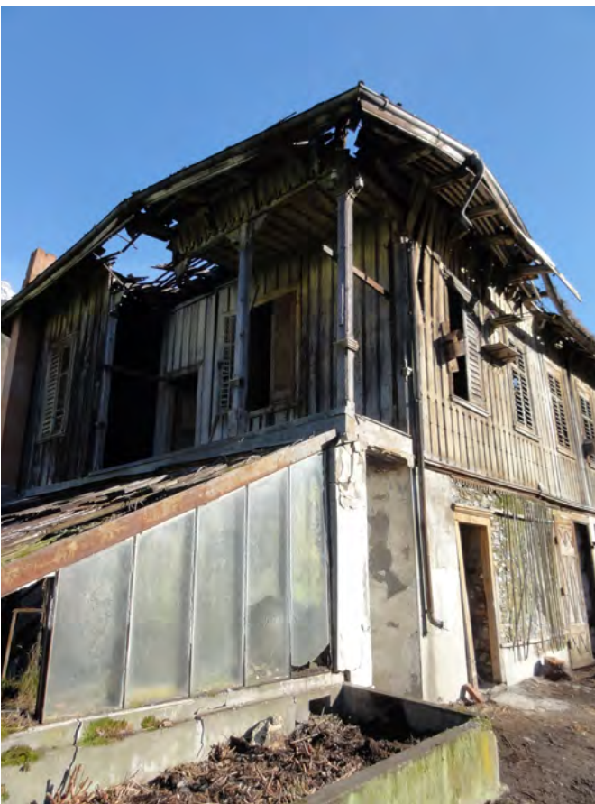
13 Luchsingen, Hauptstrasse: Die Teilansicht von Süd- und Westfassade zeigt den Gewächshausanbau von 1864 mit vorgelagertem Pflanztrog. Über den offenen Durchgang in der Südfassade erreicht man das Treppenhaus, das auf die Laube im Obergeschoss führt. Blick nach Nordosten. Aufnahme 2012.
