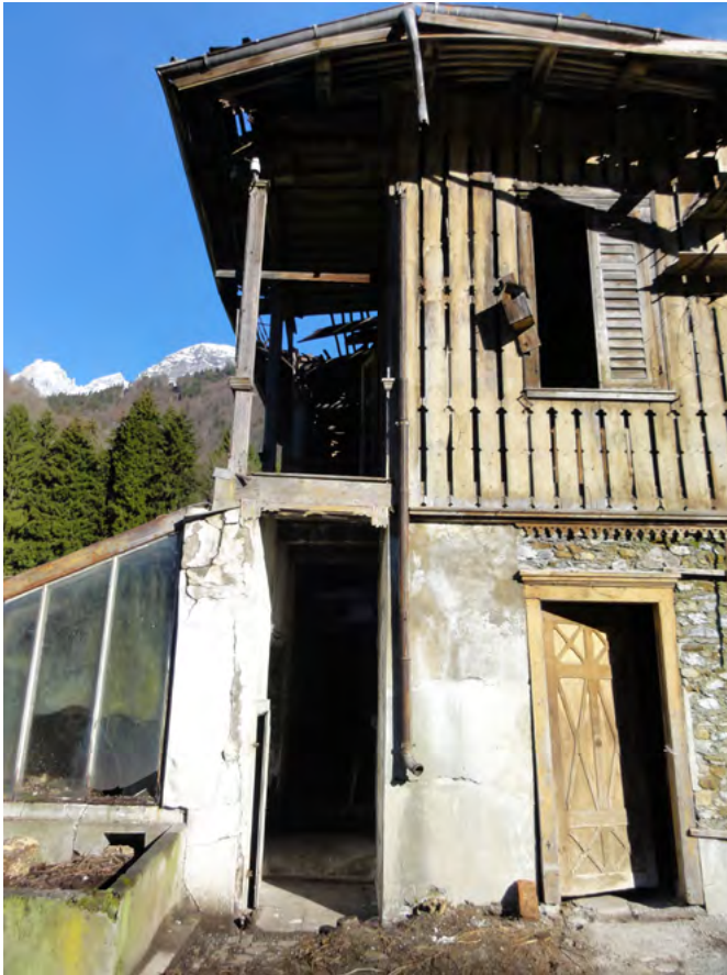
10 Luchsingen, Hauptstrasse: Das Ökonomiegebäude an seinem Herkunftsort kurz vor dem Abbau. Das Gebäude war in einem schlechten baulichen Zustand. Blick nach Nordwesten. Aufnahme 2012.
