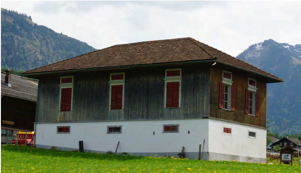
20 Kerns OW, Stanserstrasse, Parzelle 421: Ökonomiegebäude zu einer Ärztevilla. Funktional und gestalterisch ist dieses eng mit dem Bau aus Luchsingen verwandt und zeugt beispielhaft von der überregionalen Verbreitung dieses Bautyps. Aufnahme 2020.
