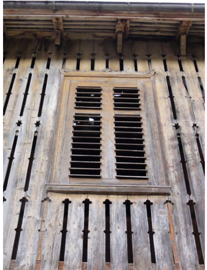
11 Luchsingen, Hauptstrasse: Teilansicht der Südfassade kurz vor dem Abbau 2012. Sie zeigt die sorgfältige handwerkliche Ausführung des Obergeschosses. Aufnahme 2012.
