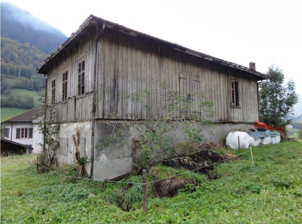
12 Luchsingen, Hauptstrasse: Ansicht der Nordfassade kurz vor dem Abbau. Sie ist als Rückfassade deutlich schlichter gehalten. Blick nach Südwesten. Aufnahme 2012.
