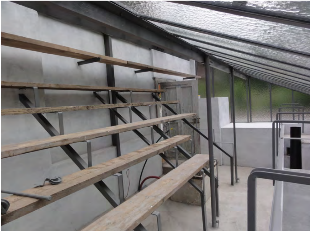
24 Freilichtmuseum der Schweiz, Ökonomiegebäude aus Luchsingen: Innenansicht des Gewächshauses kurz vor der Fertigstellung. Die aufwändige Instandstellung der Stahlkonstruktion erfolgte vorgängig in der Metallbauwerkstatt. Aufnahme 2015.
