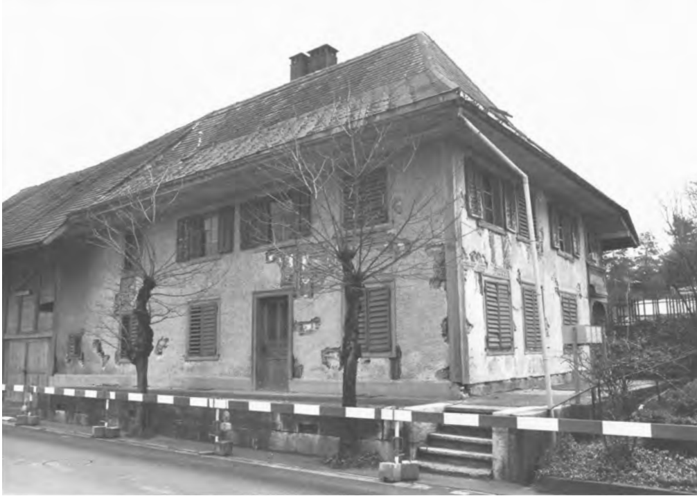
11 Herzogenbuchsee, ehemalige Zürichstrasse 36: Der Fachwerk- und Ständerbohlenbau stand auf einem Steinsockel, der nach Westen und Süden als Plattform ausgebildet war. Die Wände wurden zu einem unbekanntem Zeitpunkt verputzt, einzig das Fachwerk auf der strassenabgewandten Ostseite blieb sichtbar. Blick nach Nordosten. Aufnahme vor 1984.
