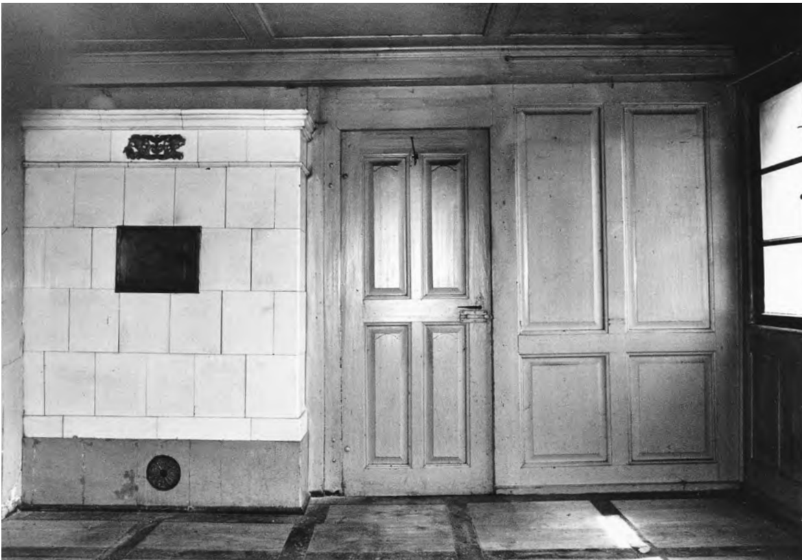
22 Herzogenbuchsee, ehemalige Zürichstrasse 36: Obergeschoss, Arbeitszimmer West. Einige Räume im Obergeschoss wurden zu einem unbekanntem Zeitpunkt verändert und haben aufwendigere Bodenbeläge und Täfer erhalten. Hier ist das Verlegemuster Berner Parkett zu sehen. Aufnahme vor 1984.
