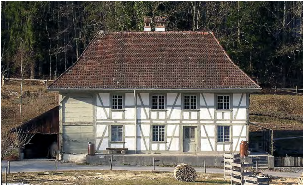
27 Freilichtmuseum der Schweiz, Handwerkerhaus aus Herzogenbuchsee: Das Gebäude steht typologisch in der Tradition der herrschaftlichen Wohnstöcke. Charakteristisch sind das symmetrische Dach, und der Verzicht auf die besondere Hervorhebung einer Gebäudeseite. Der linke Dachabschluss wurde auf dem Ballenberg rekonstruiert. Mit dem Fachwerk- und Bohlen-Ständerbau sowie der rückwärtigen Laube, ist das Gebäude aber auch bäuerlichen Bauformen verpflichtet. Blick nach Osten. Aufnahme 2005.
