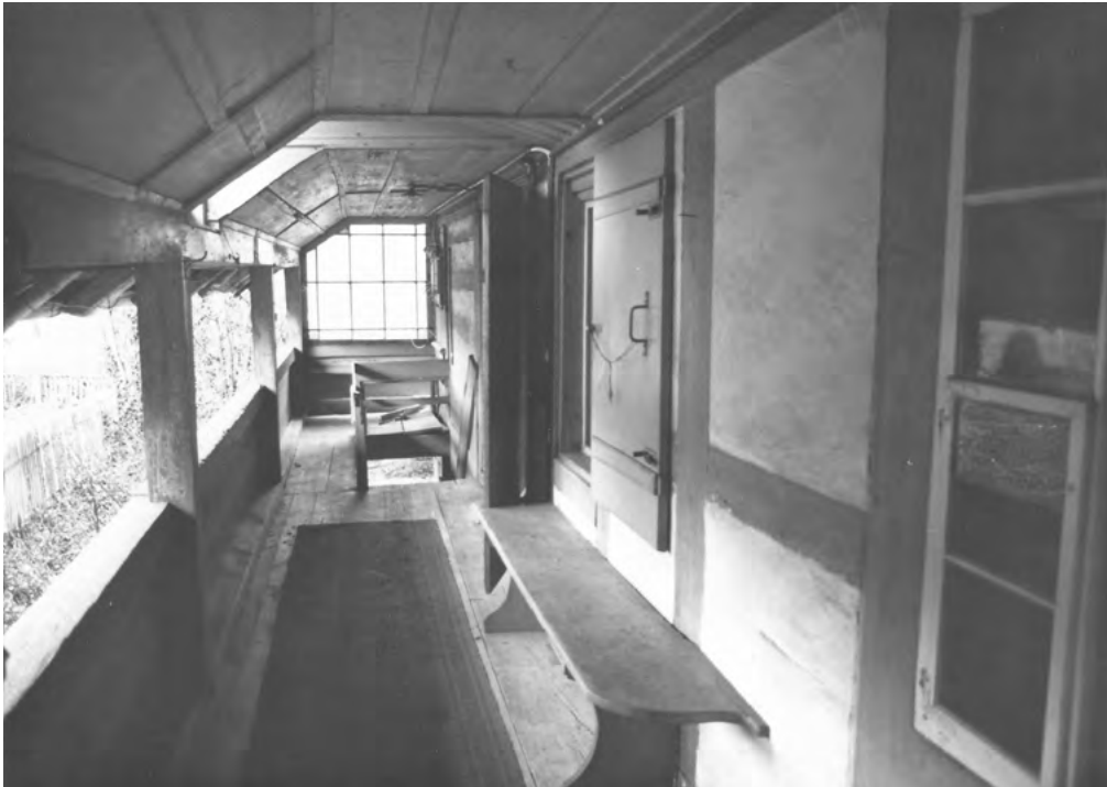
24 Herzogenbuchsee, ehemalige Zürichstrasse 36: Die Laube im Obergeschoss. Hier war das Fachwerk noch zu sehen und nicht verputzt. Blick nach Süden. Aufnahme vor 1984.
