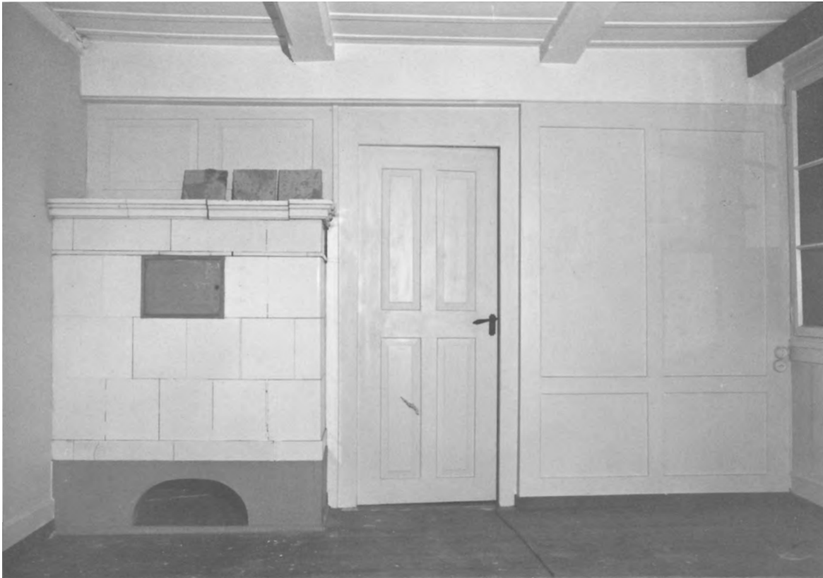
21 Herzogenbuchsee, ehemalige Zürichstrasse 36: Erdgeschoss, wohl Arbeitszimmer West. Die Räume im Erdgeschoss waren mit schlichtem Täfer versehen. Auch die Kachelöfen waren sehr zurückhaltend gestaltet. Aufnahme vor 1984.
