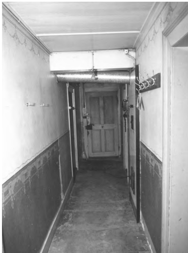
20 Herzogenbuchsee, ehemalige Zürichstrasse 36: Der Hausgang im Erdgeschoss. Die Kachelöfen in den Arbeitszimmern wurden vom Gang aus befeuert, wie man es auch von historischen städtischen Bürgerhäusern kennt. Wie der Rauchabzug ursprünglich funktionierte, ist unklar. Zuletzt wurde er über im Gang sichtbare Ofenrohre den Küchenkaminen zugeleitet. Blick nach Osten. Aufnahme vor 1984.
