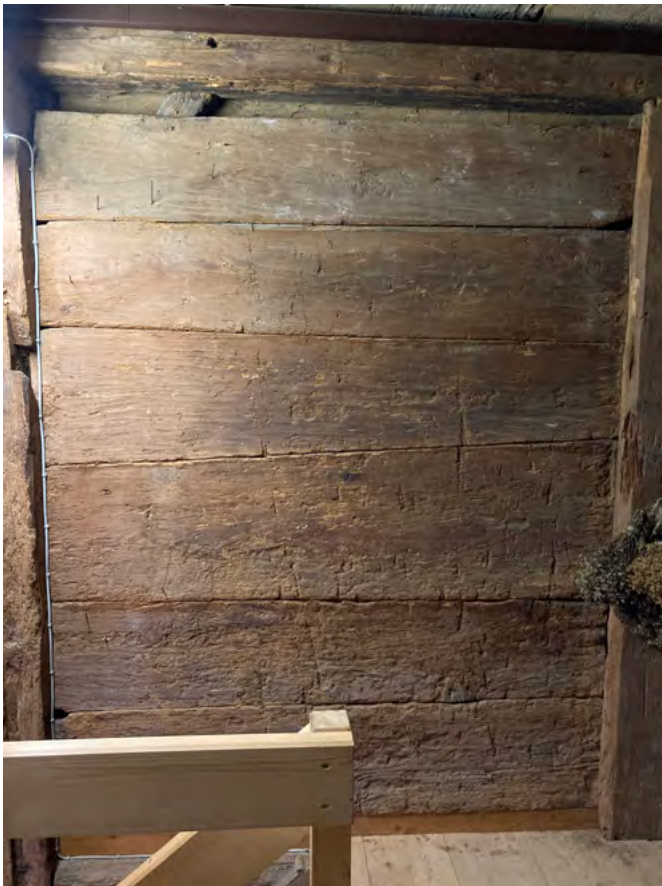
12 Freilichtmuseum der Schweiz, Handwerkerhaus aus Herzogenbuchsee: Im Obergeschoss des früher wohl als Lager genutzten Bohlen-Ständerbaus. Teilweise wurden – wohl wegen der Holzknappheit – dem natürlichen Baumwuchs entsprechende, konisch zulaufende Bohlen genutzt. Zum Ausgleich wurden sie versetzt übereinandergelegt. Blick nach Osten. Aufnahme 2023.
