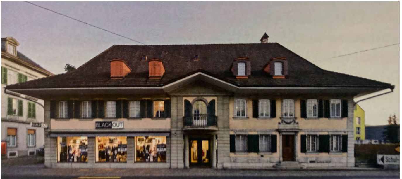
28 Herzogenbuchsee, Bernstrasse 17/23: Dieser massiv gebaute Wohnstock befindet sich mitten in Herzogenbuchsee und wurde 1794/95 errichtet. Blick nach Südosten. Aufnahme undatiert.
