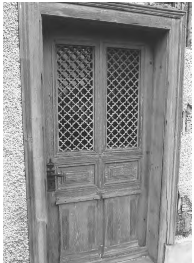
14 Herzogenbuchsee, ehemalige Zürichstrasse 36: Die vermutlich originale strassenseitige Eingangstür in die Erdgeschosswohnung war noch erhalten. Die Glasflächen im oberen Teil des Türblattes wurden durch filigrane gusseiserne Gitter geschützt. Blick nach Osten. Aufnahme vor 1984.
