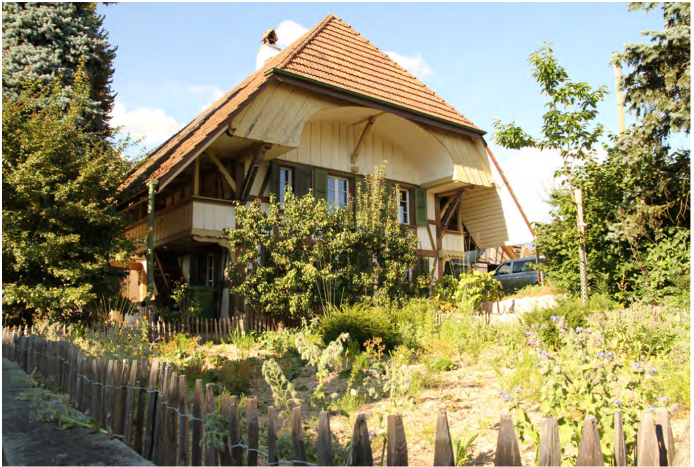
5 Herzogenbuchsee, Zürichstrasse 42: Das nördlich an das Handwerkerhaus angrenzende Bauernhaus stammt von 1828. Es entspricht einem ab um 1800 in der Region aufkommenden Bautypus mit Fachwerk, Walmdach und Ründe. Aufnahme 2016. Blick nach Norden.
