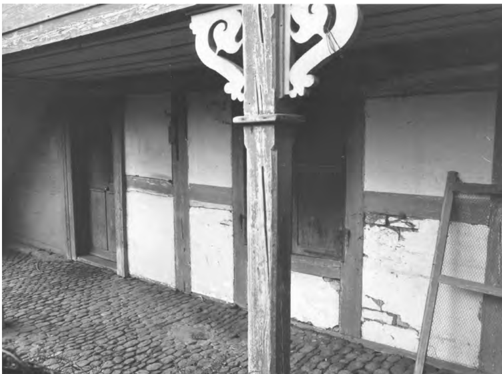
16 Herzogenbuchsee, ehemalige Zürichstrasse 36: Die zurückhaltend profilierten Laubenständer zierten im oberen Bereich Laubsägearbeiten. Der Boden unter der Laube war mit einem regelmässig verlegten Bollensteinbelag versehen. Blick nach Westen. Aufnahme vor 1984.
