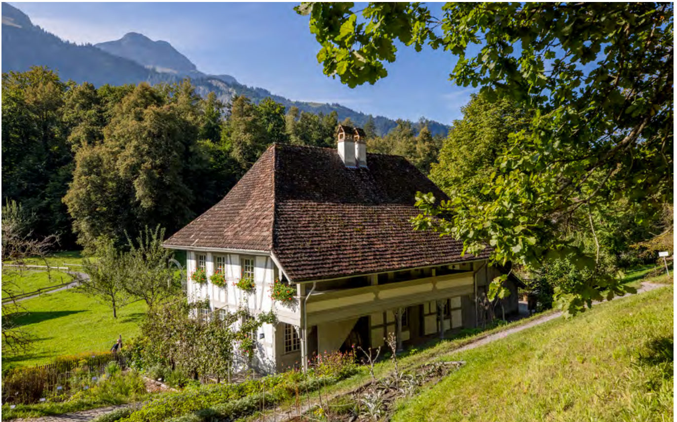
31 Freilichtmuseum der Schweiz, Handwerkerhaus aus Herzogenbuchsee: Auf der Grundlage von restauratorischen Untersuchungen hat das Gebäude sein früheres farbliches Erscheinungsbild zurückerhalten. Die Holzkonstruktion ist grau gefasst, die Ausfachungen sind weiss verputzt. Weisse und graue Farbakzente bilden auch im Bereich der Laube und der Dachverschalung einen reizvollen Kontrast. Blick nach Südwesten. Aufnahme 2020.
