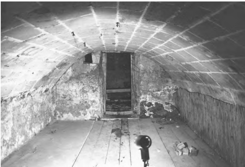
25 Herzogenbuchsee, ehemalige Zürichstrasse 36: Der südliche Kellerraum schloss mit einem aufwendig hergestellten Tonnengewölbe aus Sandsteinquadern ab. Blick nach Norden. Aufnahme vor 1984.
