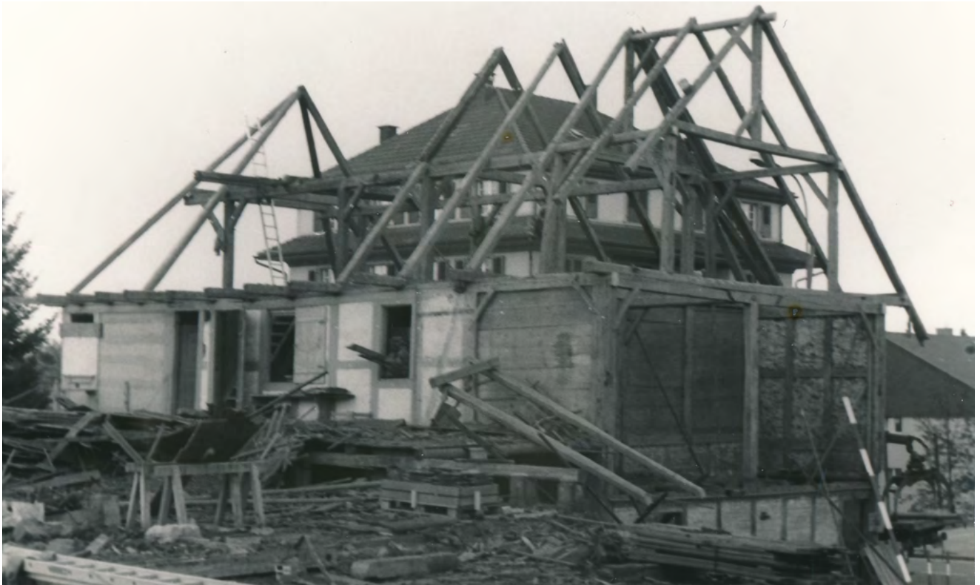
17 Herzogenbuchsee, ehemalige Zürichstrasse 36: Beim Abbau des Gebäudes wurde das Dachwerk sichtbar. Es handelte sich um ein Sparrendach mit stehendem Stuhl. An der südlichen Giebelseite, im Bild links, war das Dach als Vollwalm ausgebildet. Im Norden war es durch den späteren Stallanbau gestört worden. Blick nach Südwesten. Aufnahme 1983.
