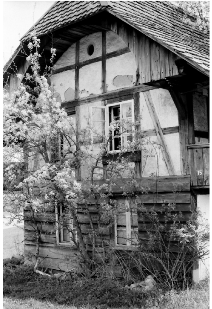
13 Köniz-Wabern, Stöckli Unteres Morillongut: Blick nach Nordosten auf die hofseitige Westfassade mit den Stuben im Erd- und Obergeschoss. Vor der Fassade steht Spalierobst. Die Wand im Erdgeschoss hat nachträglich eine Bretterschalung als Wärmedämmung bekommen. Der Schwebgiebel der Dachkonstruktion unter dem Krüppelwalm ist hier auf der Westseite als Ründe ausgebildet und mit Brettern verschalt. Aufnahme 1984.
