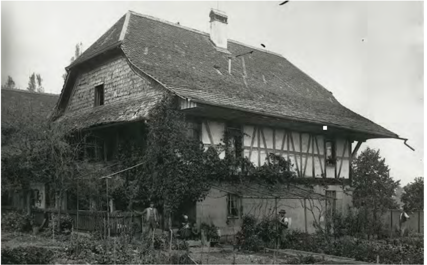
7 Köniz-Wabern, Unterer Morillongut: Blick nach Südwesten auf den Wohnteil des Pächterhauses im Unterer Morillongut, heute Frischingweg 19, mit den Gärten im Vordergrund. Gebaut war der herrschaftliche Wohnstock mit eindrücklichem Walmdach, gemauertem Erdgeschoss und Rieg im Obergeschoss. Aufnahme wohl ausgehendes 19. Jahrhundert.
