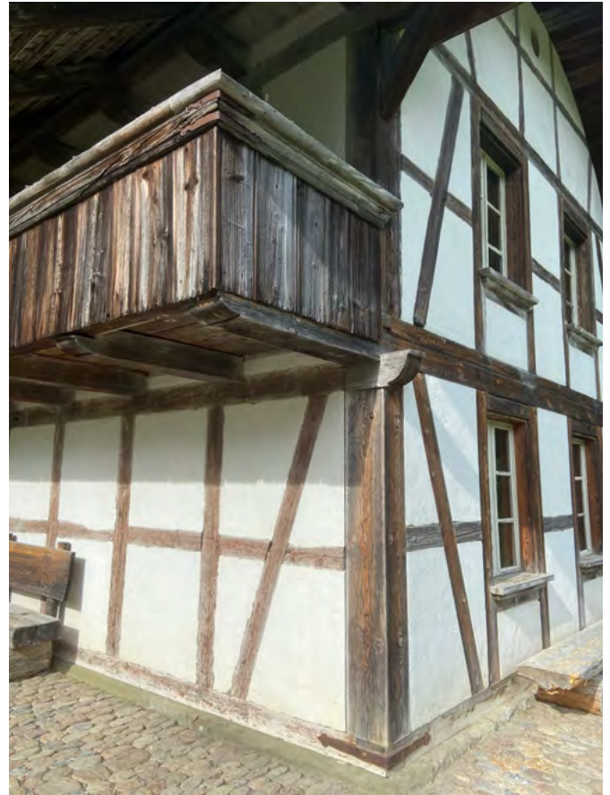
11 Freilichtmuseum der Schweiz, Stöckli Unteres Morillonogut: Blick auf die südwestliche Ecke des Stöckli. Gut zu erkennen ist die zusätzliche Sicherung der Eckverbindung des Schwellenkranzes mit einem Eisenband. Dies ist ein gutes Indiz für eine späte Entstehung des Gebäudes, als die Handwerkstraditionen bereits von den neuen Formen des gewerblichen, rationalisierten Bauens abgelöst worden waren. Aufnahme 2022.
