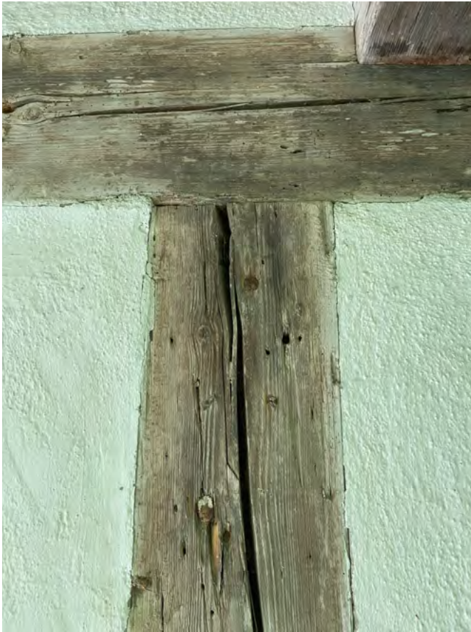
10 Freilichtmuseum der Schweiz, Stöckli Unteres Morillonogut: Das im Sägewerk vorgefertigte Bauholz weist festsitzende Holzverbindungen auf, die allesamt ohne Holznägel auskommen. Abbundzeichen eines handwerklichen Abbunds der Hölzer auf einem Zimmereiplatz fehlen. Die Zimmerleute nutzten offenbar das standardisierte Bauholz und fertigten vor Ort nur noch die nötigen Zapfenverbindungen mit Säge und Stechbeitel. Aufnahme 2022.
