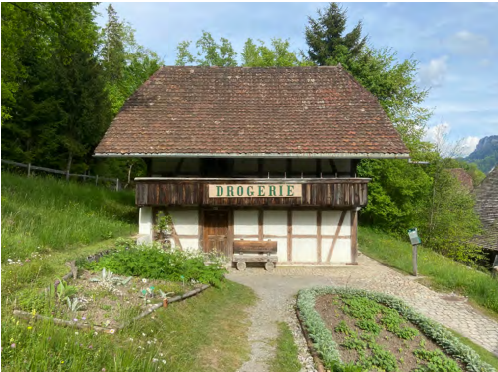
24 Freilichtmuseum der Schweiz, Stöckli Unteres Morillongut: Blick nach Osten auf die heutige Westfassade des jetzt als historische Drogerie eingerichteten Stöckli. Zu sehen ist unter der Seitenlaube der ehemalige Hauseingang vor der Küche. Da der Keller nicht übernommen wurde, steht das Gebäude jetzt auf einem Sandsteinsockel, das Umfeld ist für den Museumsbetrieb gepflastert. Aufnahme 2022.
