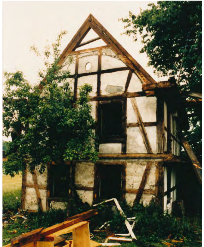
18 Köniz-Wabern, Stöckli Unterer Morillongut: Blick auf die westliche Giebelwand nach dem Abbau des Daches. Gut abzulesen ist der Verlauf der ehemaligen Ründe und die Konstruktion des Sparrendachs. Aufnahme 1984.
