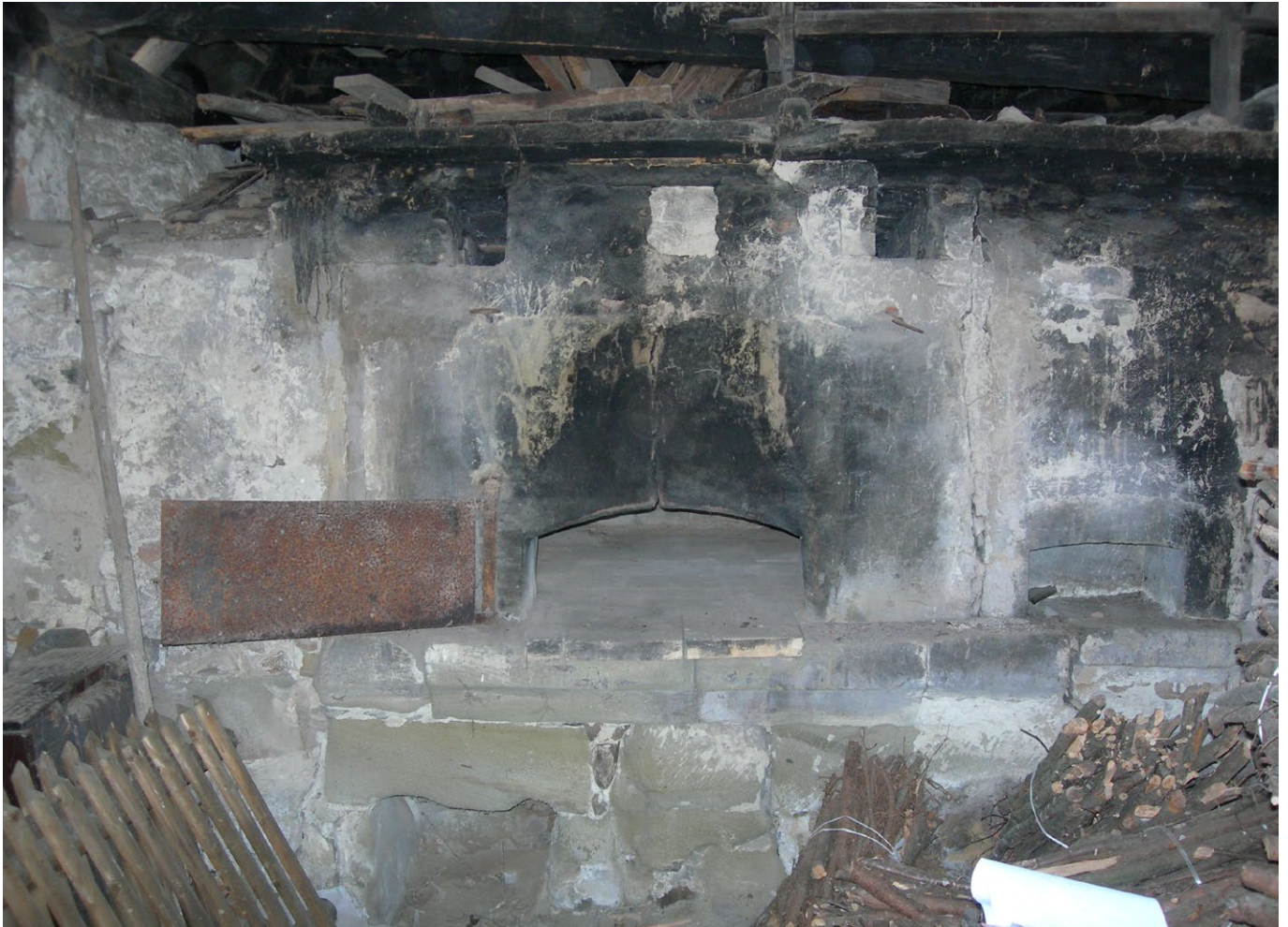
12 Breitenried, Ofenhaus: Die Ofenfront mit Ofenloch, Rauchabzügen, Ascheloch und Lichtnische. Blick nach Westen. Aufnahme 2006.
