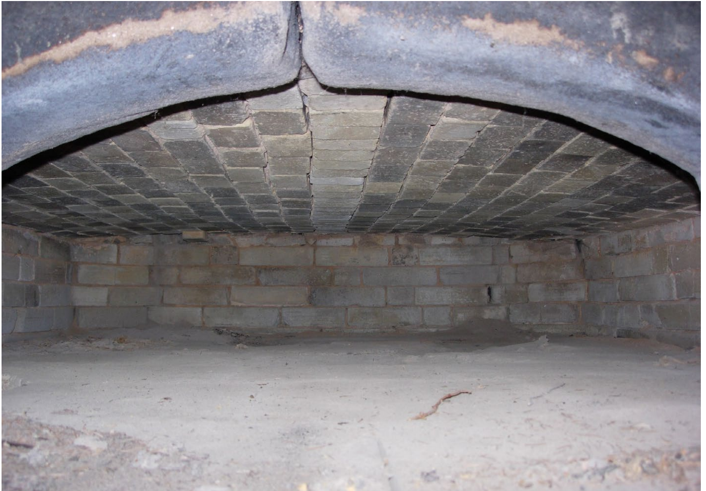
6 Breitenried, Ofenhaus: Der um 1935 umgebaute flache Innenraum des Ofens mit eckigem Grundriss. Blick nach Westen. Aufnahme 2005.
