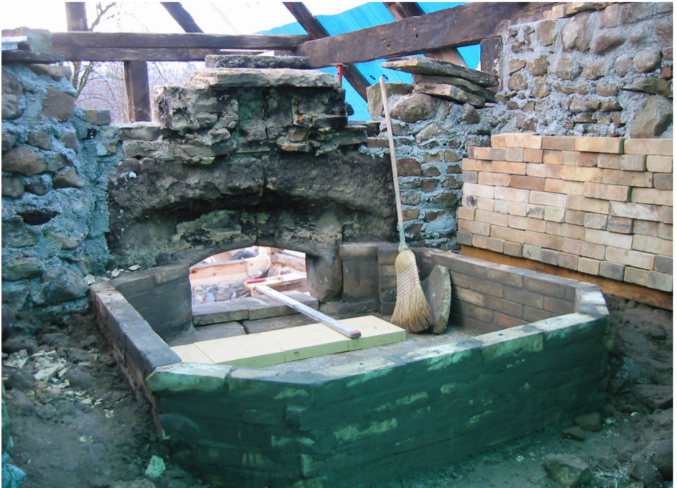
19 Freilichtmuseum der Schweiz, Ofenhaus aus Breitenried: Der Innenraum des Ofens wurde nach Befund mit neuen Schamottesteinen rekonstruiert. Die gemauerte Hülle sowie das Füllmaterial wurden vom ehemaligen Standort übernommen. Blick nach Südosten. Aufnahme 2006.
