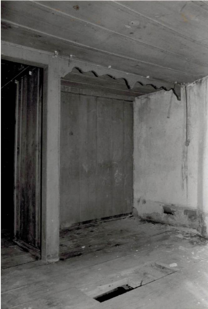
**19** Villars-Bramard: Nordwestliche Kammer. Zustand vor dem Abbruch des Gebäudes. Der Alkoven ist noch in gutem Zustand und konnte ins Freilichtmuseum überführt werden. Die ursprüngliche Raumfassung, weisse Wände mit grauer Sockelmalerei, ist gut erkennbar. Blick nach Nordosten. Aufnahme undatiert.
