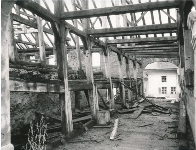
**14** Villars-Bramard: Die Stützen waren im unteren Bereich aus stabilerem Eichenholz gefertigt. Im oberen Bereich bestanden sie aus Nadelholz. Blick nach Südosten. Aufnahme 1982.
