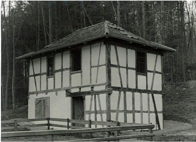
16 Freilichtmuseum der Schweiz, Ökonomiegebäude aus Rüslikon: Am Museumsgebäude wurden gegenüber dem Zustand am ehemaligen Standort einige Veränderungen vorgenommen. So wurden die vormals unregelmässig angeordneten Fenster ersetzt und vereinheitlicht. Der einst gemauerte Bereich neben dem Eingang wurde im Museum als Fachwerk ausgeführt. Blick nach Nordwesten. Aufnahme 1979.
