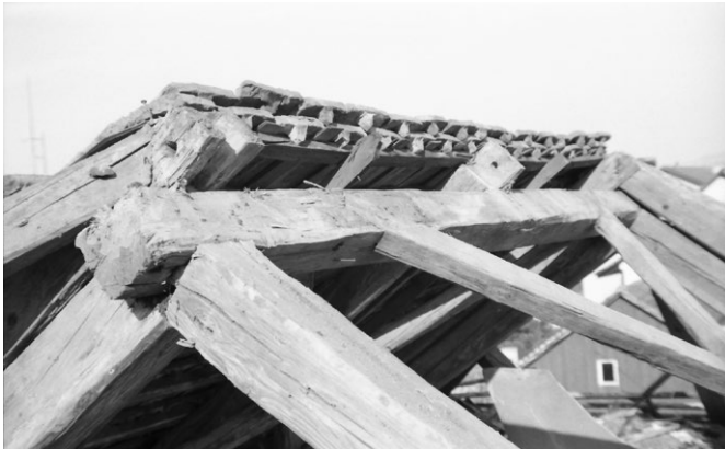
11 Rüschlikon, ehemals Dorfstrasse 38: Während des Abbaus. Die Firstpfette stützten zwei Strebenpaare. Darüber waren die miteinander verzapften Sparren gelegt. Überkreuzte Windrispen steiften die Konstruktion zusätzlich aus. Aufnahme 1979.
