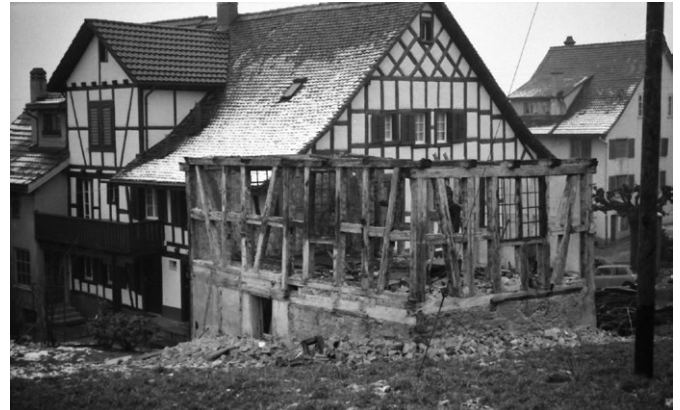
14 Rüschnikon, ehemals Dorfstrasse 38: Der Abbau erfolgte im März 1979 innerhalb von nur drei Tagen. Blick nach Südosten. Aufnahme 1979.
