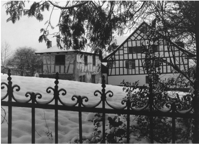
7 Rüslikon, ehemals Dorfstrasse 38: Die Westfassade des Ökonomegebäudes. Im Hintergrund ist das Nachbarhaus zu sehen. Blick nach Osten. Aufnahme ca. 1979.
