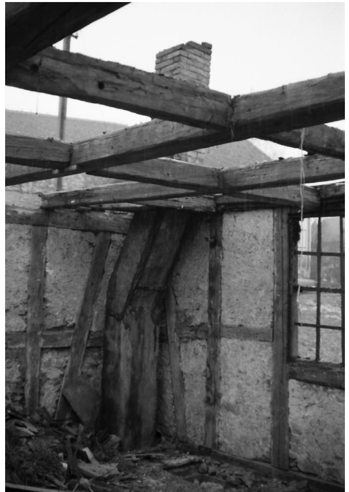
10 Rüschnikon, ehemals Dorfstrasse 38: Während des Abbaus. Das Dach wurde von einem Gitter aus überblatteten Dachbalken getragen. Blick nach Nordwesten. Aufnahme 1979.
