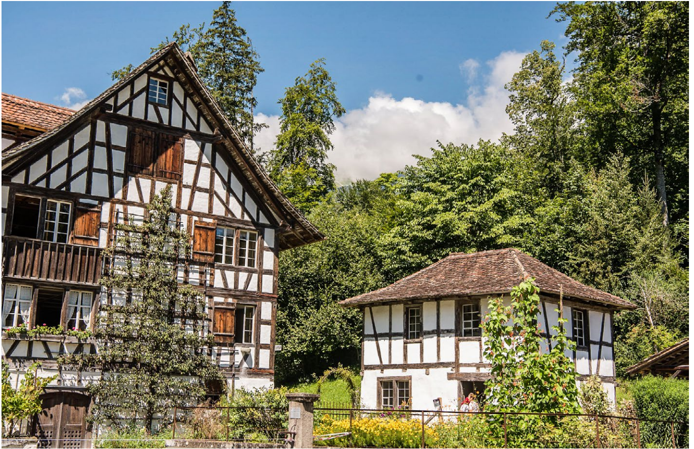
15 Freilichtmuseum der Schweiz, Ökonomiegebäude aus Rüslikon: Das Ökonomiegebäude bildet zusammen mit dem Wohnhaus aus Richterswil, im Bild links, sowie einem Tresterschopf und einem Bienenhaus ein Ensemble, das den Weinbau in der Zürichseeregion repräsentiert. Blick nach Nordwesten. Aufnahme 2020.
