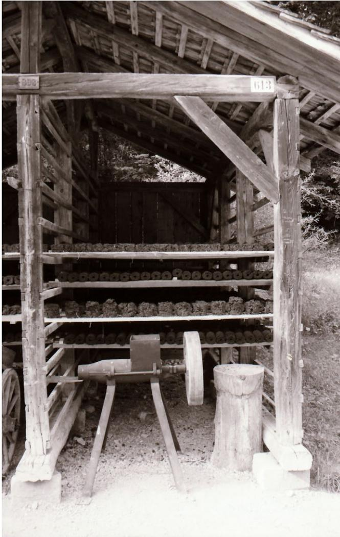
**13** Freilichtmuseum der Schweiz, Tresterschopf aus Männedorf: Beim Tresterschopf befindet sich noch eine Zigerlimaschine aus der Maschinenfabrik Hochdorf. Solche Maschinen waren weitverbreitet und wurden zur effizienteren Herstellung von Tresterstöckli benötigt. In kleineren Betrieben wurden die Tresterstöckli noch von Hand gestochen oder mittels Blumentöpfen geformt. Aufnahme o. J.
