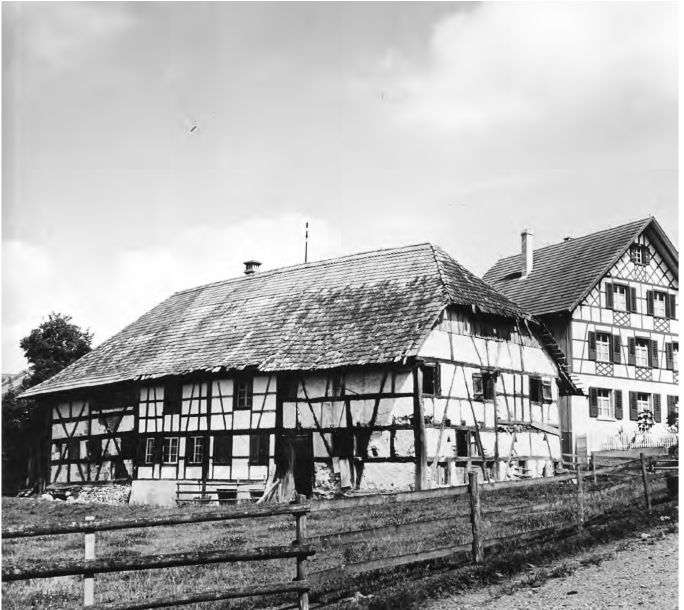
8 Uesslingen, Hugen-Haus: Das Bauernhaus im Vordergrund kurz vor der Translozierung. Es stand bereits längere Zeit leer und war entsprechend in einem stark renovierungsbedürftigen Zustand. Seit dem 18./19. Jahrhundert bestand nördlich vom Haagen-Haus anstelle der dortigen Nebengebäude das Wohnhaus im Hintergrund mit zeittypischem Fachwerk. Blick nach Nordwesten. Aufnahme 1976.
