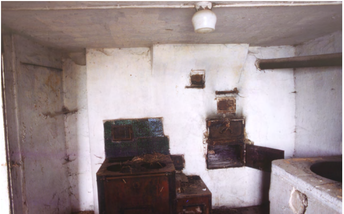
22 Uesslingen, Hugen-Haus: Blick in die Küche mit dem Sparherd und der Schüröffnung des Stubenofens. Rechts ist der Tolofen unter anderem zum Waschen der Wäsche zu erkennen. Blick nach Süden. Aufnahme 1976.
