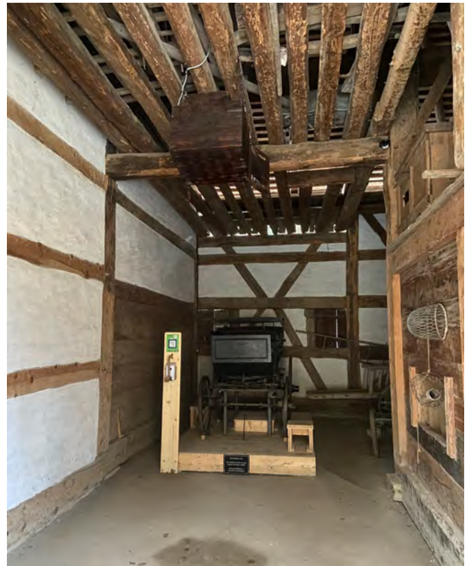
24 Freilichtmuseum der Schweiz, Bauernhaus aus Uesslingen: Blick in den westlichen Ökonomieteil nach dem Wiederaufbau. Dieser dient heute als Wagenremise. Links ist die teils ausgebohrte Wand zum Wohnteil zu sehen, rechts der wiederhergestellte Stall mit den Bohlenwänden. Oben sieht man die zur Lagerung von ungedroschenem Getreide genutzte Heubühne oder Brügi. Aufnahme 2019.
