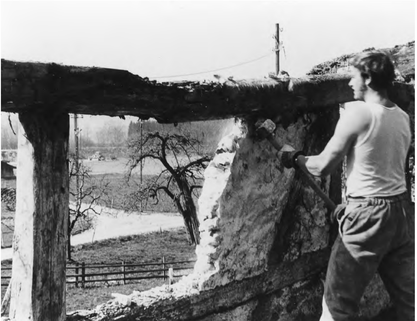
25 Uesslingen, Hugen-Haus: Abbruch der mit Bollensteinmauerwerk geschlossenen Gefache. Beim Wiederaufbau wurden die Gefache mit modernen Ziegelsteinen geschlossen. Aufnahme 1976.
