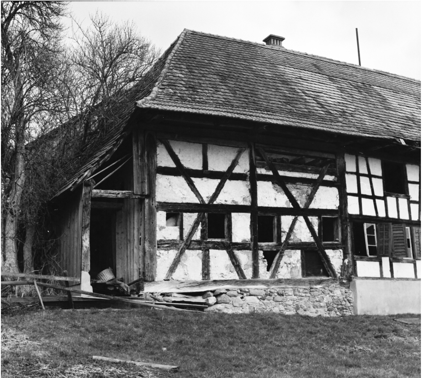
16 Uesslingen, Hugen-Haus: Südwestecke des mehrreihigen Ständerbaus. Zu sehen ist der Stallteil des Kernbaus von 1568/69 mit dem jüngeren Schleppdachanbau. Die Ständerkonstruktion weist geschossübergreifende Ständer und Streben sowie von diesen überblattete durchlaufende Brüstungs- und Sturzriegel auf, die der Fenstergliederung dienen. Gut zu erkennen ist die aus Bollensteinen gemauerte Sockelmauer unter der Eichenschwelle. Blick nach Nordosten. Aufnahme 1975.
