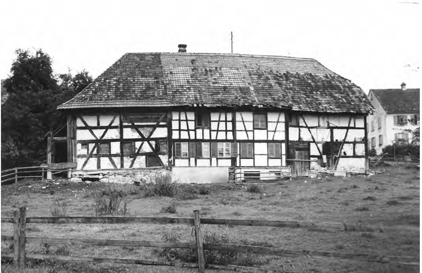
12 Uesslingen, Hugen-Haus: Das ehemalige Bauernhaus in unbewohntem und verfallenem Zustand kurz vor der Translozierung. Deutlich abzulesen ist die Dreiteiligkeit des Gebäudes an der Fassade. Blick nach Norden. Aufnahme 1976.
