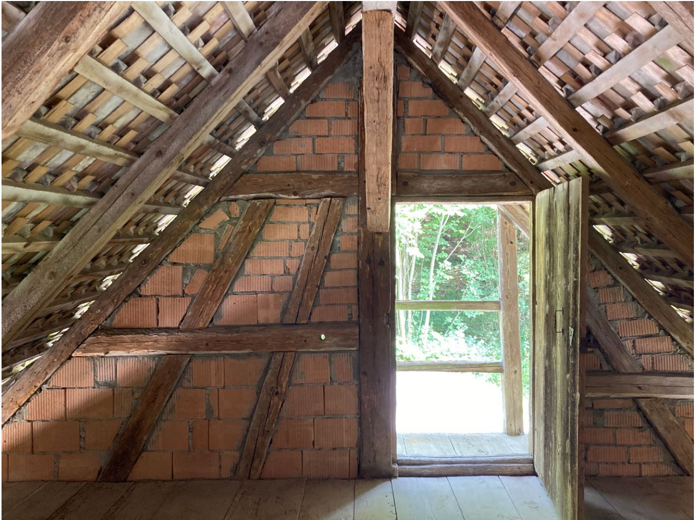
18 Freilichtmuseum der Schweiz, Kornspeicher aus Wellhausen: Beim Wiederaufbau kam neben der originalen Holzkonstruktion auch Altholz zur Verwendung. Die Bollensteine, mit denen die Gefache gefüllt waren, wurden nicht übernommen. Stattdessen entschied man sich für industriell gefertigte Ziegel, die von aussen verputzt wurden. Blick nach Norden. Aufnahme 2023.
