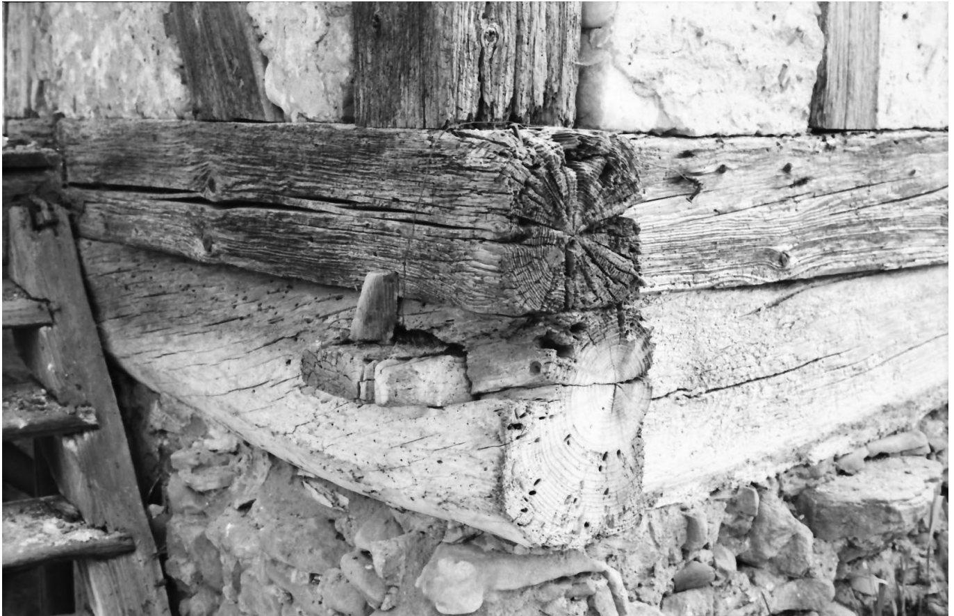
12 Wellhausen, heutige Spychergasse: Die Basis des Fachwerkbaus bildete ein doppelter Schwellenkranz, der mit einem einfachen Schwellenschloss gesichert war. Der untere Kranz bestand aus Eichen-, der obere aus Nadelholz. Blick nach Südwesten. Aufnahme um 1979.
