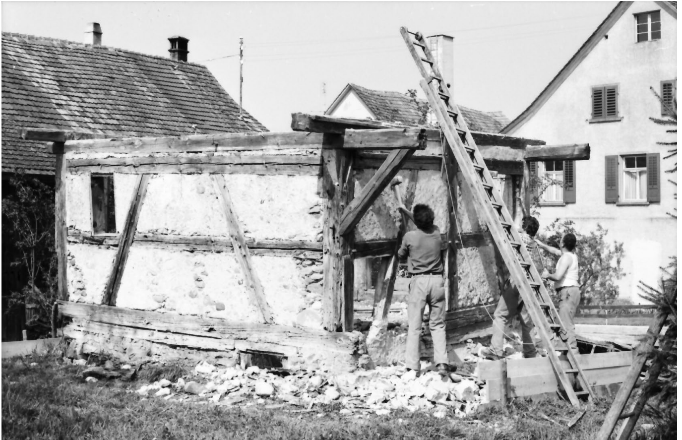
15 Wellhausen, heutige Spychergasse: Der Speicher beim Abbau. Das Gebäude wurde innert weniger Wochen demontiert und im Freilichtmuseum wieder aufgebaut. Blick nach Nordosten. Aufnahme 1979.
