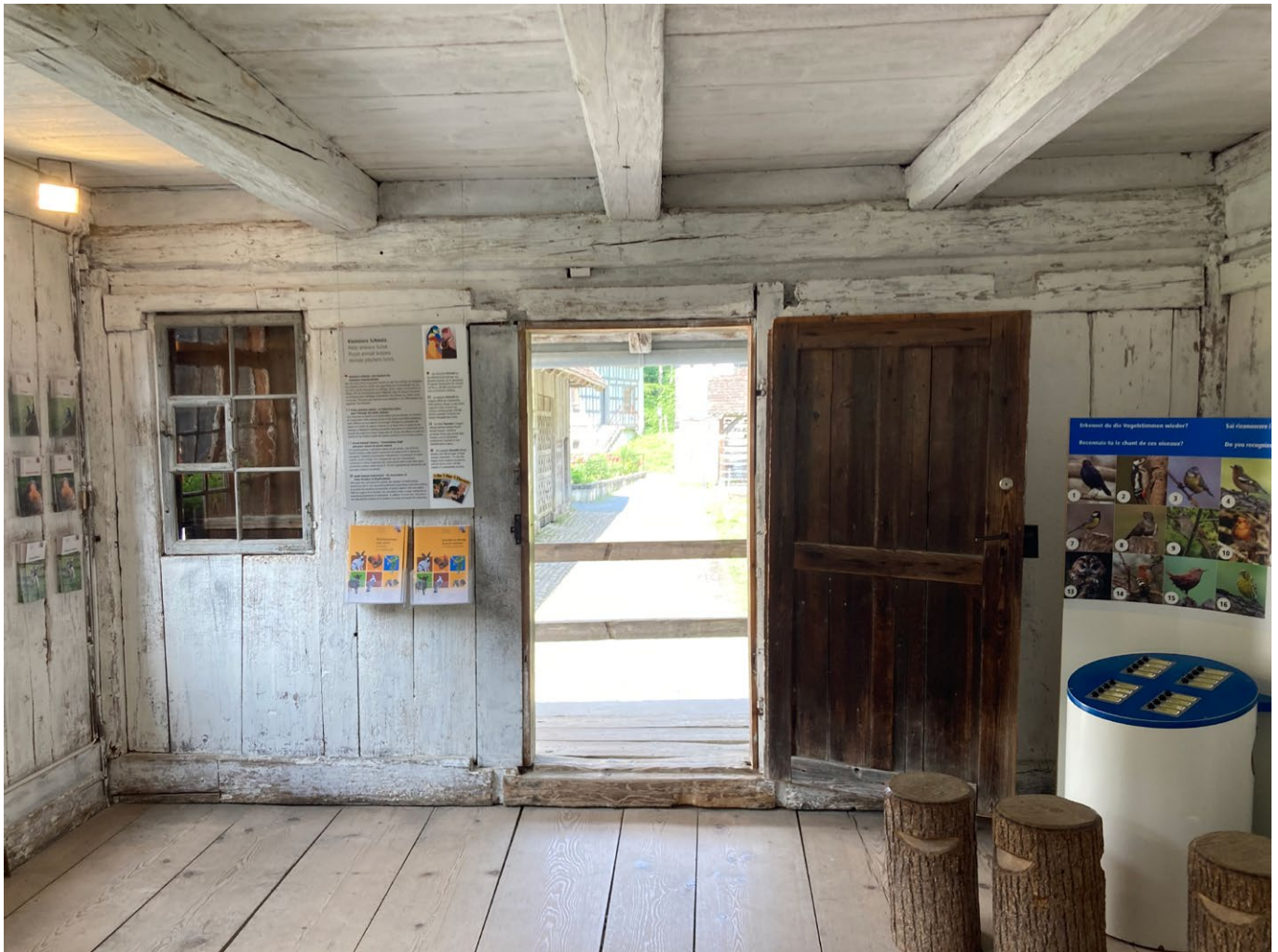
19 Freilichtmuseum der Schweiz, Kornspeicher aus Wellhausen: Der Erdgeschossraum wurde wieder mit stehenden Bohlen verkleidet und weiss gekalkt. Gegenwärtig wird ein neues didaktisches Konzept erarbeitet und die Räume in naher Zukunft umgenutzt. Blick nach Westen. Aufnahme 2023.
