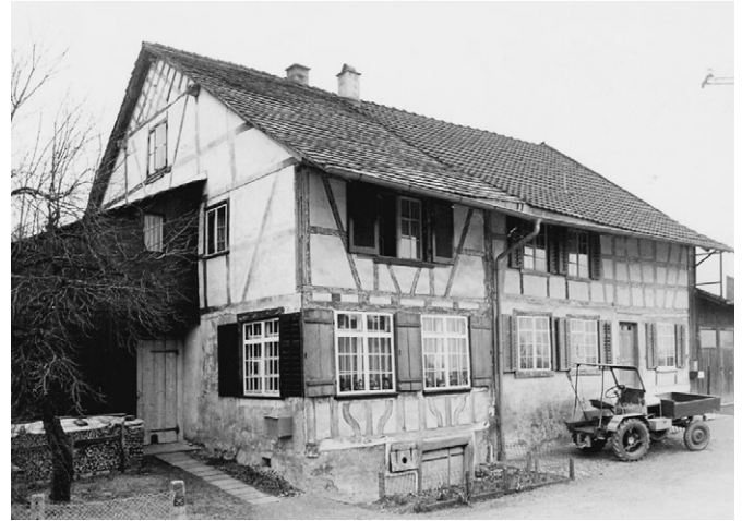
6 Wellhausen, Spychergasse 4: Das südlich des Speichers gelegene Vielzweckhaus. Es ist bei einem Brand im Frühjahr 2023 vollständig zerstört worden. Aufnahmedatum unbekannt.
