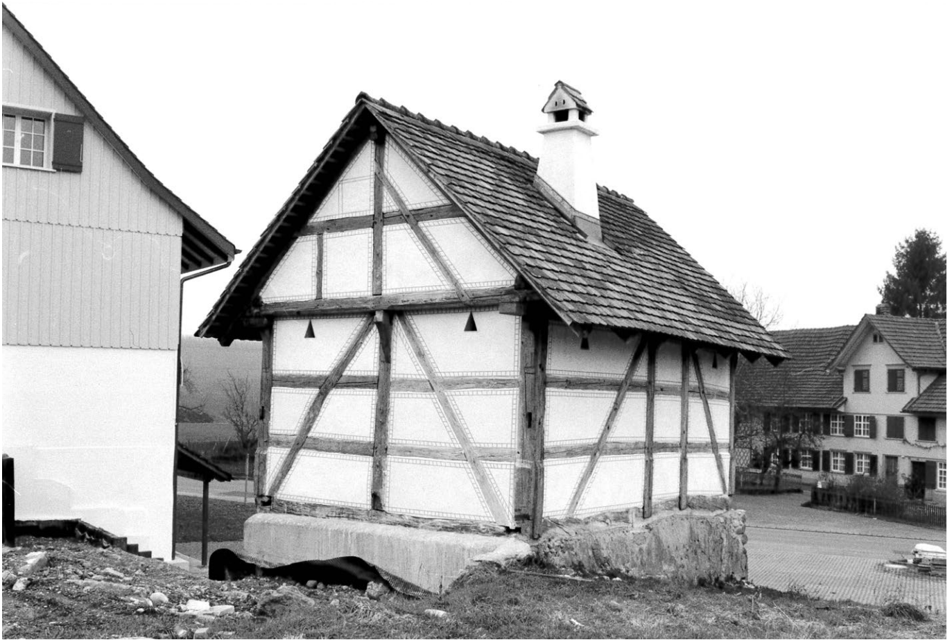
9 Riedt bei Erlen TG: Ein früher Vergleichsbau aus dem ausgehenden 16. Jahrhundert. Auch dieser Thurgauer Speicher wurde in Fachwerkbauweise errichtet. Aufnahme undatiert.
