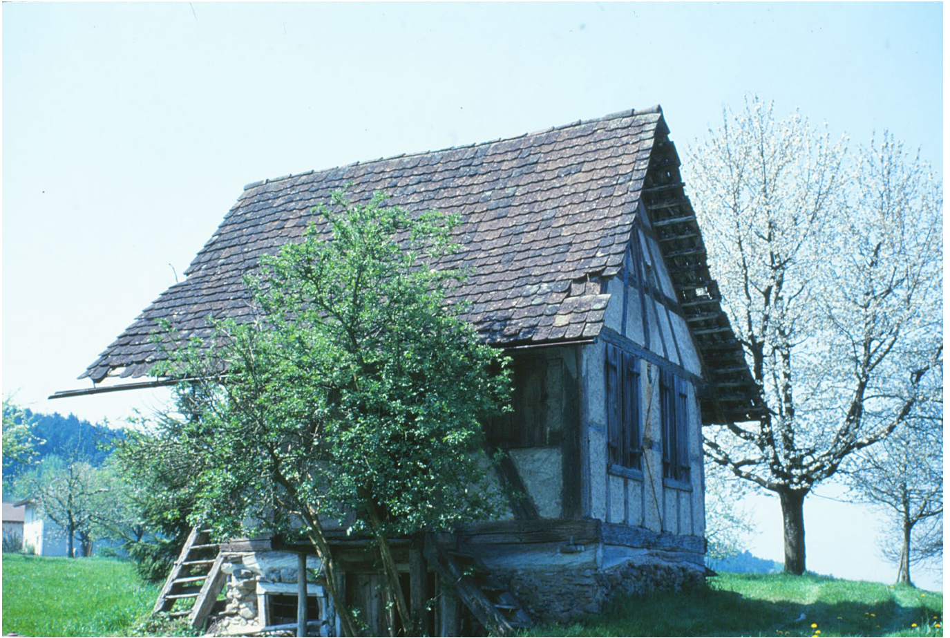
10 Wellhausen, heutige Spychergasse: Das Erdgeschoss hat im 19. Jahrhundert einen Umbau erfahren. Die Nutzung als Kornspeicher wurde aufgegeben und stattdessen eine Werkstatt eingerichtet. Dabei wurden auf der West-, Ost- und Nordseite grosse Fenster eingesetzt. Blick nach Südwesten. Aufnahme 1978.
