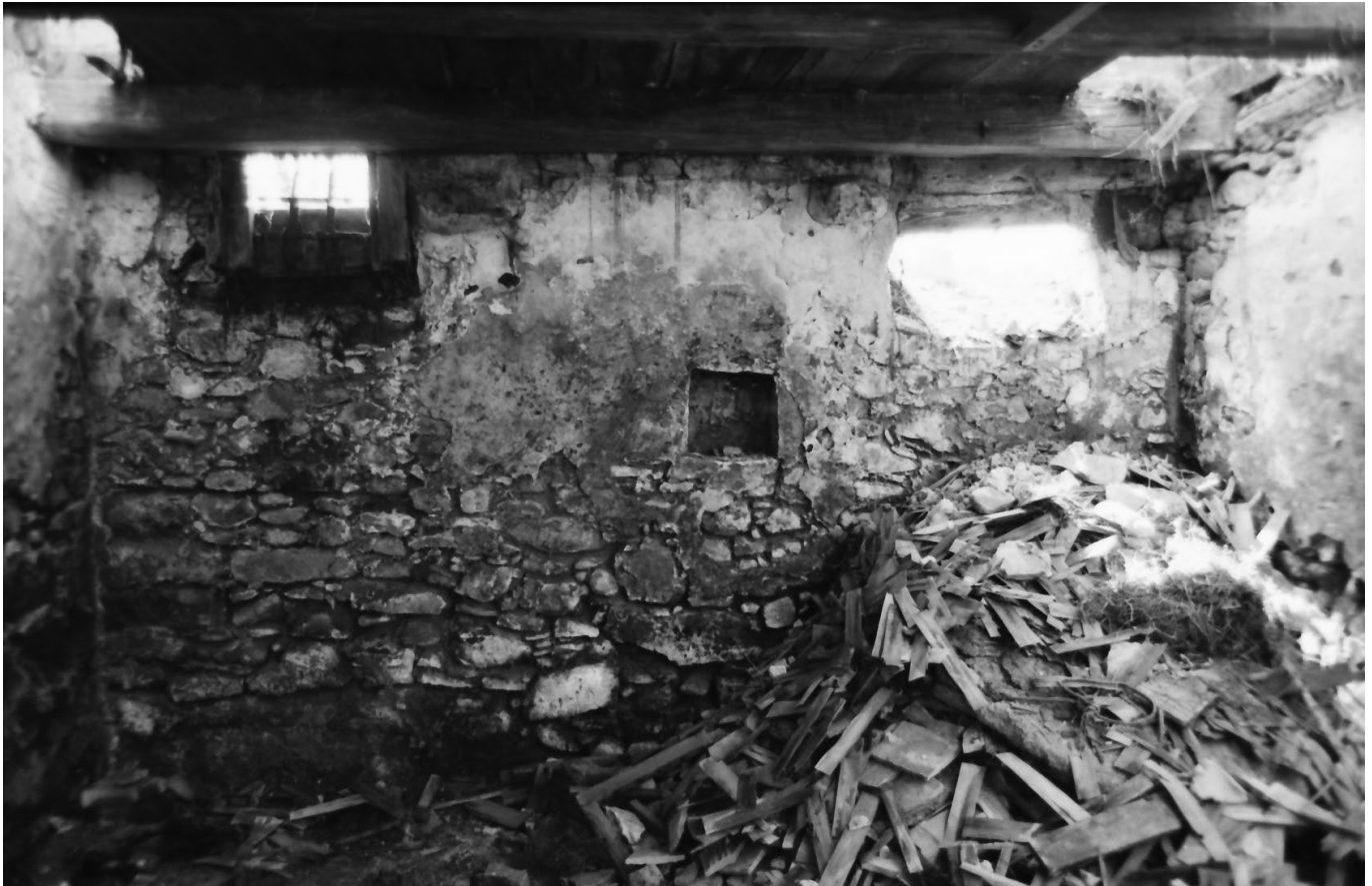
11 Wellhausen, heutige Spychergasse: Das Kellergeschoss des Speichers war aus Bollensteinen gemauert und innen hell verputzt. Vergitterte Öffnungen brachten Licht und Luft in das Rauminnere. Lichtnischen ermöglichten das Aufstellen von Leuchtmitteln. Blick nach Westen. Aufnahme um 1979.
