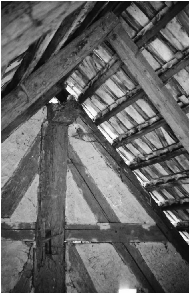
13 Wellhausen, heutige Spychergasse: Die Ständer der Giebfelder waren zugleich die Stützen für die Firstpfette, die wiederum die Sparrenpaare trug. Die Firstpfette wurde allerdings zu einem unbekanntem Zeitpunkt durchgesägt und weitestgehend entfernt. Blick nach Norden. Aufnahme um 1979.
