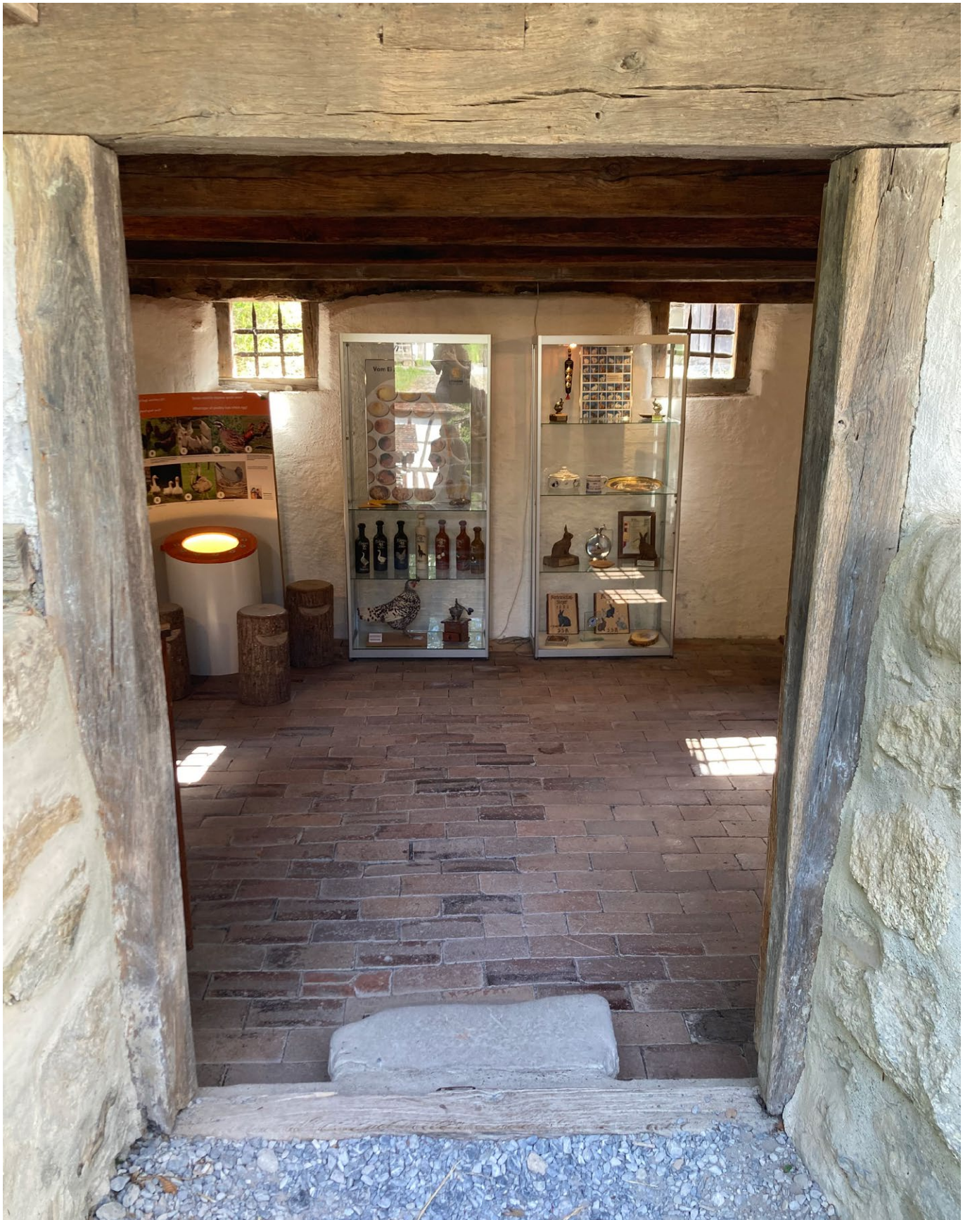
17 Freilichtmuseum der Schweiz, Kornspeicher aus Wellhausen: Der Boden des Kellergeschosses wurde auf dem Ballenberg mit Tonziegeln ausgelegt und hat wieder einen hellen Putz erhalten. Die Sandsteinstufen wurden übernommen. Blick nach Osten. Aufnahme 2023.
