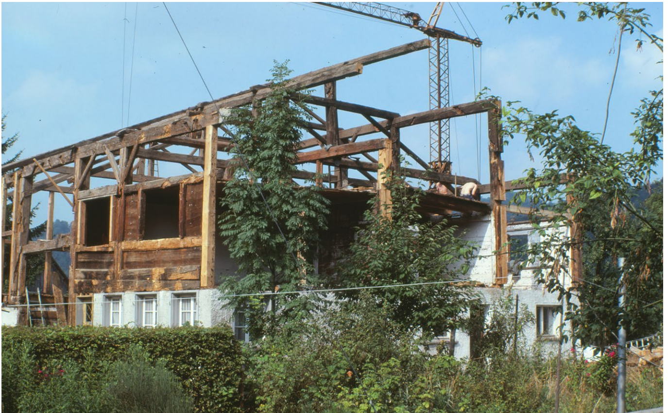
24 Wila, Huswies: Der Rückbau des Gebäudes am ursprünglichen Standort. Blick nach Nordosten. Aufnahme 1979.
