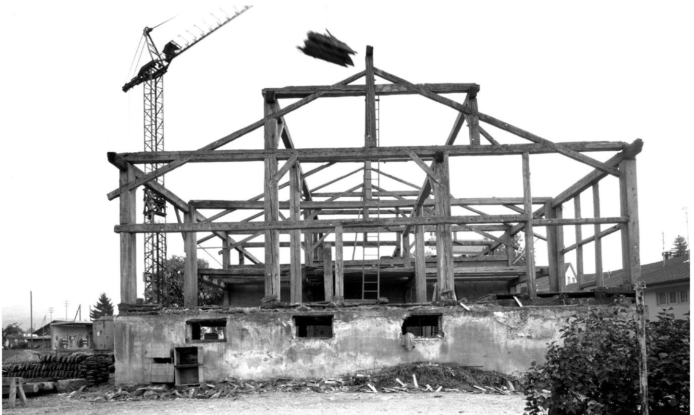
19 Wila, Huswies: Ansicht des ursprünglichen statischen Gerüsts des Ökonomieteils beim Abbau. Blick nach Süden. Aufnahme 1979.
