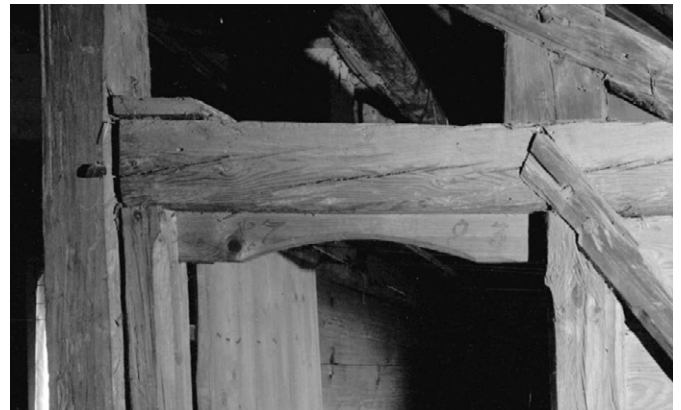
18 Wila, Huswies: Dachkammer im Sturzholz mit der Jahreszahl 1783 versehen. Aufnahme 1979.
