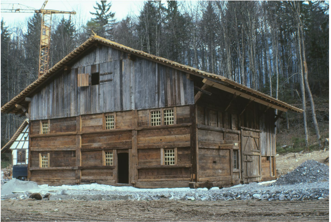
34 Freilichtmuseum der Schweiz, Bauernhaus aus Wila: Wiederaufbau im Museum. Gut zu erkennen ist, dass es sich bei verschiedenen Bauteilen um Altholz handelt. Blick nach Nordwesten. Aufnahme 1980.
