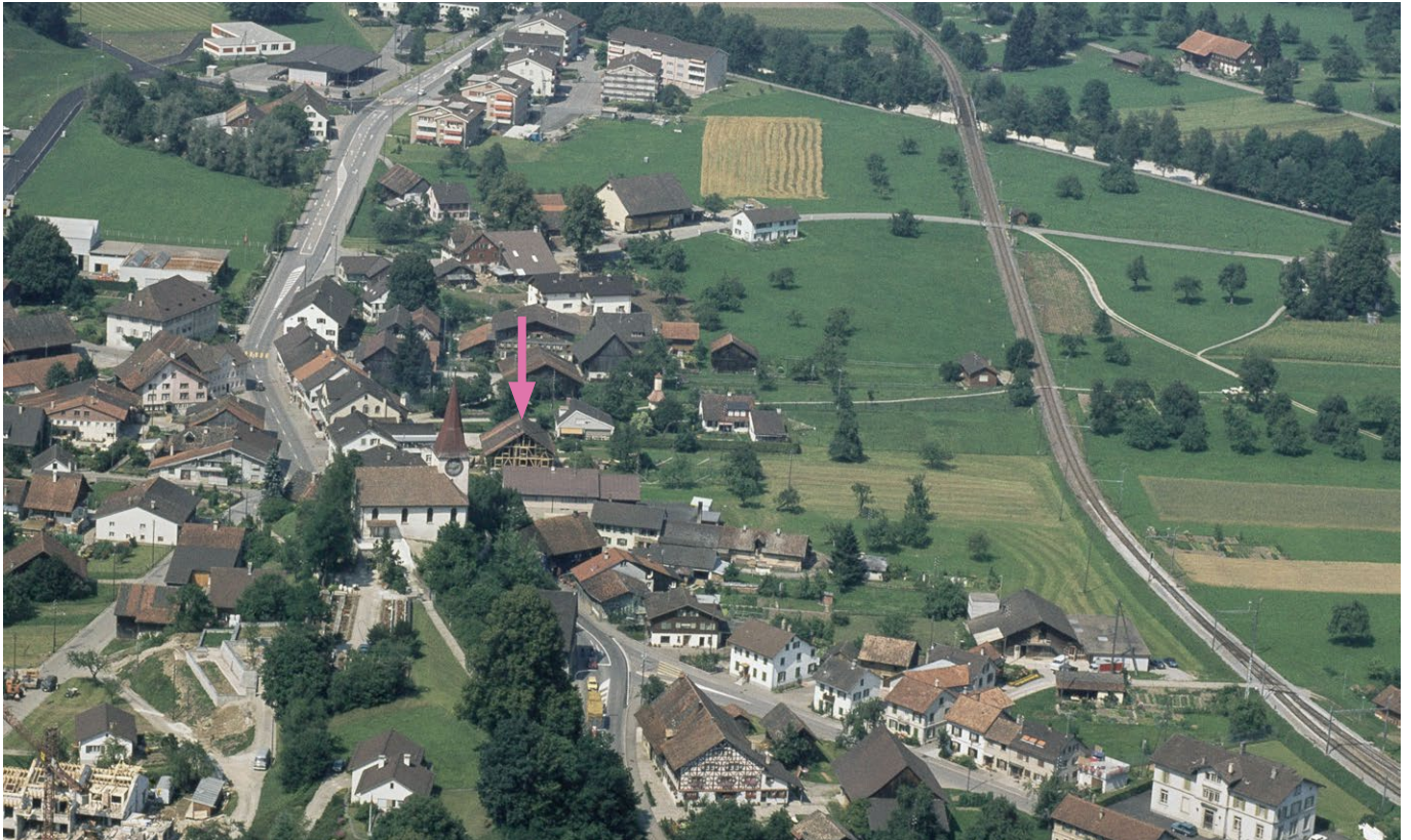
23 Wila: Ausschnitt einer Schrägaufnahme aus der Luft. Hinter der Kirche sieht man das Haus Wila mit der bereits ausgekleideten Giebfassade. Blick nach Norden. Aufnahme 1979.
