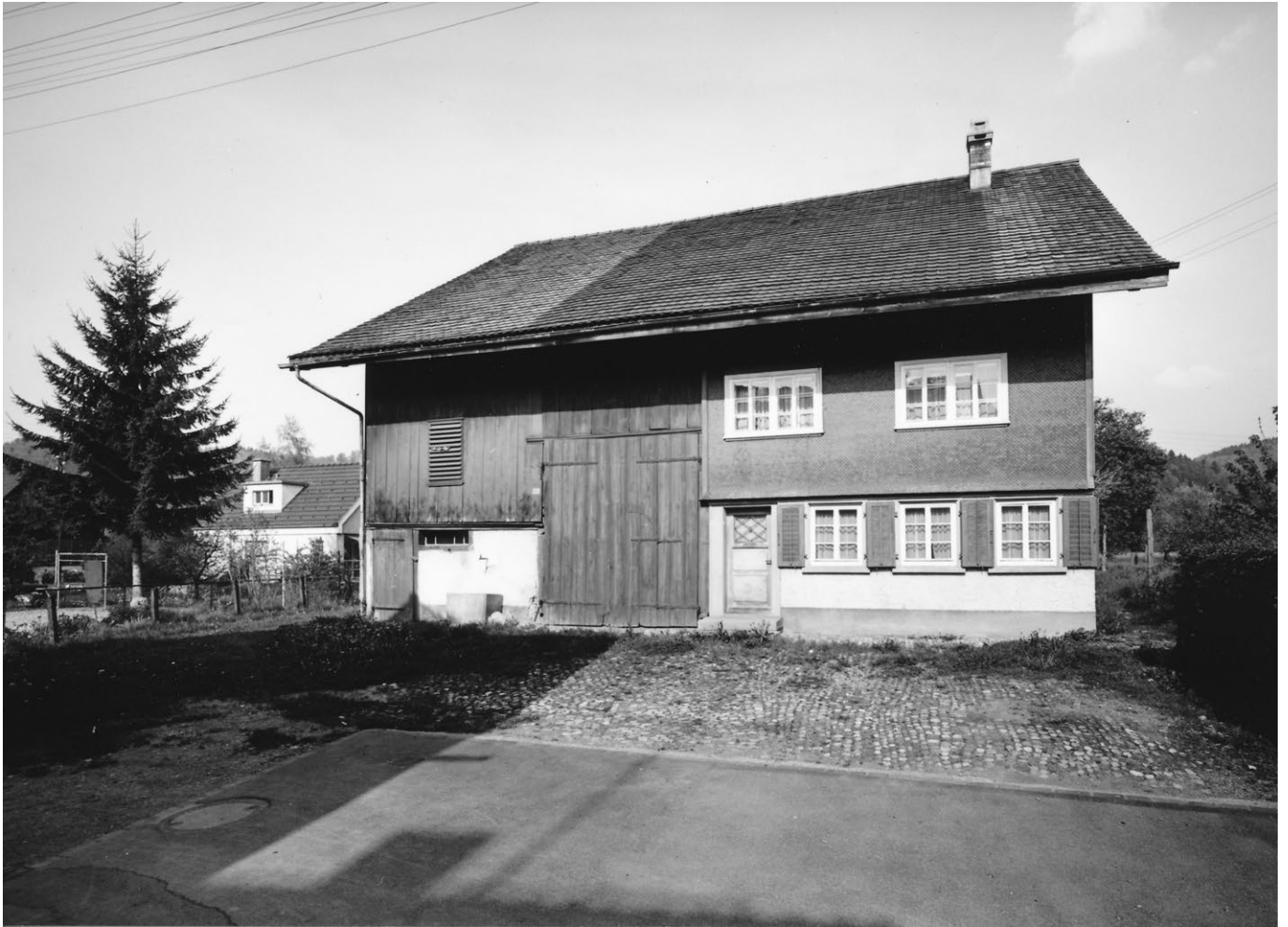
7 Wila, Huswies: Fotografie des Hauses vor Beginn der Rückbauarbeiten. Blick nach Osten. Aufnahme 1979.
