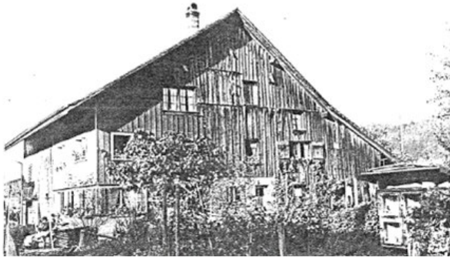
12 Wila, Huswies: Historische Aufnahme vor dem Umbau der Westfassade. Blick nach Norden. Aufnahme vor 1960.
