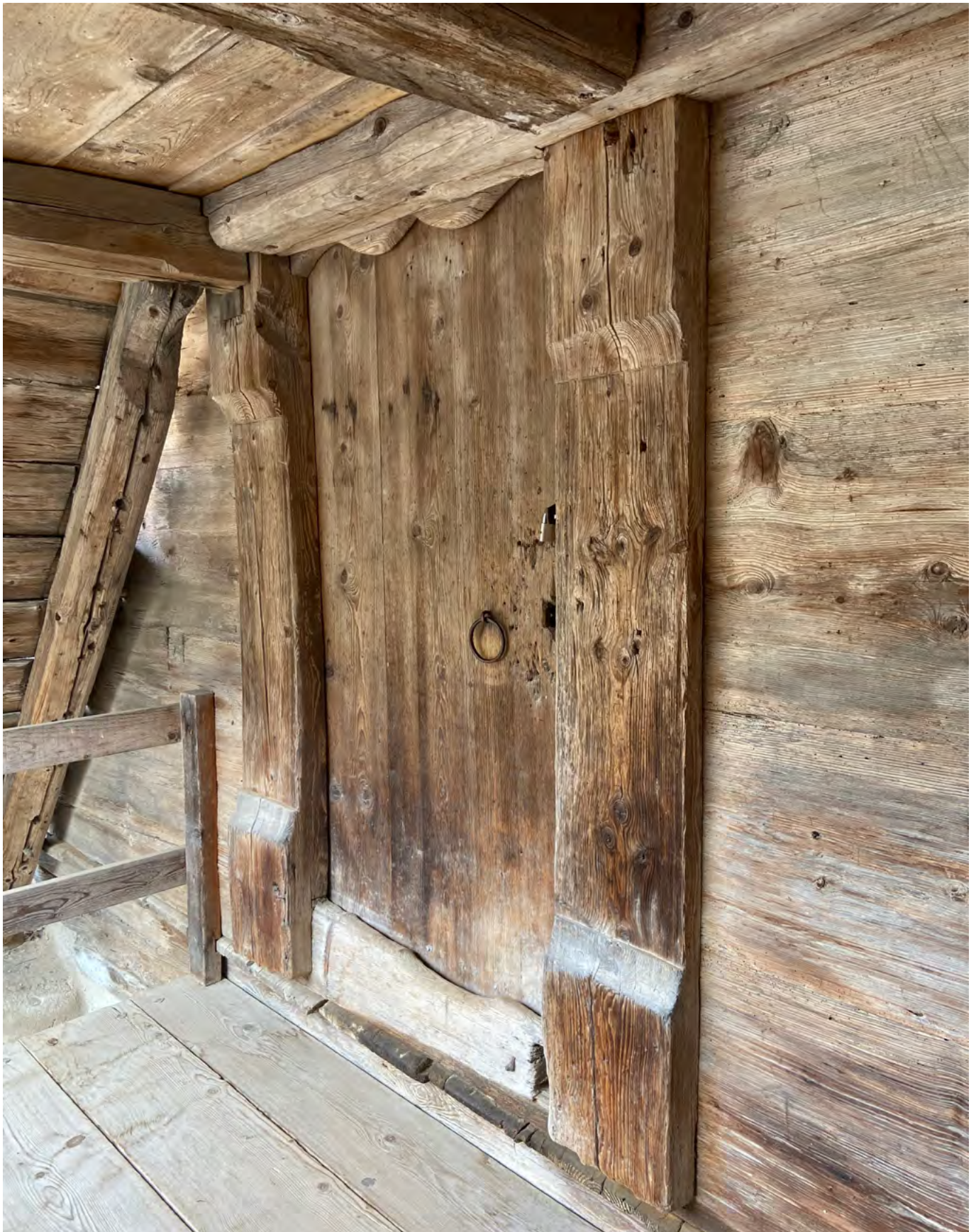
21 Freilichtmuseum der Schweiz, Speicher aus Tagelswangen: Wiederhergestellte Tür mit profilierten Türpfosten und kielbogenförmigem Sturz des ältesten Speicherschosses der Zeit um 1534. Blick nach Nordwesten. Aufnahme 2023.
