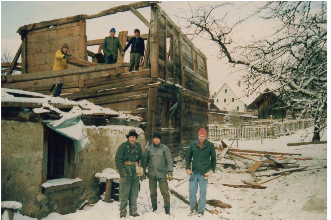
14 Tagelswangen, Huebstrasse: Rückseite der Speicherzeile während der Rückbauarbeiten. Aufnahme im Winter 1986/87.
