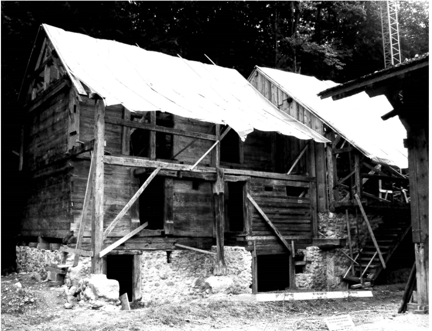
17 Freilichtmuseum der Schweiz, Speicherzeile aus Tagelswangen: Wiederaufbau der Speicherbauten im Museum. Blick nach Nordosten. Aufnahme 1988.
