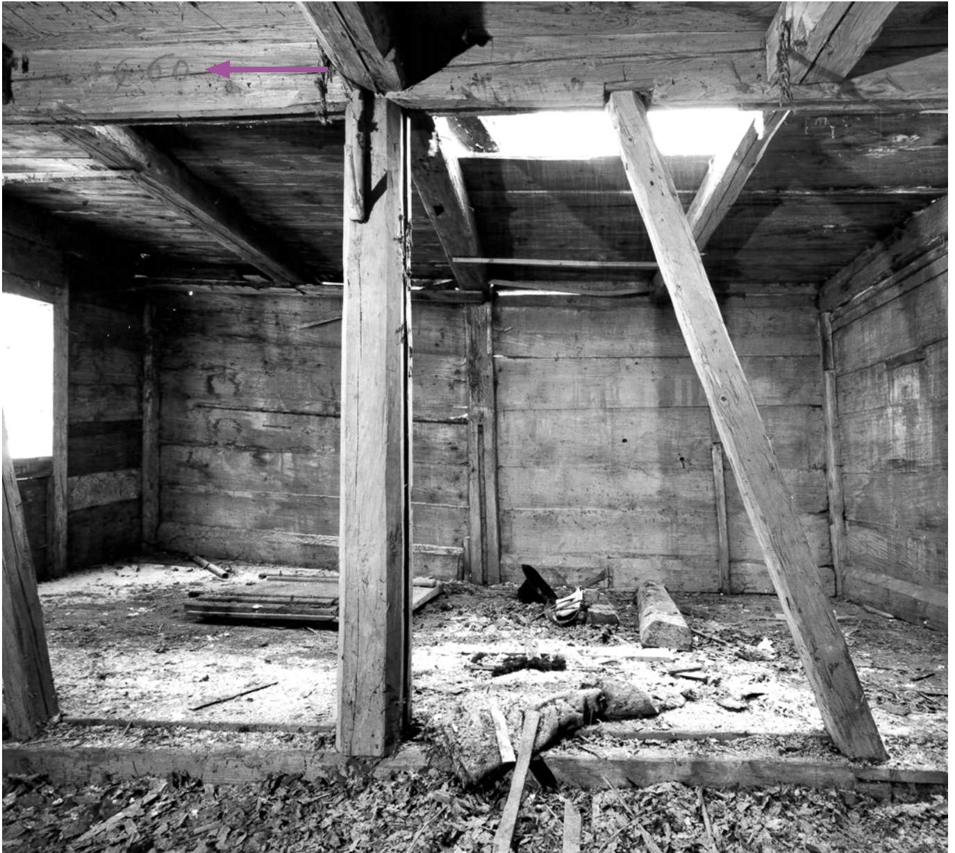
12 Tagelswangen, Huebstrasse: Innenaufnahme zum ersten Obergeschoss der Speicherzeile der Zeit um 1660/61. Diese jüngeren Bauteile wurden als Bohlen-Ständerbau errichtet. Blick nach Südwesten. Die mit einem Pfeil markierte Jahreszahl am Deckenbalken zeigt das Datum 1660, das gut mit der dendrochronologisch ermittelten Erweiterungsphase des Speichergebäudes übereinstimmt. Aufnahme während des Rückbaus 1986.
