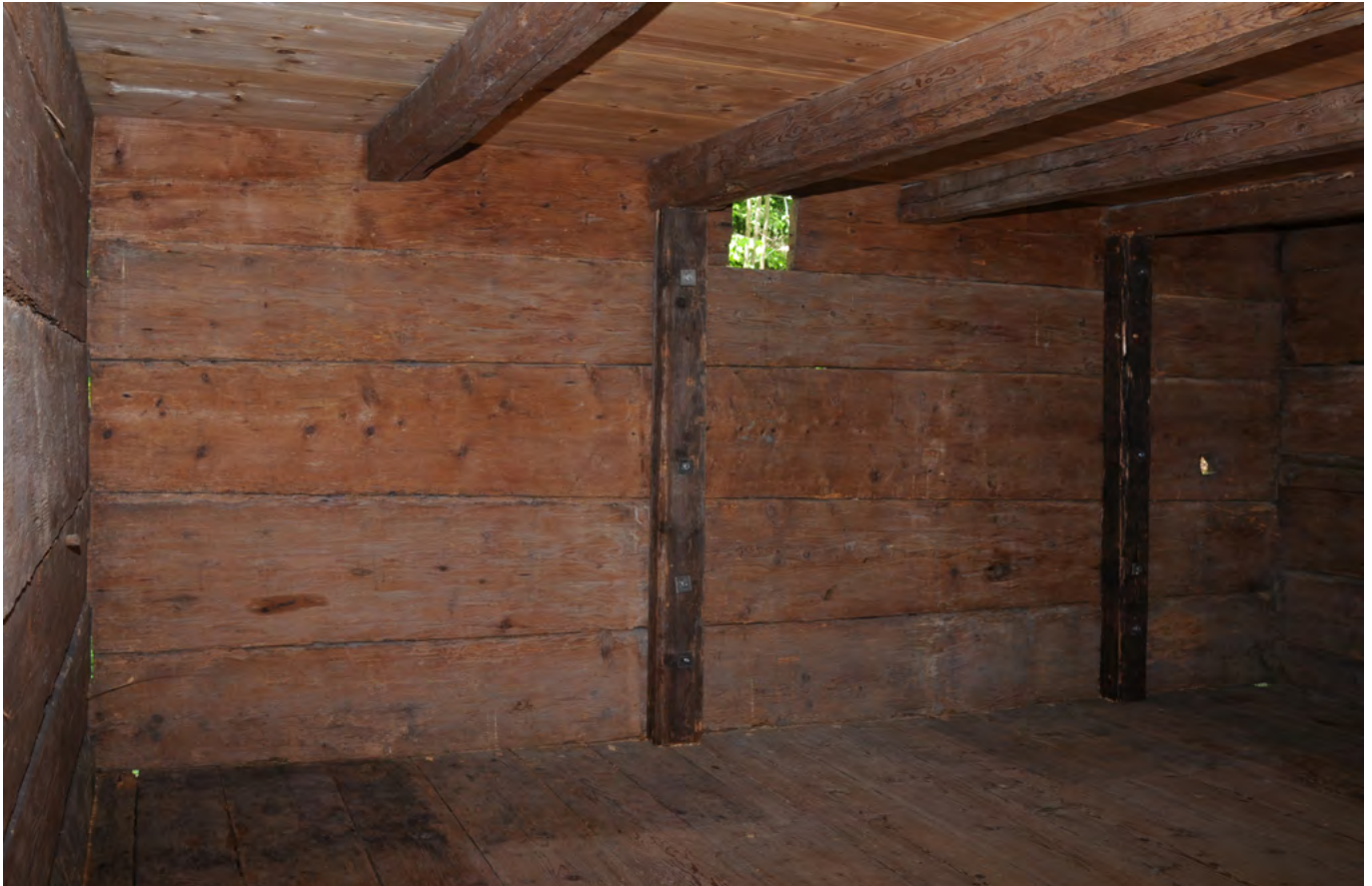
20 Freilichtmuseum der Schweiz, Speicher aus Tagelswangen: Blick in das Innere des ältesten Holzbauteils der Speicherzeile der Zeit um 1534. Die fragilen Blockbohlenwände wurden zur Sicherung mit Ständern an der Wand nachgerüstet. Blick nach Norden. Aufnahme 2022.
