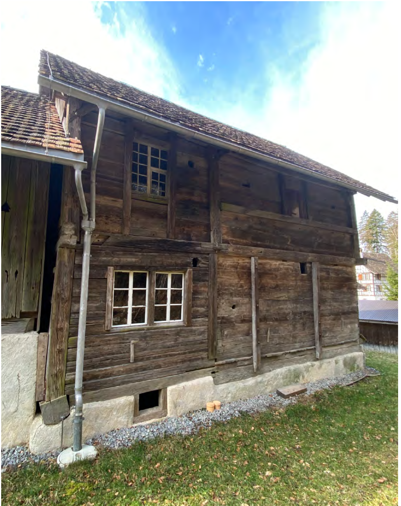
19 Freilichtmuseum der Schweiz, Speicher aus Tagelswangen: Rückseite des westlichen älteren Gebäudeteils. Gut zeichnet sich das älteste Speichergeschoss des Blockbohlenbaus rechts unten ab. Blick nach Südwesten. Aufnahme 2023.
