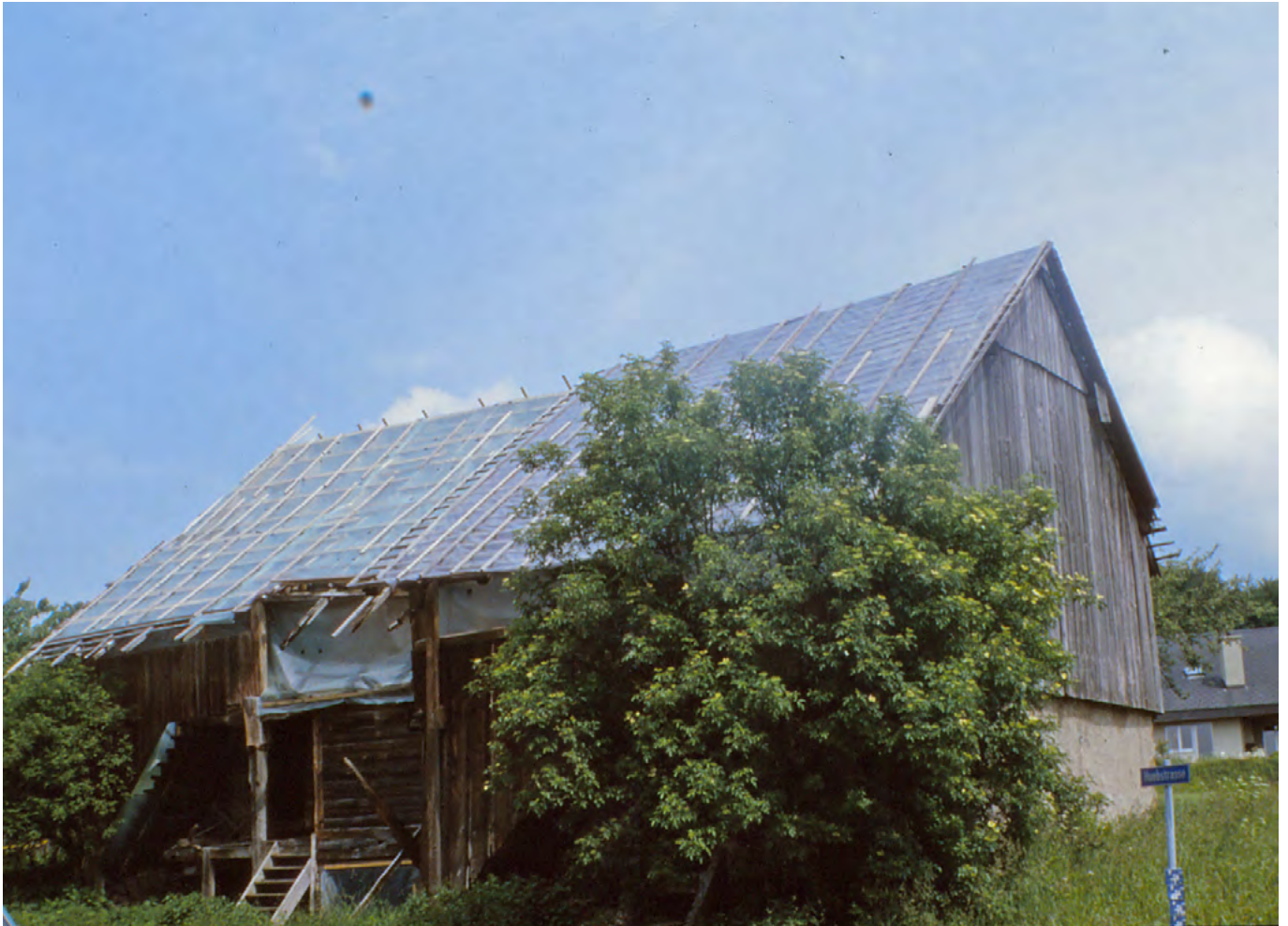
11 Tagelswangen Huebstrasse: Zustand der Speicherzeile vor dem Abbau im Juni 1986. Die Dachdeckung ist bereits entfernt und das Haus behelfsmässig mit einer Plane abgedeckt. Blick nach Osten. Aufnahme 1986.
