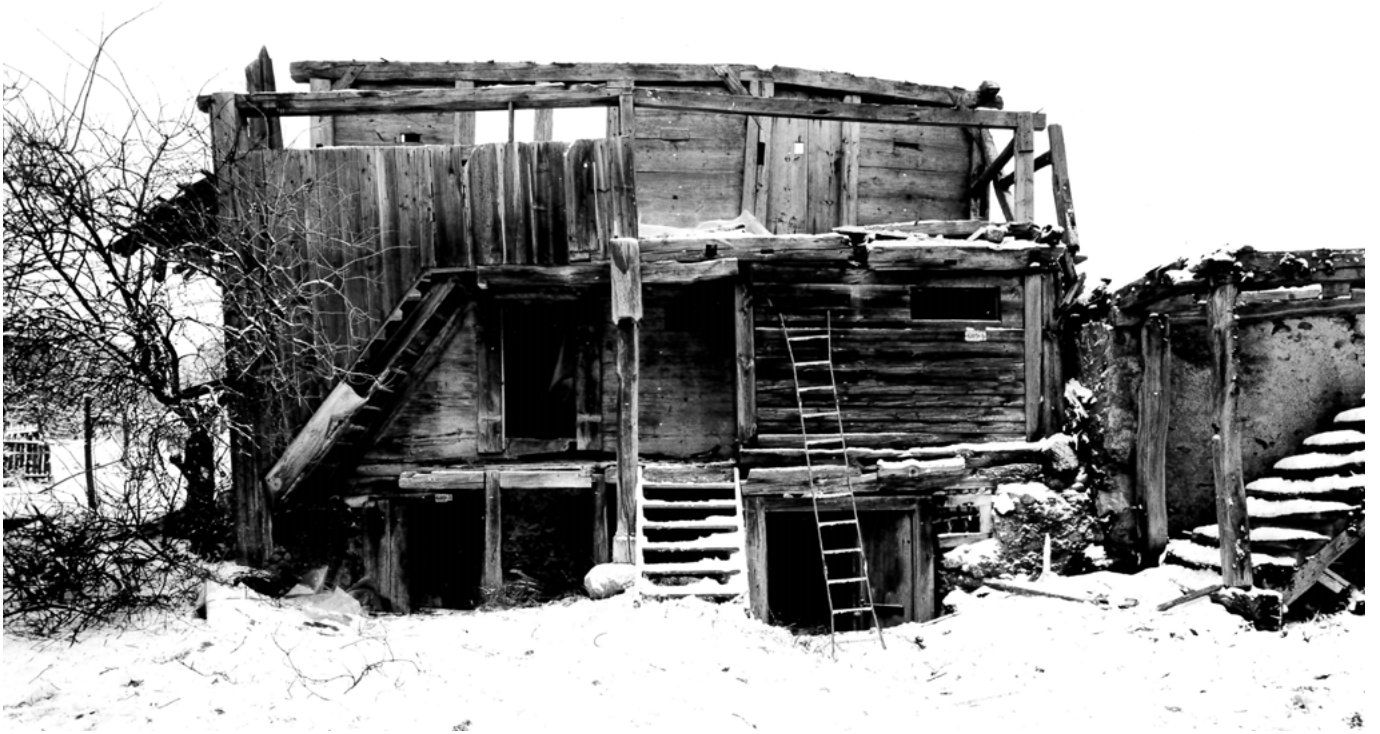
13 Tagelswangen, Huebstrasse: Die Zugangs- und Strassenseite des östlichen Teils der Speicherzeile mit den ältesten Bauteilen beim Abbau. Aufnahme im Winter 1986/87.
