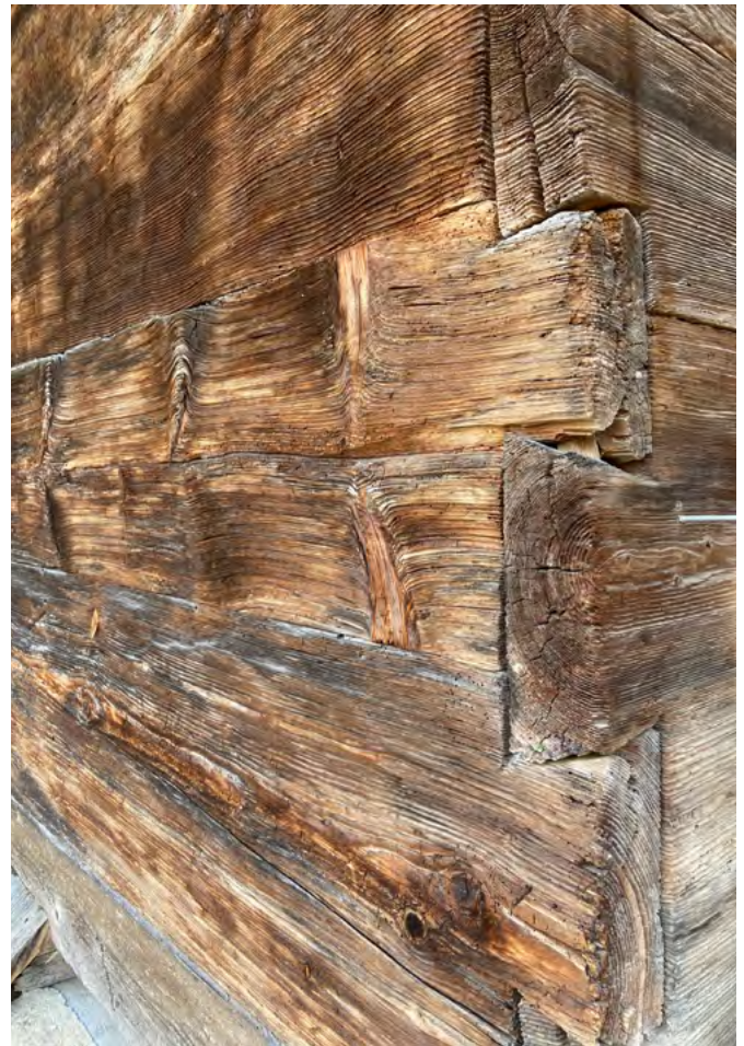
6 Freilichtmuseum der Schweiz, Speicherzeile aus Tagelswangen: Nordwestlicher Eckverband des Blockbohlenbaus des älteren Speichers von um 1534. Gut zu sehen ist die sorgfältige schwalbenschwanzförmige Verzinkung und auf den zweiten Blick auch die Fixierung der Bohlen mit einem Holzdübel. Aufnahme 2023.
