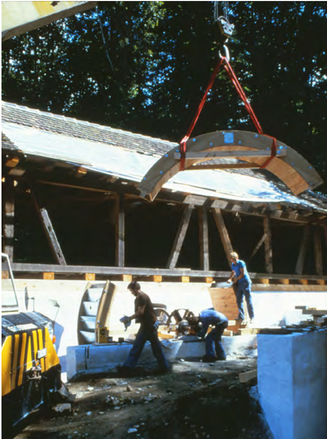
16 Freilichtmuseum der Schweiz, Sägemühle aus Rafz: Das neu hergestellte Wasserrad für die Säge wird geliefert und montiert. Im Hintergrund ist die neue Ständerkonstruktion der Südwand zu sehen. Blick nach Norden. Aufnahme 1986.
