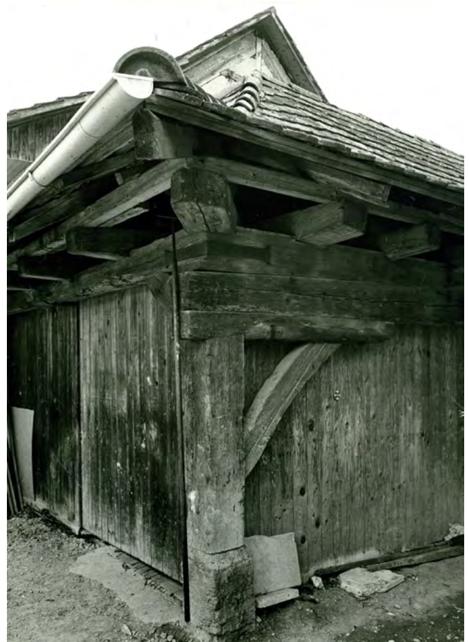
12 Rafz, Untere Mühle: Die Nordostecke der Sägerei. Der obere Balken des nordseitigen Rähms traf auf Gehrung geschnitten auf den Rähm der Ostseite. Sie waren über ein handgeschmiedetes Winkeleisen miteinander verbunden. Die Brettverschalung der Ost- und Nordwand war eine jüngere Zutat. Blick nach Südwesten. Aufnahme ca. 1976.
