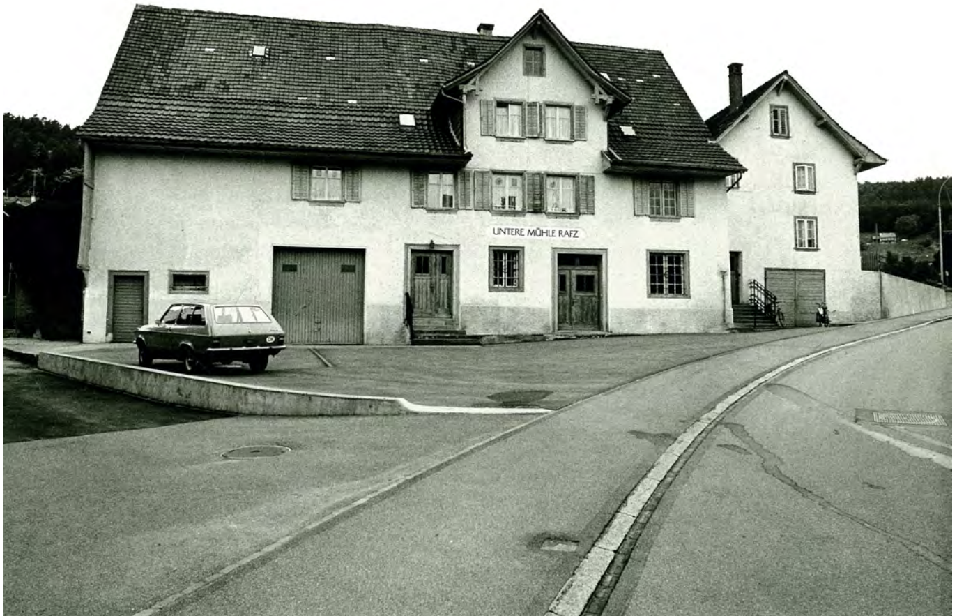
5 Rafz, Untere Mühle: 1841 liess Johannes Neukom in Rafz die Untere Mühle erbauen. Wenig später kam der östliche Anbau, hier auf der rechten Bildseite, hinzu. Im Mühlengebäude waren in den oberen Stockwerken zudem Wohnräume und auf der westlichen Seite, auf dem Bild links, der Ökonometeil untergebracht. Die Sägemühle befand sich ab 1845 auf der Rückseite des Gebäudes. Blick nach Norden. Aufnahme ca. 1976.
