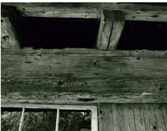
11 Rafz, Untere Mühle: Der Rähm des Sägebauwerkes bestand auf der Nordseite aus zwei übereinandergelegten Balken. Mittels präzise gefertigten Sägezahnausschnitten griffen sie ineinander. So wurde ein Verschieben der Balken zueinander verhindert. Blick nach Süden. Aufnahme ca. 1976.
