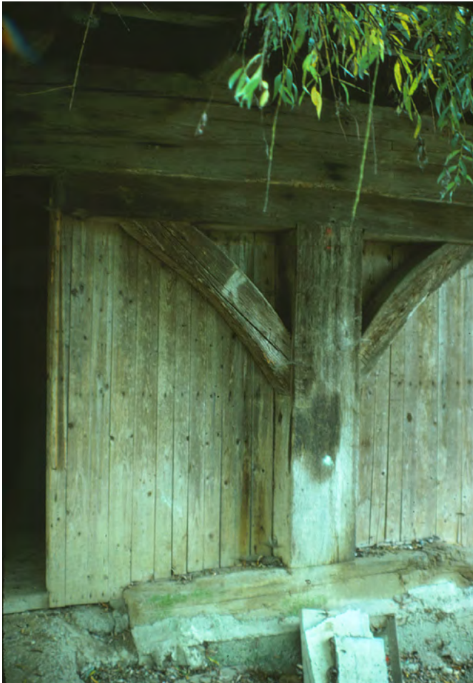
10 Rafz, Untere Mühle: Der mittlere Ständer auf der Nordseite der Sägemühle. Die Konstruktion beeindruckte aufgrund ihrer Dimensionen. Der grosse Eichenständer sass auf einem ausladenden Fussholz. Die Last des gewaltigen Rähms wurde zusätzlich über ein Sattelholz und Kopfstreben in den Ständer abgeleitet. Blick nach Süden. Aufnahme 1976.
