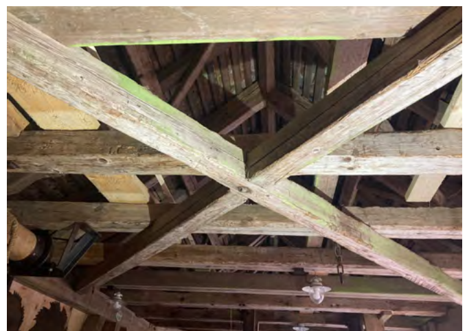
13 Freilichtmuseum der Schweiz, Sägemühle aus Rafz: Zwei in die Wandrähme eingezapfte Andreaskreuzen unterfangen die Zugbalken des Sparrendaches. Möglicherweise wurde der Dachraum über der Säge als Lager für das Schnittholz genutzt. Dies würde die massive und auf hohe Lasten ausgelegte Konstruktion der Wandkonstruktion erklären. Blick nach Westen. Aufnahme 2022.
