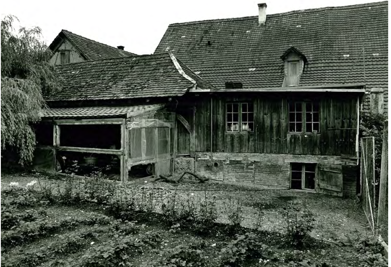
8 Rafz, Untere Mühle: Nach Aufgabe des Sägebetriebs wurde auf der Nordseite der Sägemühle ein Schopfanbau angefügt. Auf der Aufnahme ist vom Sägegebäude daher nur das geknickte Dach zu erkennen. Der Anbau rechts davon kam hinzu, als die Säge noch genutzt wurde. Unklar ist, inwiefern er mit der Sägerei in Zusammenhang stand. Blick nach Süden. Aufnahme ca. 1976.
