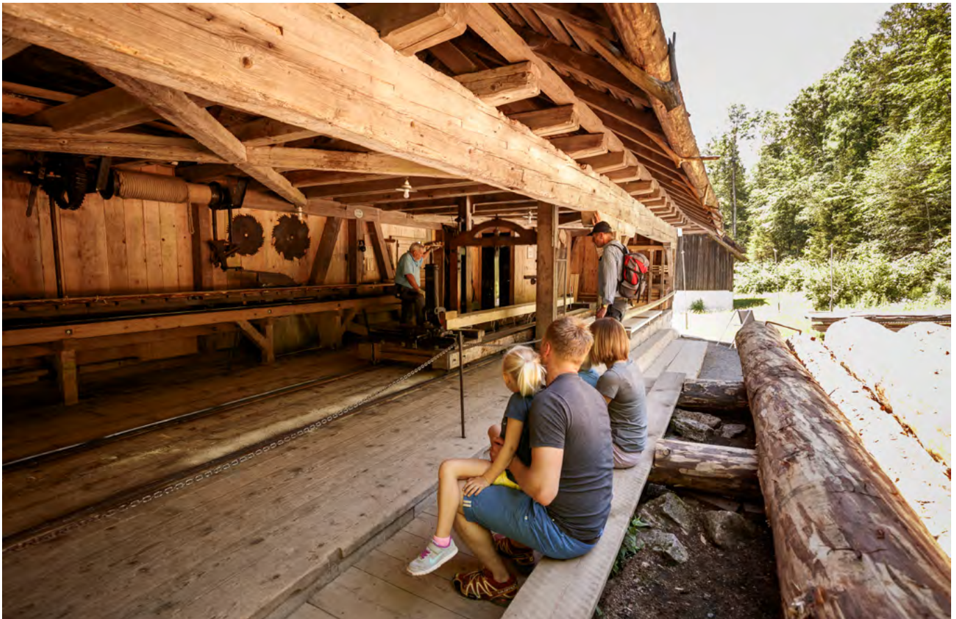
15 Freilichtmuseum der Schweiz, Sägemühle aus Rafz: Während die frühere nördliche Wandkonstruktion weitestgehend übernommen werden konnte, musste die Ständerkonstruktion der Südwand im Freilichtmuseum völlig neu hergestellt werden. An den Hölzern der Dachkonstruktion bedurfte es nur wenig Holzaustausch. Blick nach Westen. Aufnahme 2017.
