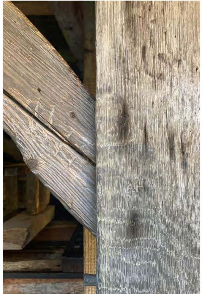
9 Freilichtmuseum der Schweiz, Sägemühle aus Rafz: Am mittleren Ständer der früheren Nordseite hat sich möglicherweise der frühere Besitzer der Unteren Mühle, Adolf Hess, mit seinen Initialen verewigt. Die Abbundzeichen an den Kopfbändern deuten auf eine Herstellung der Holzkonstruktion in der Zimmerer-Werkstatt und nicht am späteren Standort hin. Blick nach Süden. Aufnahme 2022.
