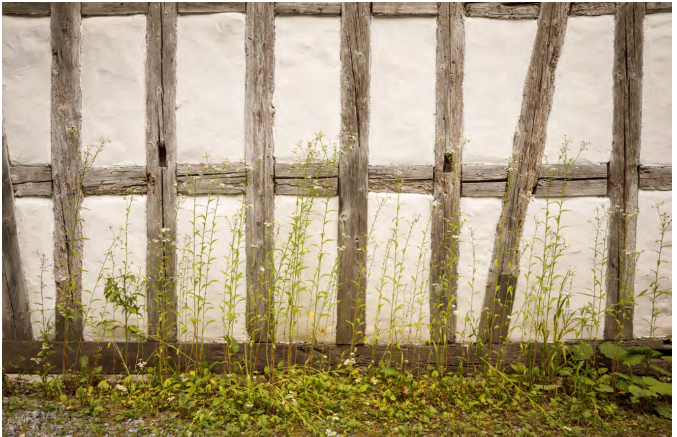
10 Freilichtmuseum der Schweiz, Knochenstampfe aus Knonau: Das Fachwerk ist auffallend zurückhaltend gestaltet. Streben wurden sparsam eingesetzt, die hohen Stützen betonen die Vertikale. Dieses Fachwerkbild ist typisch für das Knonaueramt im 19. Jahrhundert. Blick nach Norden. Aufnahme 2017.
