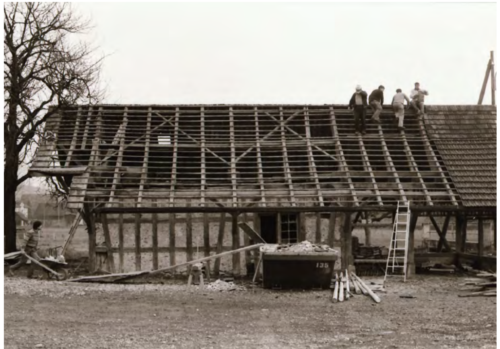
14 Knonau, Stampfstrasse: Die Knochenstampfe wurde mitsamt Anbau 1984 abgebaut. Den Erweiterungsbau hat man im Freilichtmuseum jedoch nicht wieder aufgebaut. Blick nach Südosten. Aufnahme 1984.
