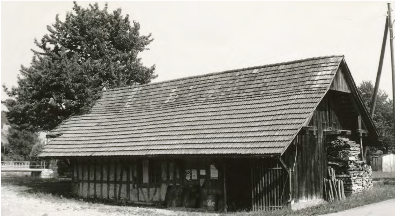
7 Knonau, Stampfstrasse: In der ersten Hälfte des 20. Jahrhunderts wurde die Knochenstampfe nach Südwesten um einen hölzernen Anbau erweitert. Vermutlich zur selben Zeit verlängerte man die Dachflächen auf der Nordost- und Nordwestseite des Gebäudes. Aufnahme undatiert.
