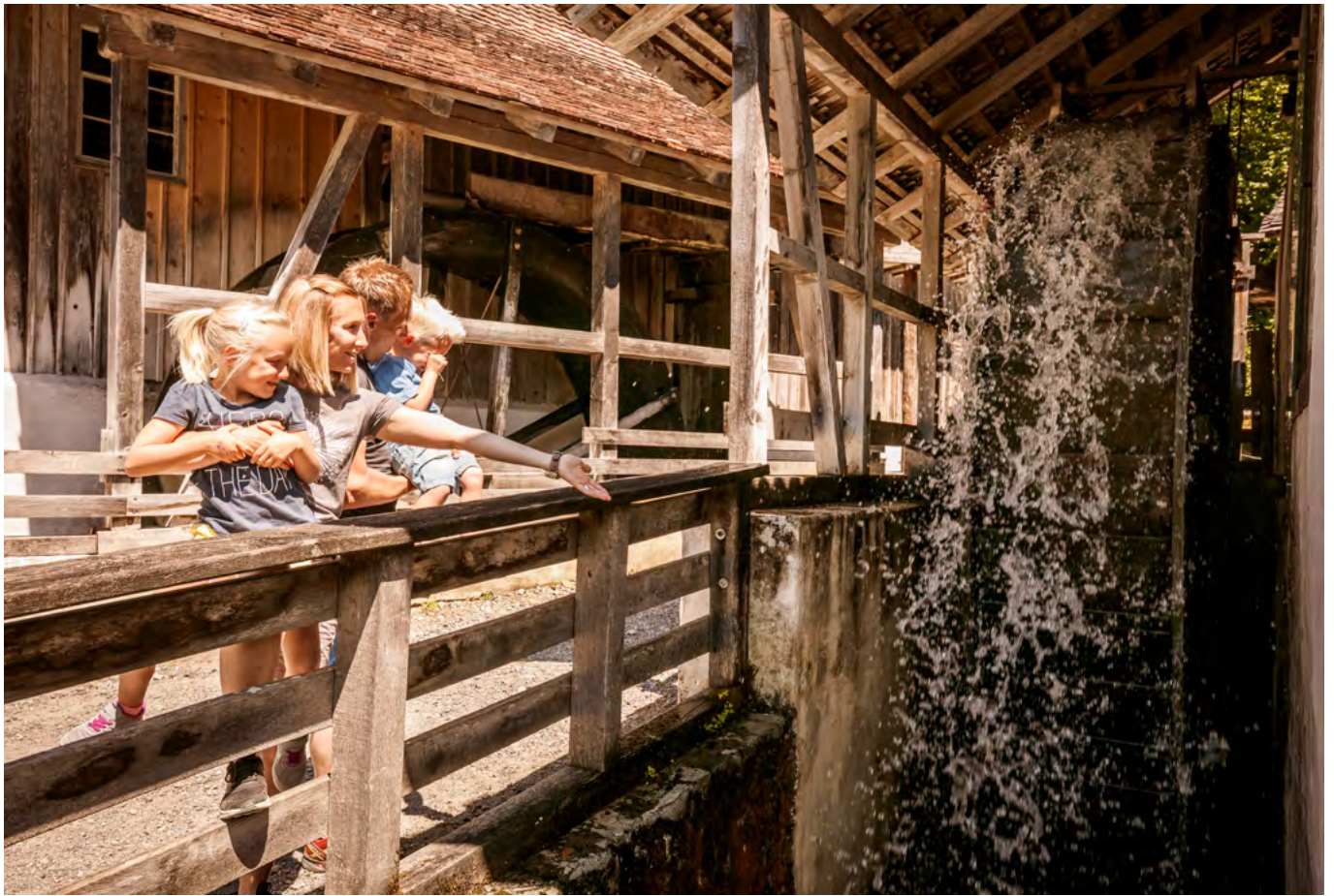
19 Freilichtmuseum der Schweiz, Knochenstampfe aus Knonau: Die Knochenstampfe fasziniert mit ihrem rekonstruierten Wasserrad auch von aussen. Zum Schutz der Anlage vor der Witterung wurde die nördliche Dachfläche im Freilichtmuseum mit einem Schleppdach verlängert. Im Hintergrund ist die Sägemühle aus Rafz ZH zu sehen. Blick nach Osten. Aufnahme 2017.
