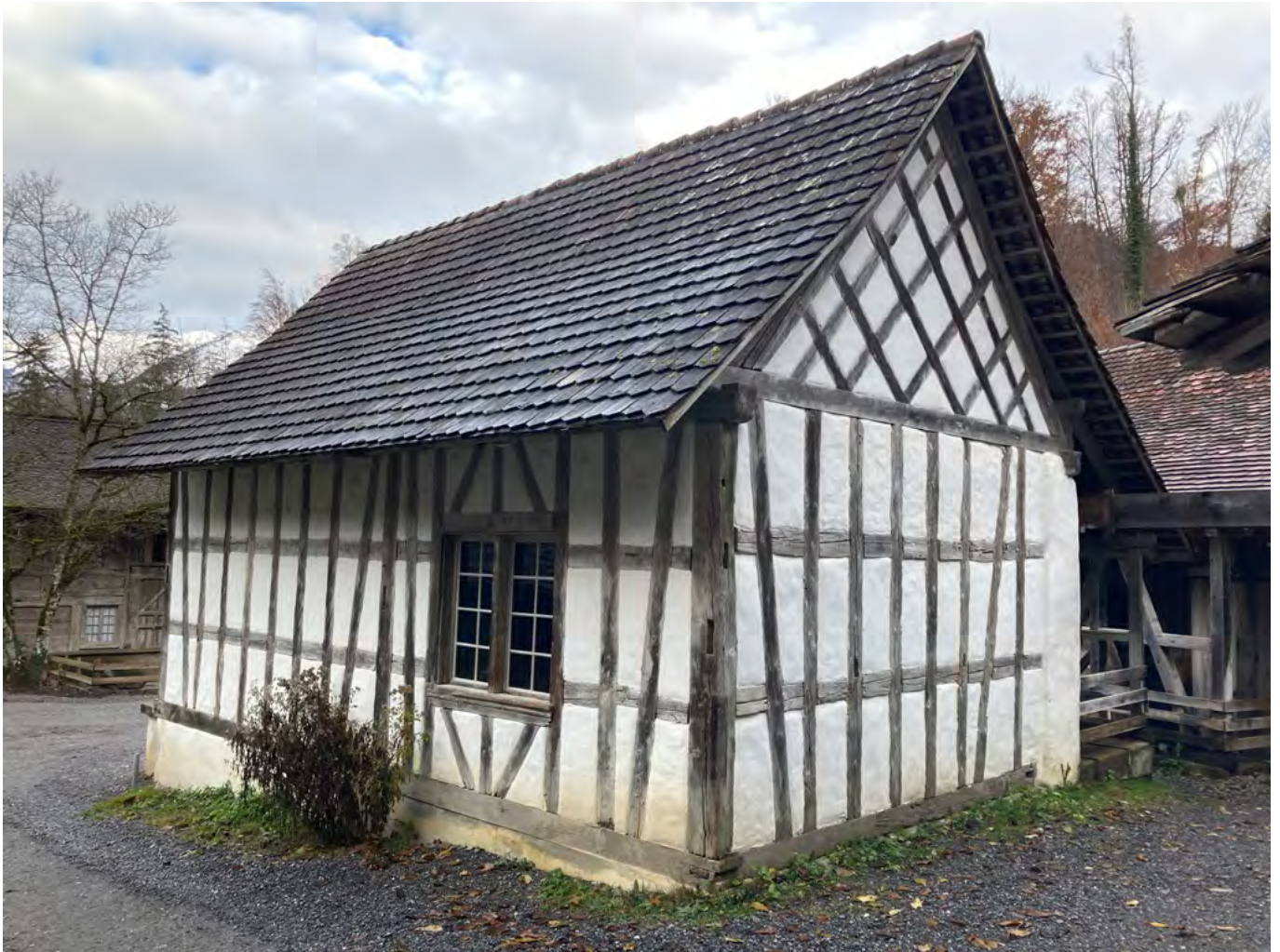
17 Freilichtmuseum der Schweiz, Knochenstampfe aus Knonau: Am ehemaligen Standort fehlte an der südlichen Seite das Giebelfachwerk. Auf dem Ballenberg wurde es in Anlehnung an die historische Giebelseite rekonstruiert. Blick nach Nordwesten. Aufnahme 2022.
