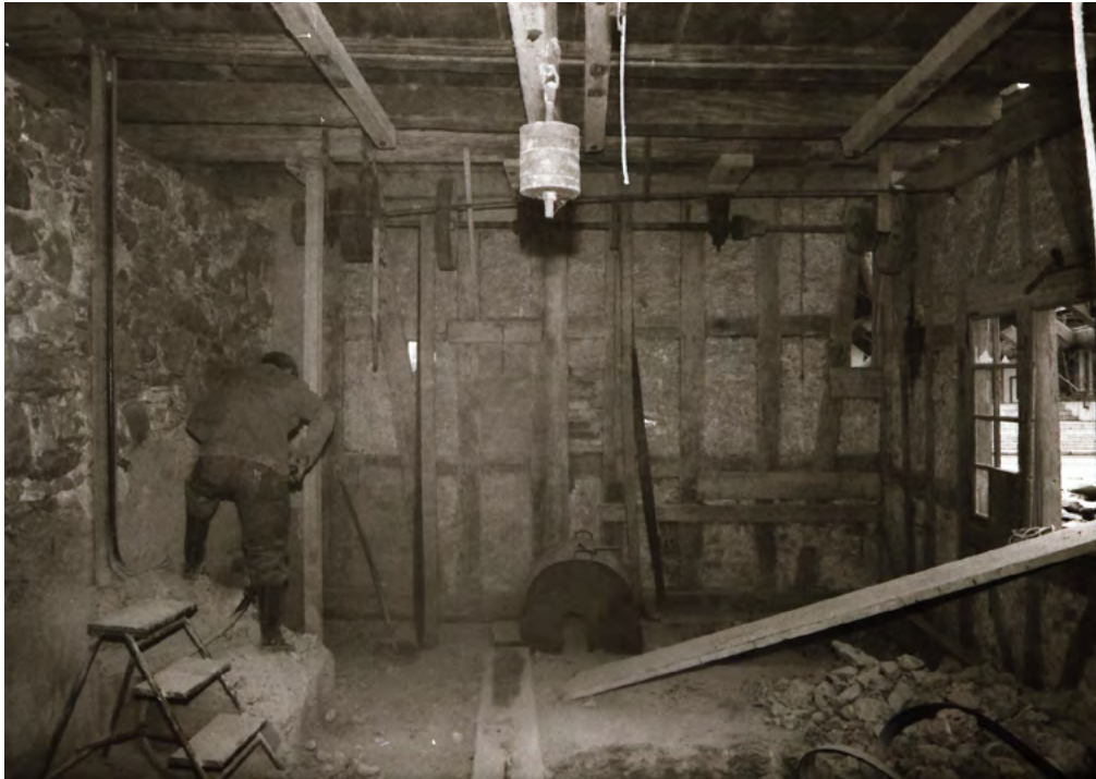
13 Knonau, Stampfstrasse: Der Innenraum der Knochenstampe. Die historische Stampfeinrichtung fehlte bereits beim Abbau des Gebäudes. Auch die später hinzugekommene technische Einrichtung war nur noch fragmentarisch erhalten. Darunter Transmissionswellen und die Reste des Elektromotors. Blick nach Südwesten. Aufnahme 1984.
