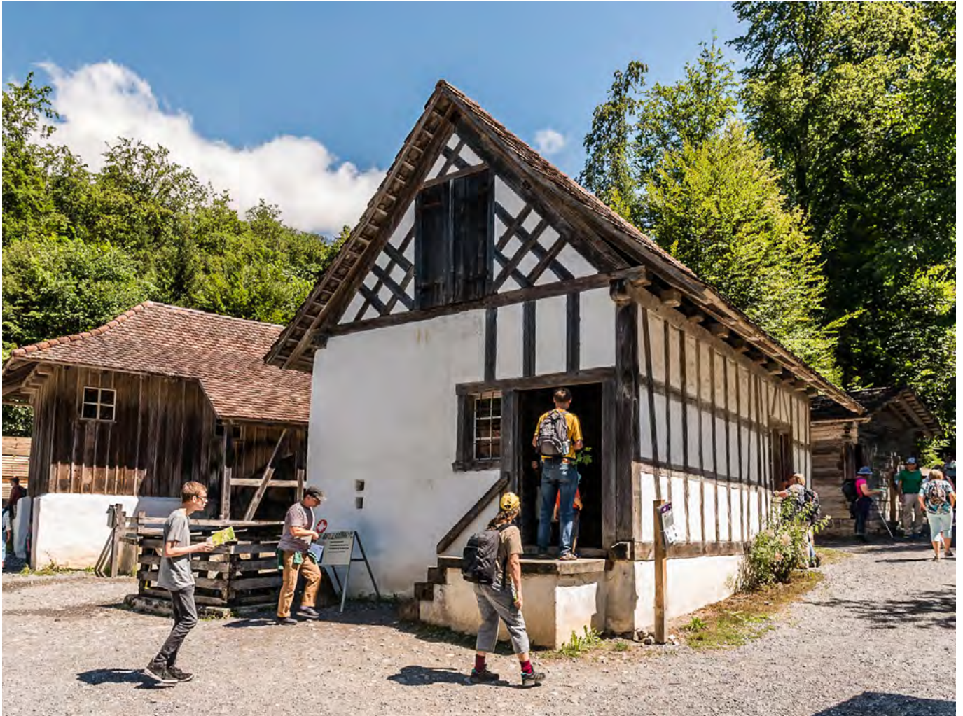
16 Freilichtmuseum der Schweiz, Knochenstampfe aus Knonau: Um das Gefälle im Gelände auszugleichen, wurde der Museumsbau auf einen Sockel gesetzt. Die Stampfe ist über einen Sandsteintritt erschlossen. Die Dachenerweiterungen aus dem 20. Jahrhundert wurde nicht übernommen. Das Dach präsentiert sich nun weitestgehend in seinem ursprünglichen Zustand. Blick nach Nordosten. Aufnahme 2020.
