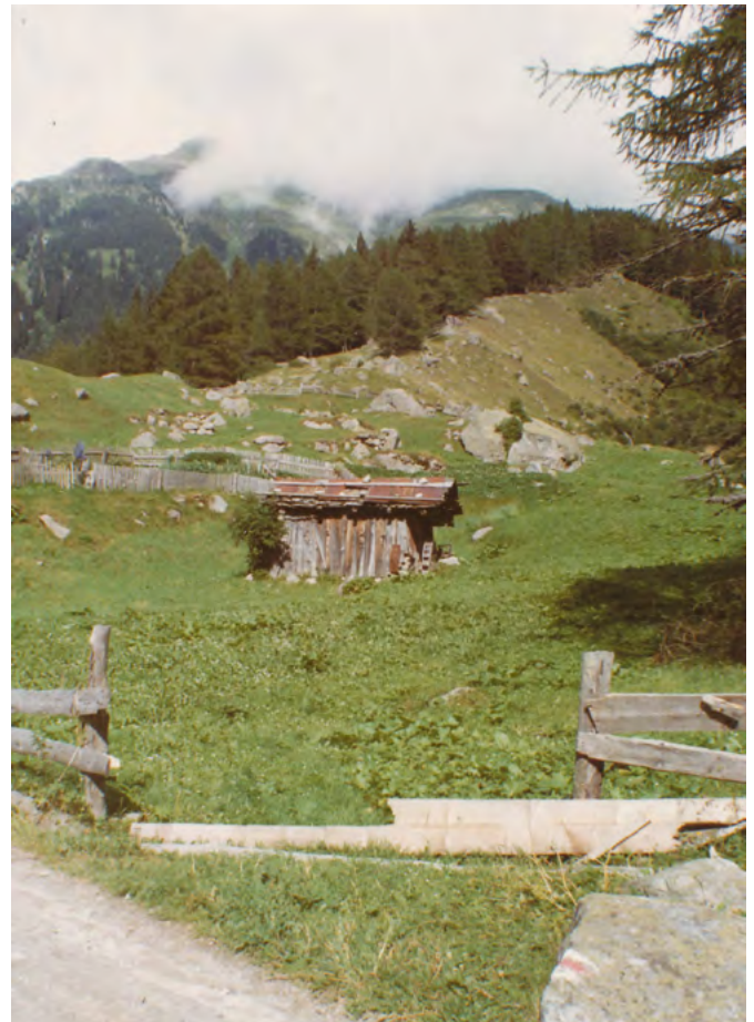
6 Medel, Fuorns: Die frühere Getreidemühle und spätere Stampfe befand sich nicht direkt am Bergbach, sondern etwas abgerückt ausserhalb der Gefahrenzone von Lawinen und Überschwemmungen. Dafür musste die Wasserversorgung umständlich in Holzkänneln über die Wiese geführt werden. Blick etwa nach Osten. Aufnahme ca. 1978.
