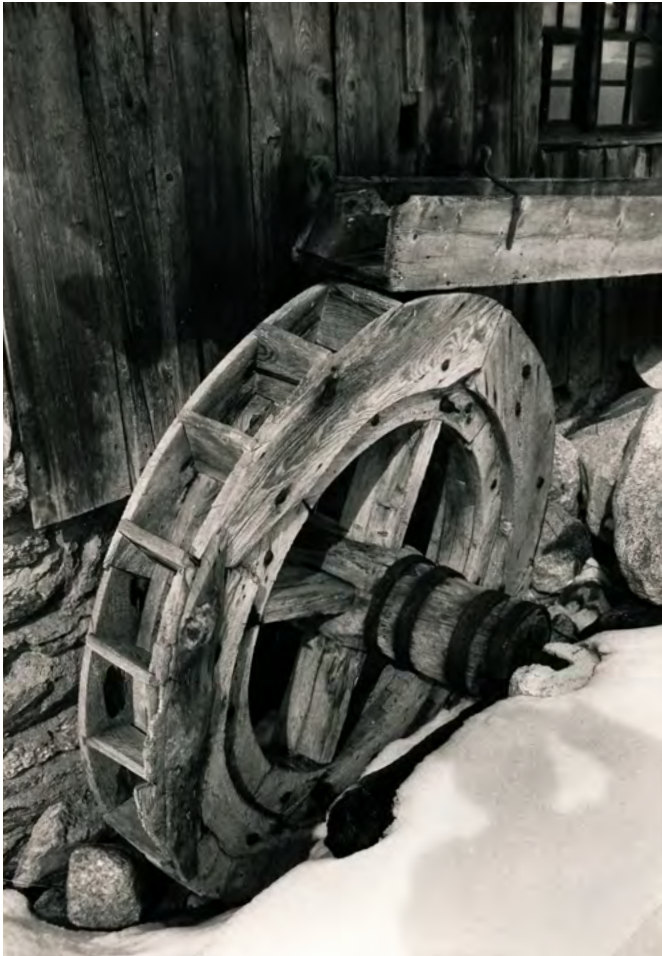
13 Medel, Fuorns: Das ober-schlächtig betriebene Wasserrad der Leinsamen- und Flachsstampe auf der ungefähren Südseite des Gebäudes. Aufnahme ca. 1978.
