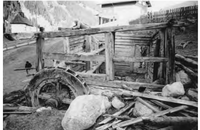
10 Medel, Fuorns: Während des Abbaus offenbarte sich auch von aussen ein Blick auf die Wandkonstruktionen der Stampfe. Die Südwand war früher einmal wohl bis auf das Giebfeld gemauert. Blick etwa nach Norden. Aufnahme 1978.
