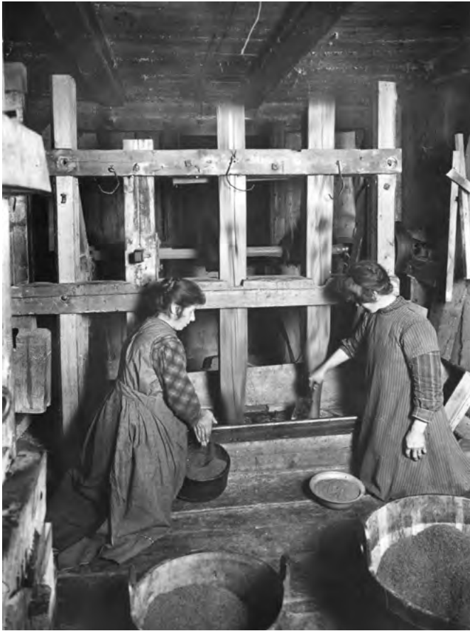
7 Disentis, Cuoz: Die Leinsamen wurden in der wasserradbetriebenen Stampfe zunächst zu Mehl und in einem zweiten Schritt mit Wasser vermischt zu einer Paste verarbeitet, welche anschliessend geröstet und gepresst wurde. Solche Stampfen waren überall in der Surselva verbreitet und dienten häufig auch der Herstellung von Rollgerste. Aufnahme ca. 1917.
