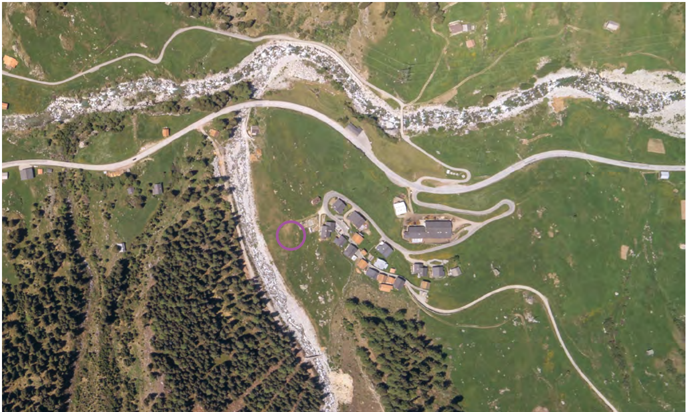
5 Medel, Fuorns: Südlich des Weilers befand sich bis 1978 die Leinsamen- und Flachsstampfe. Ihr früherer Standort ist eingekreist. Das Gebäude wurde ursprünglich als Getreidemühle genutzt und erst um 1930 zur Stampfe umgebaut. Aufnahme 1997.
