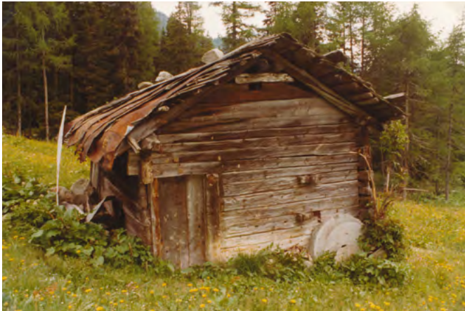
9 Medel, Fuorns: Die ungefähre Nordseite der Stampfe mit Eingang. Bei dieser Wand handelt es sich vermutlich um die einzige Gebäudeseite, die sich noch überwiegend im ursprünglichen Zustand befindet. Teile der Seitenwände sowie die Südseite mit dem Wasserrad bestanden zuletzt aus einem Mauersockel mit darüberliegendem Ständerwerk. Blick etwa nach Süden. Aufnahme ca. 1978.
