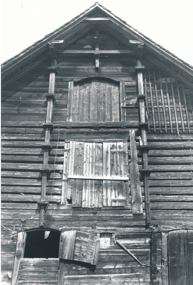
12 Sachseln, Stallscheune Haltenmatte: Die aus den Kanthölzern herausgeschnittenen Segmentgiebel über den Wandöffnungen verliehen der Stallscheune ein vornehmes Aussehen. Die rechteckige Öffnung in der Gimmwand kam später hinzu, dabei hat man auf eine gestalterische Anpassung an den Bestand verzichtet. Blick nach Nordwesten. Aufnahme vor 1991.
