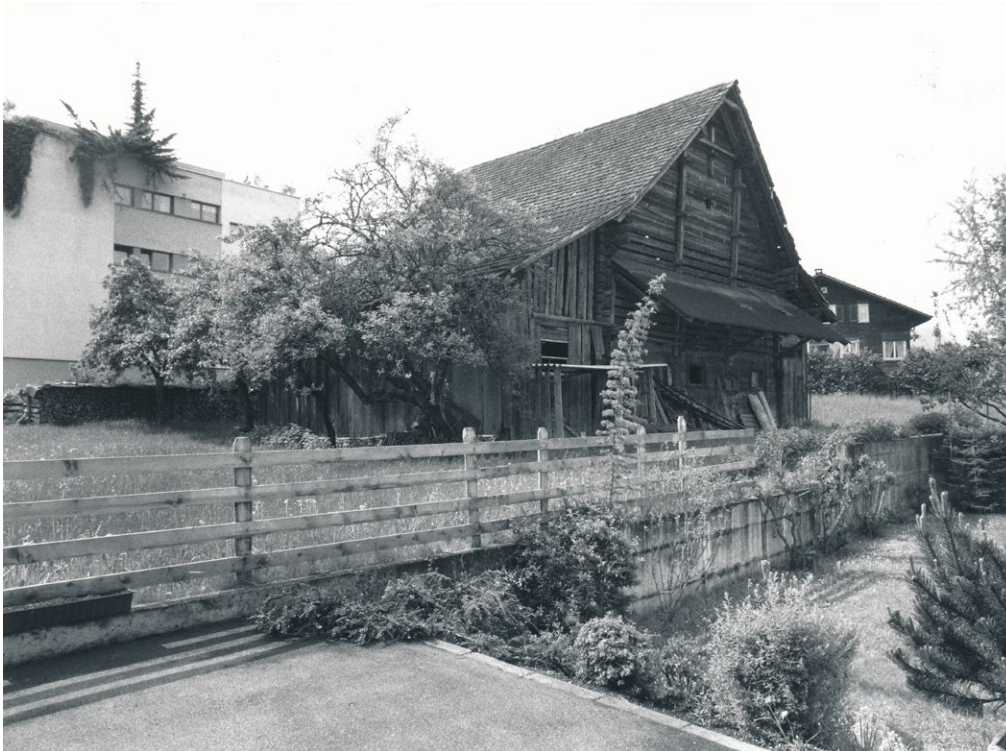
11 Sachseln, Stallscheune Haltenmatte: Die Gebäuderückseite. Die Türöffnung und die grossen Fenster wurden von der Bauforschung als spätere Zutat identifiziert. Ursprünglich war der Stall nur über die südöstliche Giebelseite zugänglich und das Licht im Inneren des Erdgeschosses nur spärlich vorhanden. Blick nach Süden. Aufnahme vor 1991.
