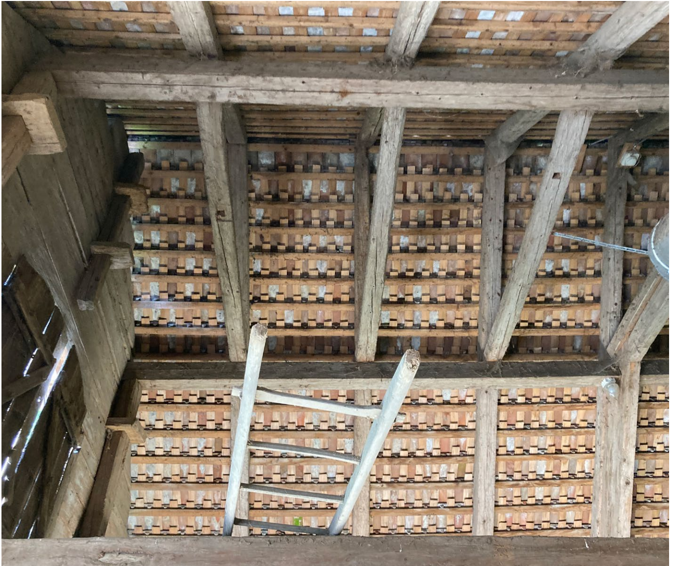
15 Freilichtmuseum der Schweiz, Stallscheune aus Sachseln: Das Pfetten-Rafen-Dach verfügt in der Gebäudemitte über einen einzelnen liegenden Stuhl. Die Rafen sind oberhalb der Zwischenpfetten über einen Kehlbalcken miteinander verbunden, dafür fehlt eine Firstpfette. Aufnahme 2022.
