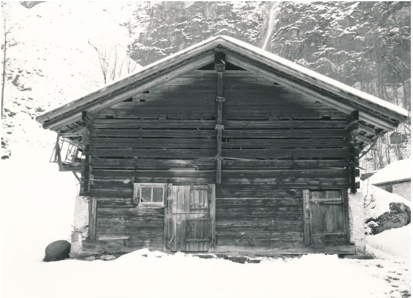
5 Lungern OW, Heustall: Stallscheunen und Heuställe fanden sich einst überall in Obwalden. Während sie, wie dieser, zunächst häufig mit schwach geneigtem Tätschdach versehen waren, ist in der ersten Hälfte des 19. Jahrhunderts ein Trend zu steilen, ziegelgedeckten Dächern zu verzeichnen. Aufnahmedatum unbekannt.
