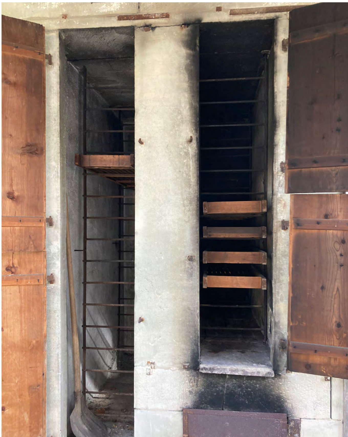
16 Freilichtmuseum der Schweiz, Dörröfen aus Alpnachstad: Die Türen für die Dörrkammern wurden gemäss Bestand rekonstruiert, ebenso die Eisenbeschläge, welche für das Museumsobjekt von Hand geschmiedet wurden. Die Eisengestelle, in welche die Hurden mit den Obstschneiden geschoben wurden, sind original. Blick nach Südwesten. Aufnahme 2022.
