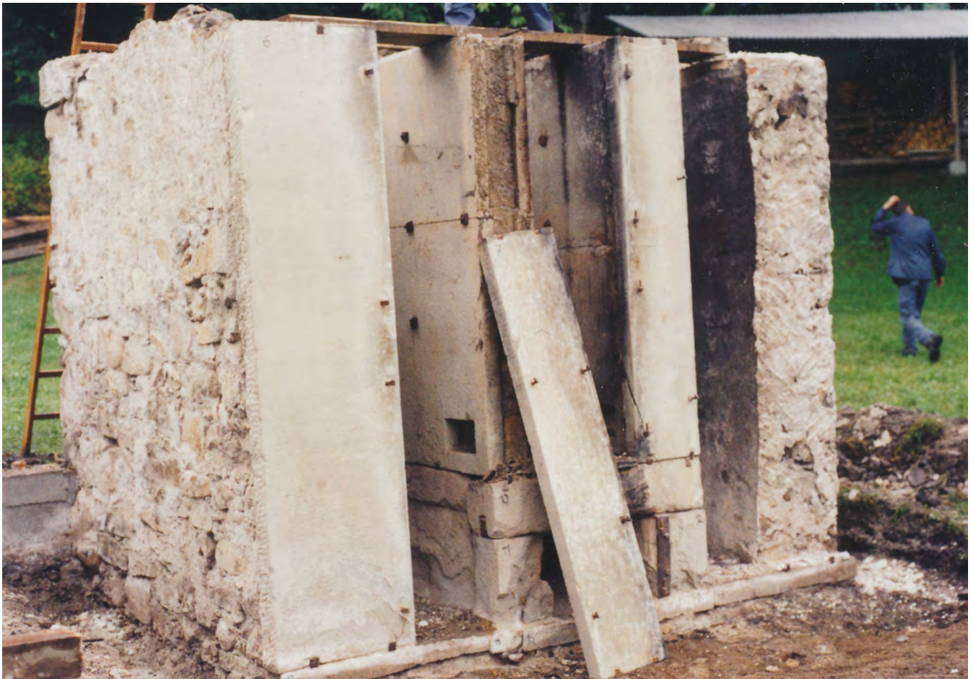
9 Alpnachstad, Hof Rothenbächli: Die Seitenwände und die Rückwand des Dörrroffens bestanden aus verputztem Bruchsteinmauerwerk. Die Dörrkammern und Ofenfront waren mit vorgeblendeten und sorgfältig bearbeiteten Sandsteinplatten versehen, welche mittels Eisenklammern an Ort und Stelle gehalten wurden. Blick nach Norden. Aufnahme 2000.
