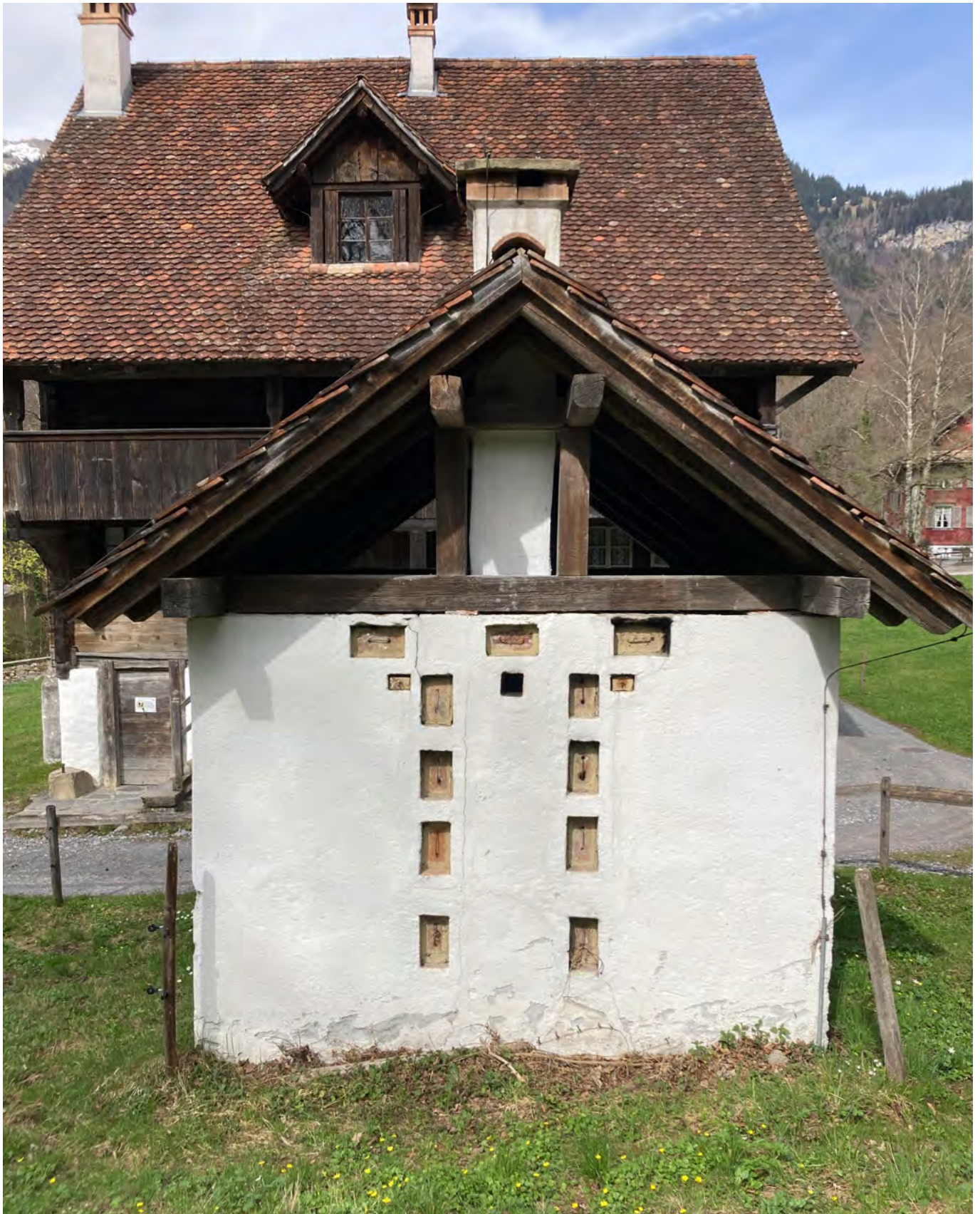
17 Freilichtmuseum der Schweiz, Dörröfen aus Alpnachstad: Die Rückseite des Gebäudes. Das Bruchsteinmauerwerk hat auf dem Ballenberg von aussen eine Kalkfassung erhalten. Da der Ofen im Museum betrieben wird, sind die Öffnungen mit Lehm abgedichtet um keine Wärme entweichen zu lassen. Blick nach Nordosten. Aufnahme 2022.
