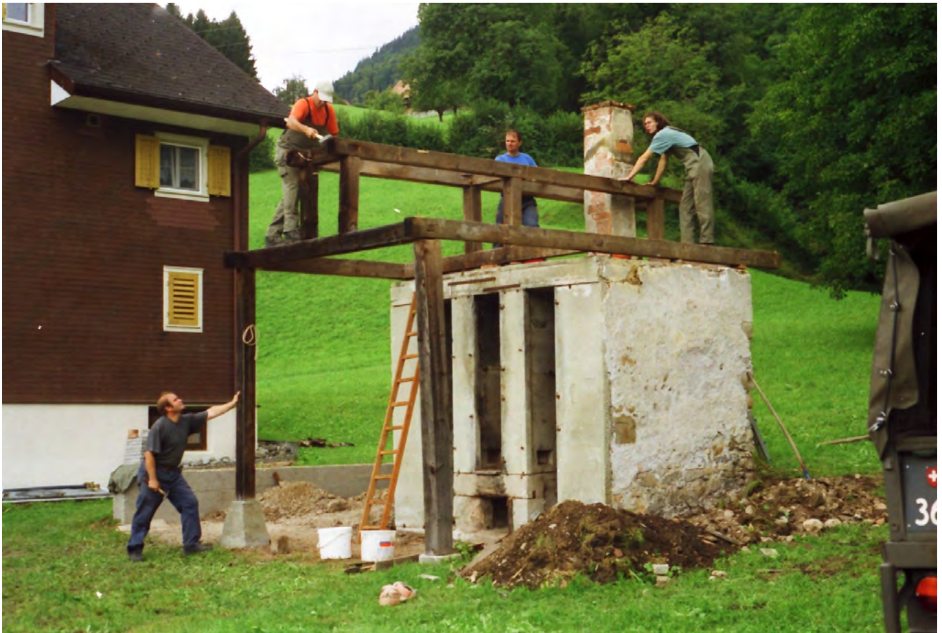
14 Alpnachstad, Hof Rothenbächli: Auf dieser während des Abbaus entstandenen Aufnahme ist die Dachkonstruktion besonders gut zu erkennen. Da der Kamin einer Firstpfette im Weg gestanden hätte, entschied man sich für ein Dachgerüst mit stehendem Stuhl. Blick nach Südwesten. Aufnahme 2000.
