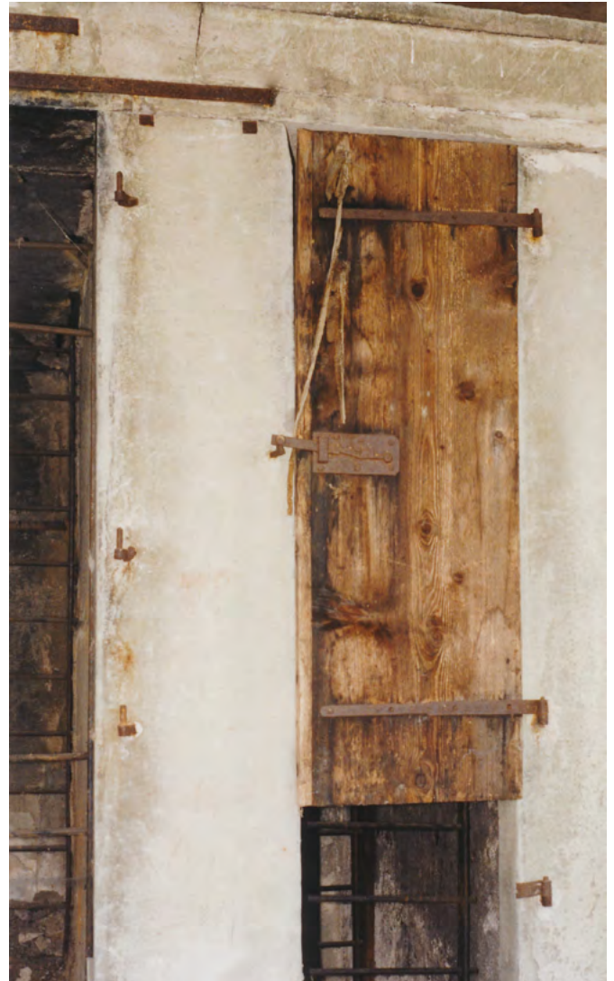
10 Alpnachstad, Hof Rothenbächli: Von den horizontal zweigeteilten Türen der Dörrkammern existierte beim Abbau nur noch eine Hälfte. Diese wurde als Vorlage für die Rekonstruktion im Freilichtmuseum genutzt. Blick nach Nordwesten. Aufnahme 2000.
