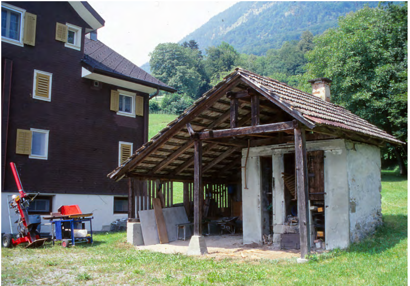
8 Alpnachstad, Hof Rothenbächli: Das Dörrhaus kurz vor dem Abbau mit der Erweiterung aus den 1960er Jahren. Damals wurde die linke Dachfläche verlängert und das Dach wurde angehoben. Blick nach Westen. Aufnahme 2000.
