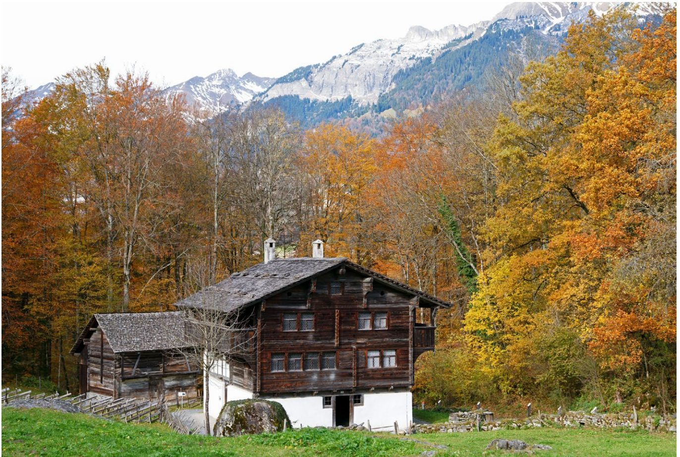
16 Freilichtmuseum der Schweiz, Geländekammer Zentralschweiz: Der Heustall bildet heute, analog zum ehemaligen Standort, zusammen mit dem Wohnhaus aus Erstfeld UR im Vordergrund ein Museumsgehöft der Region um Spiringen. Blick von Westen. Aufnahme 2010.
