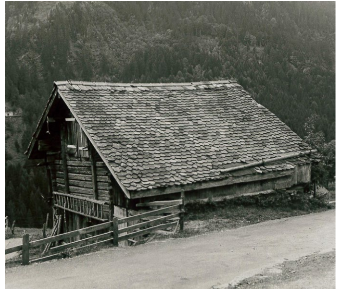
11 Spiringen, Heustall: Rückseite des Stallgebäudes mit Blick auf die nördliche Dachfläche. Das Pfetten-Rafendach ist erst in späterer Zeit mit den Biberschwanzziegeln gedeckt worden. Zuvor trug es Nagelschindeln. Gut zu erkennen ist die Hanglage des Gebäudes. Blick nach Südosten. Aufnahme 1984.
