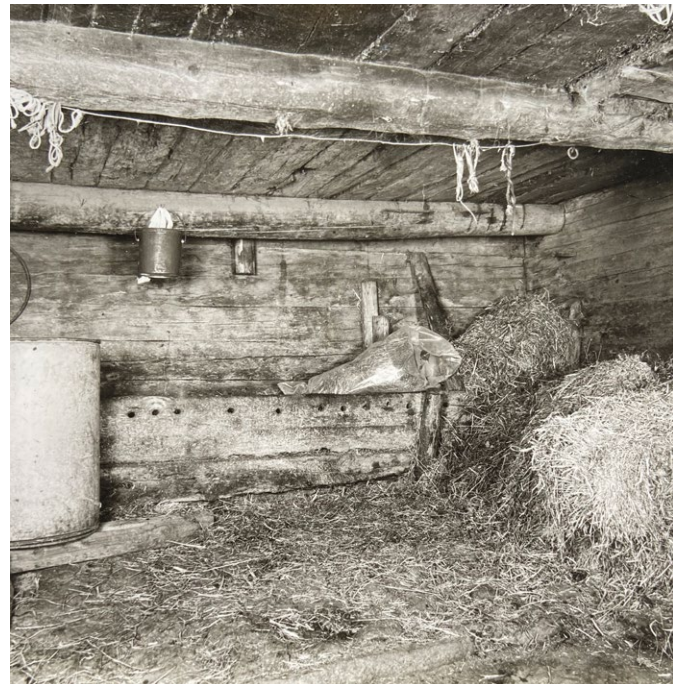
13 Spiringen, Heustall: Blick in den Stall mit einem der beiden Viehstände und der zugehörigen Futterkrippe. Aufnahme 1984.
