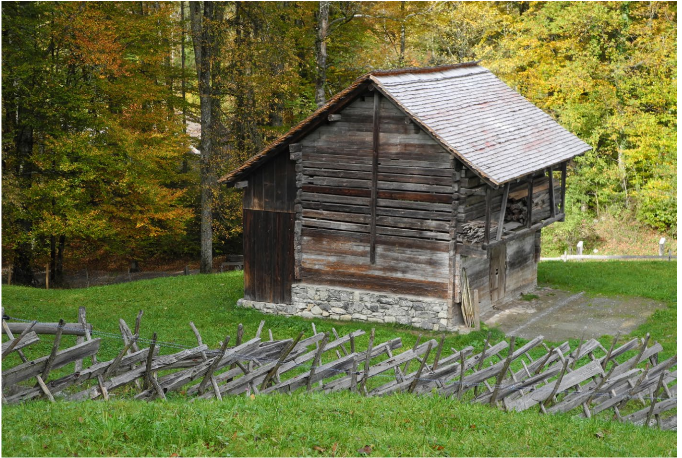
17 Freilichtmuseum der Schweiz, Heustall aus Siringen: Rückseite des heute um ca. 90 Grad nach Westen gedrehten Heustalls. Der Stalleingang weist im Museum nicht wie früher ins Tal, sondern zum benachbarten Wohnhaus aus Erstfeld. Im Vordergrund steht ein im Schächental weitverbreiteter Scharhag, mit dem die Weidefläche eingehegt ist. Blick nach Nordosten. Aufnahme 2013.
