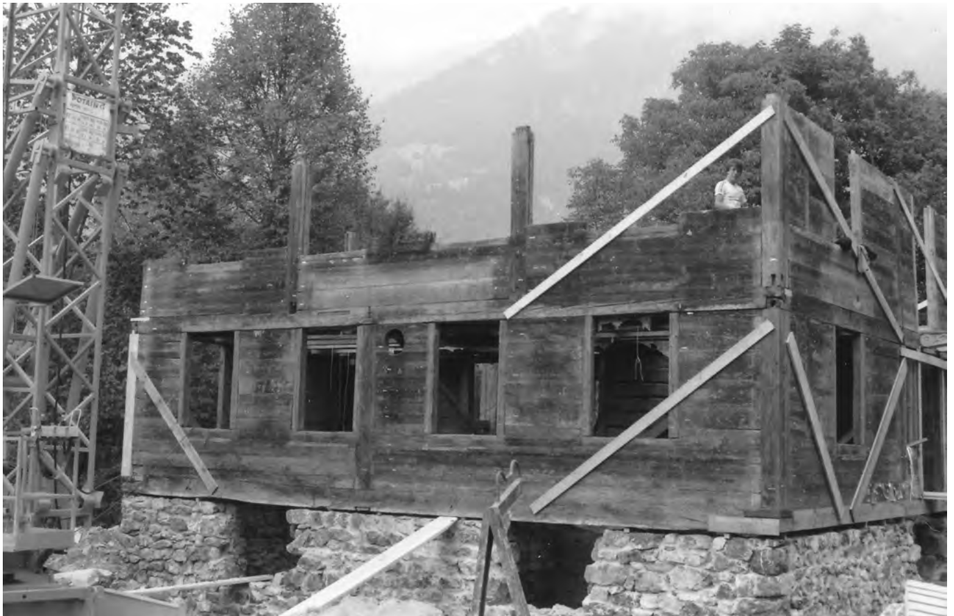
18 Freilichtmuseum der Schweiz, Gasthaus Degen: Das Gasthaus aus Hünenberg während des Wiederaufbaus auf dem Ballenberg. Das Foto verdeutlicht die Konstruktionsweise des Hauses. Blick nach Nordwesten. Aufnahme 1990.
