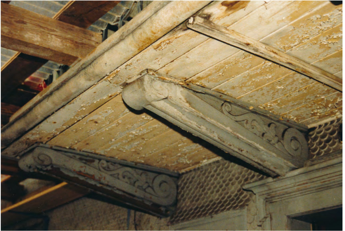
10 Hünenberg, Chamerstrasse 9: Untersicht des Balkons über dem Eingang, mit klassizistisch gestalteten Trägerbalken. Blick nach Südwesten. Aufnahme 1988.
