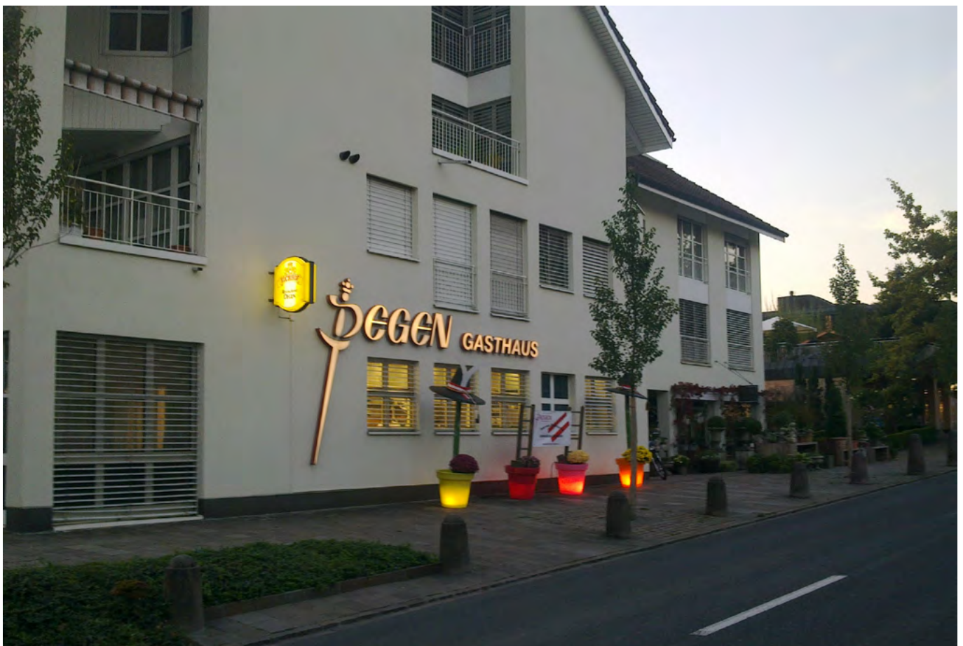
8 Hünenberg, Chamerstrasse 9: Der «neue» Degen von 1989. Blick nach Nordwesten. Aufnahme 2010.
