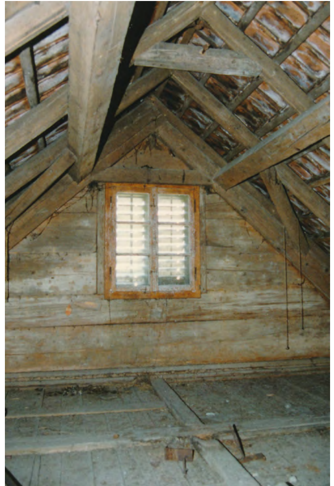
12 Hünenberg, Chamerstrasse 9: Blick in den Dachraum über dem Kehlgebälk. Aufnahme 1988.
