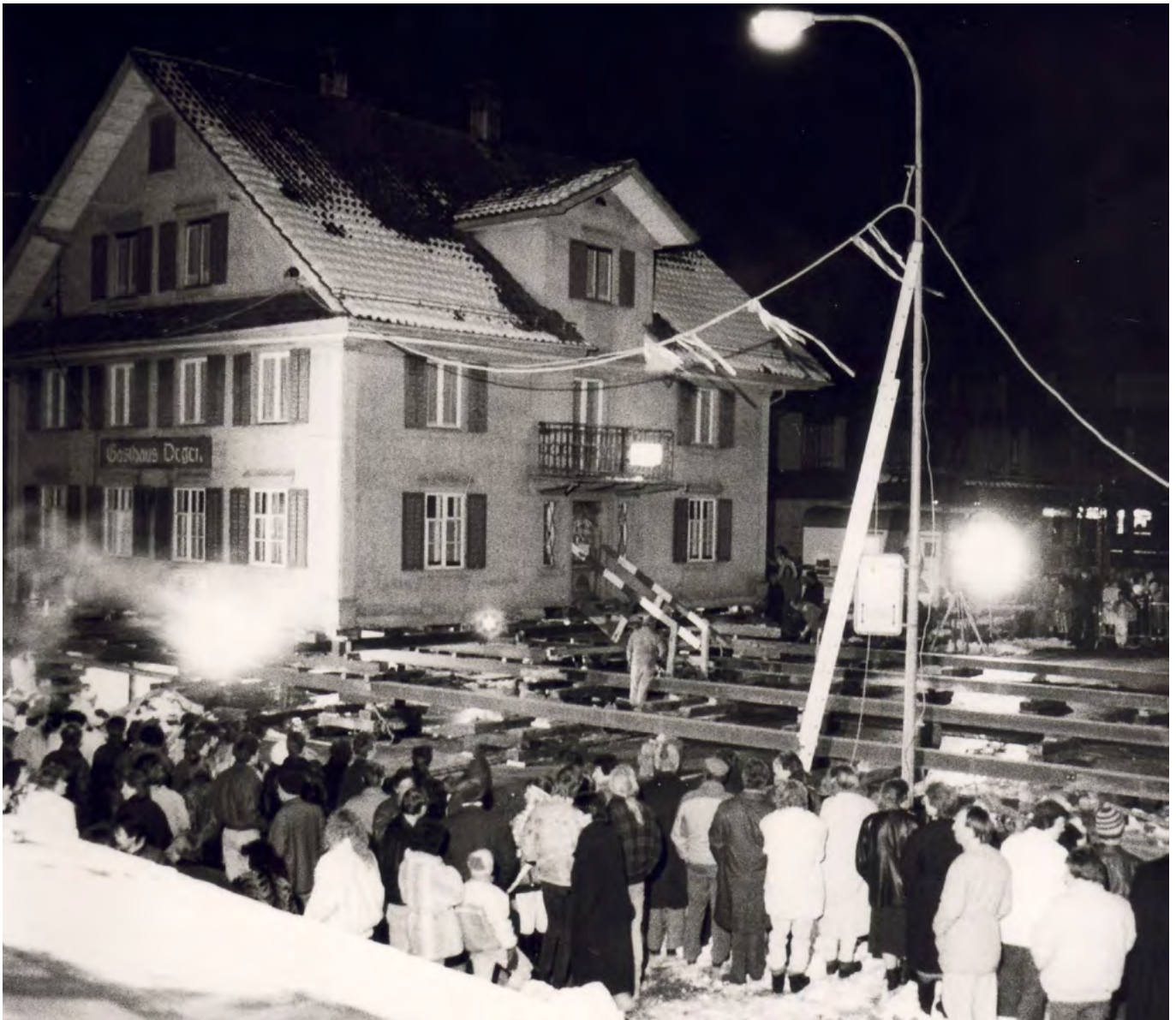
6 Hünenberg, Chamerstrasse 9. Das Gasthaus Degen während seiner Verschiebung auf die gegenüberliegende Strassenseite am 29.2.1988. Aufnahme 1988.
