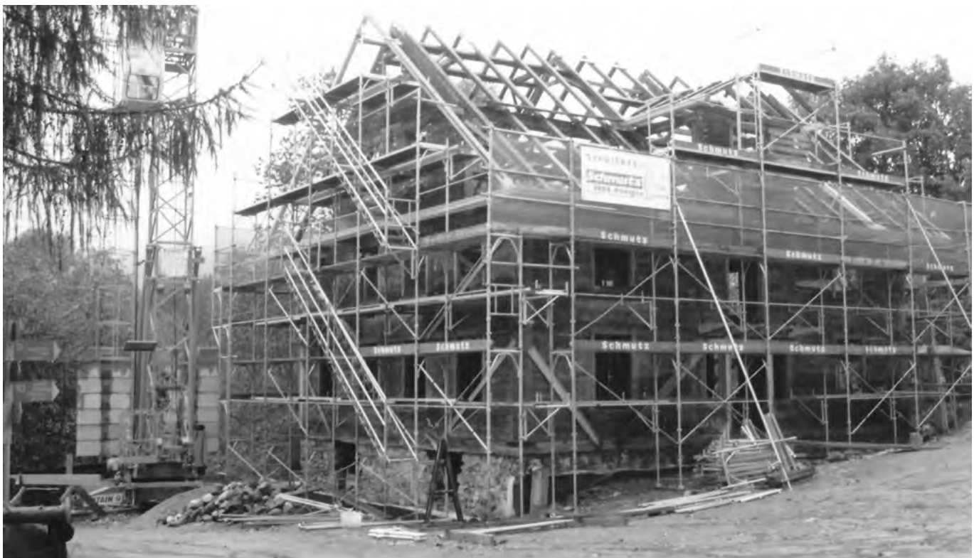
19 Freilichtmuseum der Schweiz, Gasthaus Degen: Das Gebäude während der Schindelarbeiten im Winter 1990/91. Blick nach Nordwesten. Aufnahme 1990.
