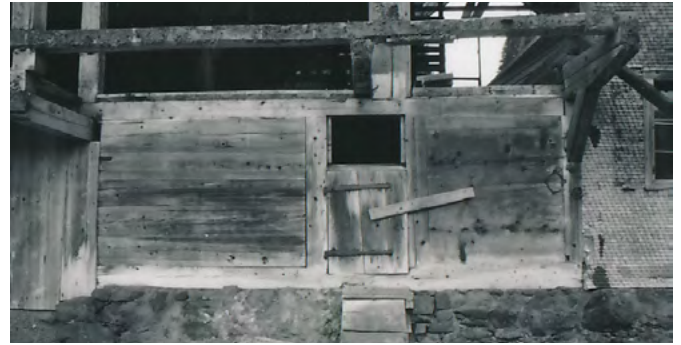
11 Escholzmatt-Wissemmen: Der Stallteil in der Hauptfassade. Hier zeigt sich, dass das Haus nicht als reiner Blockbau, sondern in etlichen Bereichen als Ständerkonstruktion errichtet und mit Balken ausgefacht war. Blick nach Süden. Aufnahme um 1997.
