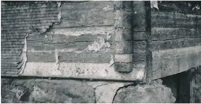
10 Escholzmatt-Wissemmen: Die Gebäudeecke, hinter der sich die Stube befindet, zeigt die für die Blockkonstruktion typische Eckverkämmung. Blick nach Südosten. Aufnahme um 1997.
