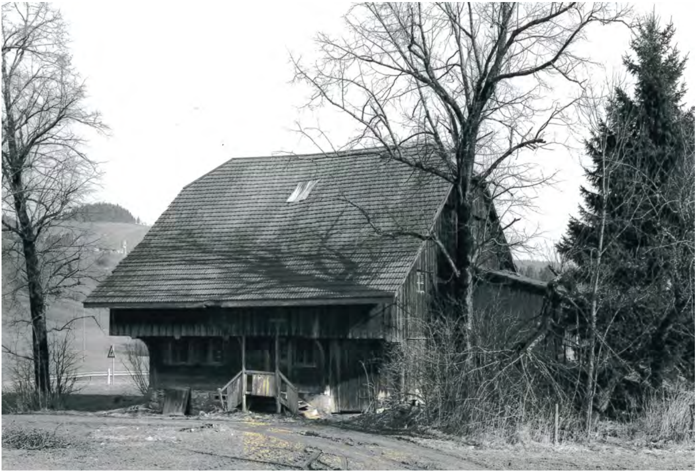
12 Escholzmatt-Wissemmen: Das Haus kurz vor den Abbauarbeiten. Blick nach Nordosten, auf die Trauffassade mit dem Haupteingang. Aufnahme 1997.
