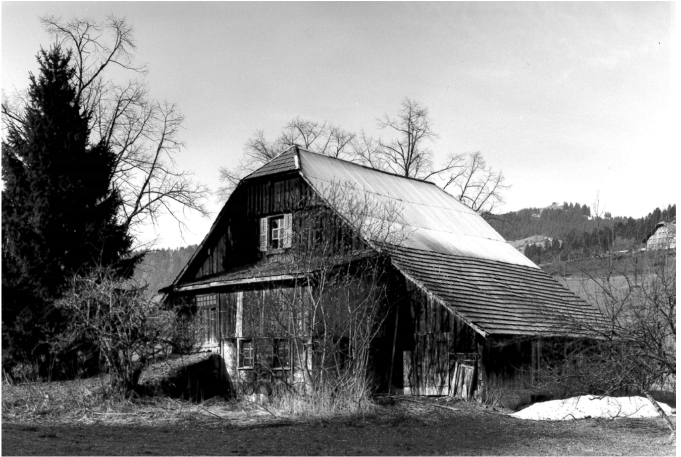
5 Escholzmatt-Wissemmen: Die Schopfanbauten und die Einfahrt auf den Heuboden sind im Laufe des 20. Jahrhunderts hinzugekommen. Blick nach Nordwesten. Aufnahme 1997.
