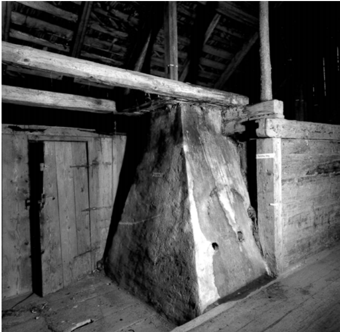
15 Escholzmatt-Wissemmen: Das Haus kurz vor den Abbauarbeiten. Blick in den Dachraum. Der gemauerte Rauchfang zeugt von der einst offenen Feuerstelle in der Küche. Der Kaminzug über dem Rauchfang bestand zu diesem Zeitpunkt bereits nicht mehr. Aufnahme 1997.
