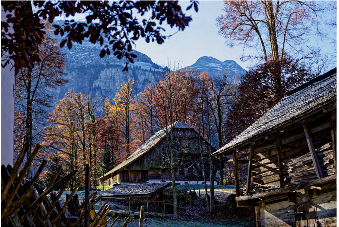
18 Freilichtmuseum der Schweiz, Kleinbauernhaus aus Escholzmatt: Das Gebäude von den Zentralschweizer Bauten aus Erstfeld und Spiringen UR aus. Blick nach Süden. Aufnahme 2020.
