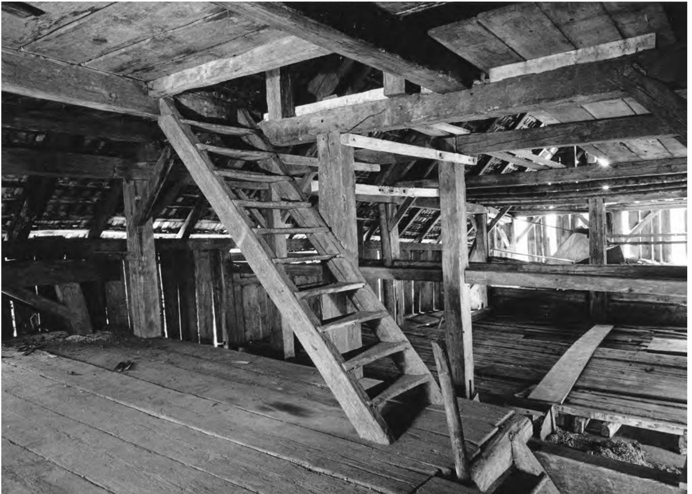
11 Meggen, Hof Weid: In der Stallscheune. Mit der Erweiterung des Gebäudes wurde nicht nur der Grundriss vergrössert, sondern auch das Dach erhöht. So entstanden im östlichen Gebäudeteil drei Geschosse. Blick vom Obergeschoss des Anbaus nach Westen. Aufnahme undatiert.
