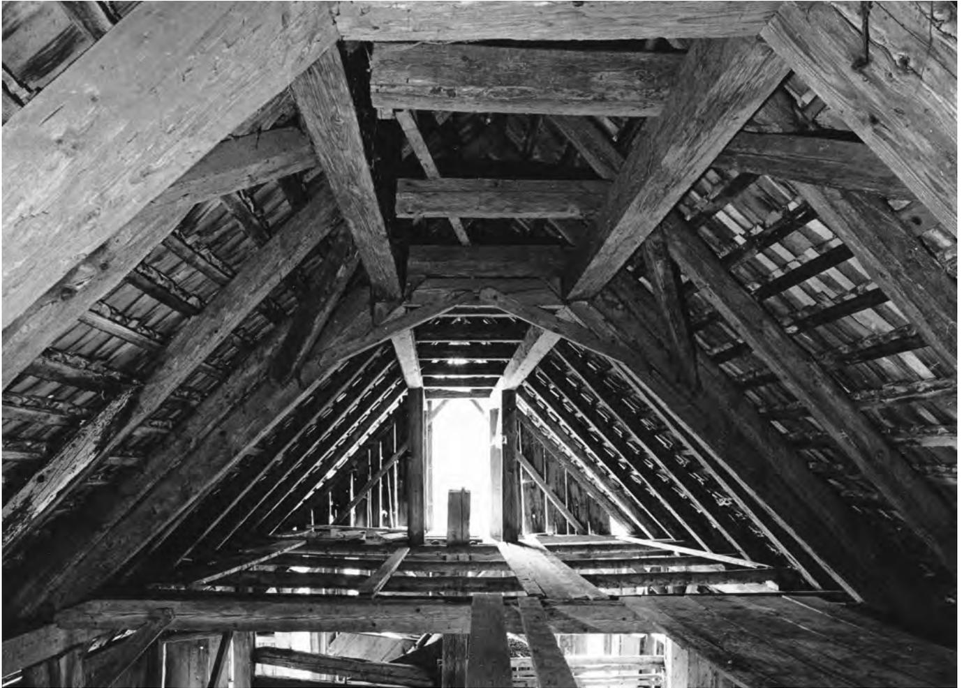
**12** Meggen, Hof Weid: In der Stallscheune. Das Dach wurde 1799 vom flachen, auf Hochstüden lastenden Tätschdach zum steilen Satteldach umgebaut, welches von liegenden und stehenden Stühlen getragen wurde. Die alten Hochstüde blieben teilweise erhalten und ragten fortan, wie in der Bildmitte zu sehen, in den Dachraum hinein. Blick nach Westen. Aufnahme undatiert.
