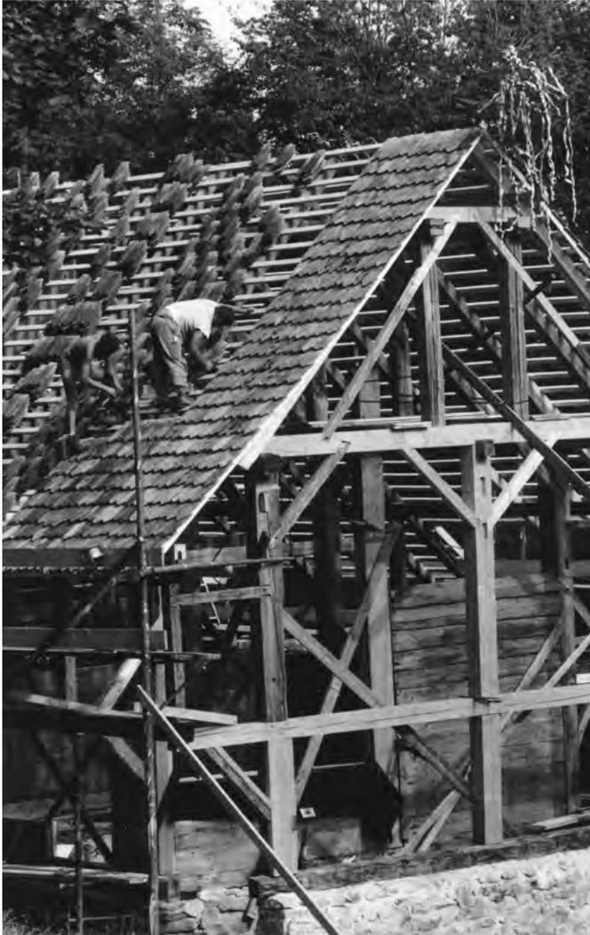
**15** Freilichtmuseum der Schweiz, Stallscheune aus Meggen: Diverse Elemente der Holzkonstruktion waren nicht wiederverwendbar und wurden durch neues Holz ausgetauscht. Dieses ist auf der Aufnahme aufgrund der helleren Farbe gut vom Bestandsmaterial zu unterscheiden. Beim Holzaustausch wurde behutsam vorgegangen und wo möglich hat man morsche Stellen ergänzt, anstelle ganze Konstruktionselemente zu erneuern. Blick nach Südosten. Aufnahme 1993.
