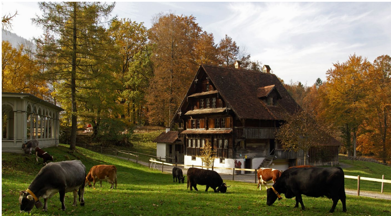
12 Freilichtmuseum der Schweiz, Landschaftskammer Zentralschweiz: Blick auf die Spielhalle aus Sarnen links und das Wohnhaus aus Sachseln OW rechts. Der ländliche Kontext, in dem der Bau heute steht, ist mit dem Ursprungsort neben dem monumentalen Schulbau in Sarnen nicht zu vergleichen. Blick nach Westen. Aufnahme 2010.
