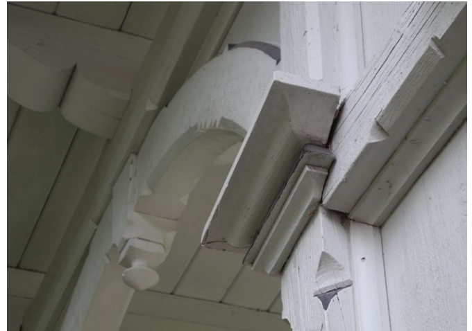
10 Freilichtmuseum der Schweiz, Spielhalle aus Sarnen: Teilansicht der Holzkonstruktion. Die meisten gestalterischen Details wurden direkt an den Konstruktionshölzern ausgeführt, nur wenige Elemente des Bauschmucks, wie beispielsweise die auf der Aufnahme sichtbaren Konsolen, wurden als reine Dekorelemente nachträglich auf die Konstruktion aufgebracht. Aufnahme 2013.
