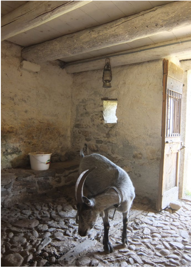
15 Freilichtmuseum der Schweiz, Heustall aus Pollegio: Der Stallraum mit Blick zur Tür. Aufnahme 2022.
