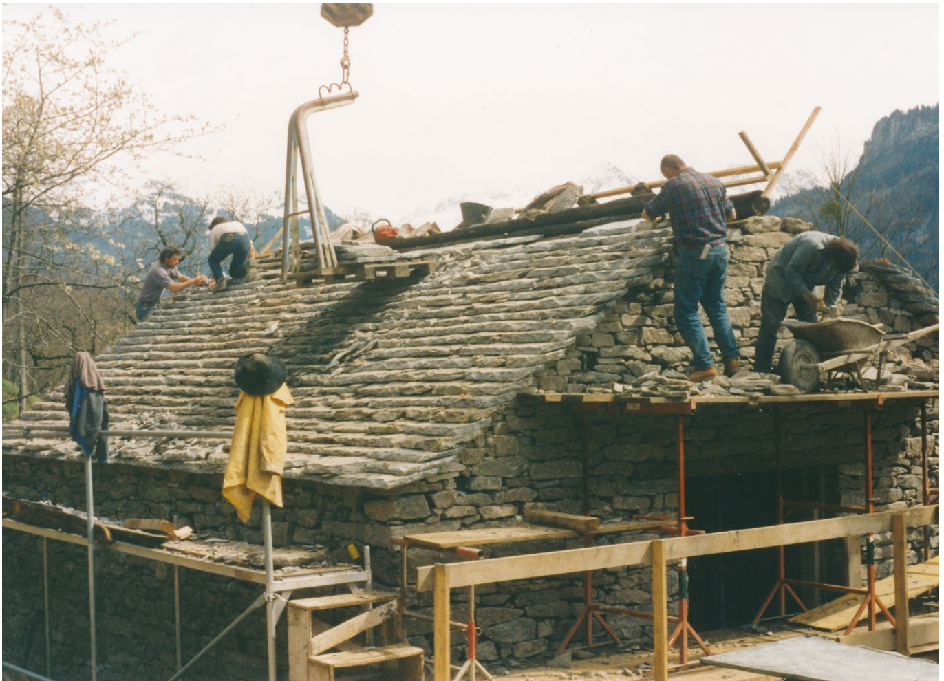
13 Freilichtmuseum der Schweiz, Heustall aus Pollegio: Das Gebäude beim Wiederaufbau. Aufnahme 2001.
