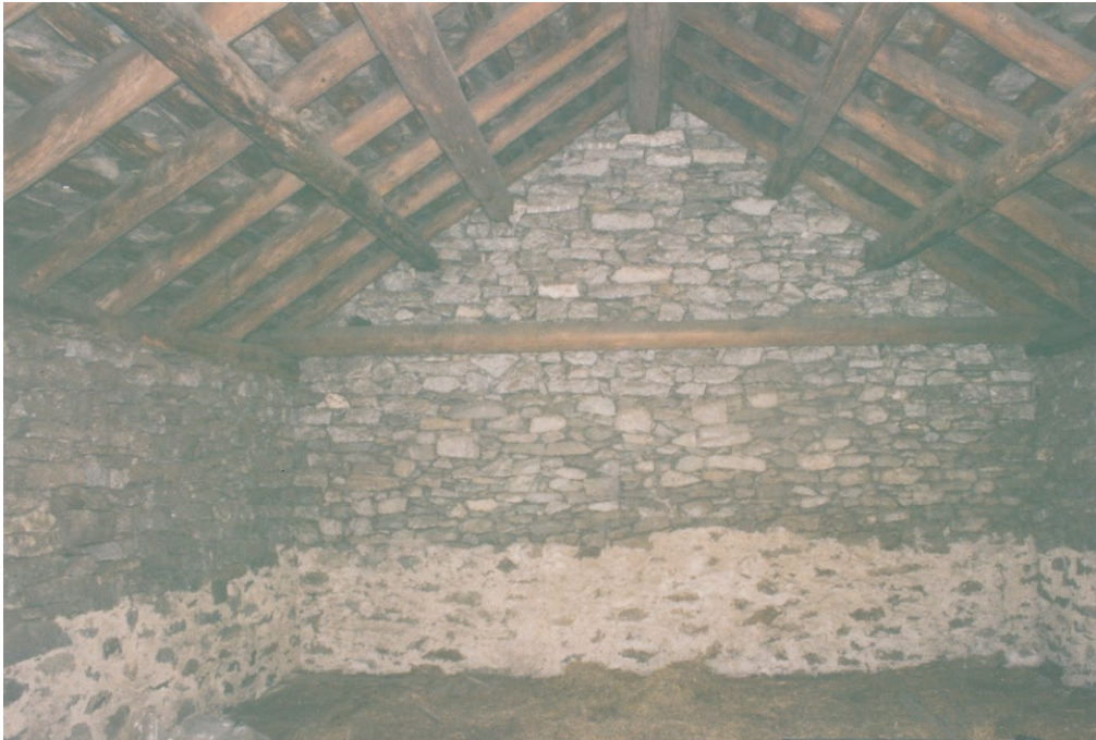
8 Pollegio, Heustall: Der Heuraum mit der gut sichtbaren Dachkonstruktion. Aufnahme wohl 1999.
