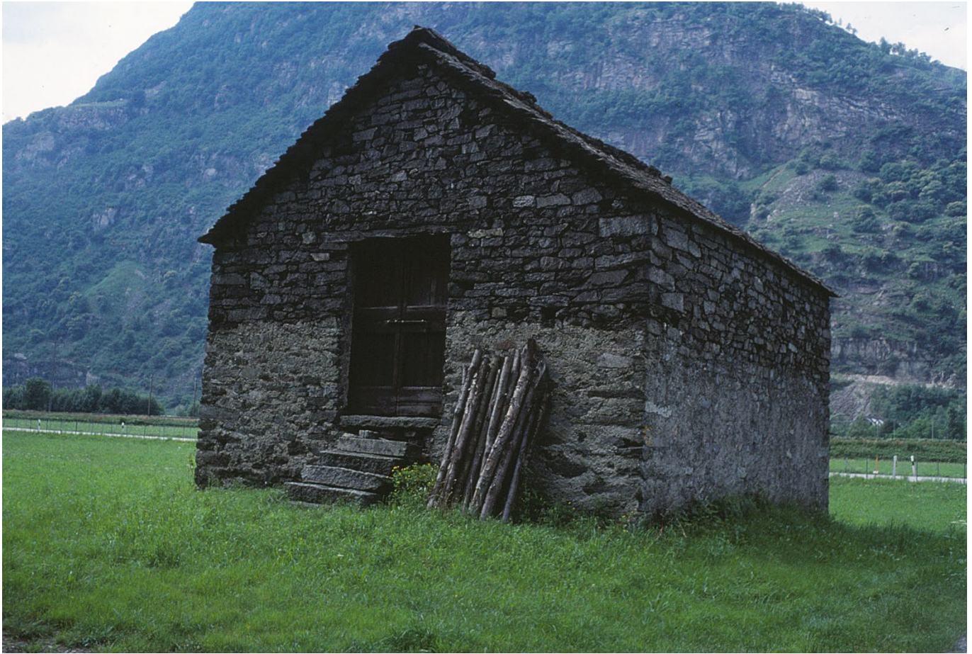
4 Pollegio, Heustall: Das Gebäude befand sich freistehend, mitten in einer Wiese, nicht weit entfernt von der Kantonsstrasse. Blick nach Süden. Aufnahme 1999.
