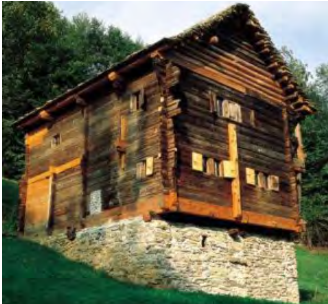
15 Freilichtmuseum der Schweiz, Wohnhaus aus Malvaglia: Das Museumsgebäude wurde eben erst neu aufgebaut, die neuen Holzteile sind noch gut ablesbar. Blick nach Nordosten. Aufnahme um 1992/93.
