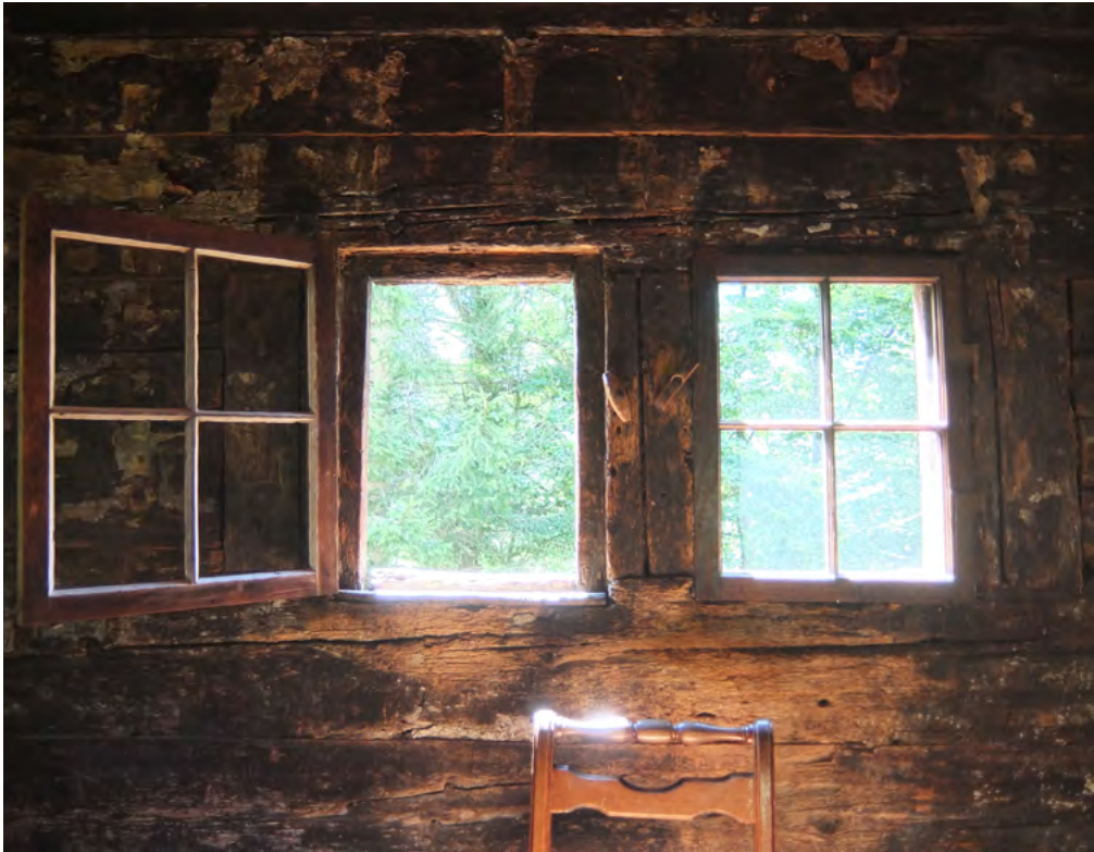
23 Freilichtmuseum der Schweiz, Wohnhaus aus Malvaglia: Fenster im ersten Blockgeschoss. Blick nach Süden. Aufnahme 2022.
