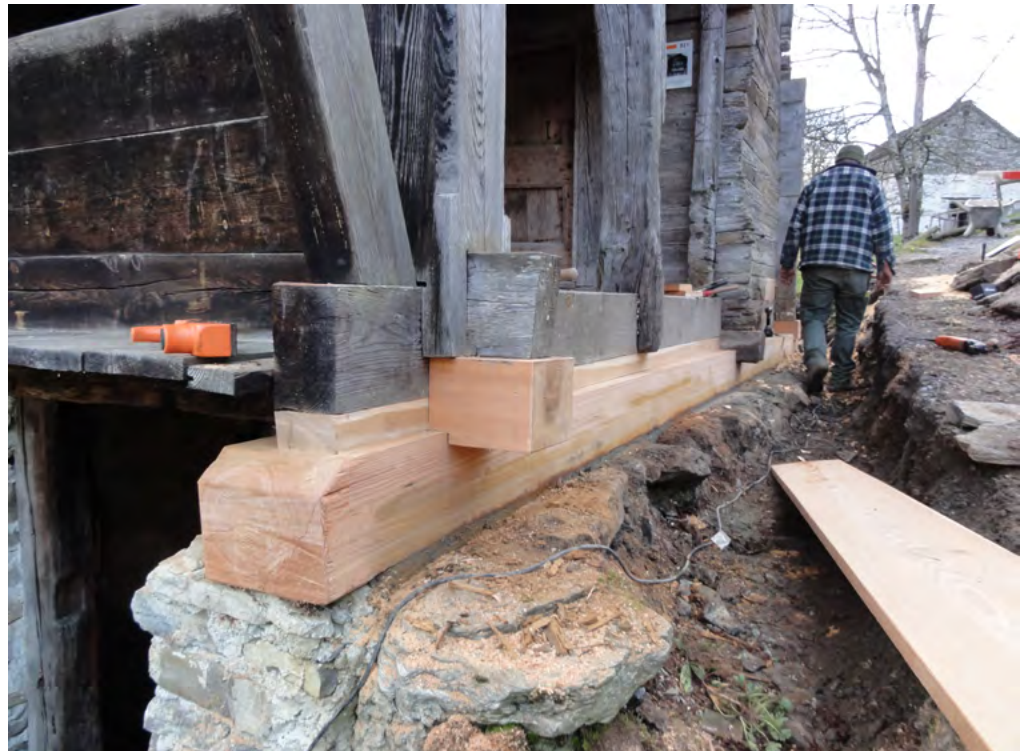
16 Freilichtmuseum der Schweiz, Wohnhaus aus Malvaglia: Das Museumsgebäude beim Einsetzen einer neuen Schwelle aus Lärchenholz. Blick nach Westen. Aufnahme 1992.
