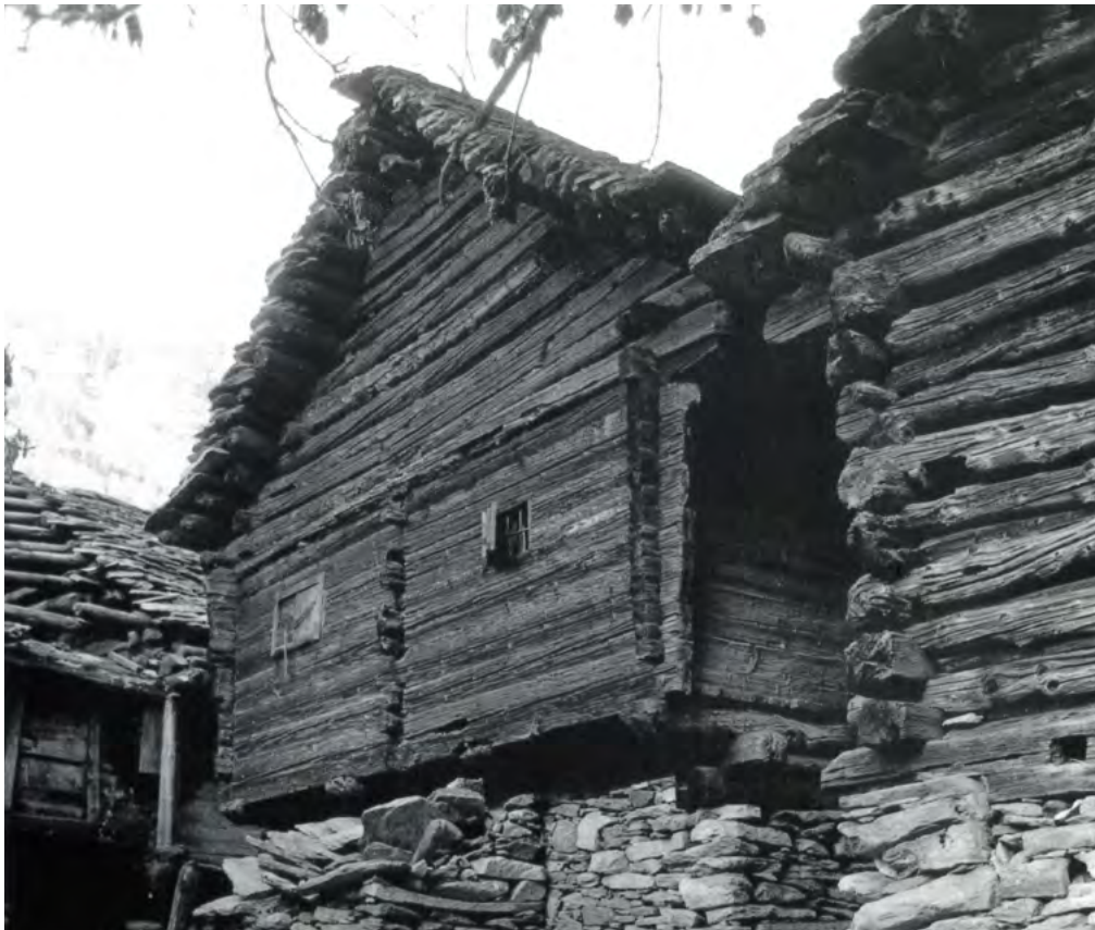
13 Malvaglia-Dandrio TI: Zweigeschossiges und einräumiges Turmhaus mit übereinanderliegenden Funktionen. Die Küche befand sich im Sockelgeschoss, darüber der nur von aussen durch einen Ofen heizbare Raum. Aufnahme vor 1993.
