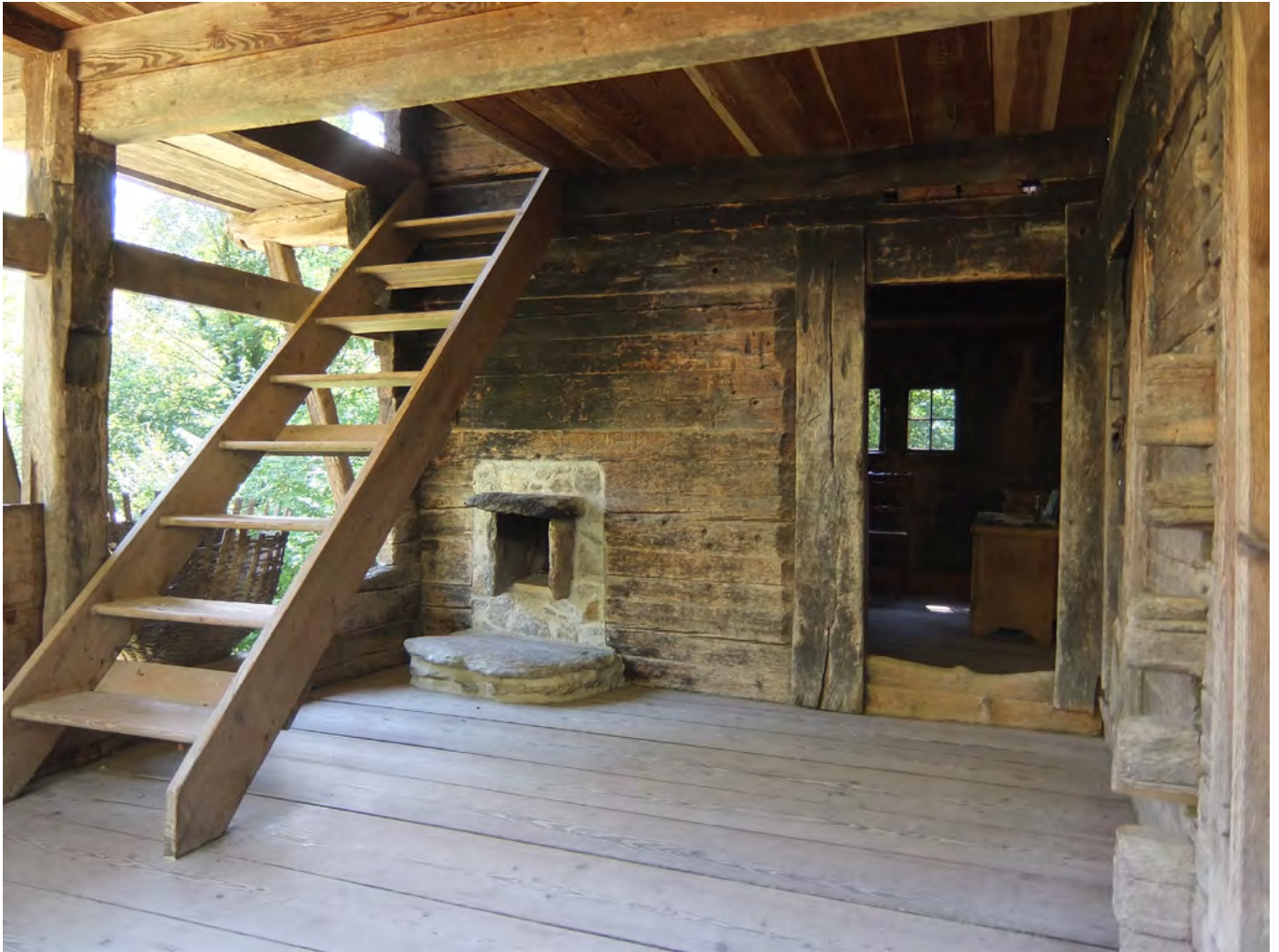
20 Freilichtmuseum der Schweiz, Wohnhaus aus Malvaglia: Offener Vorraum im ersten Blockgeschoss, mit Feuerungsöffnung des Stubenofens und Treppe zum zweiten Blockgeschoss. Blick nach Südosten. Aufnahme 2022.
