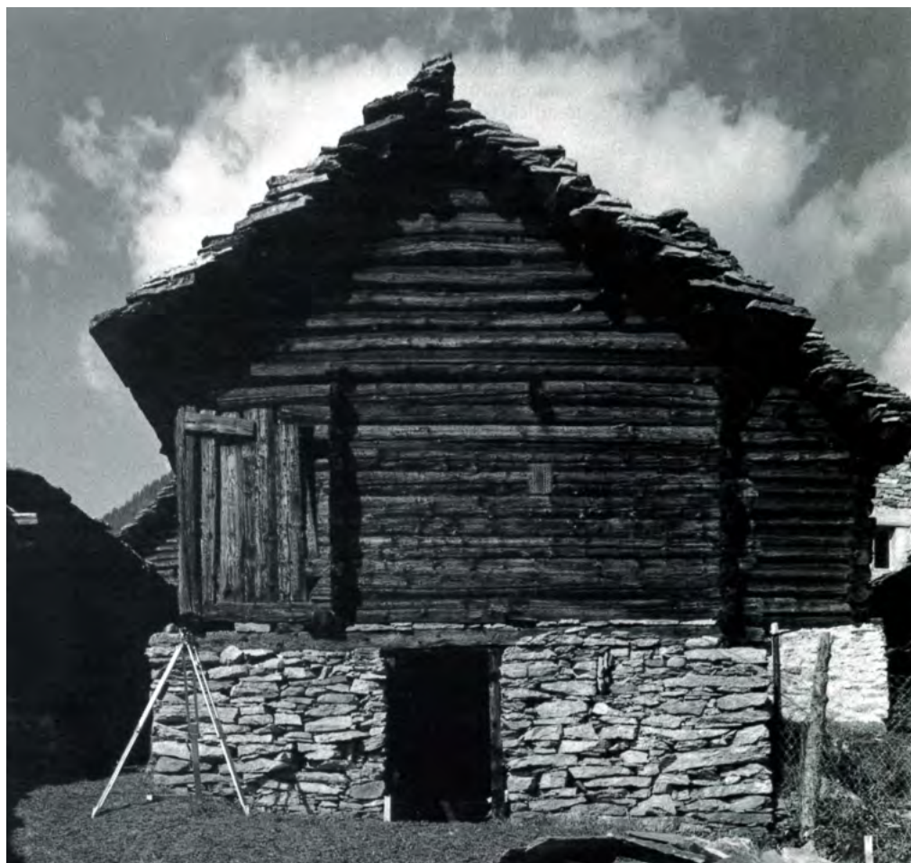
12 Malvaglia-Dagro TI: Einfacher zweigeschossiger Vielzweckbau mit seitlicher Loggia. Im gemauerten Sockelgeschoss war der Stall untergebracht, davor bestand ein gedeckter Vorplatz. Der Blockbau darüber war mit zwei Speicherkam- mern und Loggia und auf der Rückseite mit zwei Heuräumen ausgestattet. Aufnahme vor 1993.
