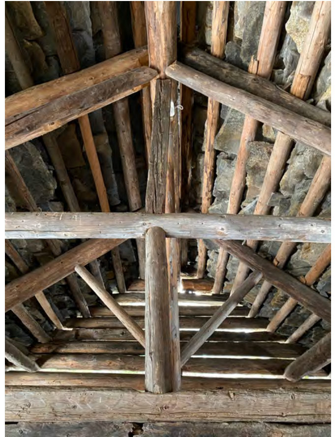
22 Freilichtmuseum der Schweiz, Wohnhaus aus Malvaglia: Blick in den Dachstuhl. Aufnahme 2021.
