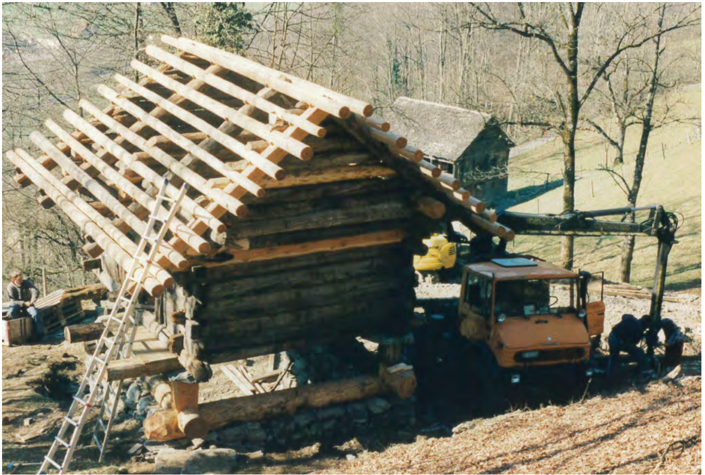
12 Freilichtmuseum der Schweiz, Getreidespeicher aus Campo (Vallemaggia): Aufbau des Museumsgebäudes. Blick nach Südwesten. Aufnahme 2000.
