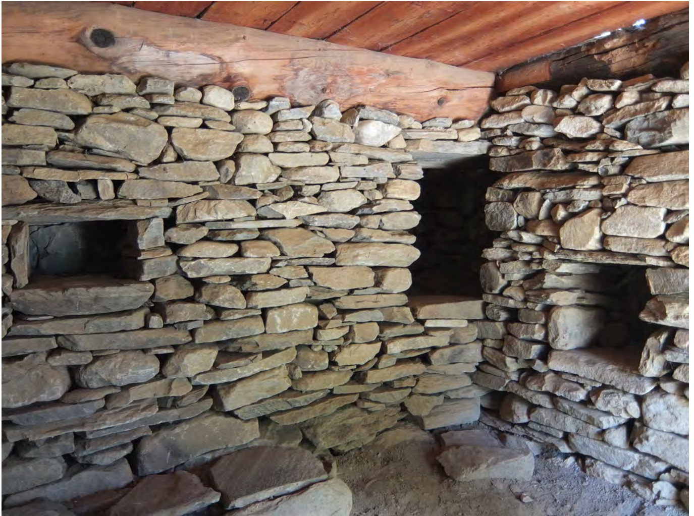
15 Freilichtmuseum der Schweiz, Getreidespeicher aus Campo (Vallemaggia): Der Innenraum des Sockelgeschosses mit Nischen und abgetrenntem Keller in Hang eingetieft. Blick Richtung Nordosten. Aufnahme 2022.
