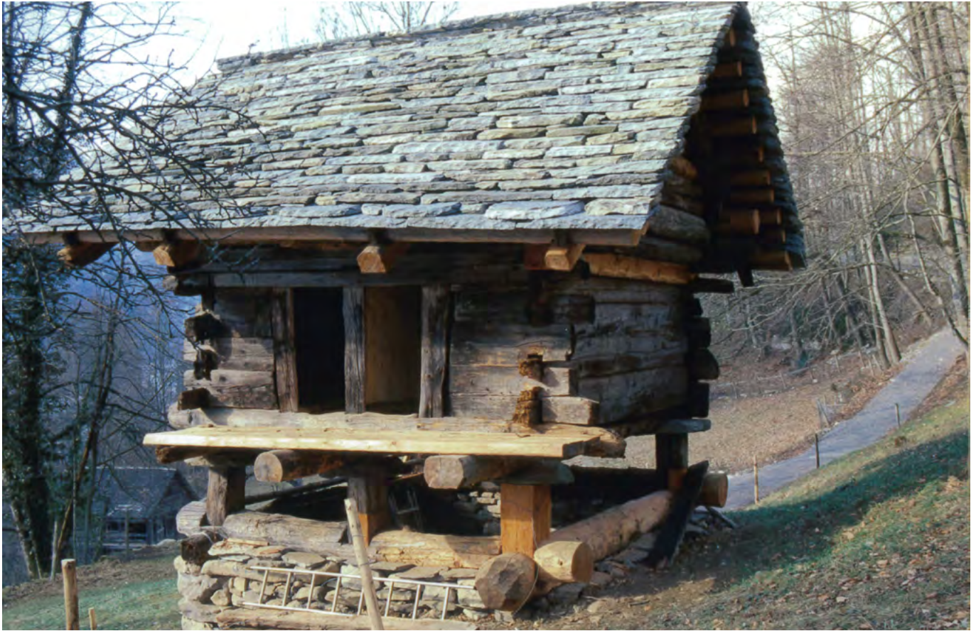
13 Freilichtmuseum der Schweiz, Getreidespeicher aus Campo (Vallemaggia): Fertig aufgebautes Museumsgebäude mit Steinplattendach. Blick nach Südwesten. Aufnahme nach 2000.
