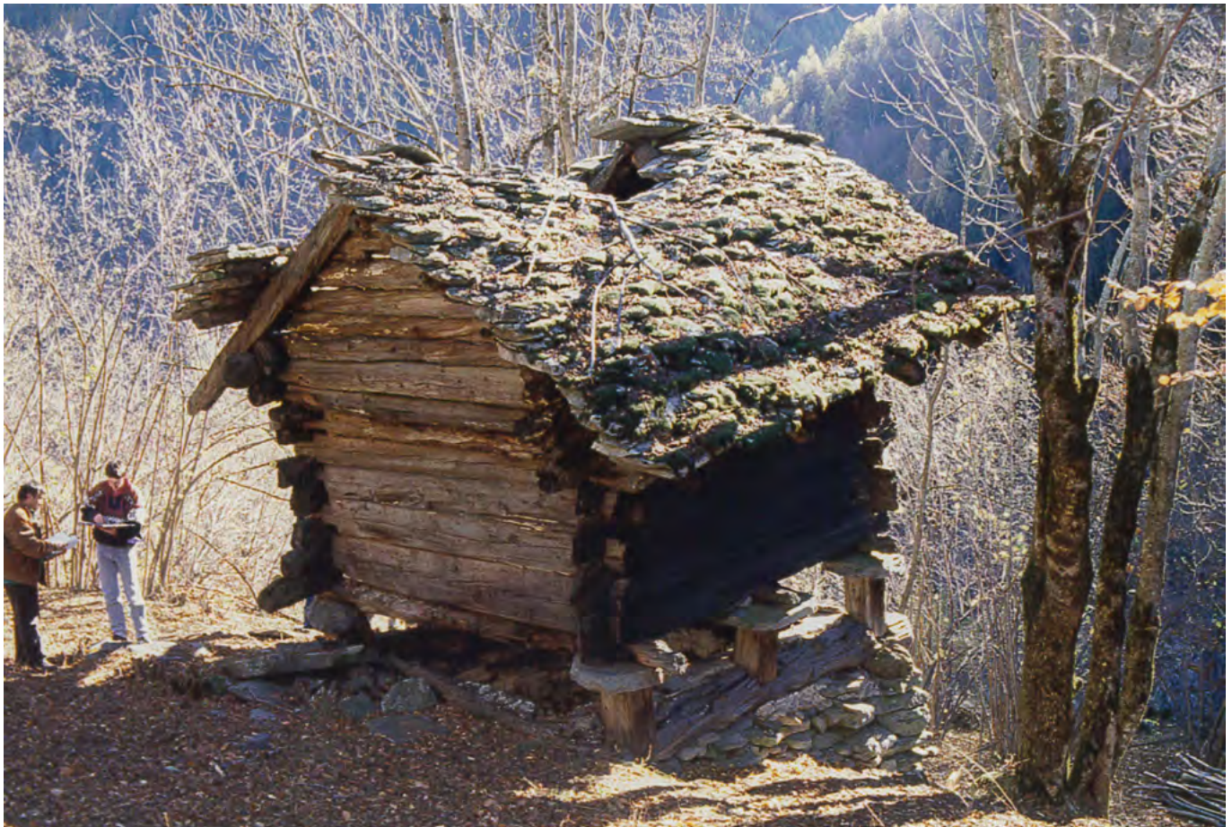
6 Piano di Campo: Der Speicher am Originalstandort vor dem Abbau. Blick nach Südosten. Aufnahme 1999.
