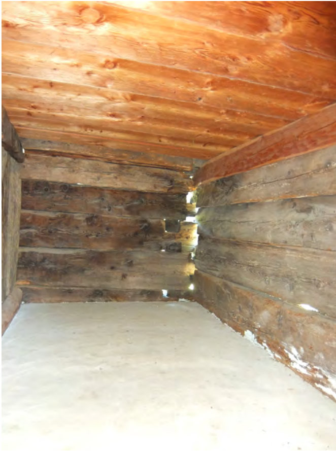
17 Freilichtmuseum der Schweiz, Getreidespeicher aus Campo (Vallemaggia): Der nördliche Speicherraum mit Kalkmörtelboden, lastrigh genannt. Blick nach Westen. Aufnahme 2022.
