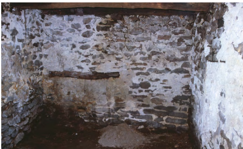
39 Cugnasco, Wohnhauskomplex: Erdgeschoss nach der Entrümpelung. An der Nordwand war ein Balken eingemauert, dessen Funktion sich nicht mehr erschloss. Blick nach Norden. Aufnahme Mai 2000.
