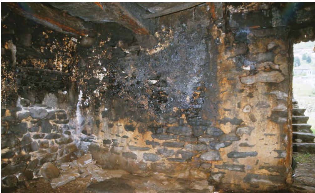
37 Cugnasco, Wohnhauskomplex: Blick ins Erdgeschoss des Eckhauses mit der Herdstelle vor der Nordwand. Blick nach Norden. Aufnahme Mai 2000.
