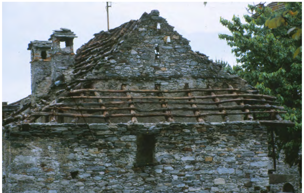
35 Cugnasco: Wohnhauskomplex: Blick auf das Dach des Doppelwohnhauses sowie die eingebaute Nordlaube und ihren Zugang im Westen nach Abtragung der Dachhaut. Blick nach Osten. Aufnahme Mai 2000.
