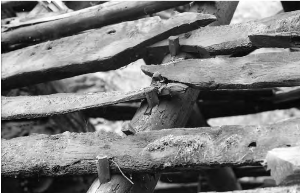
36 Cugnasco, Wohnhauskomplex: Das Dachwerk des Nordhauses während des Abbaus. Die unregelmässig gewachsenen, kaum bearbeiteten Dachlatten waren mit Holznägeln an den Sparren befestigt. Aufnahme Mai 2000.
