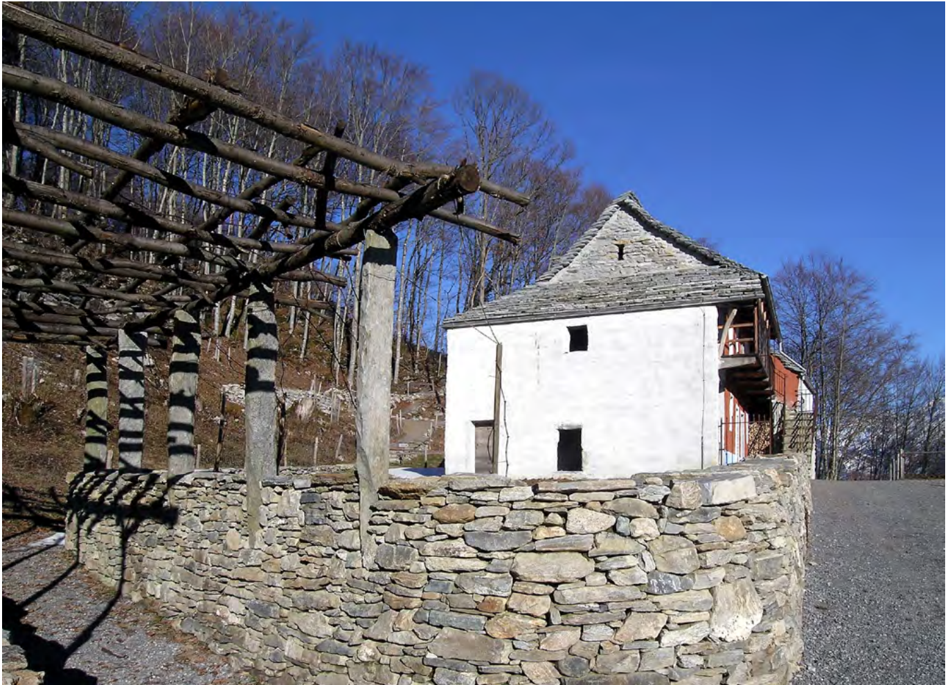
48 Freilichtmuseum der Schweiz, Hauskomplex aus Cugnasco: Das Gebäude mit der fertiggestellten Pergola und Trockenmauer. Blick nach Nordosten. Aufnahme Februar 2005.
