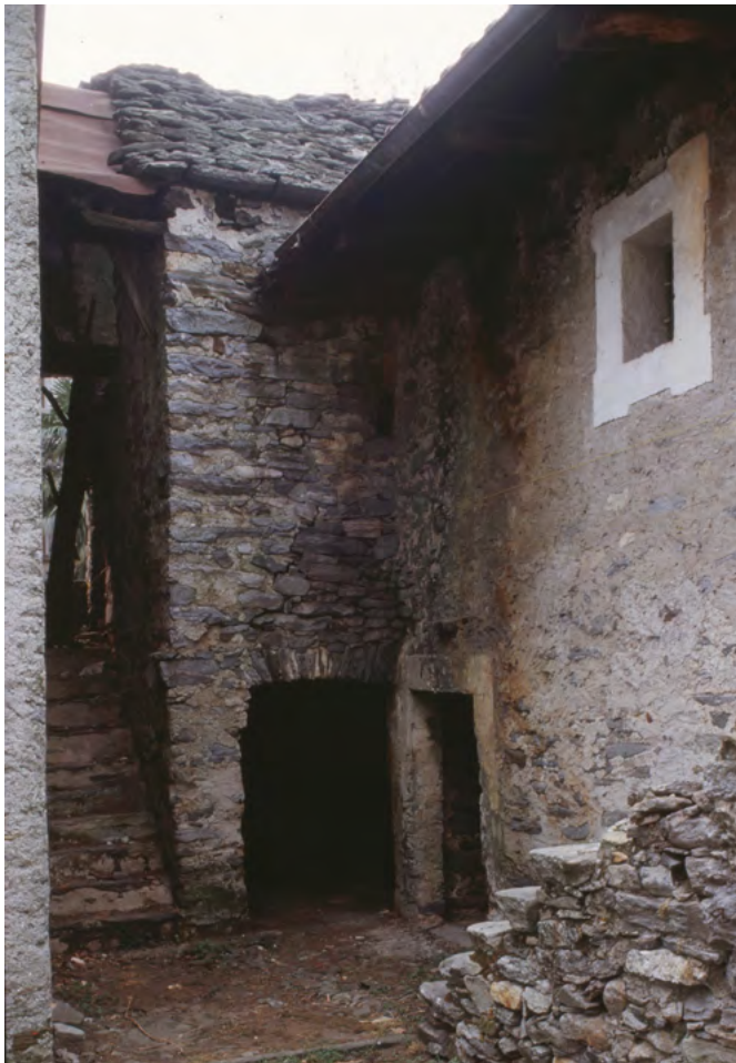
31 Cugnasco, Wohnhauskomplex: Nordöstliche Hausecke des Eckhauses und Ostfassade des Nordhauses während der Bauuntersuchung vor und während des Abbaus. Blick nach Südwesten. Aufnahme Mai 2000.
