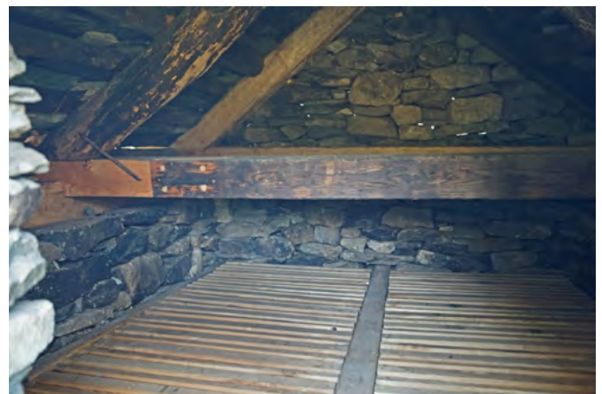
19 Freilichtmuseum der Schweiz, Kastaniendörrhaus aus Prato-Sornico: Der Rost im Dörrraum im Obergeschoss. Aufnahme 2011.
