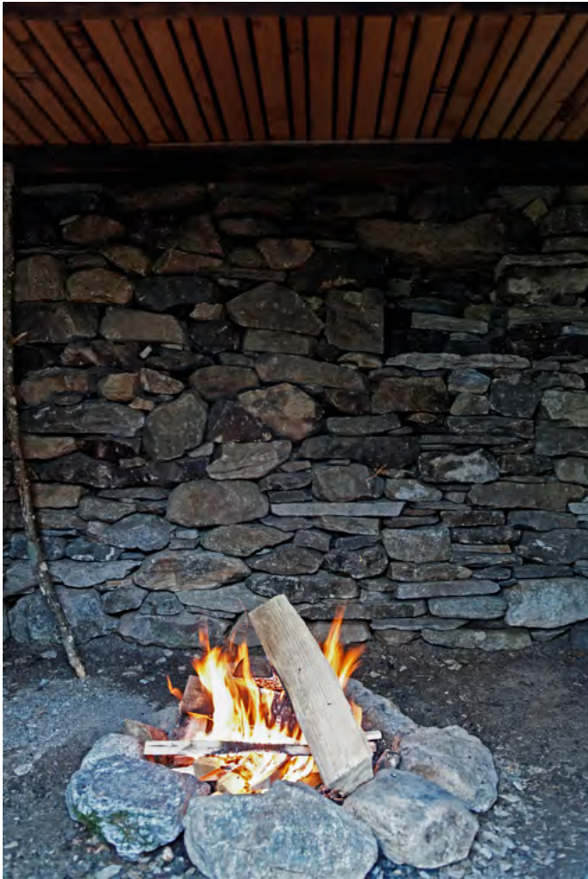
18 Freilichtmuseum der Schweiz, Kastaniendörrhaus aus Prato-Sornico: Die Feuerstelle im Erdgeschoss. Aufnahme 2011.
