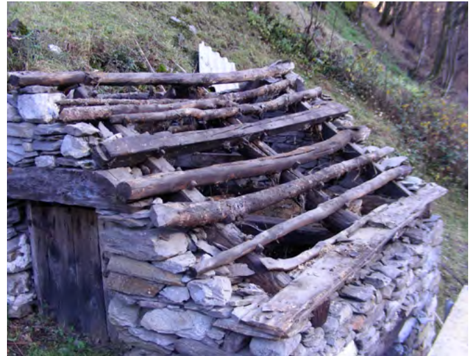
12 Prato-Sornico: Das Dach des Kastaniendörrhauses an seinem Originalstandort bereits zur Hälfte abgedeckt. Aufnahme 2010.
