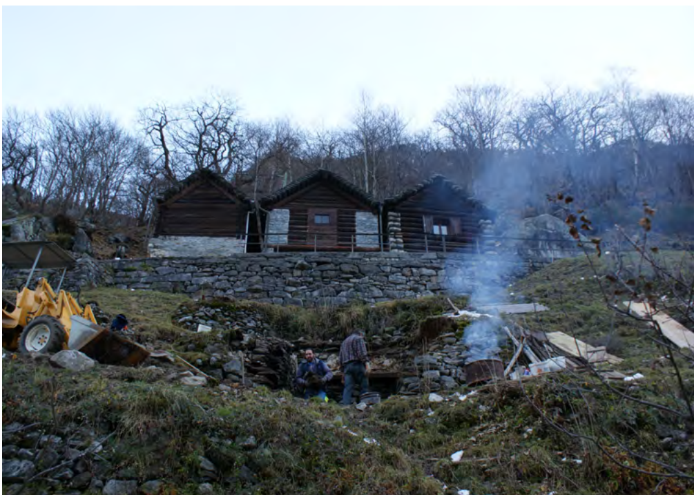
15 Prato-Sornico: Abbau des Kastaniendörrhauses am Originalstandort. Die Hangmauer musste vor Ort bleiben. Aufnahme 2010.
