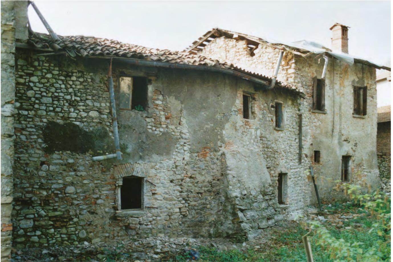
**31** Novazzano, La Pobbia: Äussere Ansicht des Ostflügels. Am Ende ist das höhere Eckgebäude zu sehen, das an den Nordflügel mit dem Hauptgebäude angefügt worden ist. Mittig ist eine Mauerverstärkung in Form einer Dossierung zu sehen, die von der nachträglichen Aufstockung des mittleren Gebäudes im Ostflügel zeugt. Blick nach Nordwesten. Aufnahme 2001.
