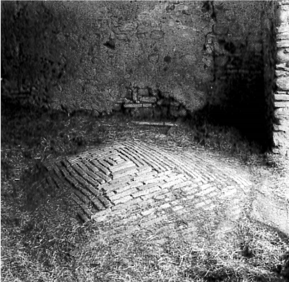
**36** Novazzano, La Pobbia: Mit Backsteinen gemauertes Gewölbe eines Stallbereichs. Man blickt im darübergelegenen Scheunenbereich von oben auf die Konstruktion. Aufnahme vor 1994.
