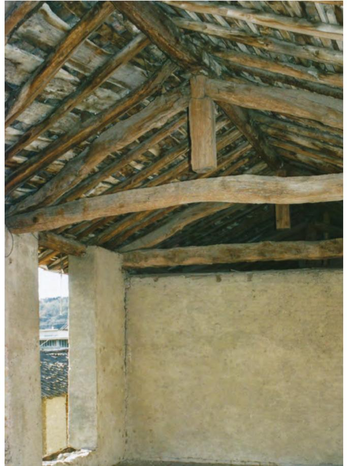
**34** Novazzano, La Pobbia: Dachkonstruktion mit Hängepfosten im offenen Galeriebereich im ersten Obergeschoss über dem Eingangsportal im Südflügel. Blick nach Nordosten. Aufnahme 2001.
