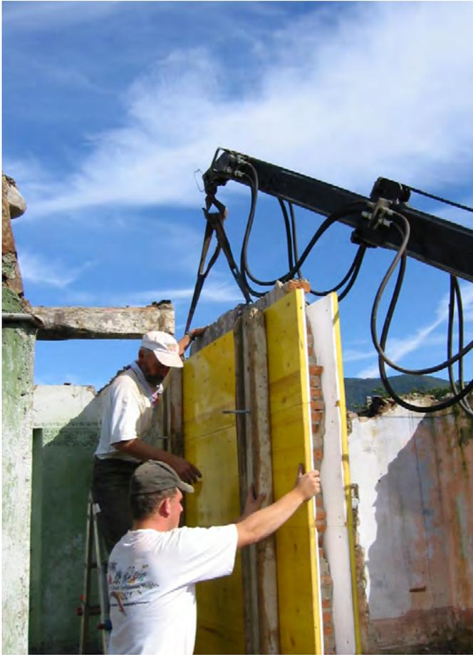
**40** Novazzano, La Pobbia: Abbauarbeiten am ursprünglichen Standort in Novazzano. Vorsichtig werden die verschalteten Backsteinmauern mit ihren Putzen und Farbfassungen geborgen. Aufnahme 2002.
