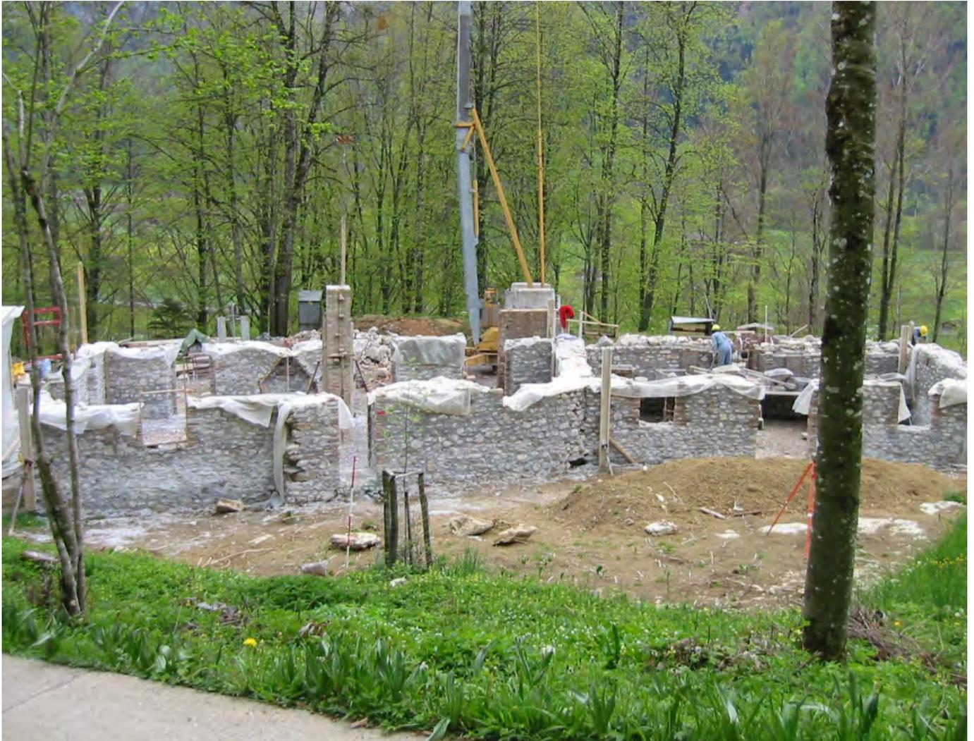
41 Freilichtmuseum der Schweiz, Gutshof La Pobbia: Wiederaufbau des Gutshofes. Gerade werden die Erdgeschossmauern mit dem originalen Steinmaterial und Kalkmörtel gemauert. Blick nach Süden. Aufnahme 2002.
