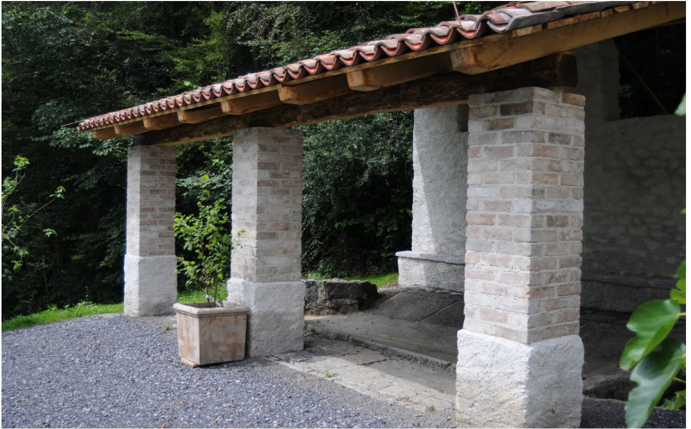
11 Freilichtmuseum der Schweiz, Waschplatz aus Bodio: Das Becken ist nun mit einem mit coppi gedeckten Puttdach überdeckt. Die Deckung lehnt sich an das im Sottoceneri übliche Dacheindeckungsmaterial des benachbarten Gutshofs an. In Bodio, in der Leventina, wäre eine Dacheindeckung mit Granitgneisplatten zu erwarten. Aufnahme 2014.
