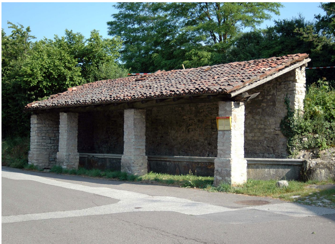
13 Meride TI, Waschplatz: Auch dieser Waschplatz aus dem Mendrisiotto diente als Vergleichsobjekt für die Dachkonstruktion des Waschplatzes aus Bodio. Aufnahme vor 2013.
