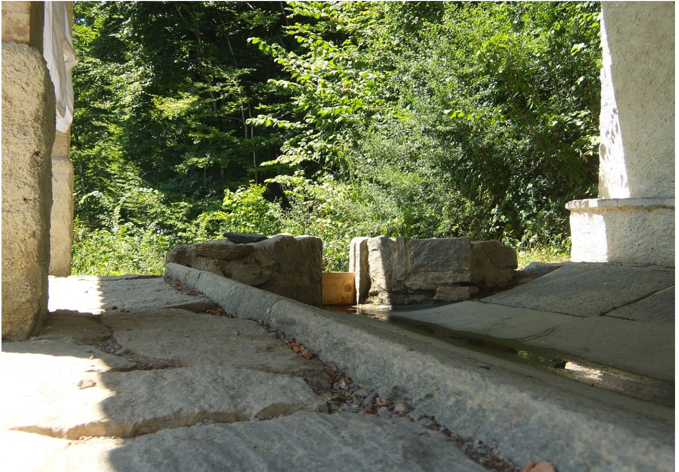
14 Freilichtmuseum der Schweiz, Waschplatz aus Bodio: Detailaufnahme des wiederhergestellten Beckens mit dem am südlichen Auslass eingesetzten hölzernen Schieber. Aufnahme 2022.
