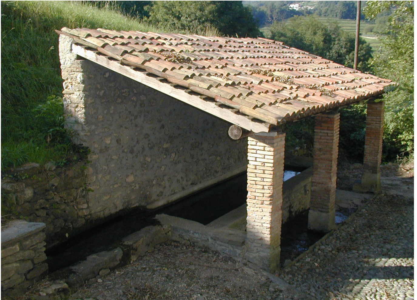
12 Corteglia TI, Waschplatz: Dieser Waschplatz aus der Gemeinde Castel San Pietro wurde im Museum als Modell für das neue Pultdach des ehemaligen Waschplatzes aus Bodio herangezogen. Aufnahme vor 2013.
