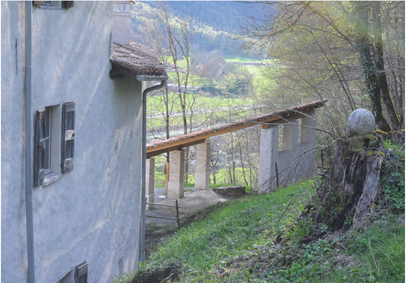
9 Freilichtmuseum der Schweiz, Waschplatz aus Bodio: Der Waschplatz im Freilichtmuseum in der Tessiner Geländekammer, beim Gutshof aus Novazzano TI, dessen Südwestecke auf dem Bild zu sehen ist. Aufnahme 2016.
