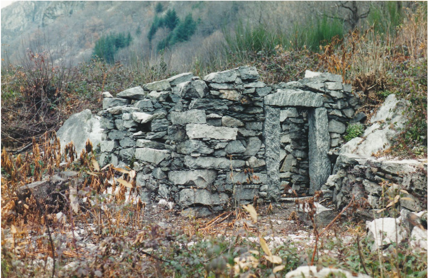
6 Bodio, Feldschmiede: Zustand vor dem Abbau. Das Dach und die Inneneinrichtung fehlten bereits. Aufnahme um 2000.
