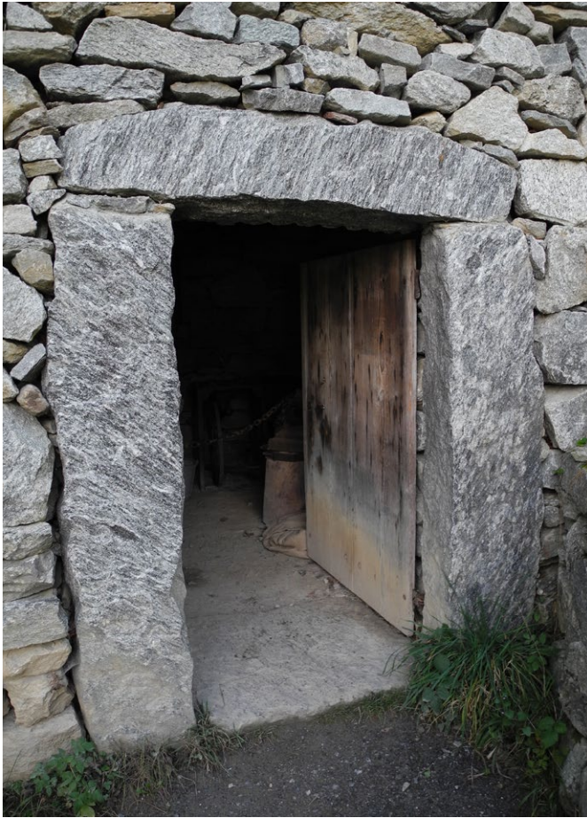
12 Freilichtmuseum der Schweiz, Feldschmiede aus Bodio: Aussenansicht des Türgewändes aus grob bearbeitetem Granitgneis. Aufnahme 2013.
