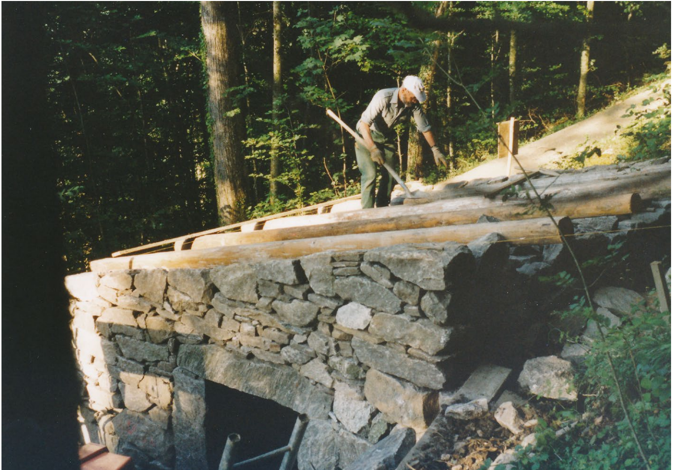
11 Freilichtmuseum der Schweiz, Feldschmiede aus Bodio: Während des Wiederaufbaus mit dem Zimmermann auf dem Dach. Aufnahme 2001.
